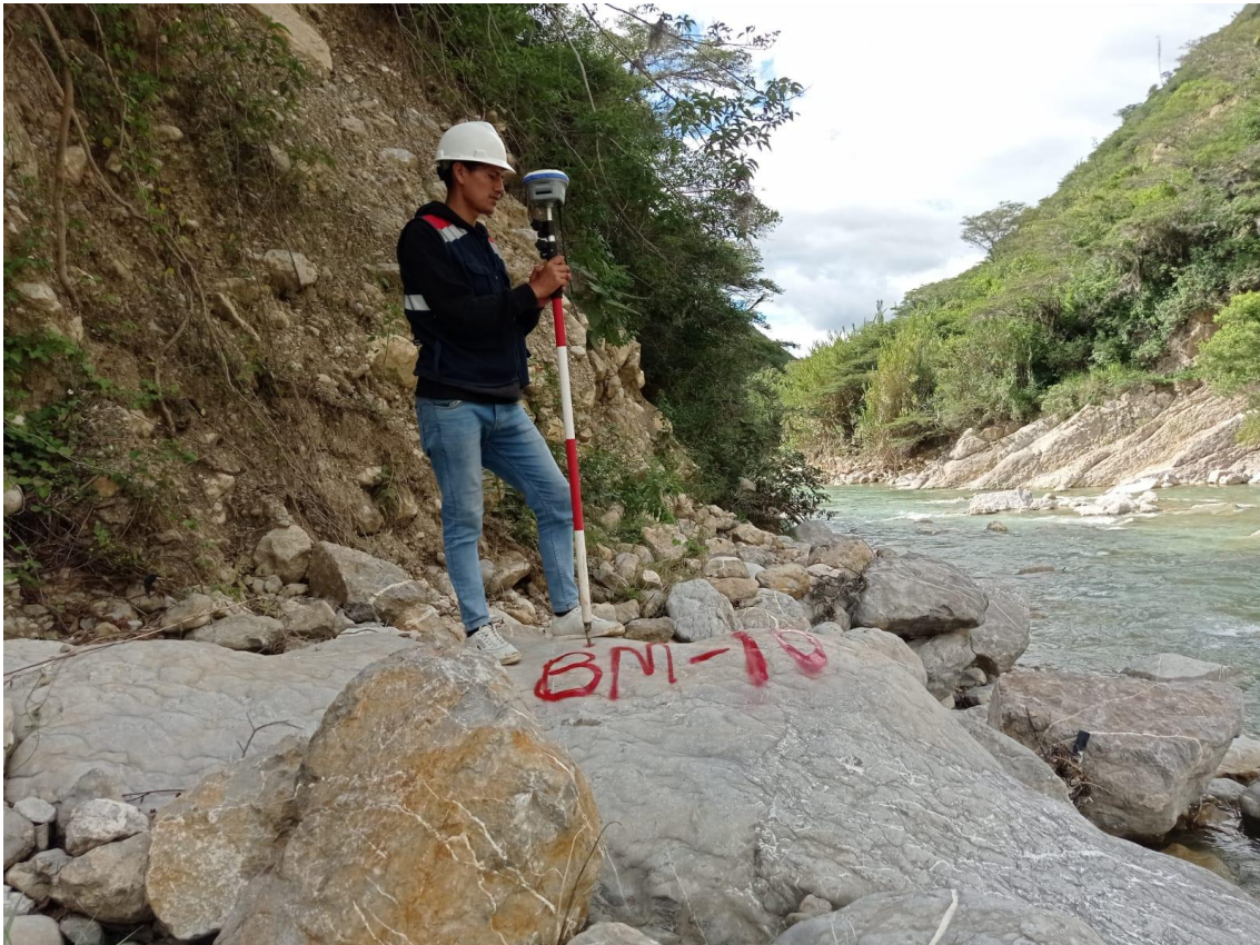
Fotografía 8. Toma de BMS y puntos fijos en el levantamiento topográfico
