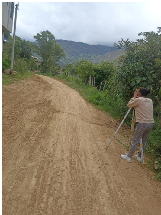
Fotografía 18. Operadora realizando lecturas en zona vial no pavimentada
