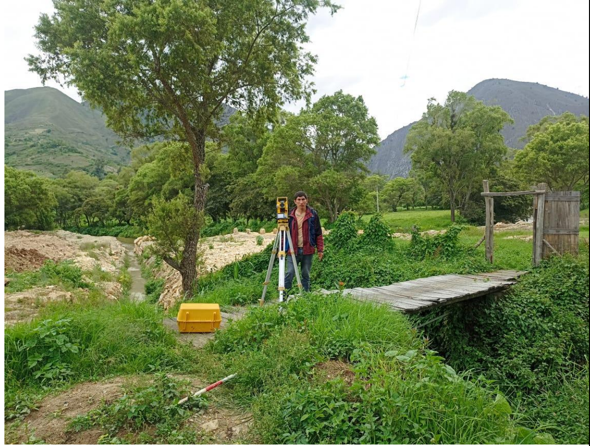
Fotografía 20. Levantamiento topográfico en zona ribereña con abundante vegetación
