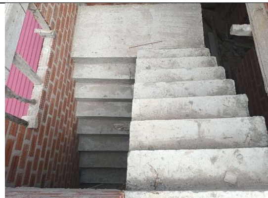
Fotografía 44. Vista de la escalera en forma de U construida en la vivienda 10
