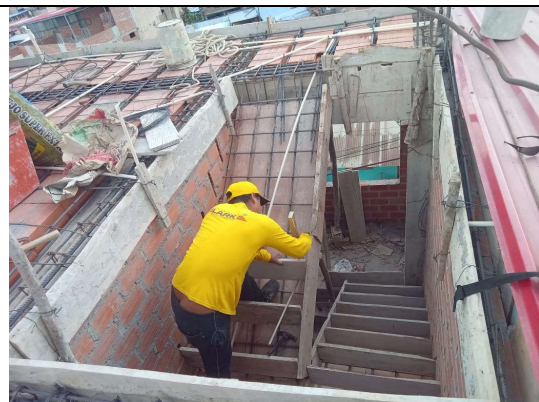
Fotografía 52. Preparación y vaciado de concreto en la vivienda 12
