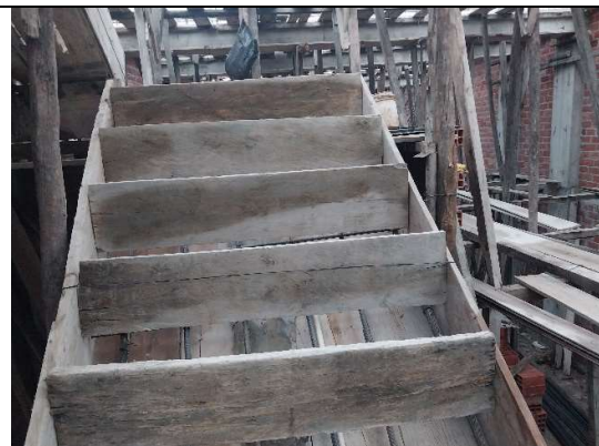
Fotografía 15. Registro de la carta balance en la vivienda 4 durante la construcción de la escalera con forma geométrica de U
