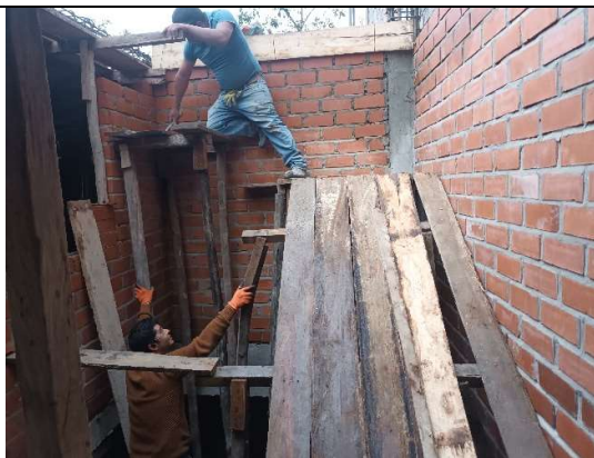
Fotografía 35. Habilitación y encofrado en la vivienda 9
