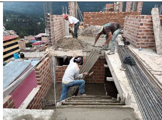
Fotografía 43. Preparación y vaciado de concreto en la vivienda 10
