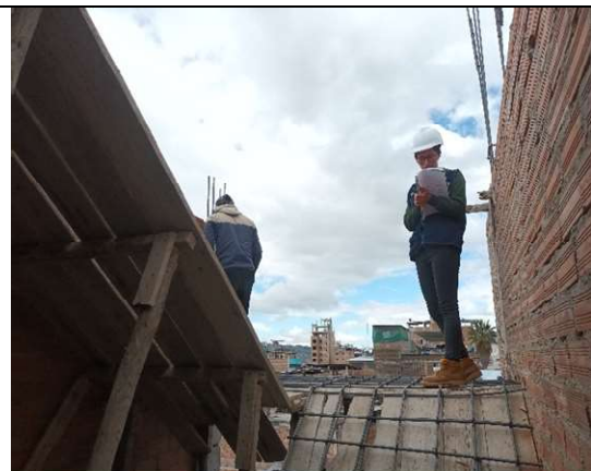
Fotografía 59. Registro de la carta balance en la vivienda 14 en la construcción de la escalera con forma de U
