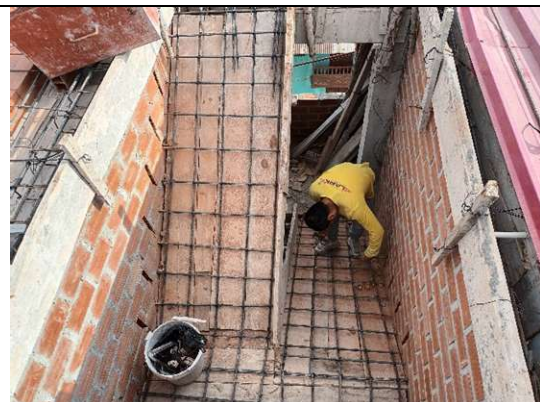
Fotografía 51. Registro de la carta balance en la vivienda 12 en la construcción de la escalera con forma de U
