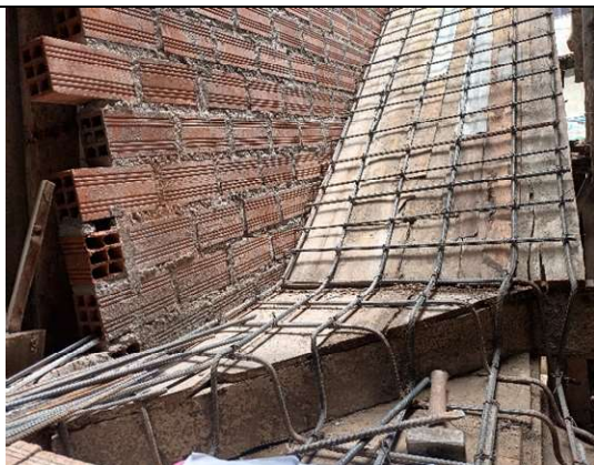
Fotografía 33. Verificaciones de la separación de acero y dimensiones en la escalera con forma de U en la vivienda 8
