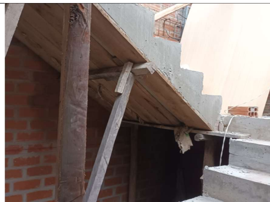
Fotografía 12. Vista de la escalera en forma de U construida en la vivienda 3
