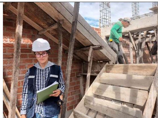
Fotografía 15. Registro de la carta balance en la vivienda 4 durante la construcción de la escalera con forma geométrica de U
