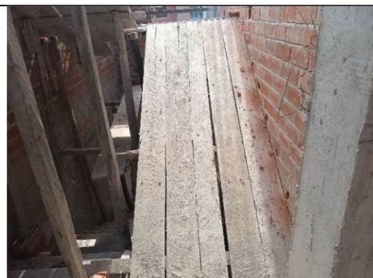
Fotografía 47. Registro de la carta balance en la vivienda 11 en la construcción de la escalera con forma de U
