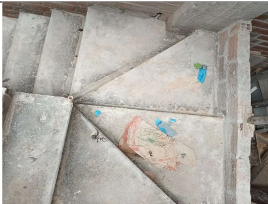
Fotografía 34. Vista de la escalera en forma de U construida en la vivienda 8
