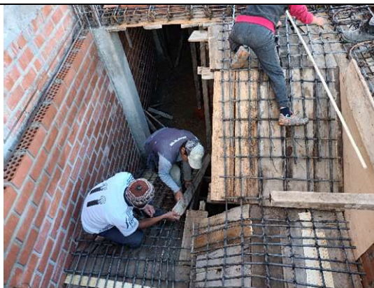
Fotografía 36. Habilitación y colocación de acero en la vivienda 9
