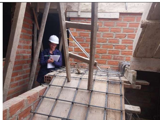
Fotografía 54. Registro de la carta balance en la vivienda 13 en acero de la escalera con forma de U
