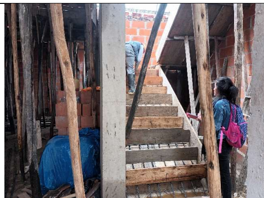
Fotografía 28. Registro de la carta balance en la vivienda 7 en la construcción de la escalera con forma de U
