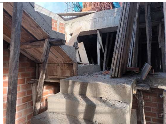
Fotografía 16. Vista de la escalera en forma de U construida en la vivienda 4
