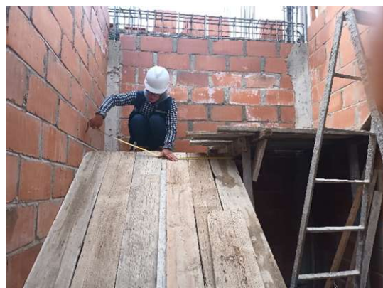
Fotografía 28. Registro de la carta balance en la vivienda 7 en la construcción de la escalera con forma de U
