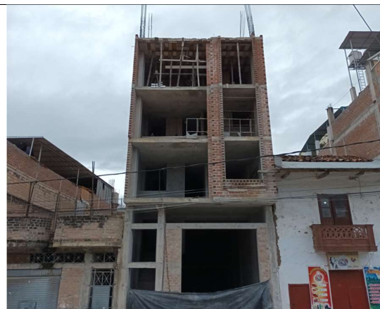
Fotografía 41. Habilitación y encofrado en la vivienda 10
