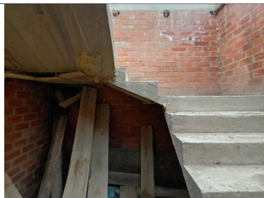
Fotografía 24. Vista de la escalera en forma de U construida en la vivienda 6
