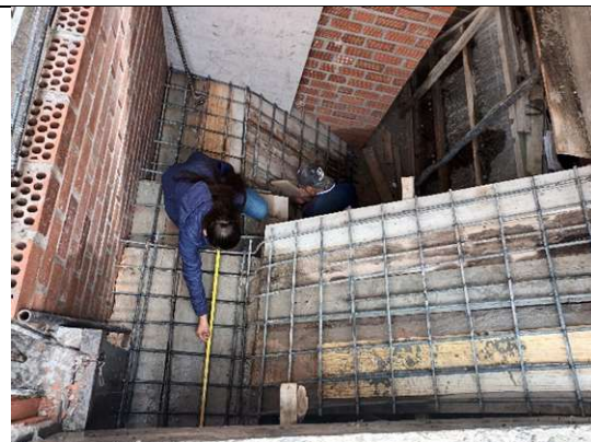
Fotografía 5. Habilidadación y colocación de acero en la vivienda 2
