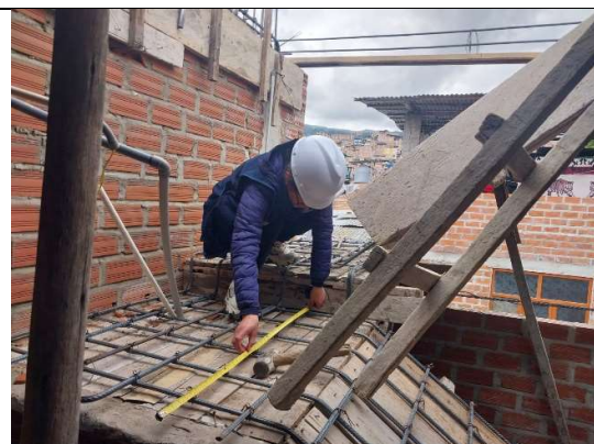
Fotografía 53. Verificaciones de la separación de acero y dimensiones en la escalera con forma de U en la vivienda 13
