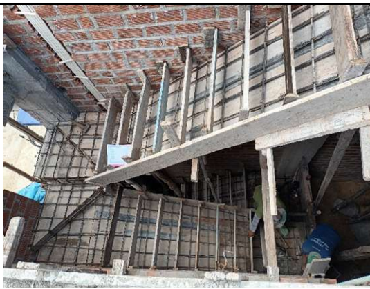
Fotografía 34. Vista de la escalera en forma de U construida en la vivienda 8
