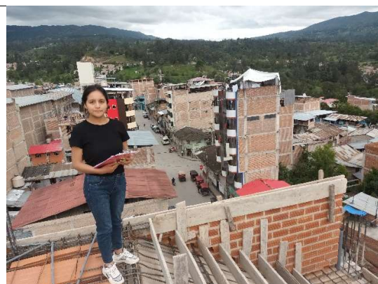
Fotografía 20. Registro de la carta balance en la vivienda 5 durante la construcción de la escalera con forma geométrica de U
