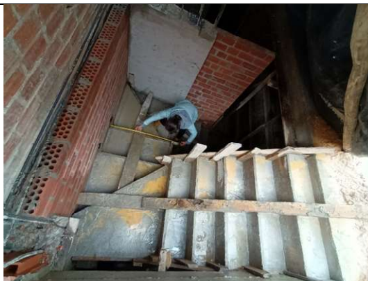
Fotografía 6. Preparación y vaciado de concreto en la vivienda 2
