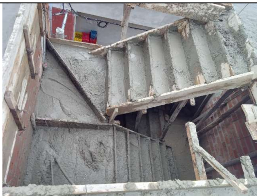
Fotografía 56. Preparación y vaciado de concreto en la vivienda 13
