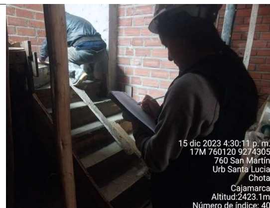
Fotografía 7. Registro de la carta balance en la vivienda 2 durante la construcción de la escalera con forma geométrica de U
