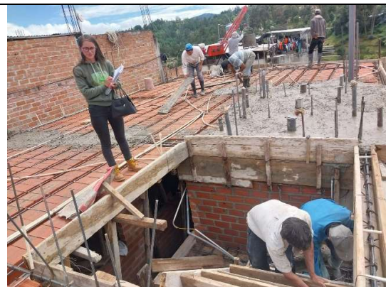
Fotografía 55. Registro de la carta balance en la vivienda 13 en la escalera con forma de U
