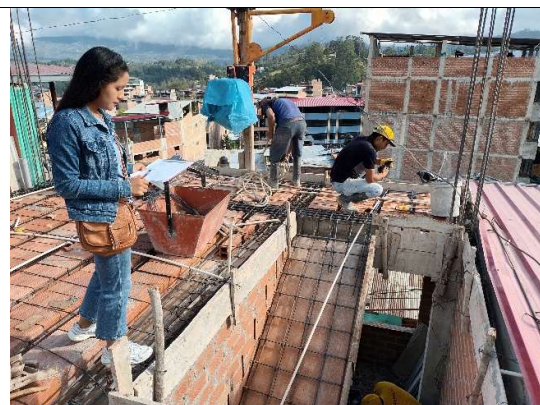
Fotografía 51. Registro de la carta balance en la vivienda 12 en la construcción de la escalera con forma de U
