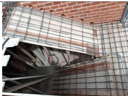
Fotografía 18. Habilidad y colocación de acero en la vivienda 5
