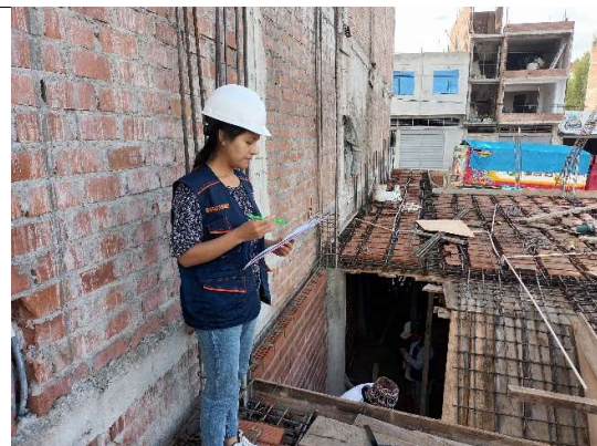
Fotografía 37. Registro de la carta balance en la vivienda 9 en la construcción de la escalera con forma de U
