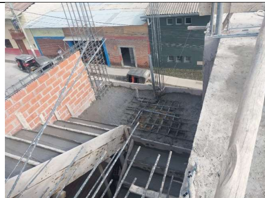
Fotografía 3. Preparación y vaciado de concreto en la vivienda 1
