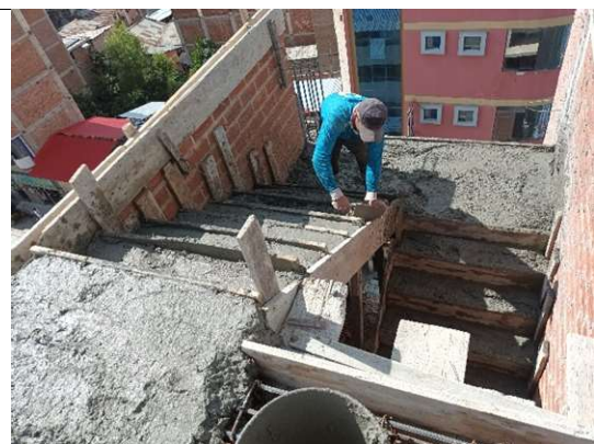
Fotografía 21. Habilitación y encofrado en la vivienda 6
