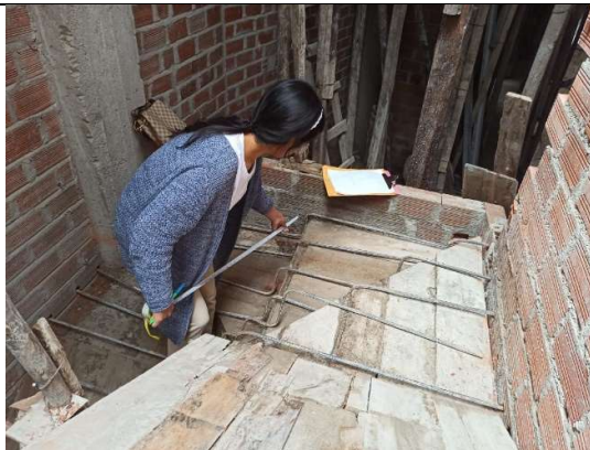
Fotografía 33. Verificaciones de la separación de acero y dimensiones en la escalera con forma de U en la vivienda 8
