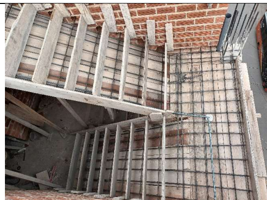
Fotografía 17. Habilidad y encofrado en la vivienda 5
