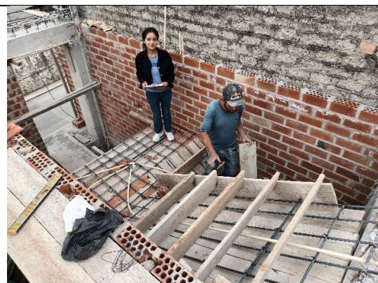
Fotografía 47. Registro de la carta balance en la vivienda 11 en la construcción de la escalera con forma de U
