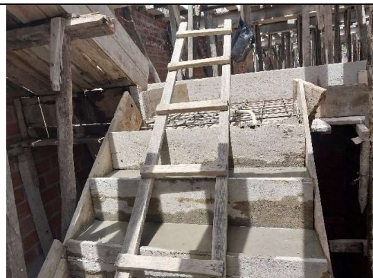
Fotografía 16. Vista de la escalera en forma de U construida en la vivienda 4
