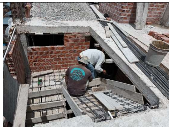
Fotografía 41. Habilitación y encofrado en la vivienda 10
