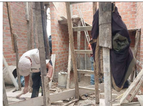
Fotografía 23. Registro de la carta balance en la vivienda 6 en la construcción de la escalera con forma geométrica de U
