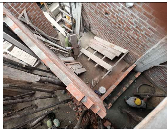
Fotografía 30. Habilidad y encofrado en la vivienda 8
