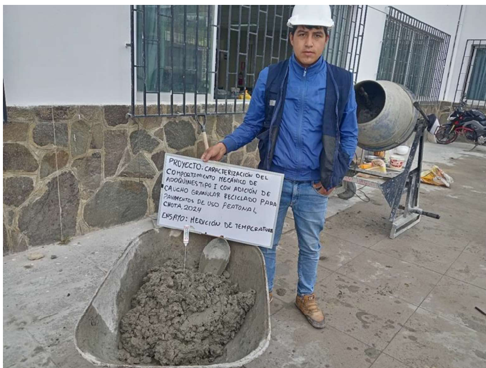
Ensayo de Temperatura en la Mezcla de Concreto
