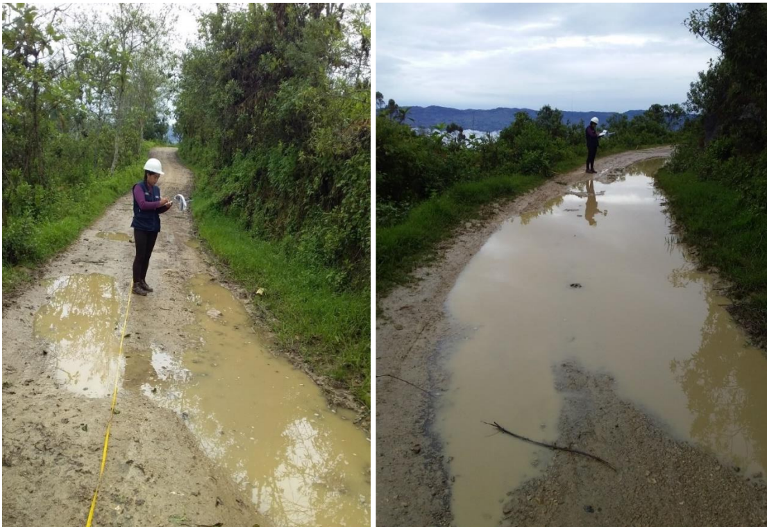
Fotografía 8. Falla por lodazal y cruce de agua
