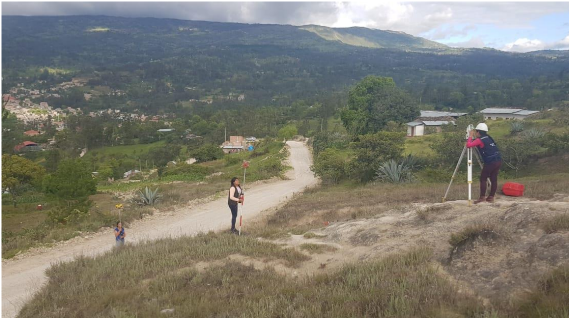
Fotografía 2. Colocación de Puntos Fijos
