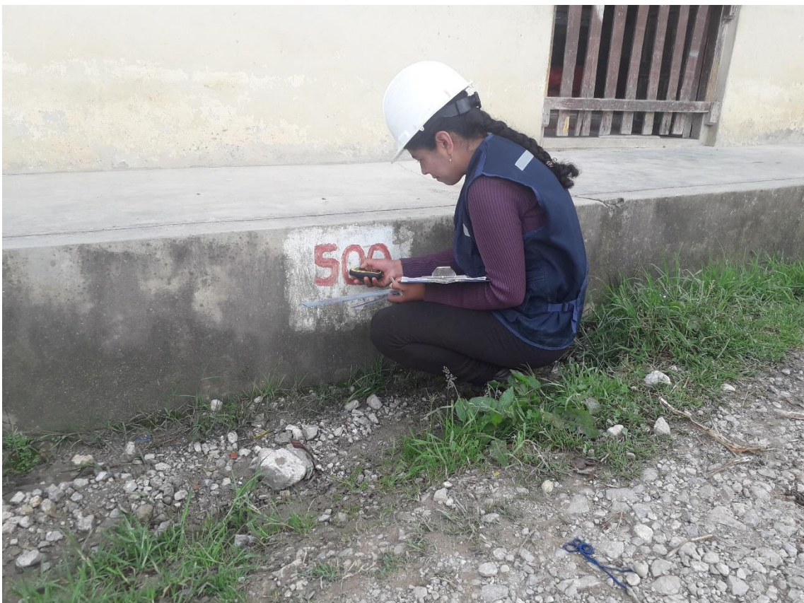
Fotografía 2. Colocación de Puntos Fijos
