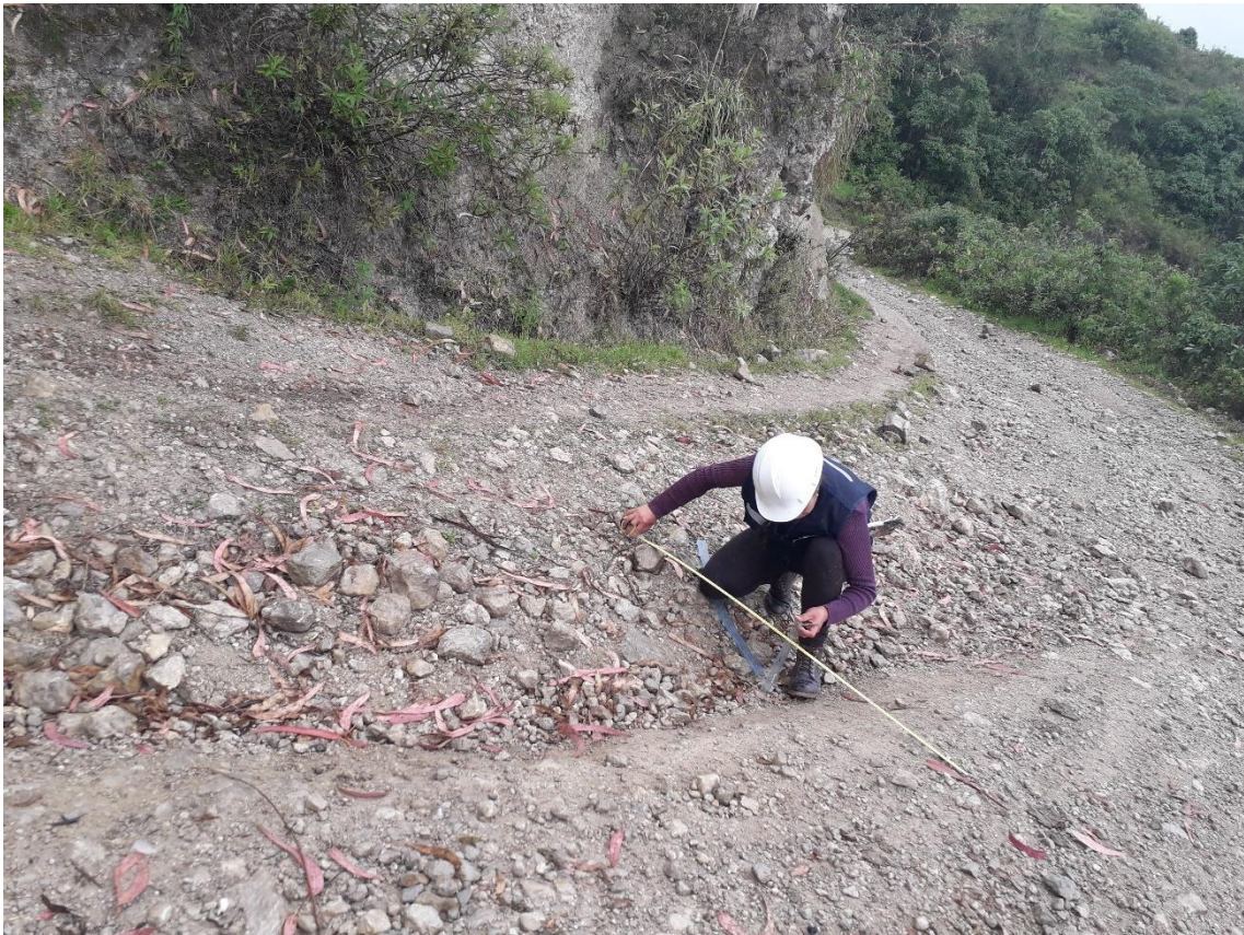
Fotografía 8. Falla por lodazal y cruce de agua
