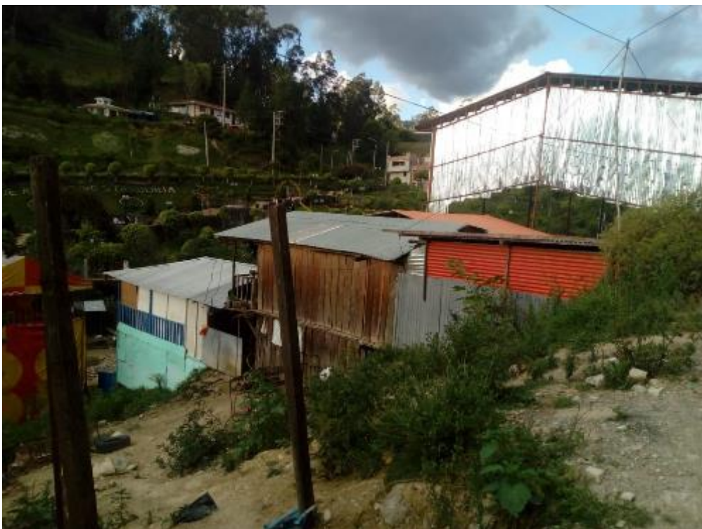
Fotografía 14. Edificaciones en sección 2
