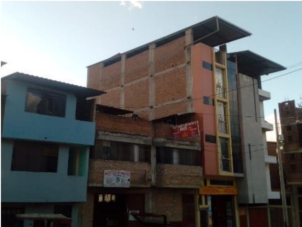
Fotografía 12. Edificaciones en sección 1
