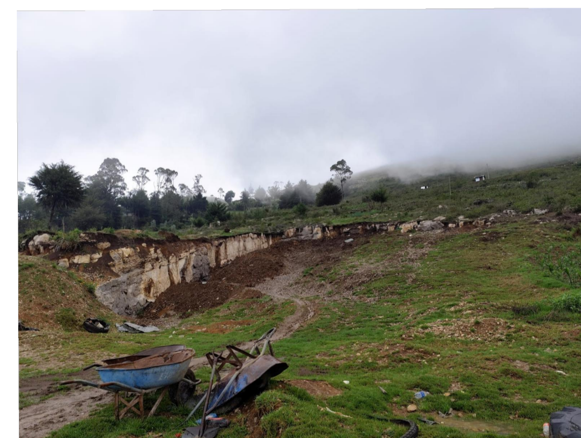
VISTA PANORÁMICA DE LA CANTERA DE AGREGADO
