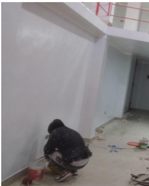
Fotografía 17. Pintado de muros interiores, vivienda 17
