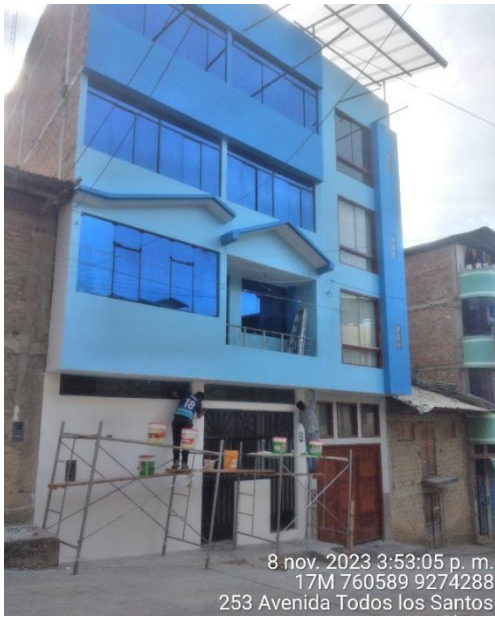
Fotografía 33. Pintado de muros exteriores, vivienda 13
