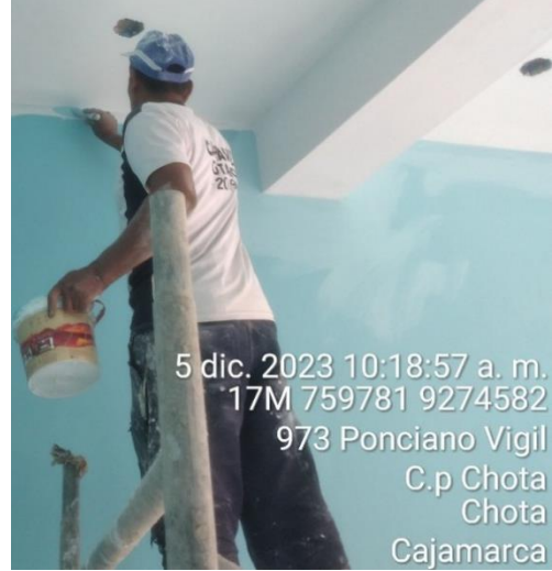
Fotografía 16. Pintado de muros interiores, vivienda 16
