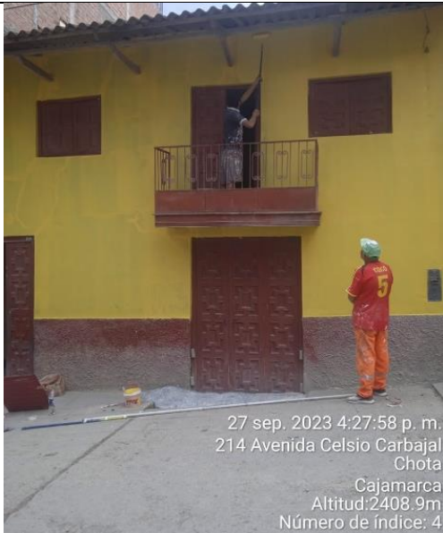
Fotografía 29. Pintado de muros exteriores, vivienda 9
