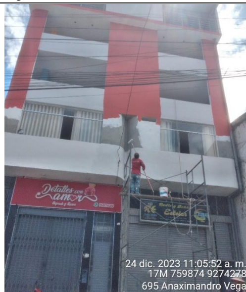
Fotografía 30. Pintado de muros exteriores, vivienda 10
