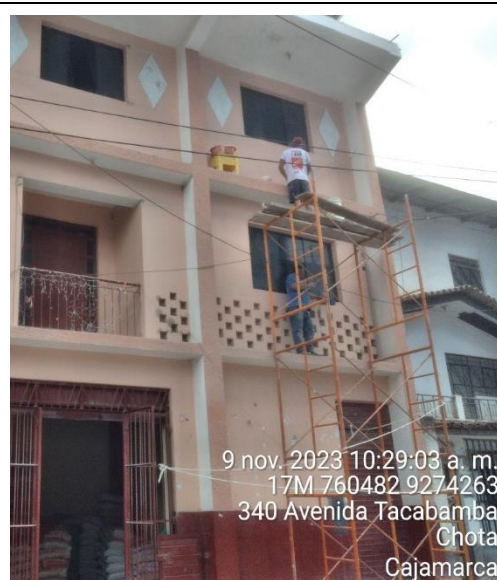
Fotografía 30. Pintado de muros exteriores, vivienda 10
