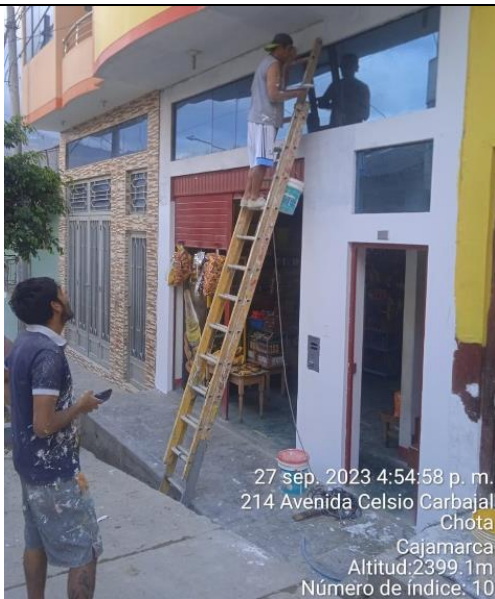
Fotografía 23. Pintado de muros exteriores, vivienda 3
