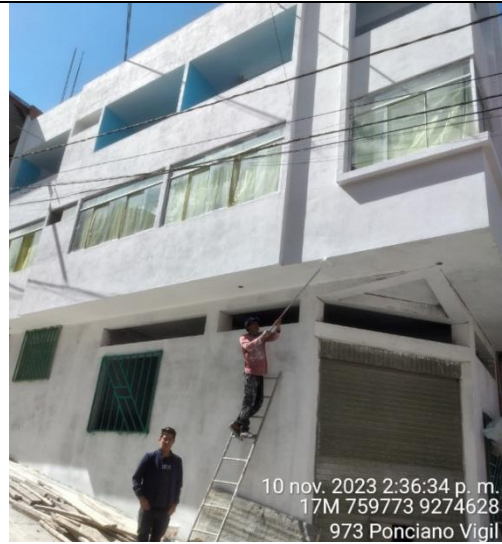
Fotografía 36. Pintado de muros exteriores, vivienda 16
