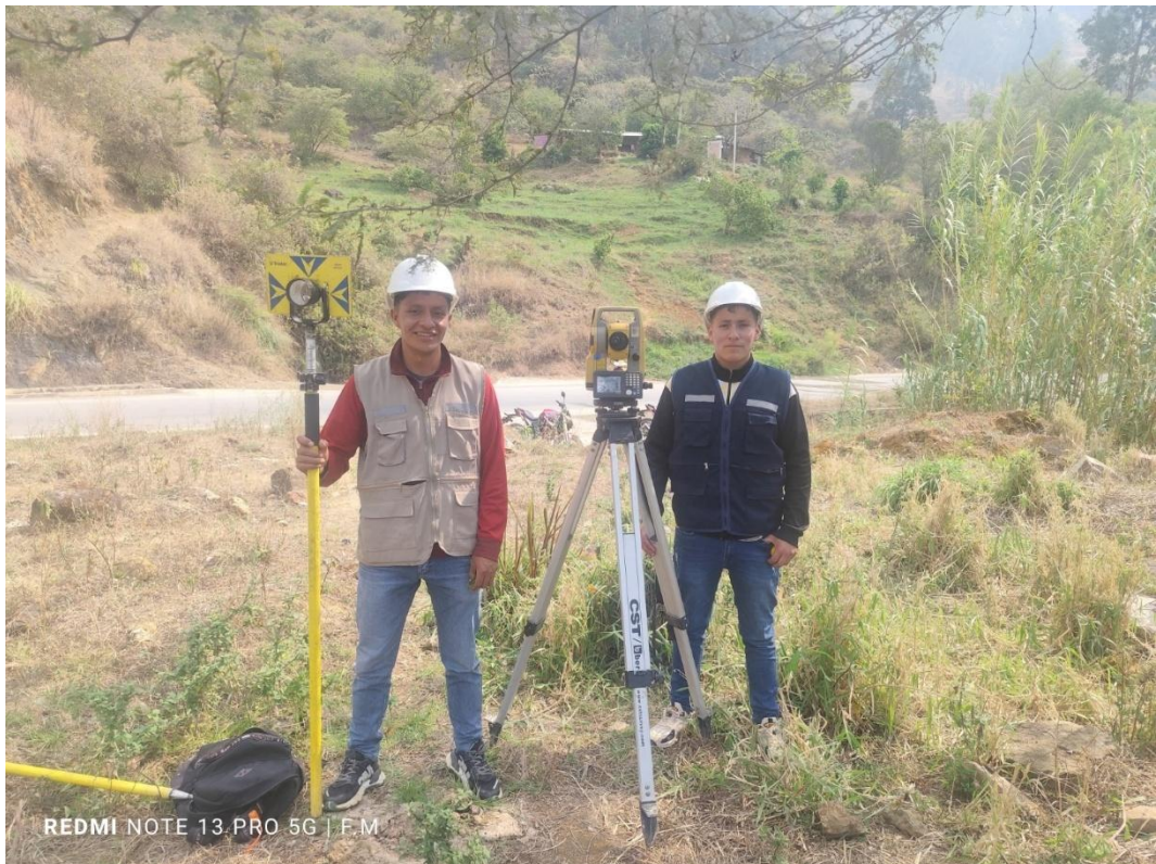
Levantamiento Topográfico en el Talud el Ingenio
