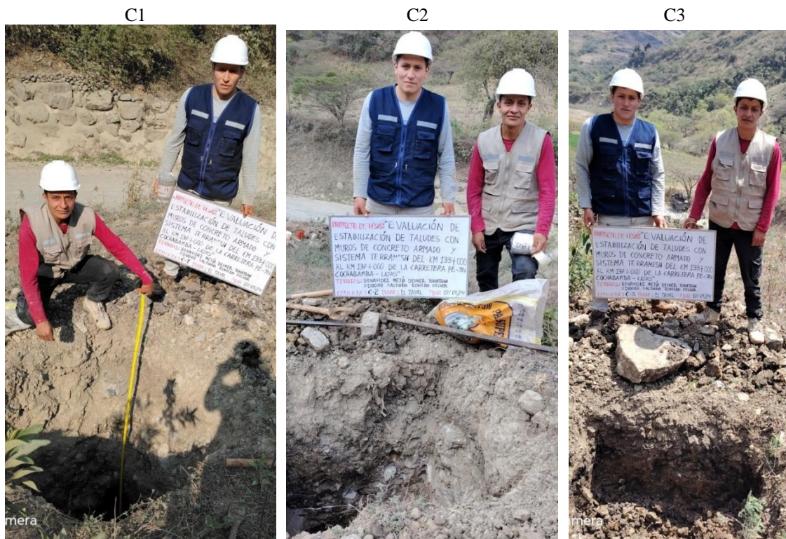
Calicatas en el Talud Tayal, Lajas
