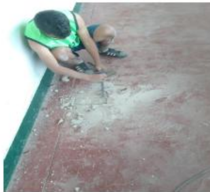
Foto: 03 Punto en losa para el ensayo de esclerometría
