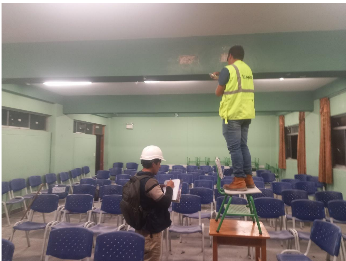
Fotografía 6 Ensayo de esclerometría en el colegio San Juan
