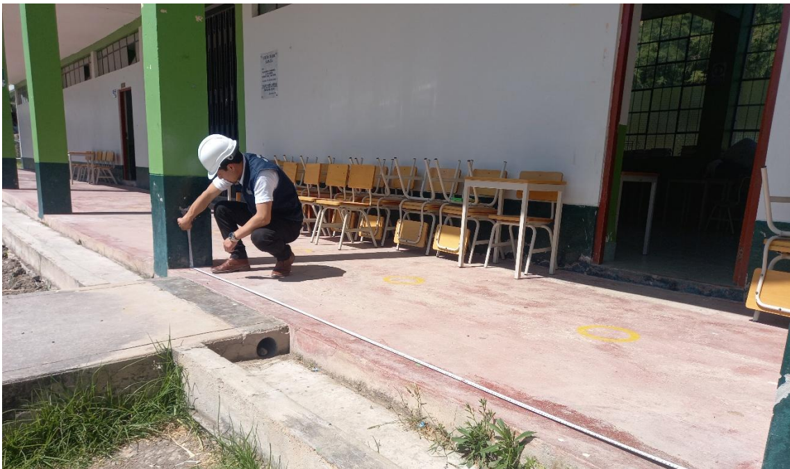
Fotografía 2 Ensayo de esclerometría en el colegio agropecuario
