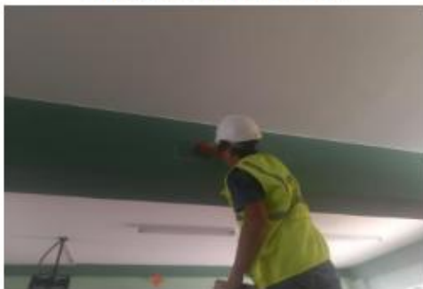
Foto:02 Señalización del punto de ensayo
