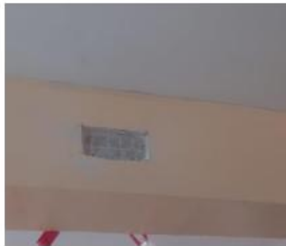
Foto: 03 Punto en viga para el ensayo de esclerometría
