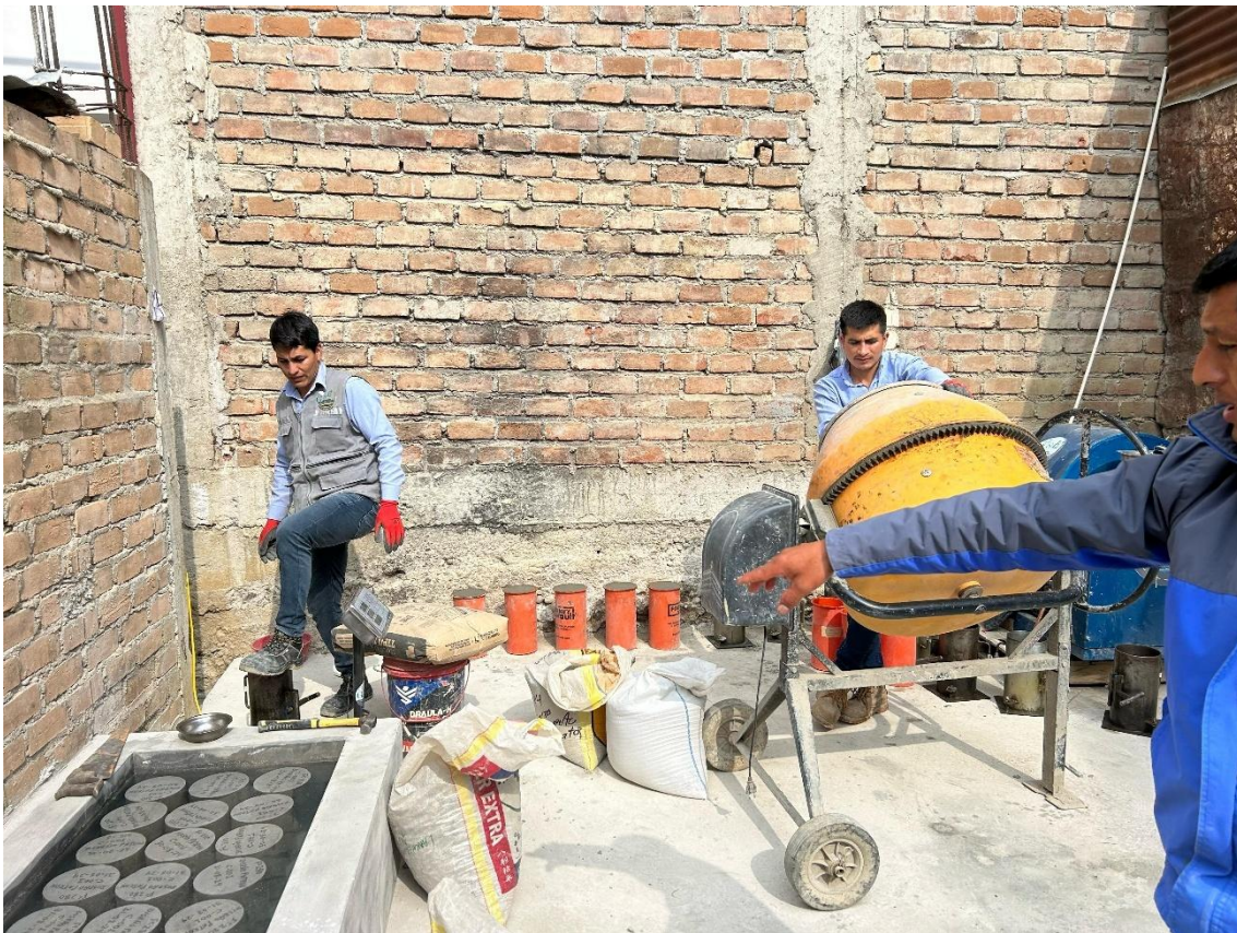
Fotografía 8. Elaboración de la mezcla para la producción de concreto
