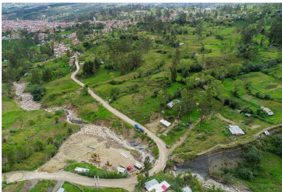
Fotografía N.º 03. Vista del deslizamiento rotacional N º2, además de la quebrada Potrera en el pie del deslizamiento.
