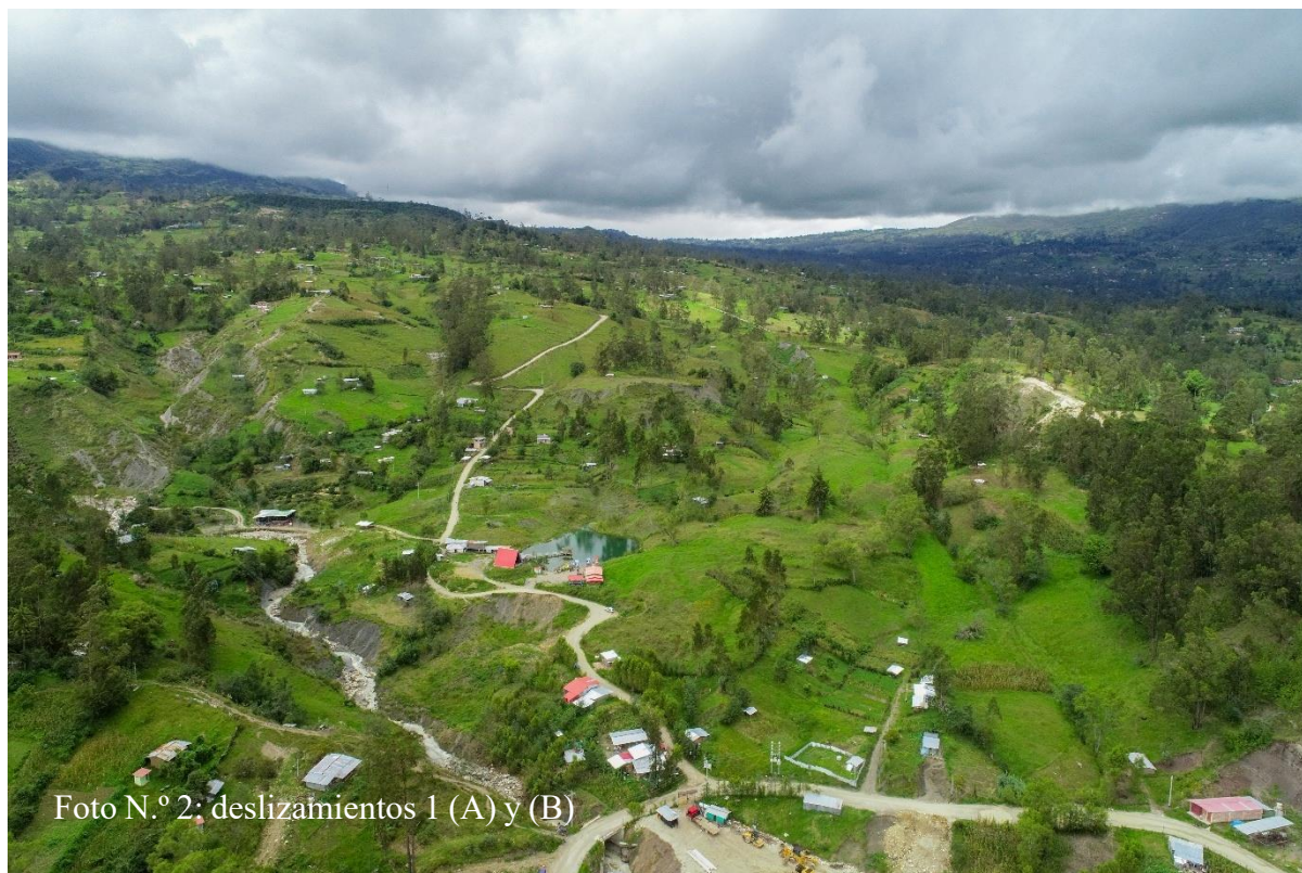
Fotografías N.º 01 y 02. Vista del deslizamiento rotacional complejo (deslizamiento 1 (A) y deslizamiento 1(B)).
