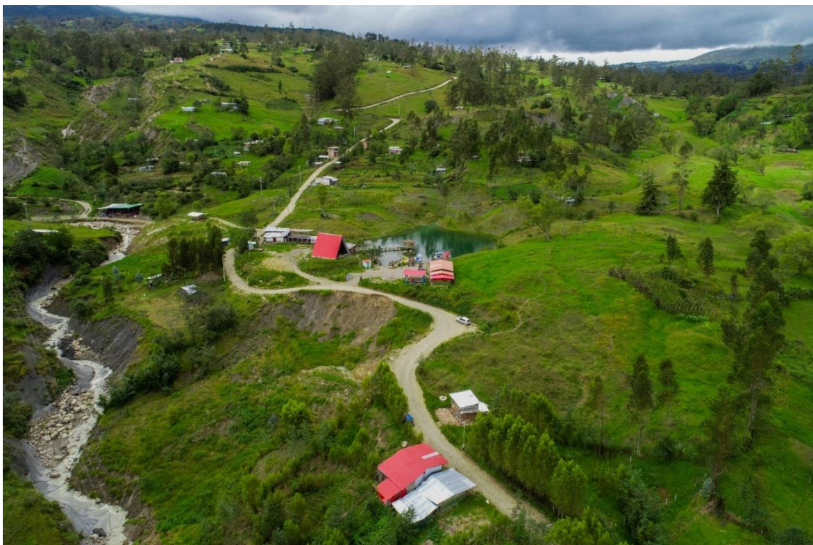
Fotografía N.º 04. Estado del deslizamiento en proceso de reactivación en el pie del deslizamiento.
