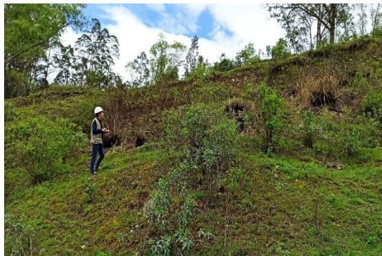
Fotografía N.º 22. Escarpe del deslizamiento N.º 2.
