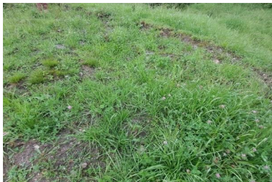
Fotografía N.º 21. Grietas tensionales en la corona del deslizamiento N.º 2.
