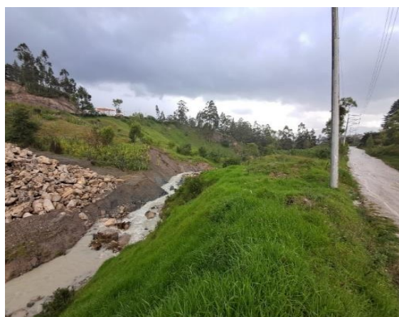
Fotografía N.º 10. Quebrada Potrera (activada en periodo de precipitaciones) ubicado en el pie de los deslizamientos.
