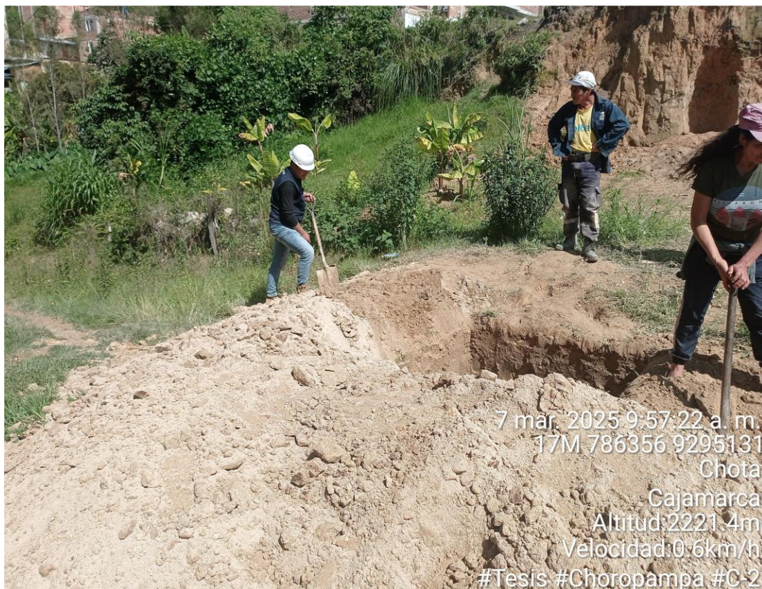
Fotografía 08: Relleno de calicata despues de obtener la muestra
