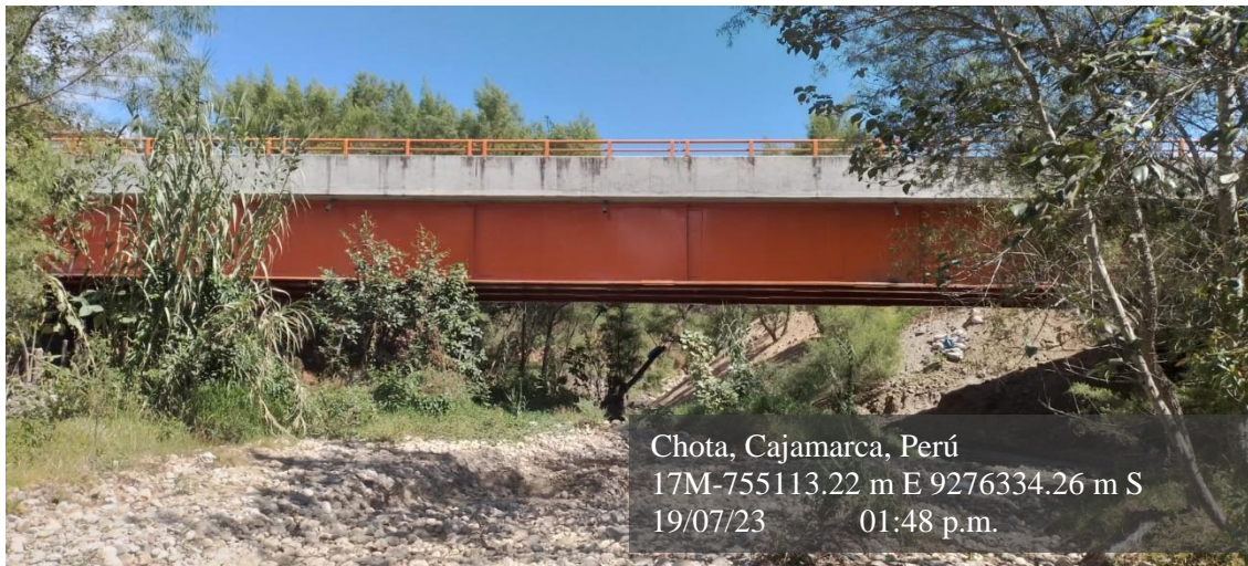
Fotografía 4: Sección hidráulica del puente Oscar Burga
