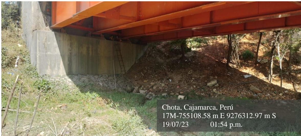
Fotografía 5: Estribo izquierdo del puente Oscar Burga
