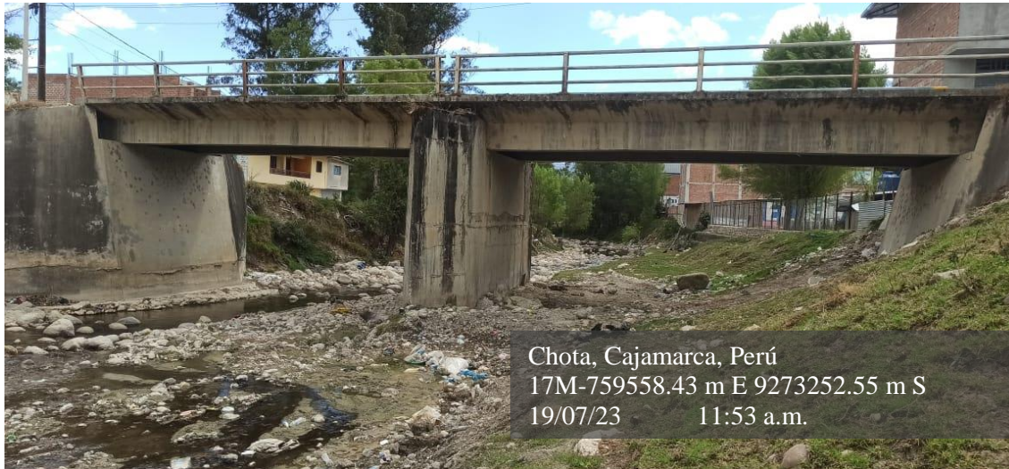
Fotografía 1. Sección hidráulica del puente Cementerio
