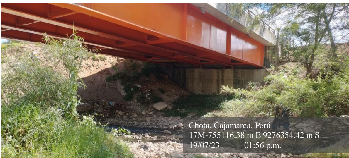
Fotografía 6: Estribo derecho del puente Oscar Burga
