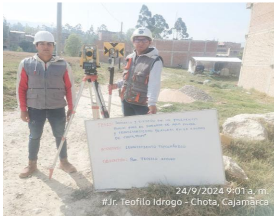
Fotografía 3. Toma de puntos topográficos de la calle en estudio
