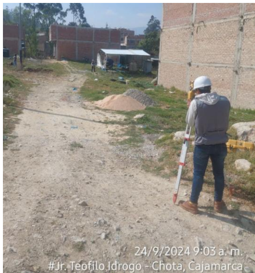
Fotografía 5. Toma de medida de profundidad 1.50 m
