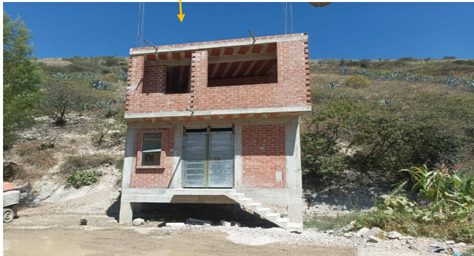
Estado actual de la vivienda
