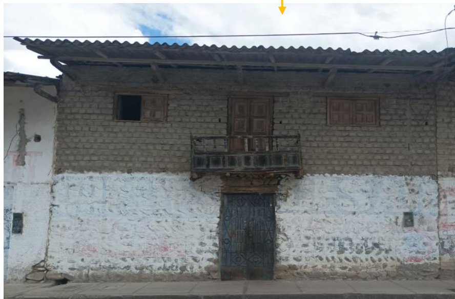
Estado actual de la vivienda
