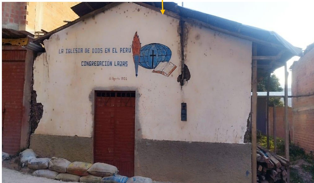
Estado actual de la vivienda
