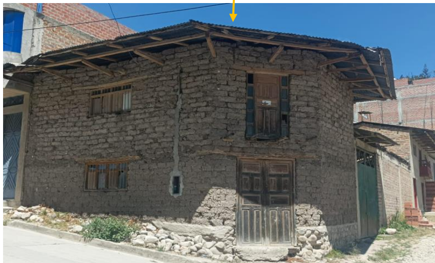
Estado actual de la vivienda
