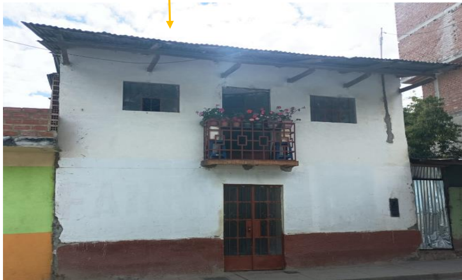
Estado actual de la vivienda
