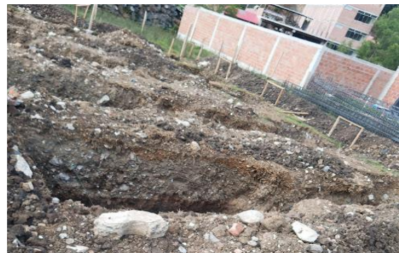
Foto 4. Condiciones del suelo y del entorno de excavación.
