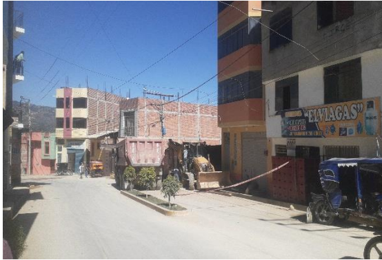
Foto 1. Vista general del área de excavación manual.
