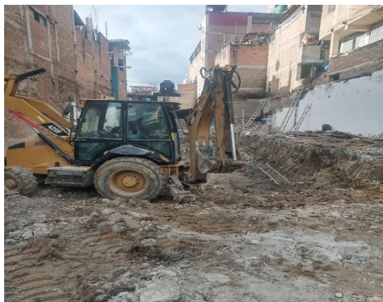
Foto 1. Vista general del frente de excavación mecánica.
