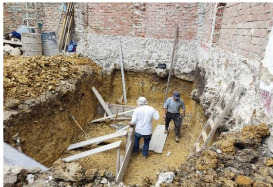
Foto 4. Condiciones del terreno y del material removido.
