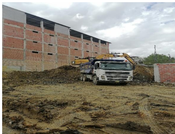
Foto 2. Excavadora en operación.
