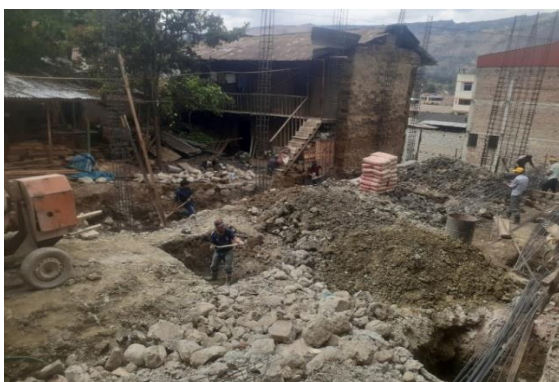
Foto 3. Excavación ejecutada para cimientos.
