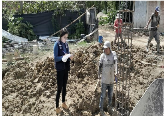
Foto 2. Excavación manual de zapatas.
