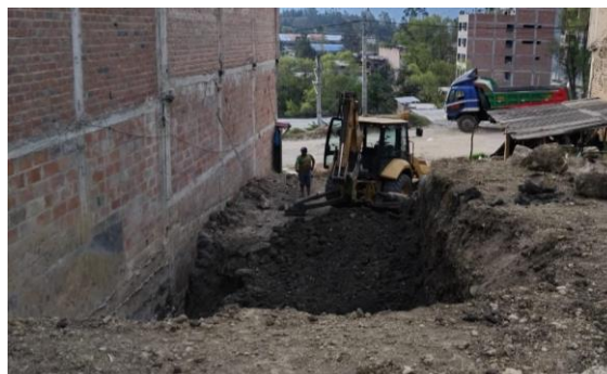
Foto 2. Operación de excavación con retroexcavadora.
