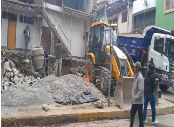
Foto 1. Vista general del área de excavación mecánica.
