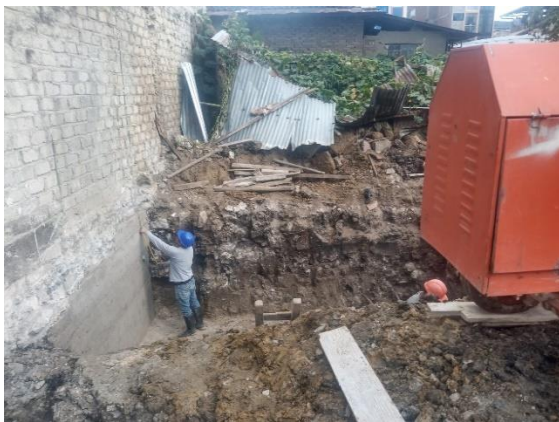
Foto 3. Excavación mecanizada y carguío de material.
