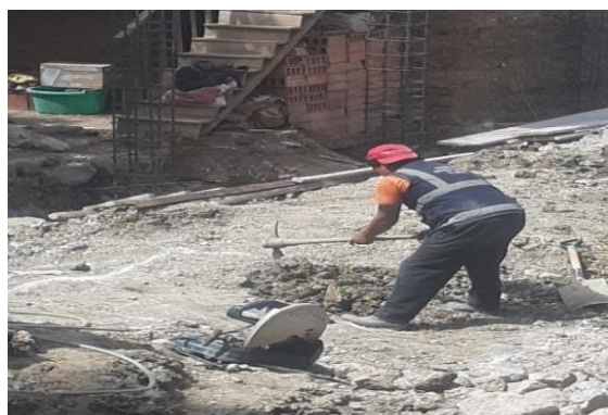
Foto 4. Condiciones del terreno durante la excavación.
