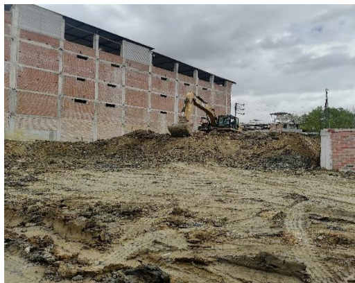
Foto 3. Excavación mecanizada de gran magnitud.
