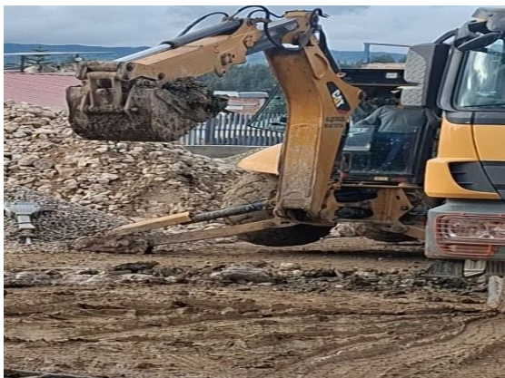
Foto 3. Excavación conformada para cimientos.
