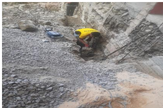
Foto 2. Participación de la cuadrilla en la excavación.
