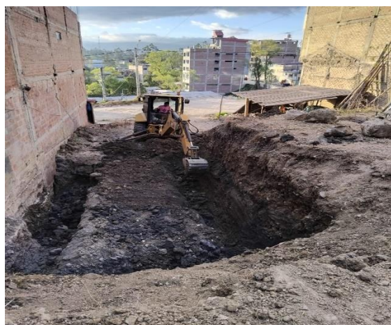
Foto 4. Material excavado y condiciones de obra.
