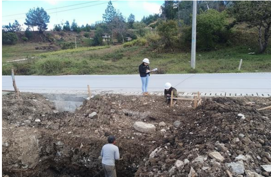
Foto 1. Vista general del frente de excavación manual.
