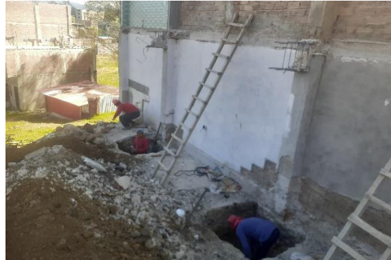
Foto 2. Excavación manual en proceso.
