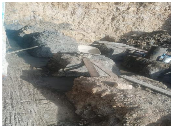
Foto 4. Material excavado y entorno operativo.
