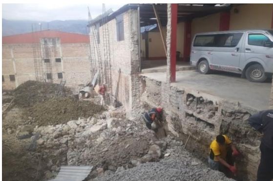
Foto 1. Vista general del frente de excavación manual.
