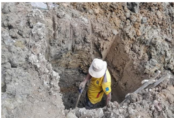
Foto 1. Vista general del lote en excavación.
