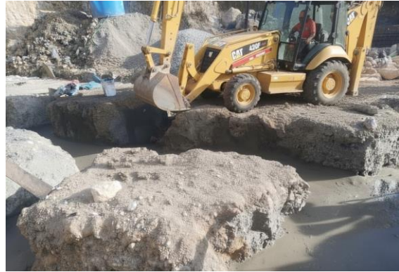
Foto 2. Retroexcavadora en proceso de corte del terreno.
