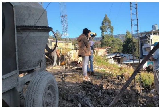
Foto 1. Vista general del área de excavación manual.
