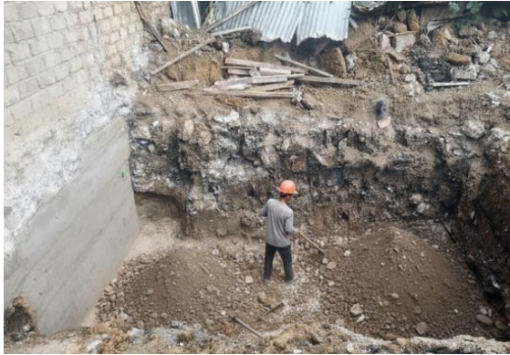
Foto 1. Vista general del área de excavación mecánica.
