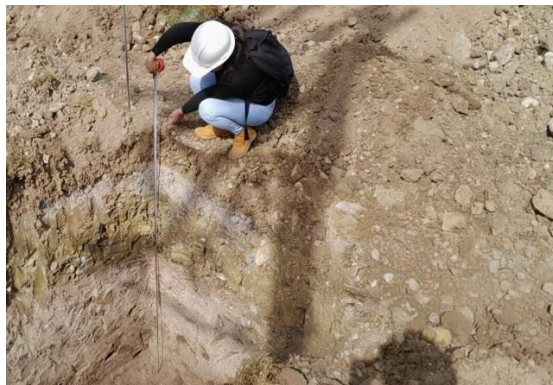
Foto 3. Excavación de gran magnitud para la cimentación.
