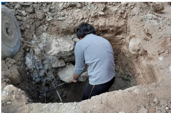
Foto 3. Avance de la excavación mecanizada.
