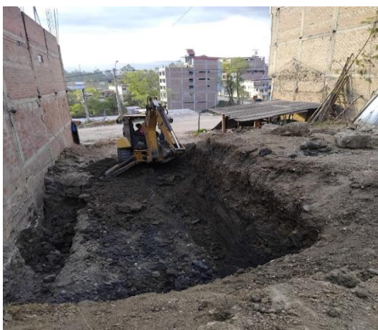
Foto 3. Conformación de la excavación para cimientos.
