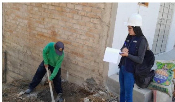
Foto 4. Registro del terreno excavado.
