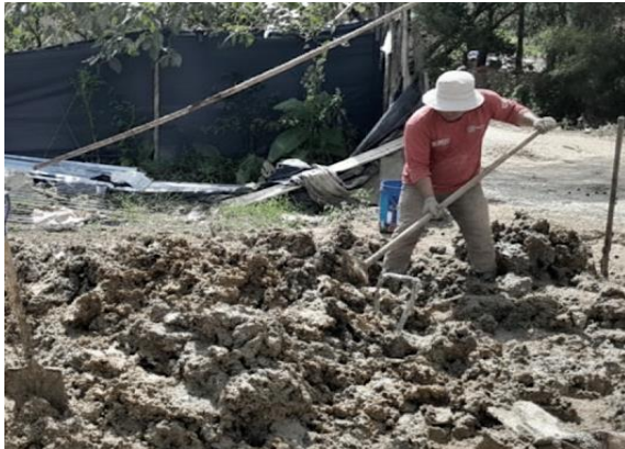
Foto 1. Vista general del área excavada.
