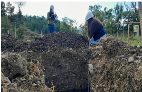
Foto 3. Detalle de la excavación ejecutada.
