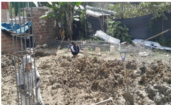
Foto 3. Conformación de la excavación en planta.
