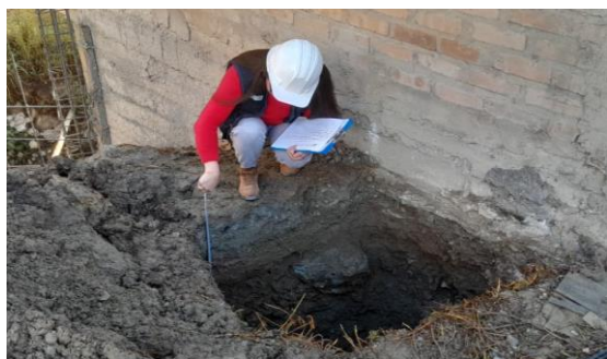
Foto 3. Excavación conformada para los elementos de cimentación.
