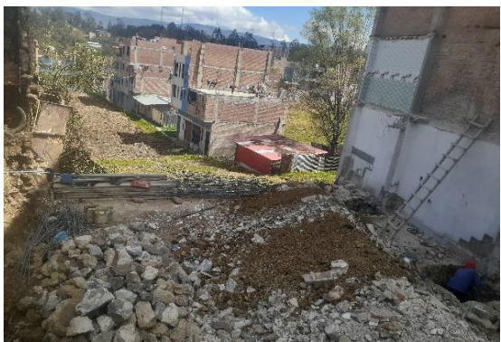
Foto 3. Conformación de la excavación de cimientos.
