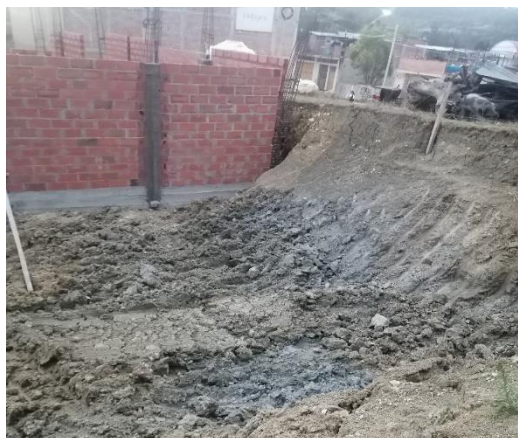
Foto 1. Vista general del área de excavación mecánica.
