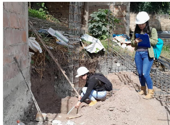
Foto 4. Estado de la excavación terminada.
