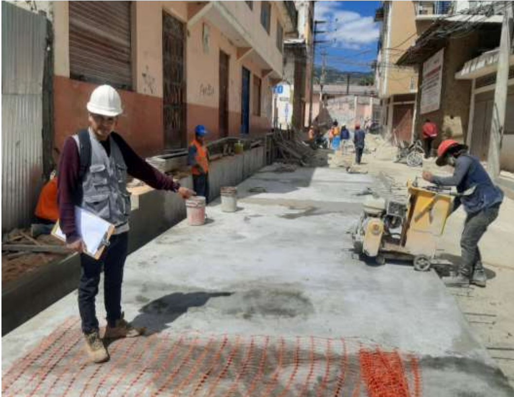
Fotografía 17. Corte de juntas de contracción e=3\text{mm}
