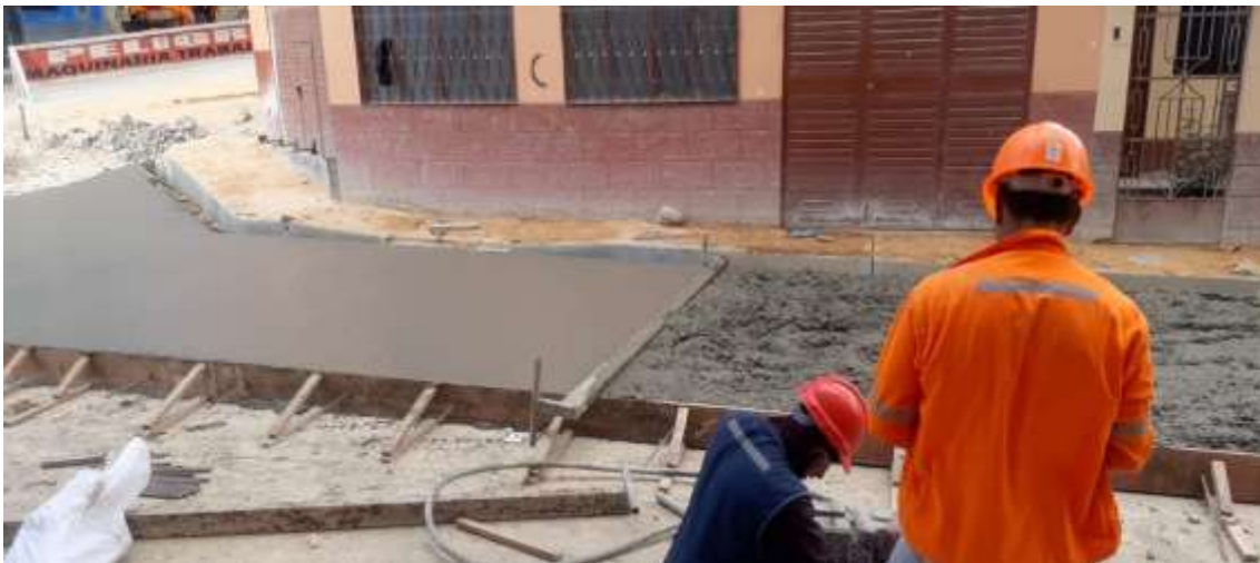
Fotografía 42. Vaciado de concreto
