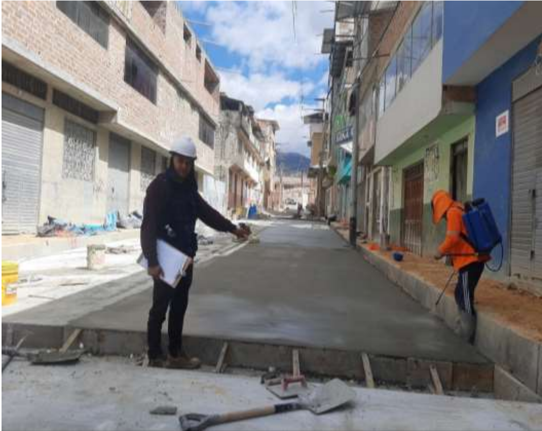
Fotografía 13. Curado de concreto con aditivo
