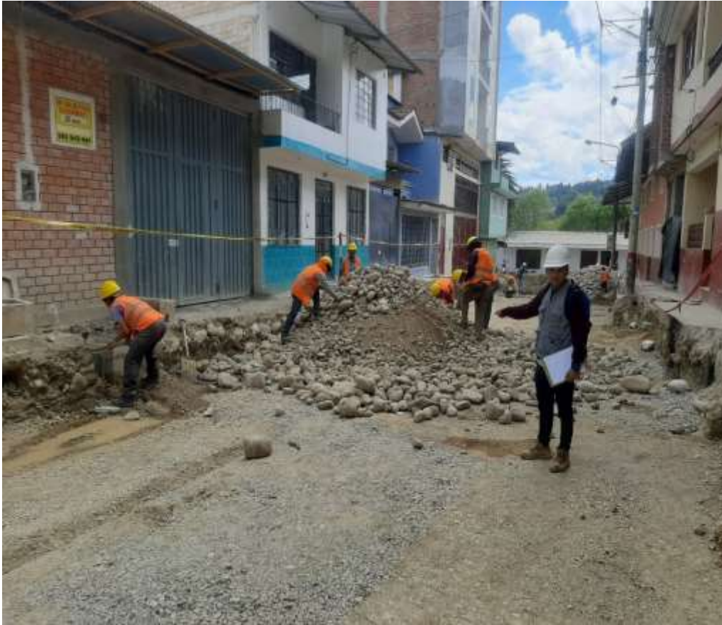
Fotografía 19. Mejoramiento de sub rasante con over e=0.35 m
