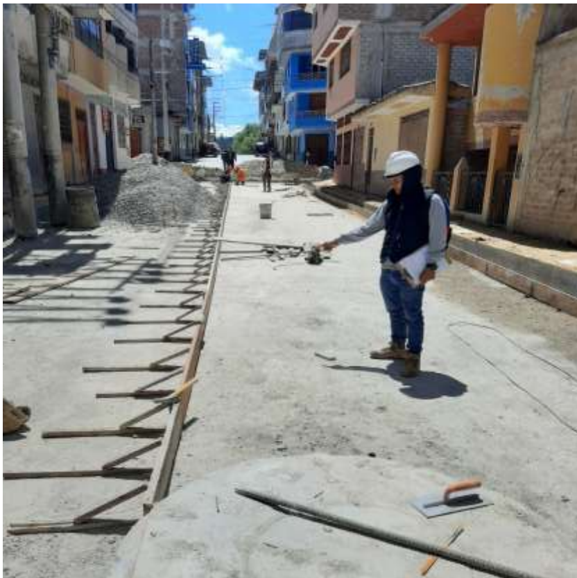
Fotografía 6. Encofrado de losa pavimento
