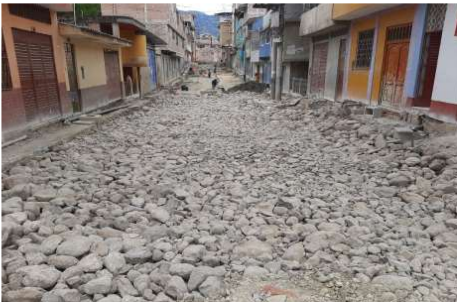
Fotografía 2. Mejoramiento de sub rasante con over e=0.20 m
