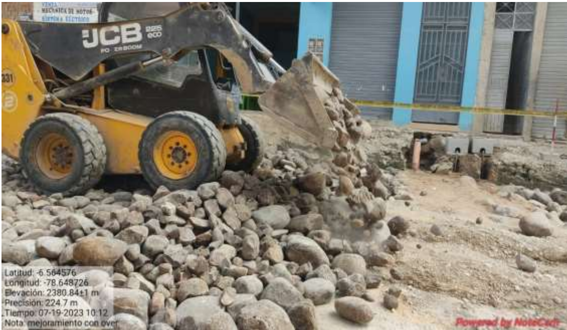
Fotografía 39. Colocación de over en la subrasante
