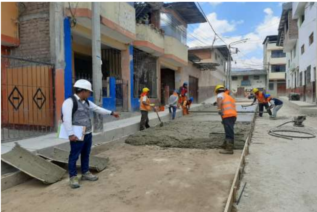
Fotografía 30. Colocación de concreto f'c=210 kg/cm 2 para pavimento rígido e=0.20 m
