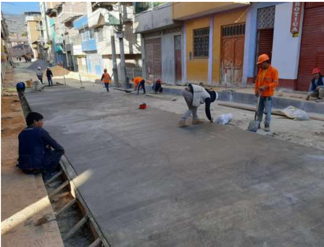
Fotografía 16. Corte de juntas de contracción e=3\text{mm}
