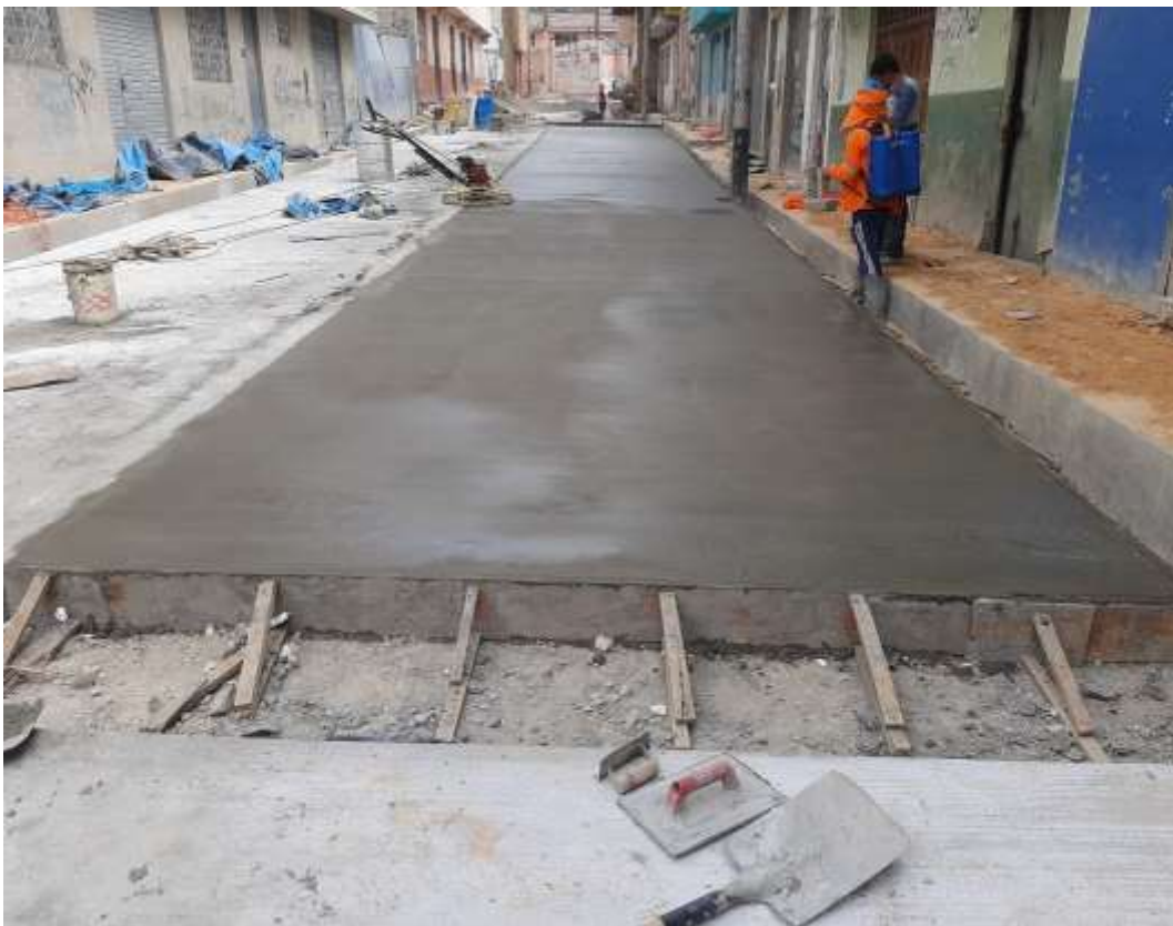
Fotografía 14. Curado de concreto con aditivo
