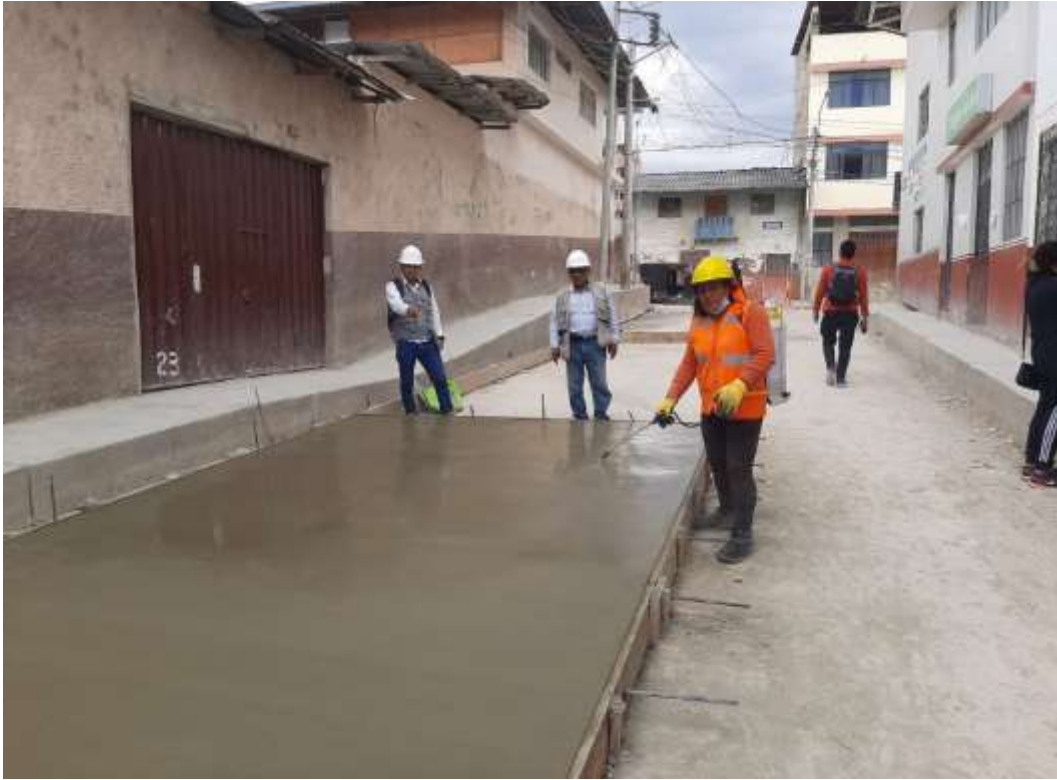
Fotografía 35. Curado de concreto con aditivo
