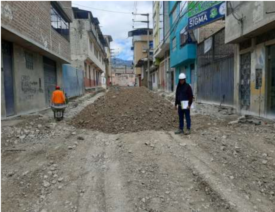
Fotografía 3. Conformación de subbase granular e=0.20 m
