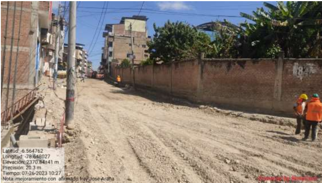
Fotografía 47. Compactación de la subbase granular
