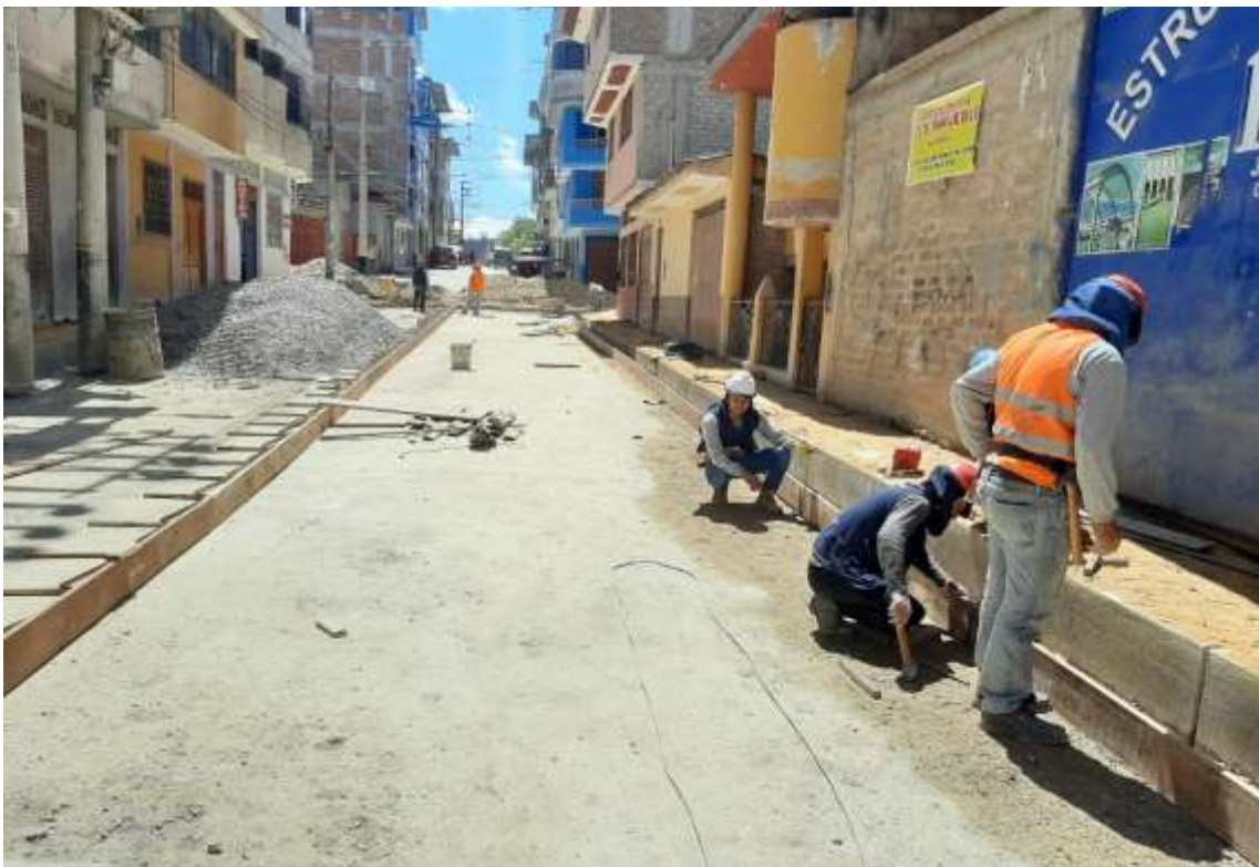
Fotografía 8. Encofrado de losa pavimento
