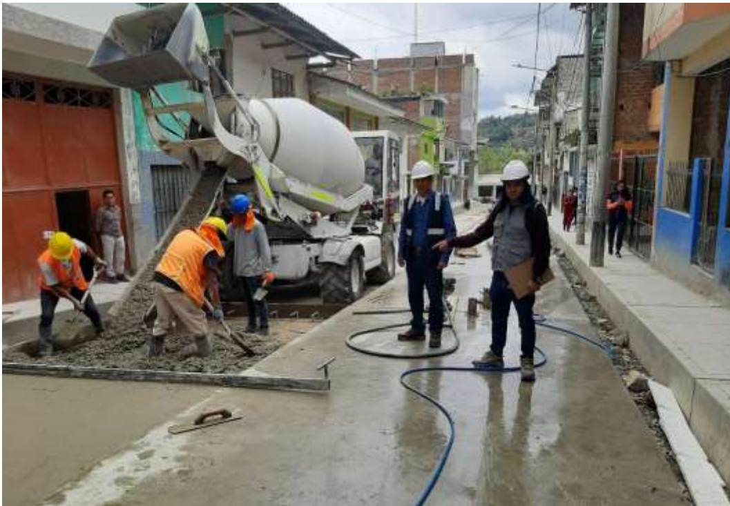
Fotografía 32. Colocación de concreto f'c=210 kg/cm 2 para pavimento rígido e=0.20 m
