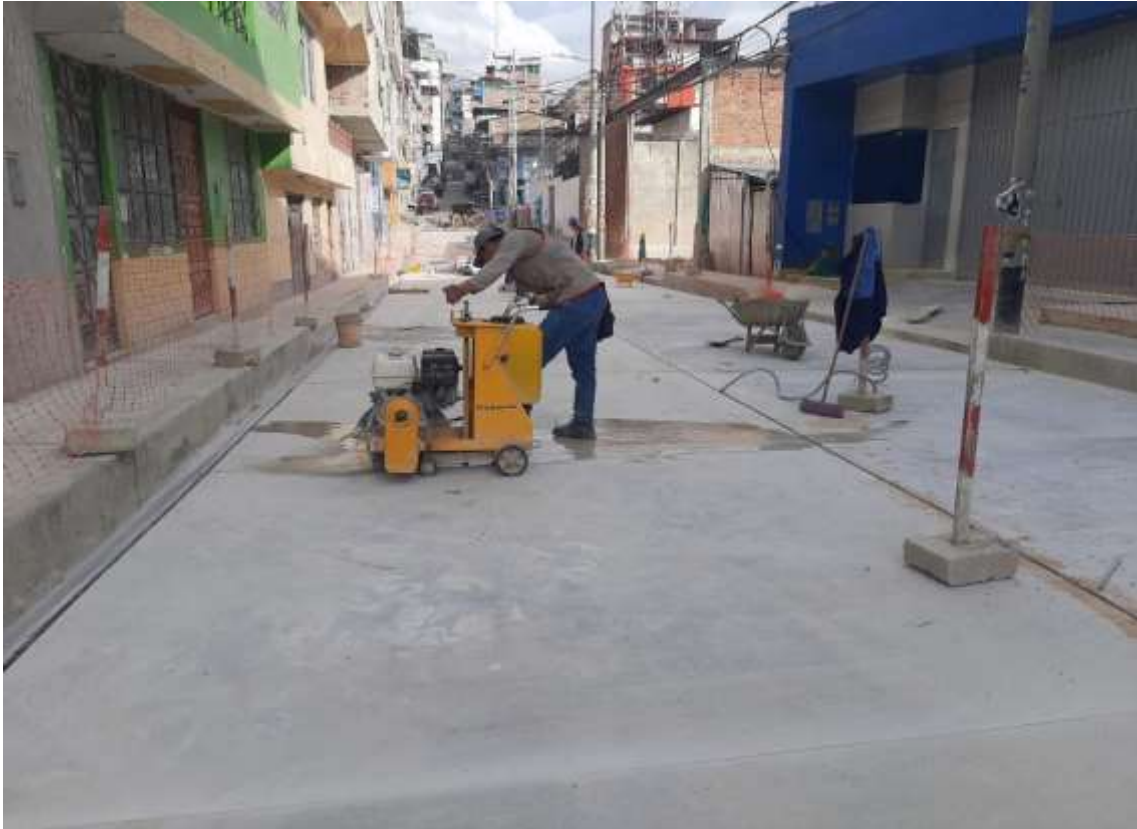
Fotografía 37. Corte de juntas de contracción e=3\text{mm}
