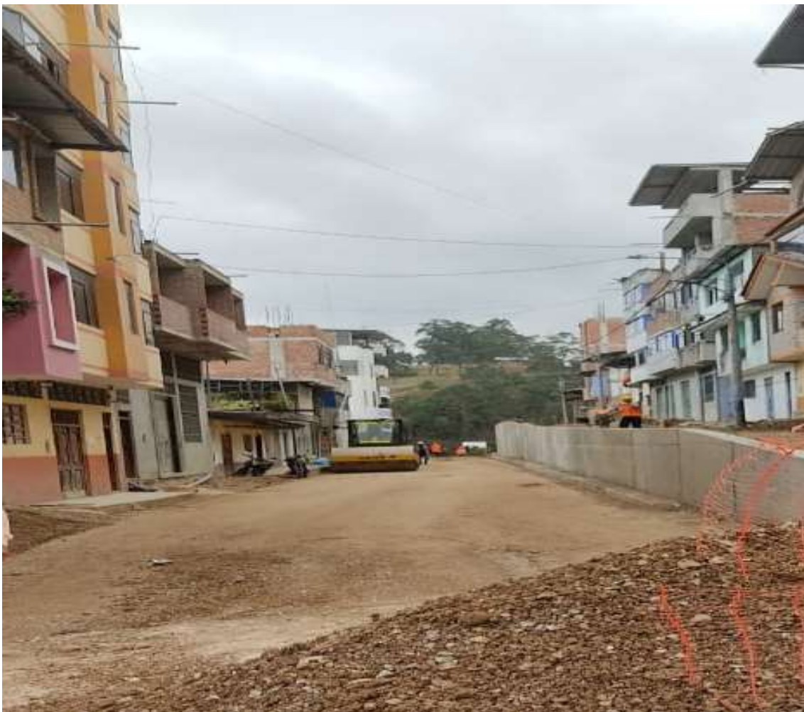
Fotografía 40. Compactación de la subrasante
