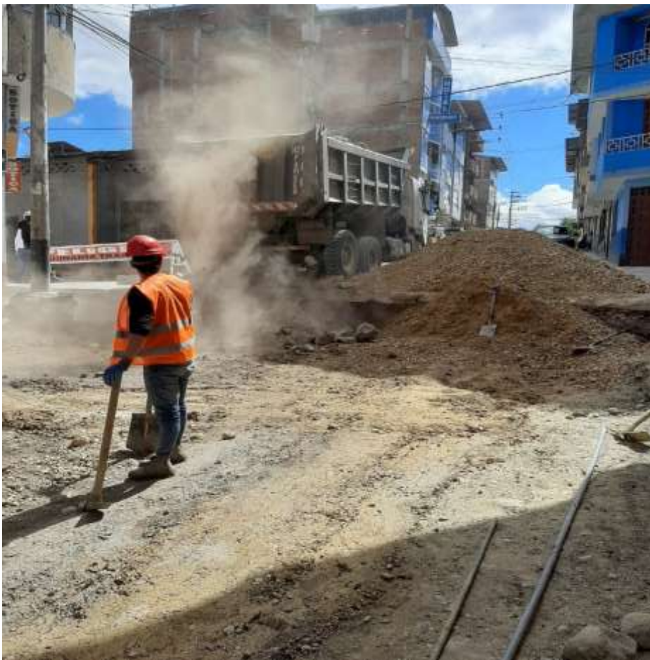
Fotografía 22. Conformacion de sub base granular e=0.20 m
