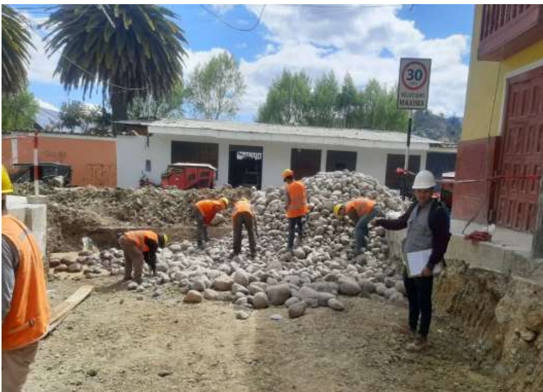
Fotografía 18. Mejoramiento de sub rasante con over e=0.35\text{ m}
