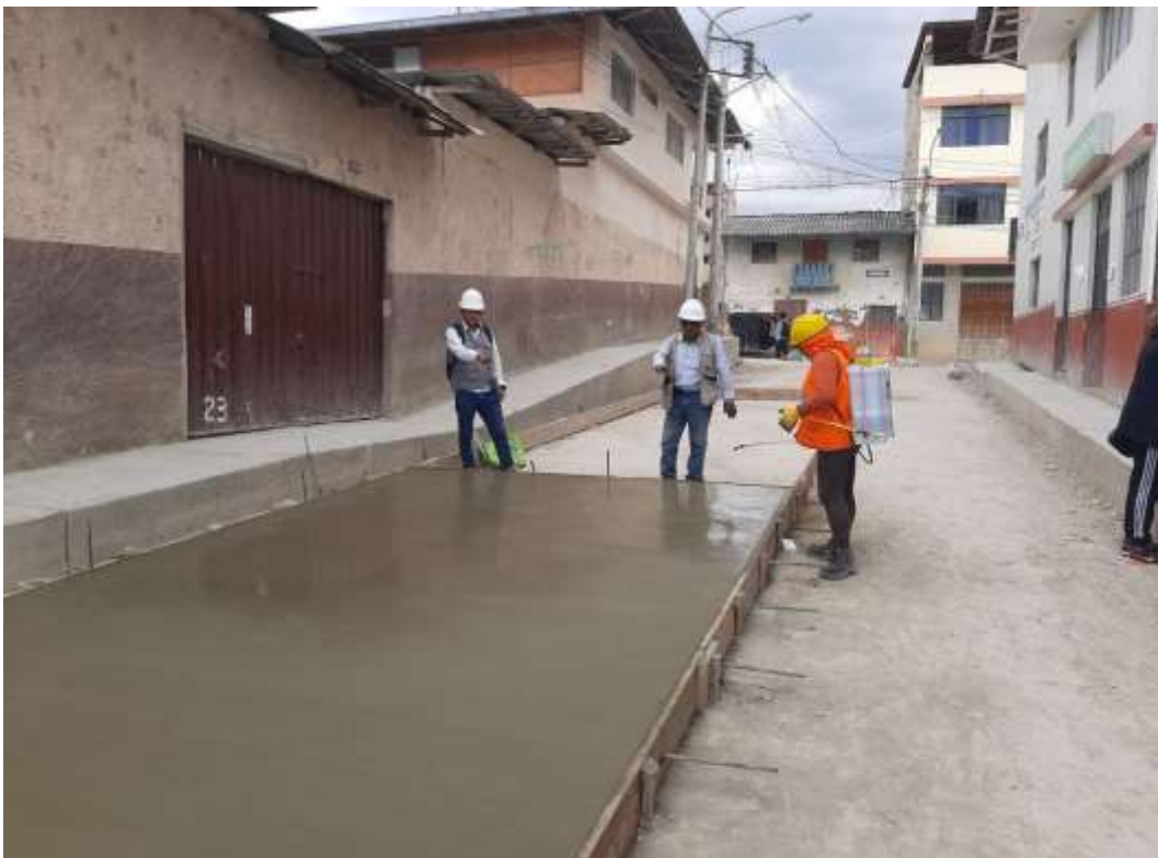
Fotografía 34. Curado de concreto con aditivo
