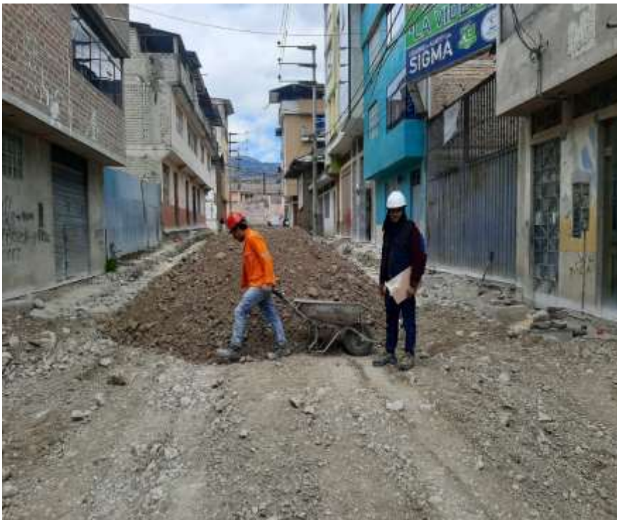
Fotografía 4. Conformación de subbase granular e=0.20 m
