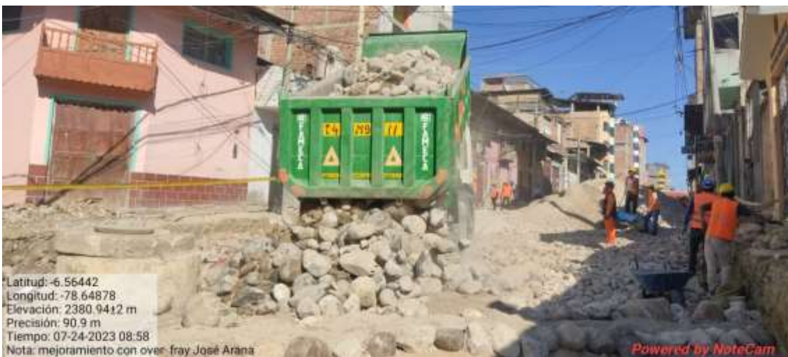
Fotografía 46. Colocación de over en la subrasante
