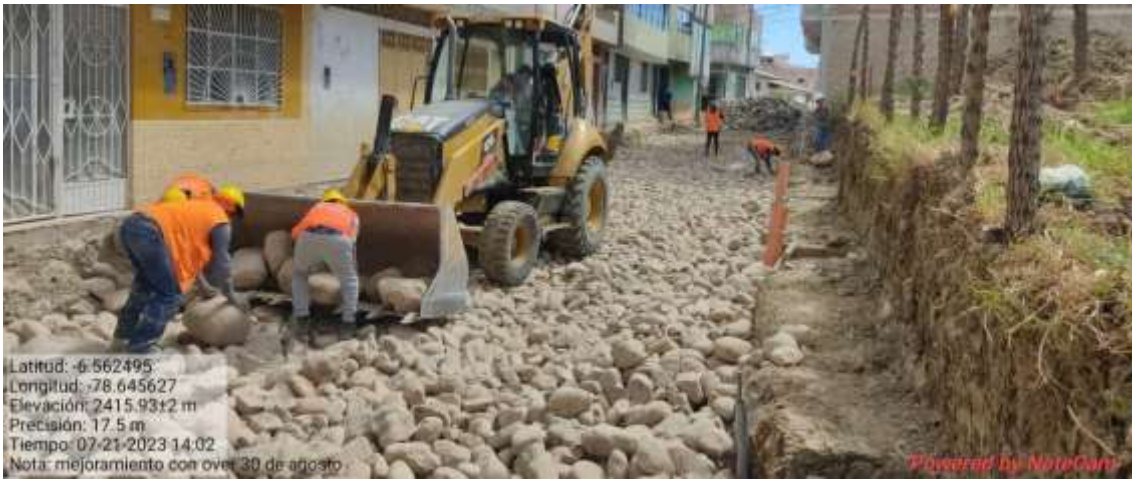
Fotografía 41. Colocación de over en la subrasante
