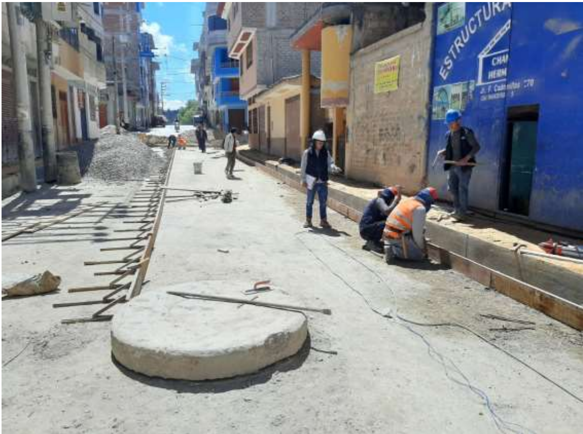
Fotografía 7. Encofrado de losa pavimento
