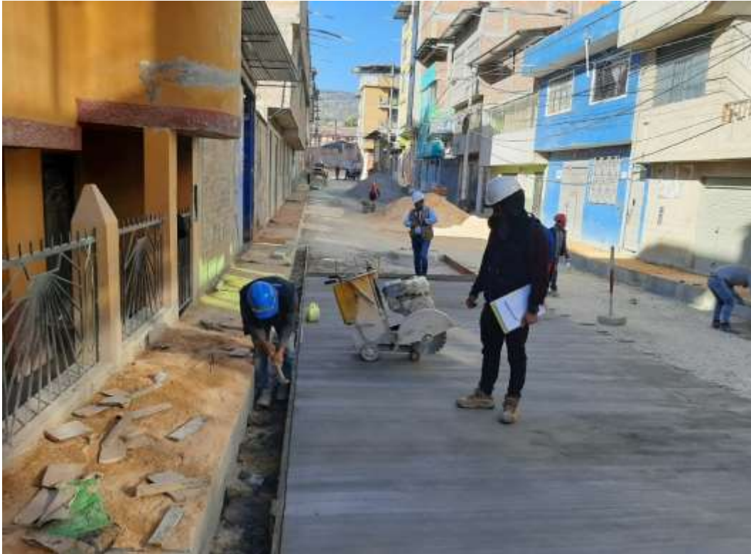
Fotografía 15. Corte de juntas de contracción e=3\text{mm}
