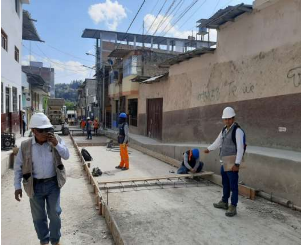
Fotografía 27. Encofrado de losa de pavimento
