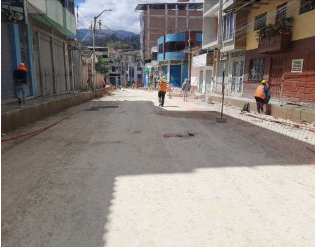
Fotografía 23. Conformación de sub base granular e=0.20 m
