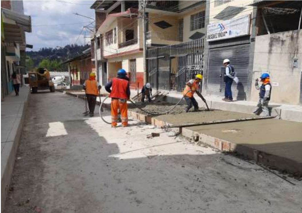
Fotografía 31. Colocación de concreto f'c=210 kg/cm 2 para pavimento rígido e=0.20 m
