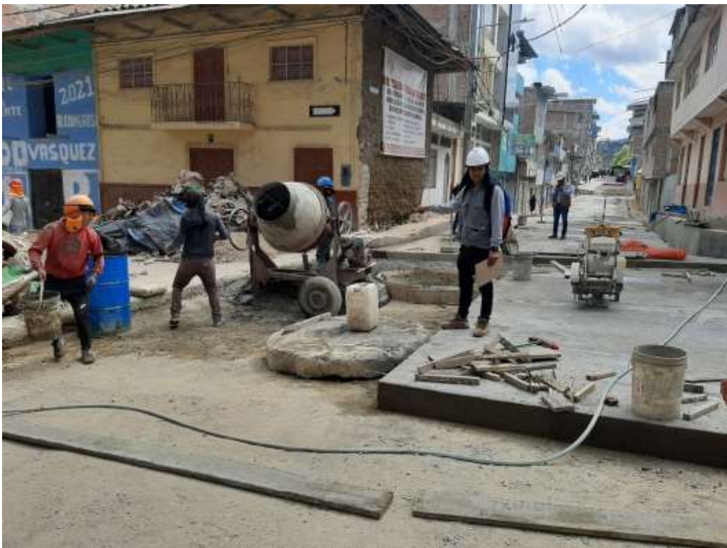
Fotografía 10. Vaciado de Concreto f'_c=210 \text{ kg/cm}^2 para pavimento rígido e=0.20 \text{ m}
