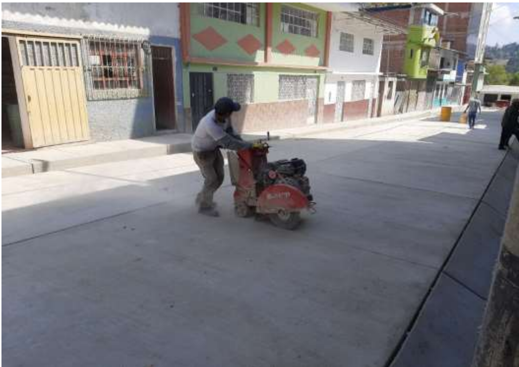
Fotografía 36. Corte de juntas de contracción e=3\text{mm}
