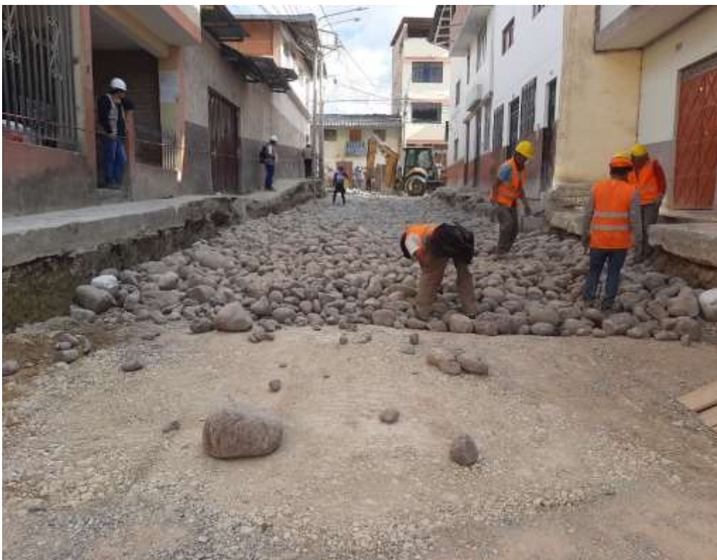
Fotografía 20. Mejoramiento de sub rasante con over e=0.35 m
