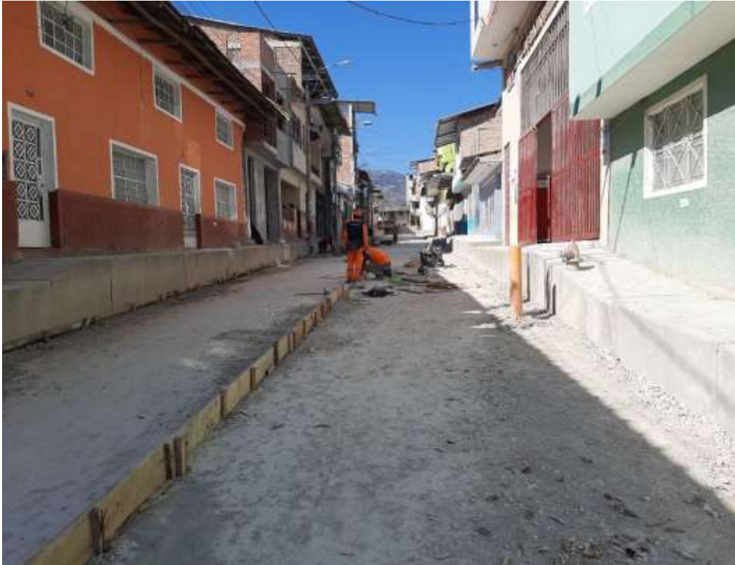
Fotografía 24. Encofrado de losa de pavimento
