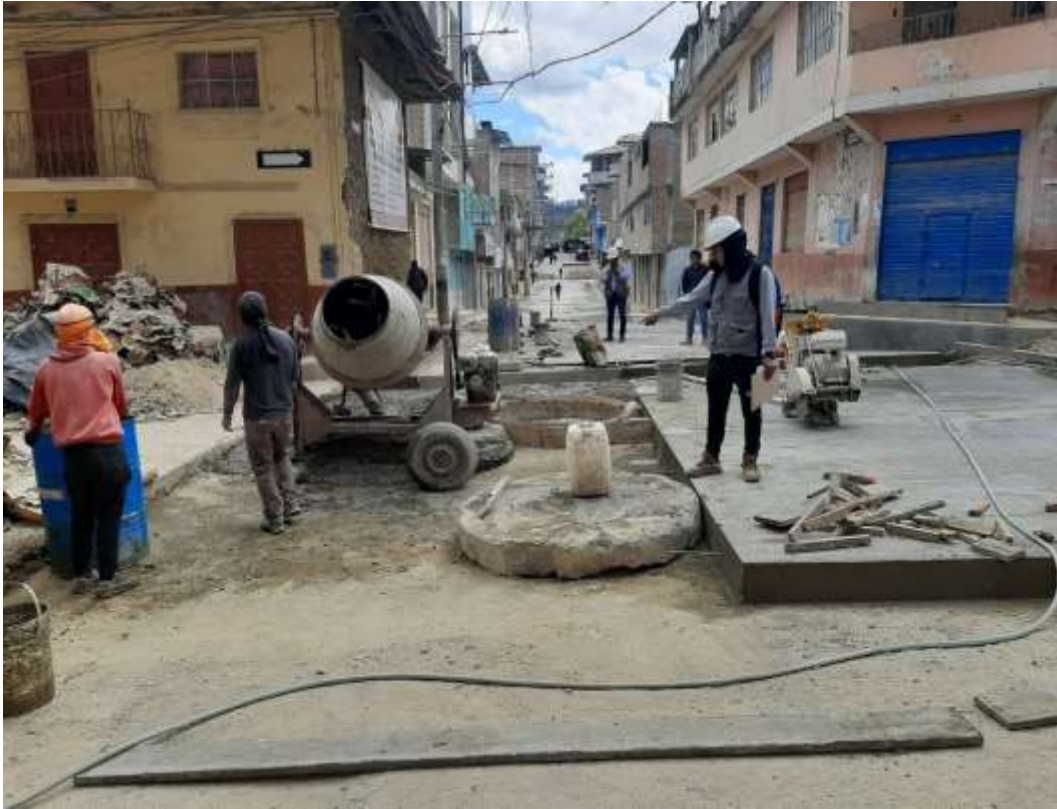
Fotografía 9. Vaciado de Concreto f'_c=210 \text{ kg/cm}^2 para pavimento rígido e=0.20 \text{ m}
