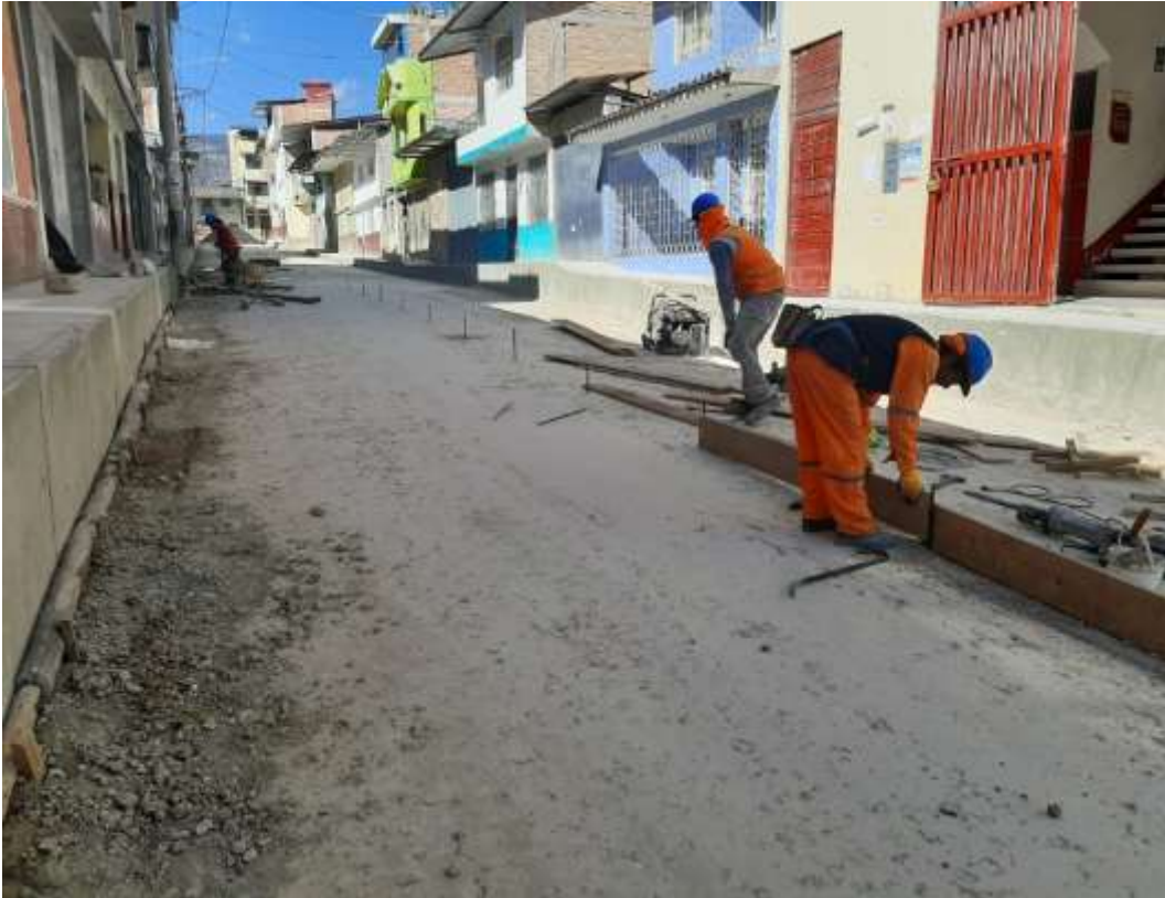
Fotografía 25. Encofrado de losa de pavimento
