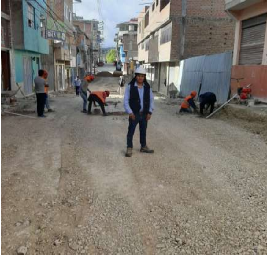
Fotografía 5. Conformación de subbase granular e=0.20 m
