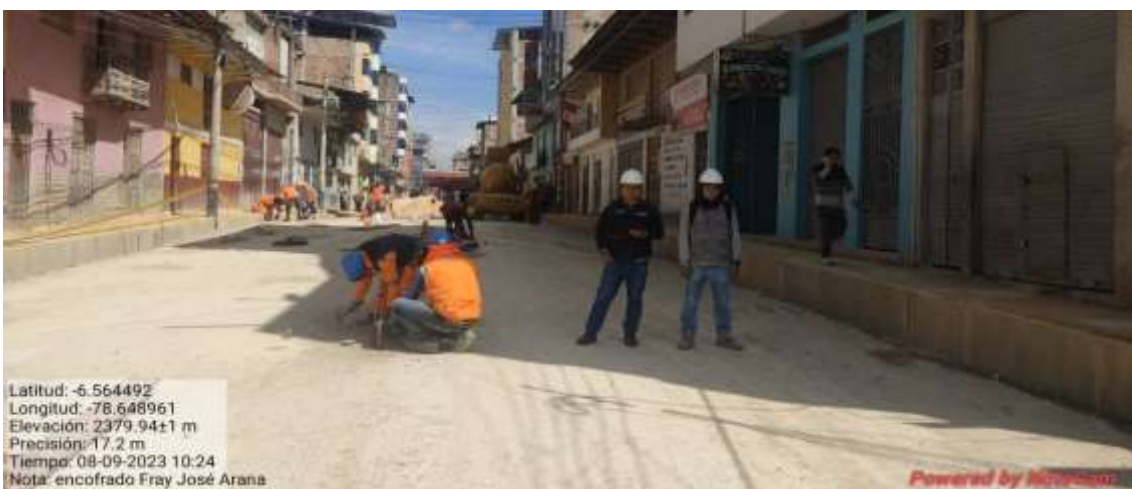
Fotografía 43. Corte de juntas
