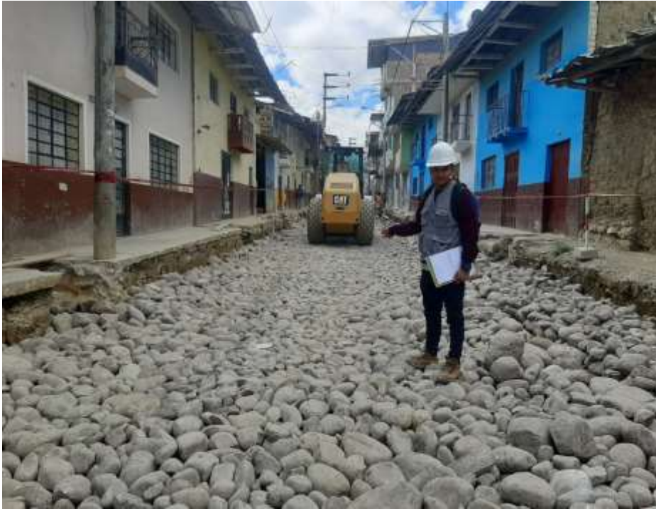
Fotografía 21. Mejoramiento de sub rasante con over e=0.35 m
