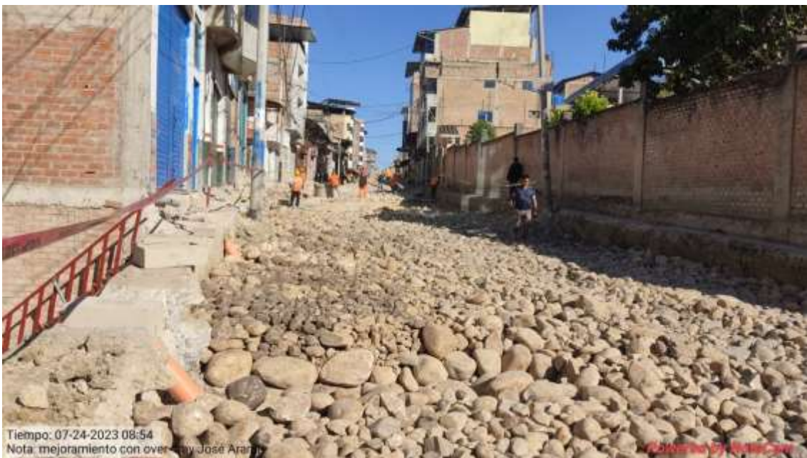
Fotografía 48. Colocación de over en la subrasante para el mejoramiento
