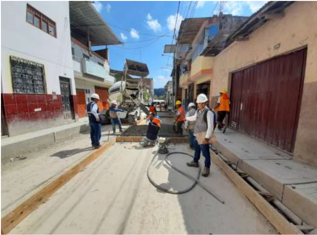
Fotografía 29. Colocación de concreto f'c=210 kg/cm 2 para pavimento rígido e=0.20 m
