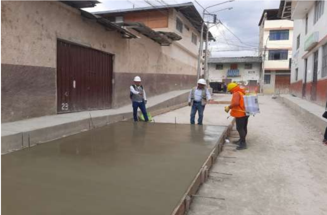
Fotografía 33. Curado de concreto con aditivo
