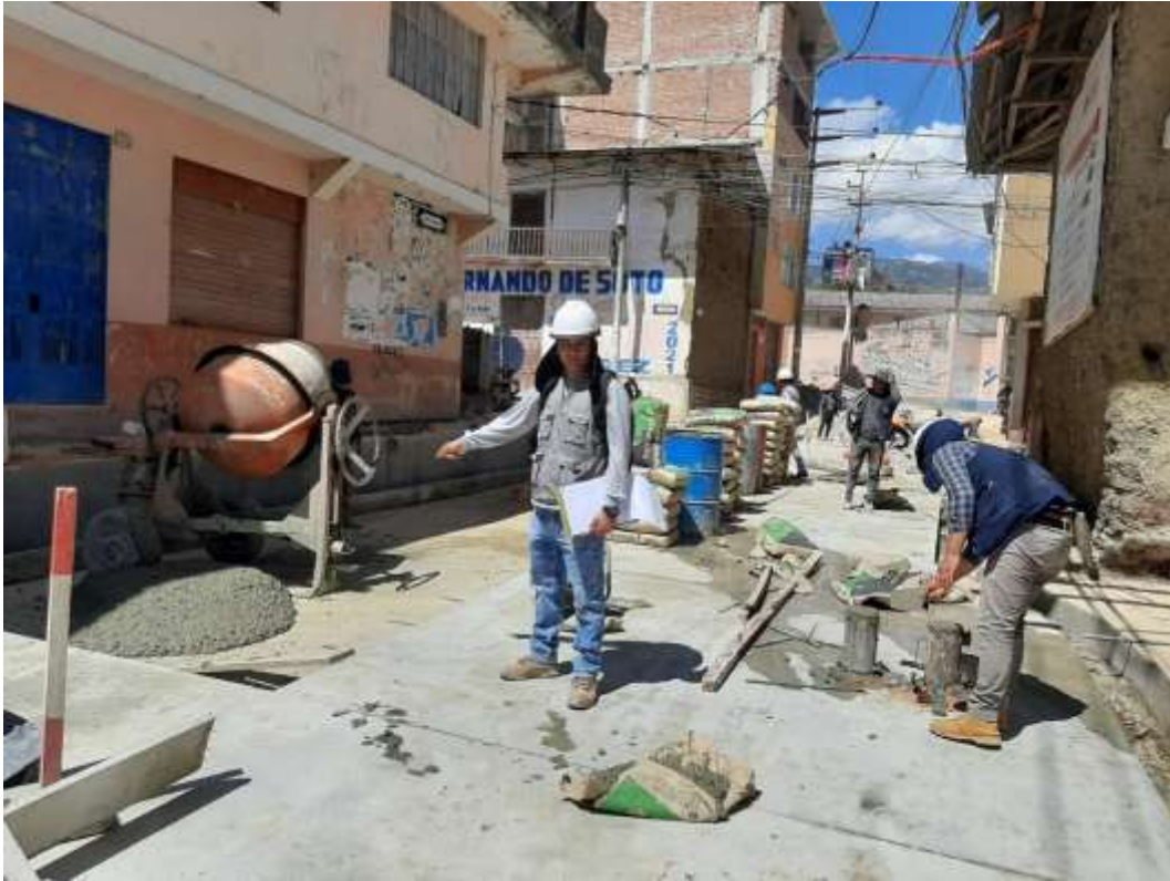
Fotografía 11. Vaciado de Concreto f'c=210 kg/cm 2 para pavimento rígido e=0.20 m
