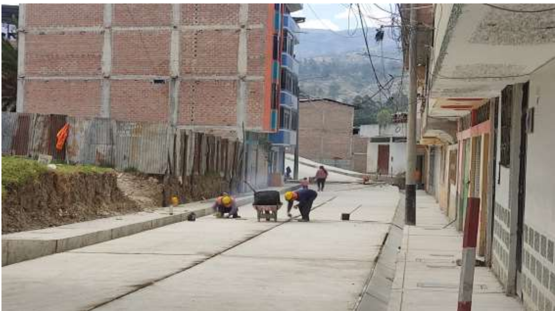
Fotografía 38. Corte de juntas en el pavimento
