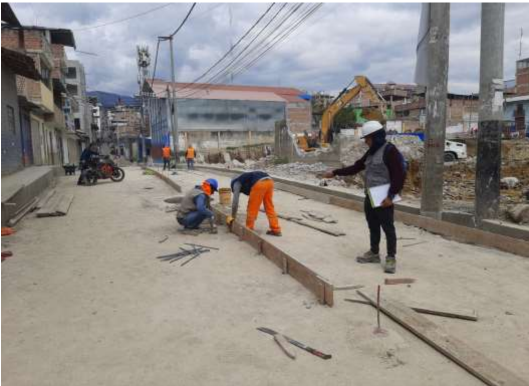
Fotografía 26. Encofrado de losa de pavimento
