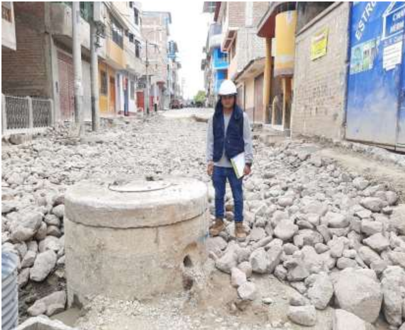
Fotografía 1. Mejoramiento de sub rasante con over e=0.20 m
