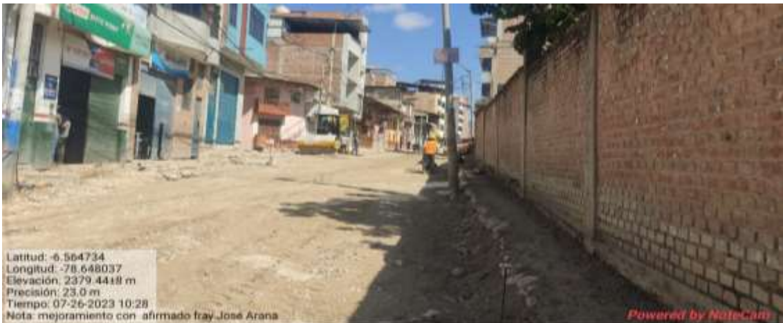
Fotografía 45. Mejoramiento del afirmado con subbase granular
