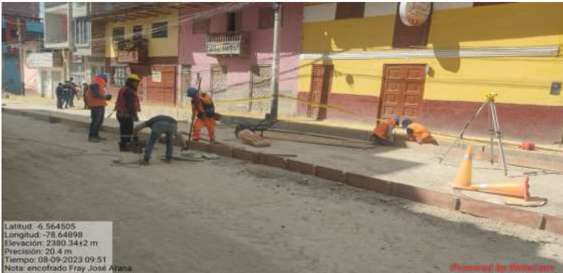
Fotografía 44 Encofrado de la losa de pavimento
