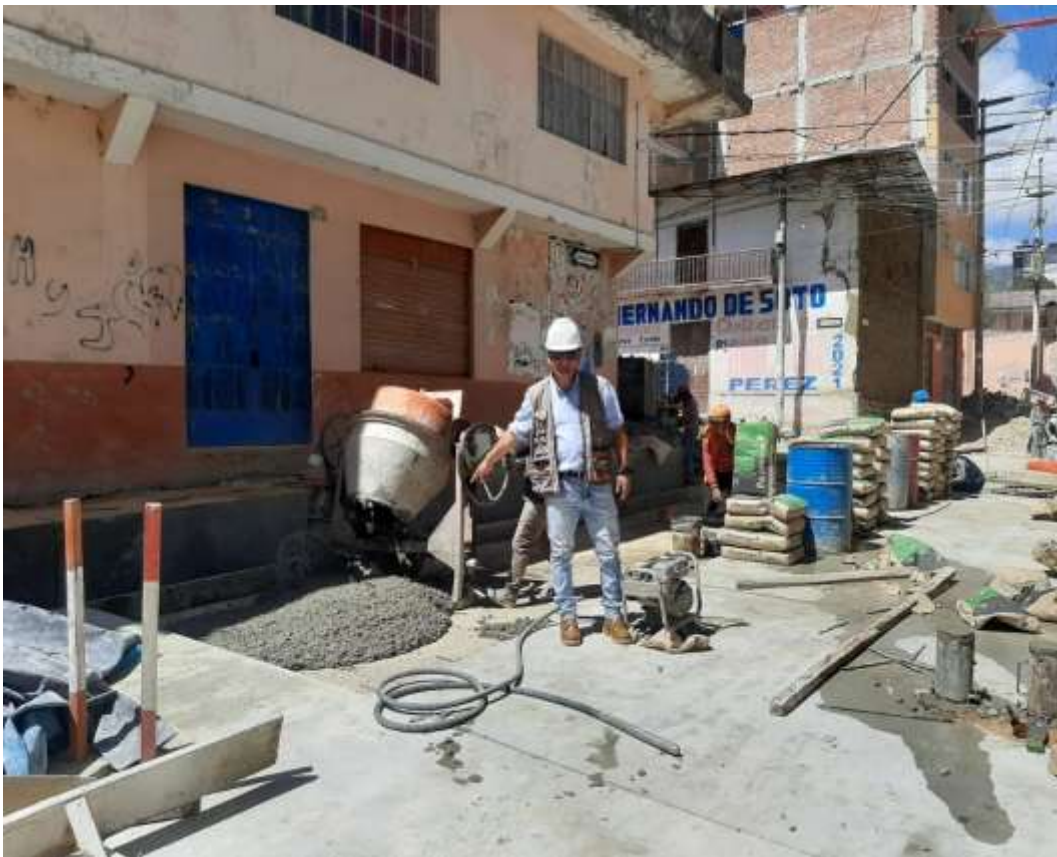
Fotografía 12. Vaciado de Concreto f'c=210 kg/cm 2 para pavimento rígido e=0.20 m
