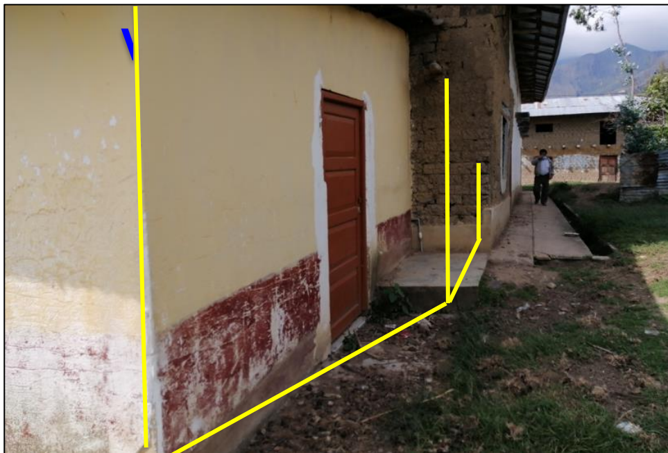
Foto 18: Vista de los vértices VI, VJ y VK, que bordean y unen la I.E. actual, con el predio del terreno donde se construirá la nueva infraestructura.
