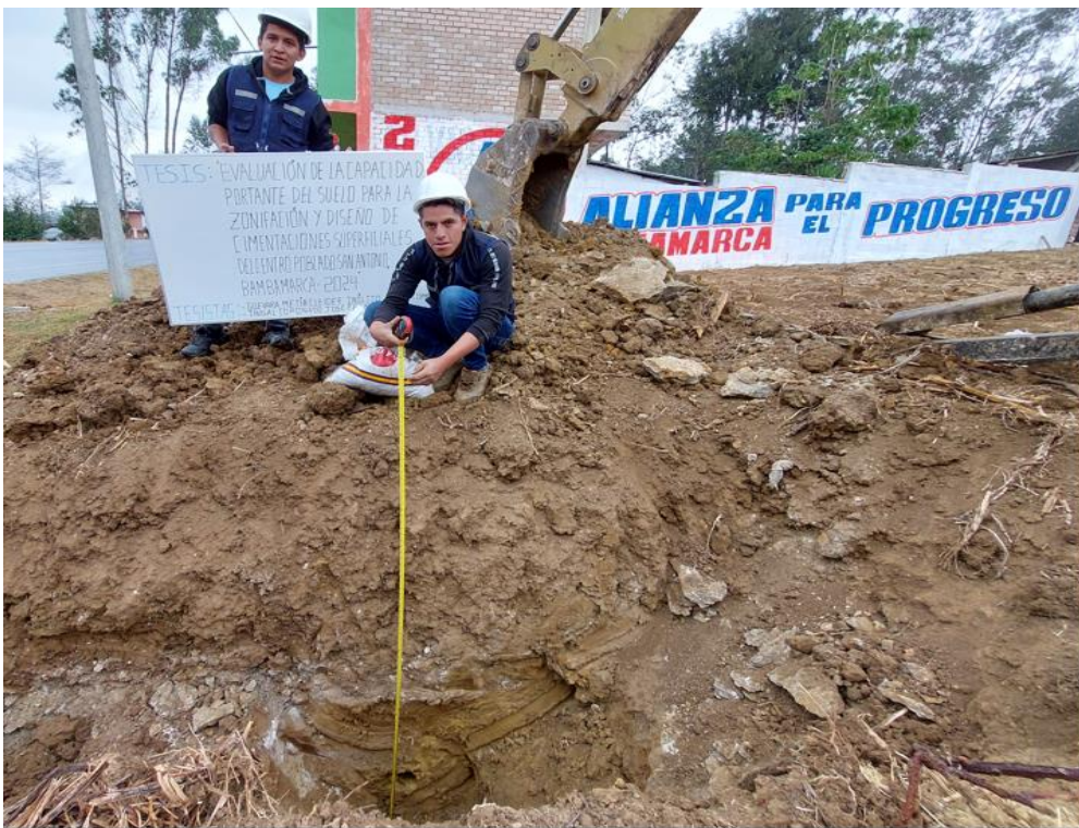
Fotografía 06: Medida de profundidad y extracción de muestras calicata N° 2.
