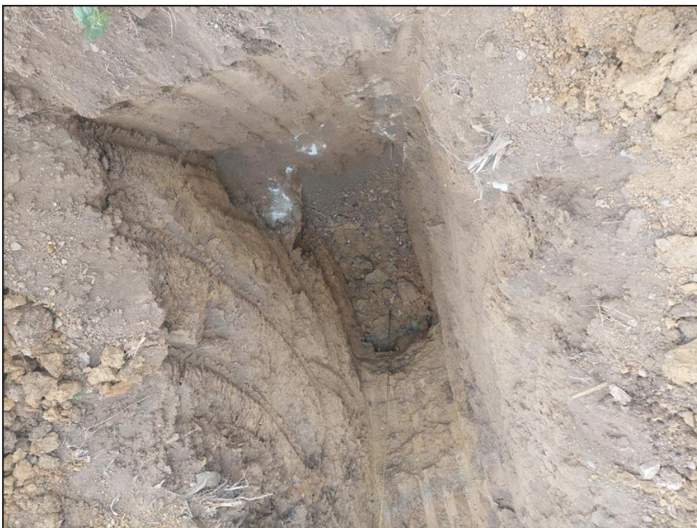
Fotografía 02: Perfil estratigráfico de la calicata N° 1.
