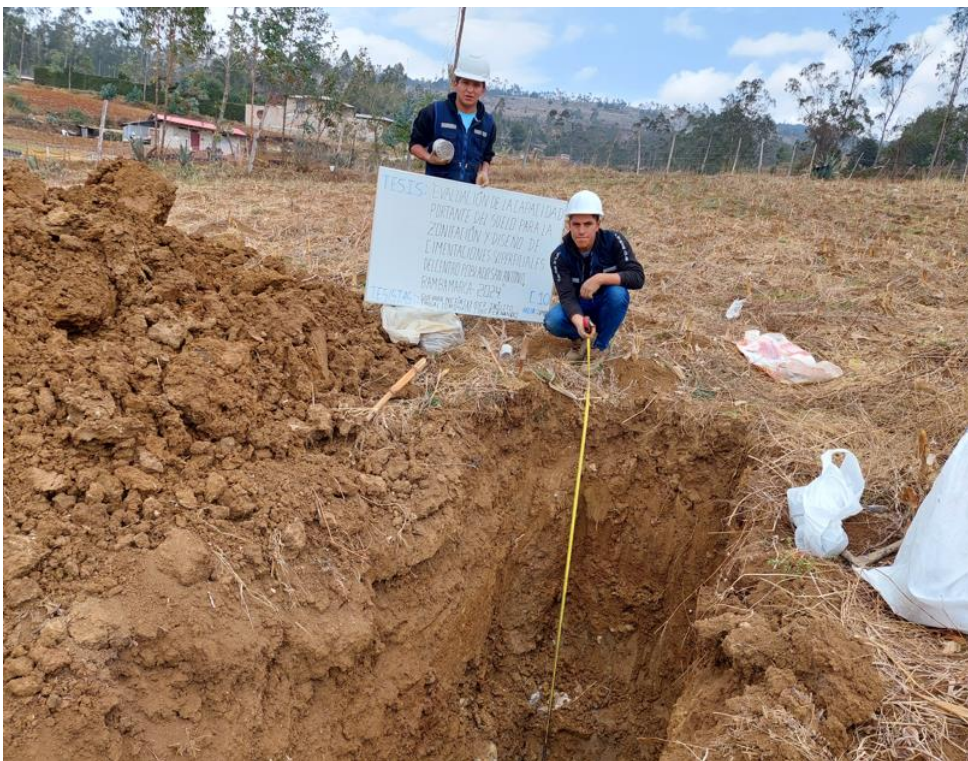
Fotografía 30: Medida de profundidad y extracción de muestras calicata N° 10.
