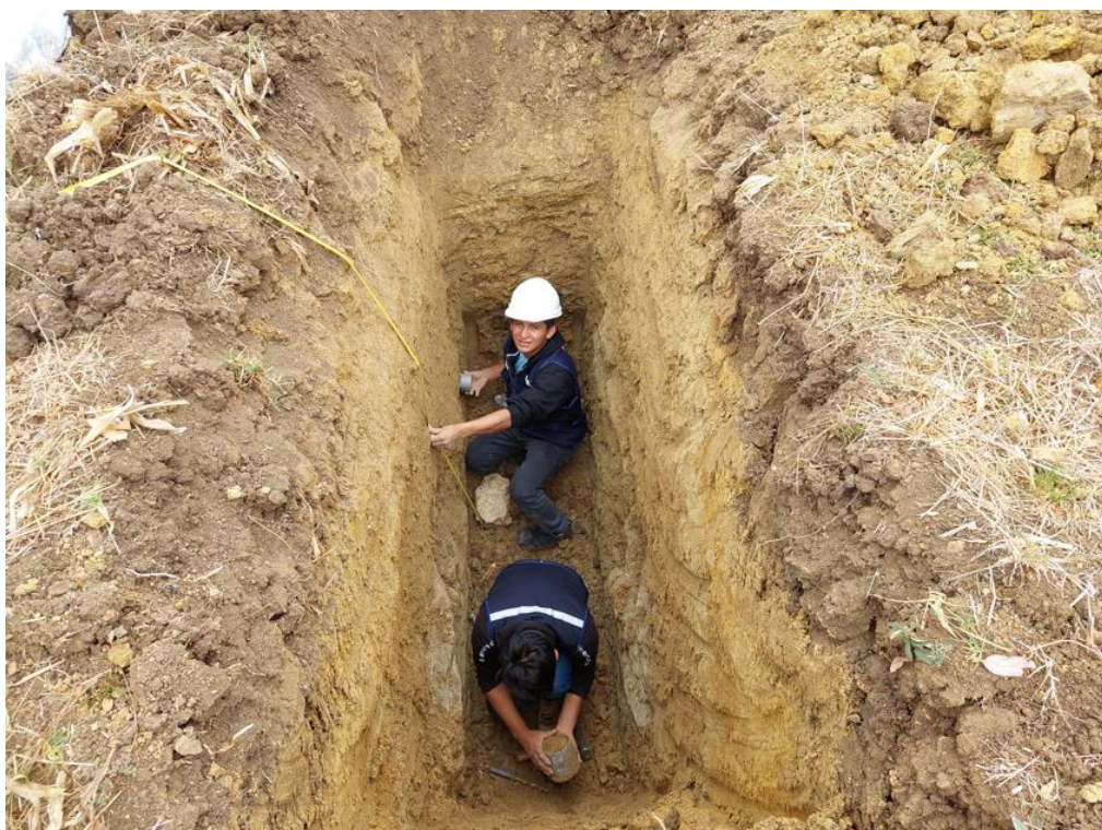
Fotografía 18: Medida de profundidad y extracción de muestras calicata N° 6.
