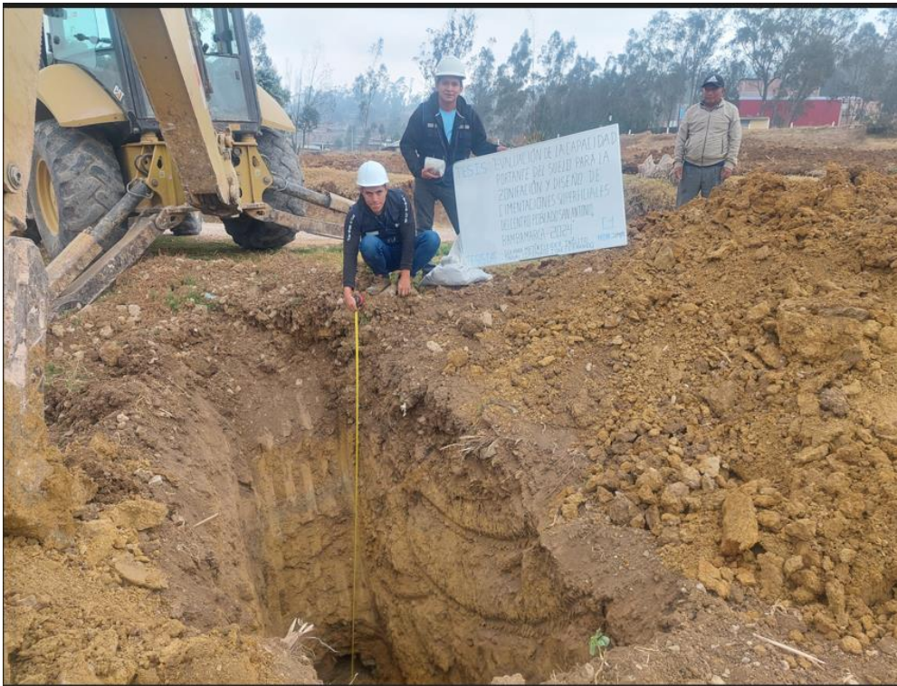
Fotografía 03: Medida de profundidad y extracción de muestras calicata N° 1.
