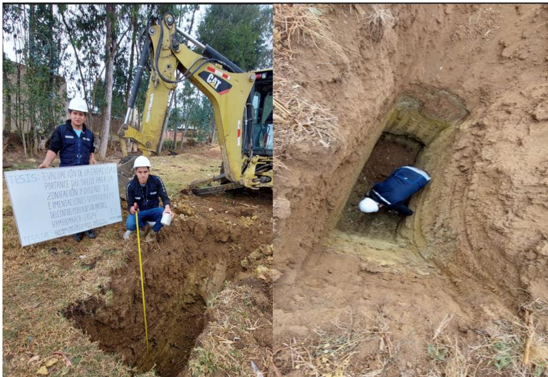
Fotografía 09: Medida de profundidad y extracción de muestras calicata N° 3.
