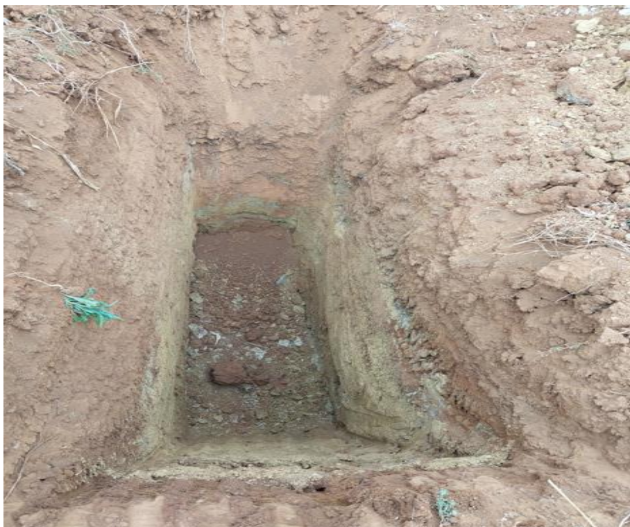
Fotografía 23: Perfil estratigráfico de la calicata N° 8.
