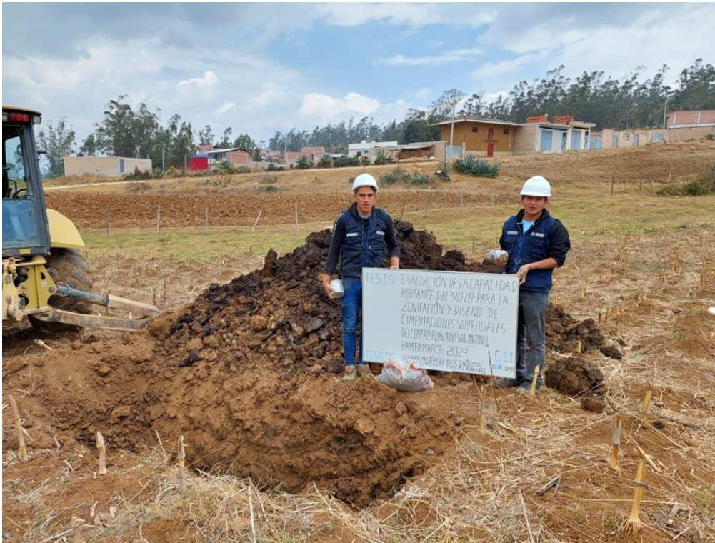
Fotografía 31: Excavación de la calicata N° 11.
