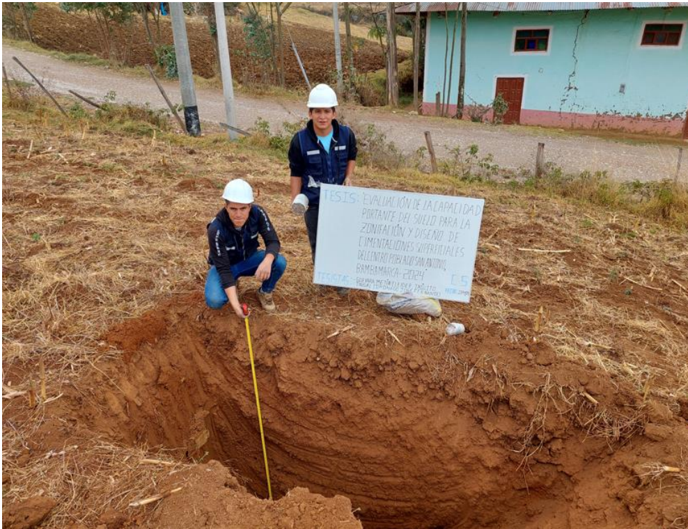
Fotografía 15: Medida de profundidad y extracción de muestras calicata N° 5.
