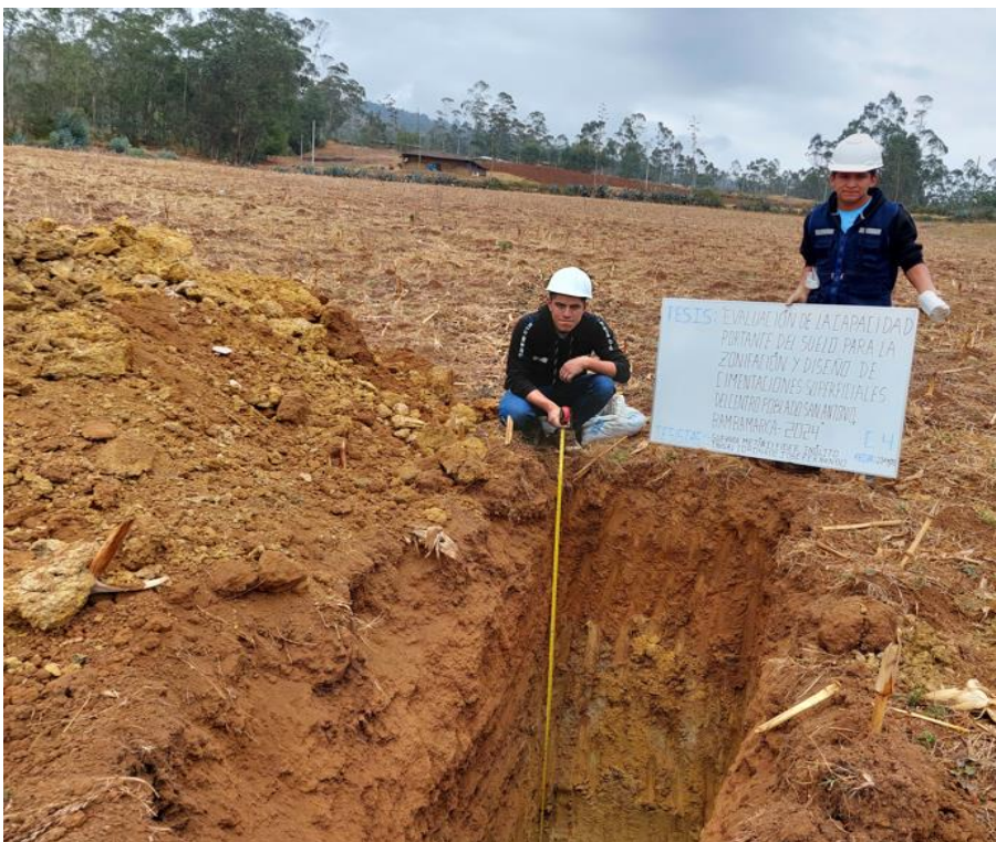
Fotografía 12: Medida de profundidad y extracción de muestras calicata N° 4.
