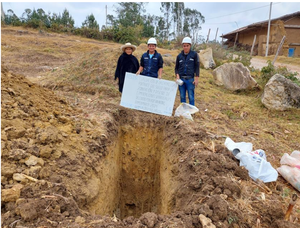
Fotografía 16: Excavación de la calicata N° 6.
