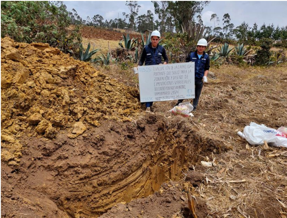
Fotografía 19: Excavación de la calicata N° 7.
