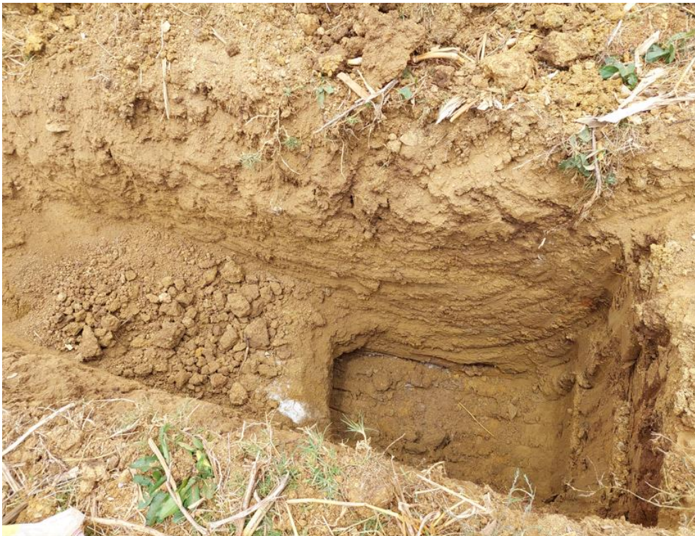
Fotografía 26: Perfil estratigráfico de la calicata N° 9.
