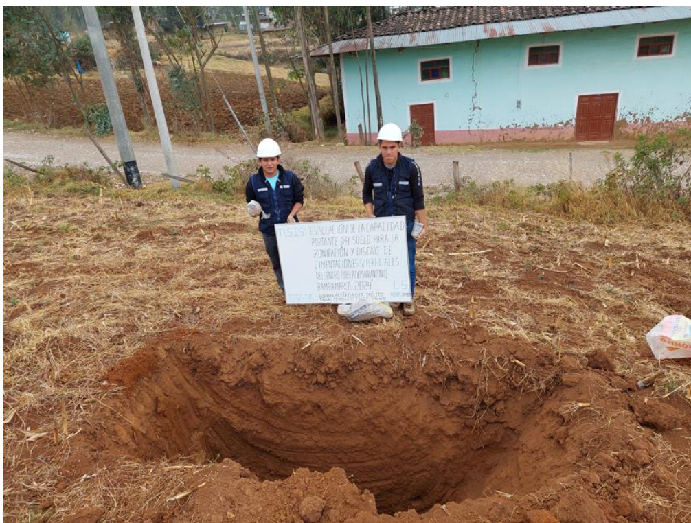
Fotografía 13: Excavación de la calicata N° 5.
