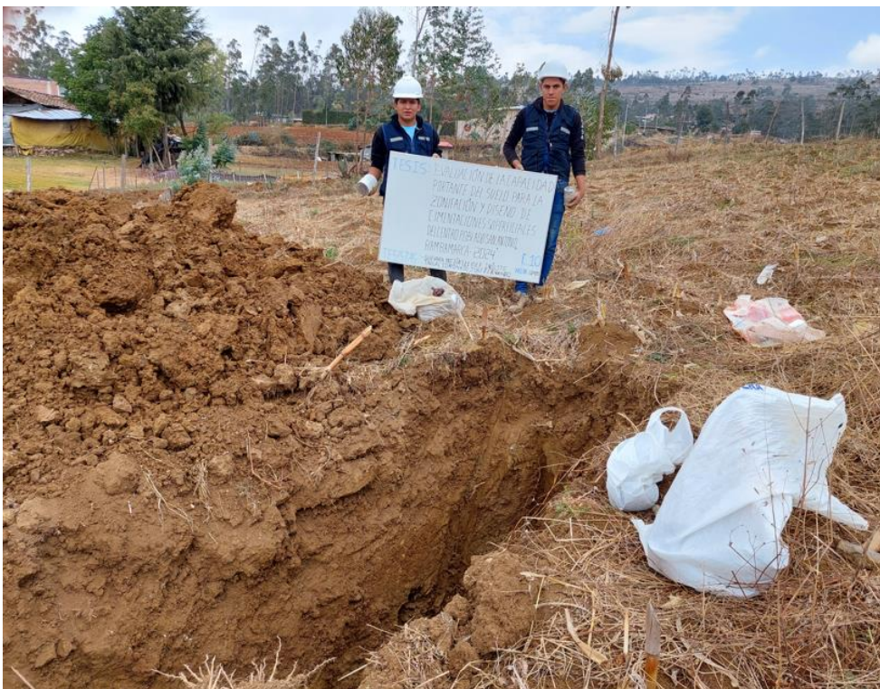
Fotografía 28: Excavación de la calicata N° 10.
