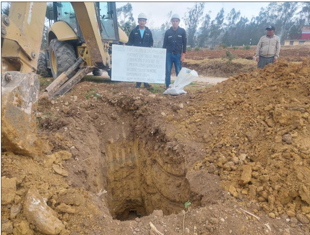
Fotografía 01: Excavación de la calicata N° 1.
