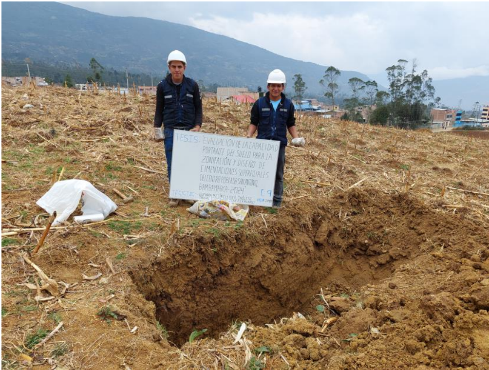
Fotografía 25: Excavación de la calicata N° 9.
