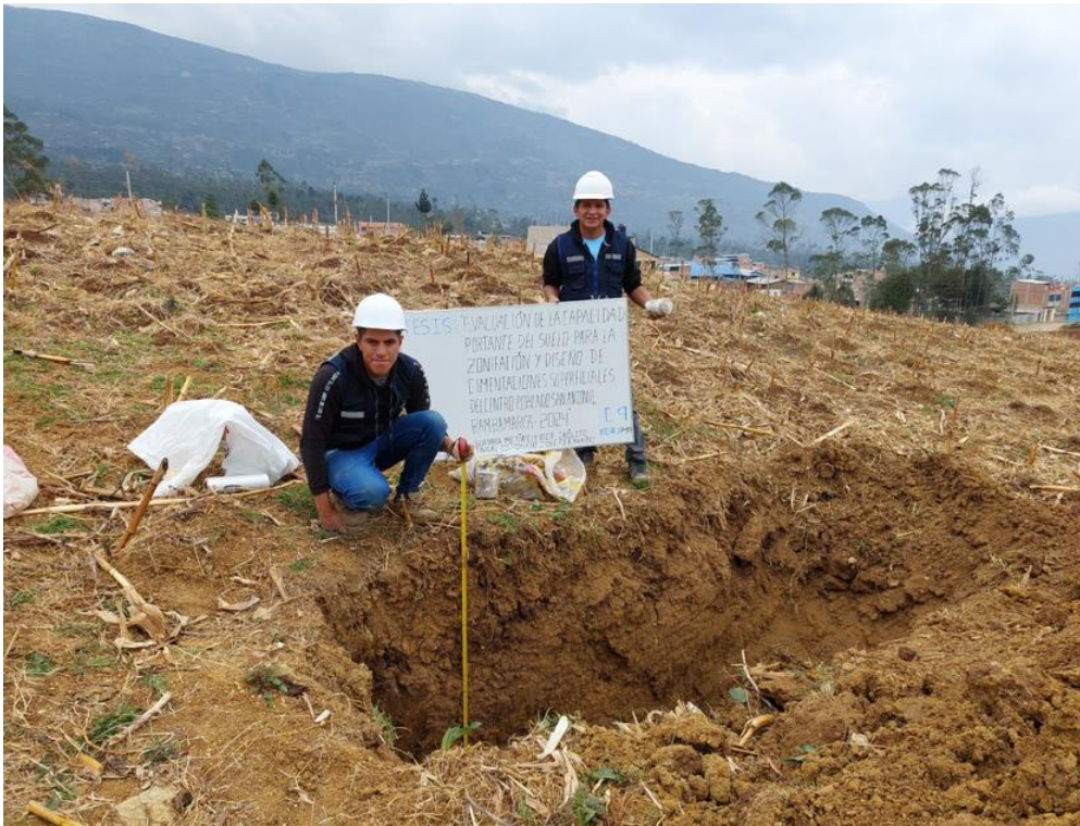
Fotografía 27: Medida de profundidad y extracción de muestras calicata N° 9.
