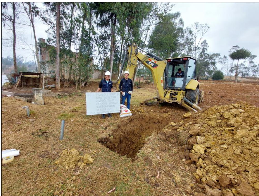
Fotografía 07: Excavación de la calicata N° 3.
