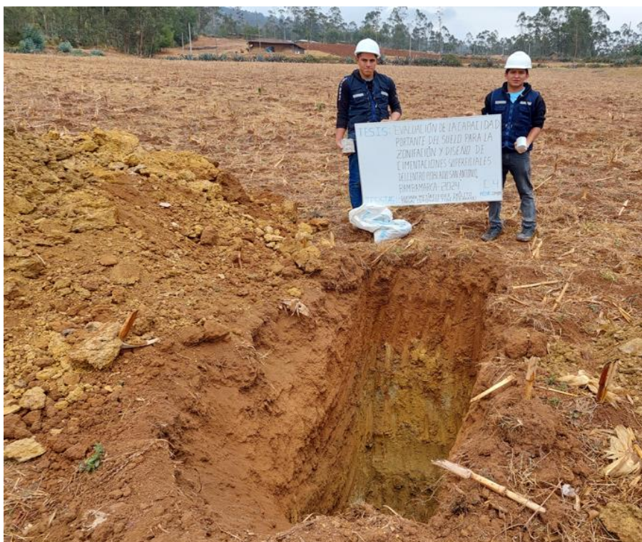
Fotografía 10: Excavación de la calicata N° 4.
