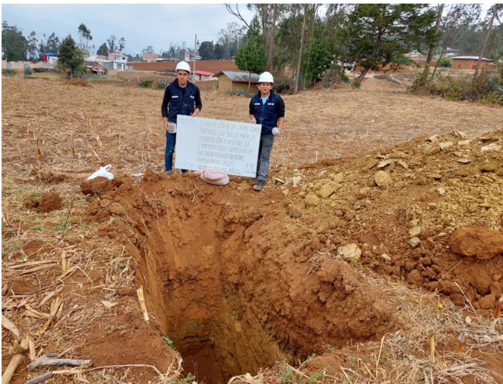
Fotografía 22: Excavación de la calicata N° 8.
