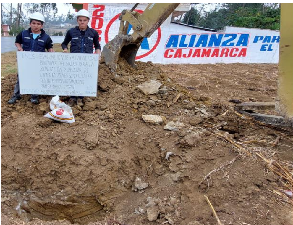
Fotografía 04: Excavación de la calicata N° 2.
