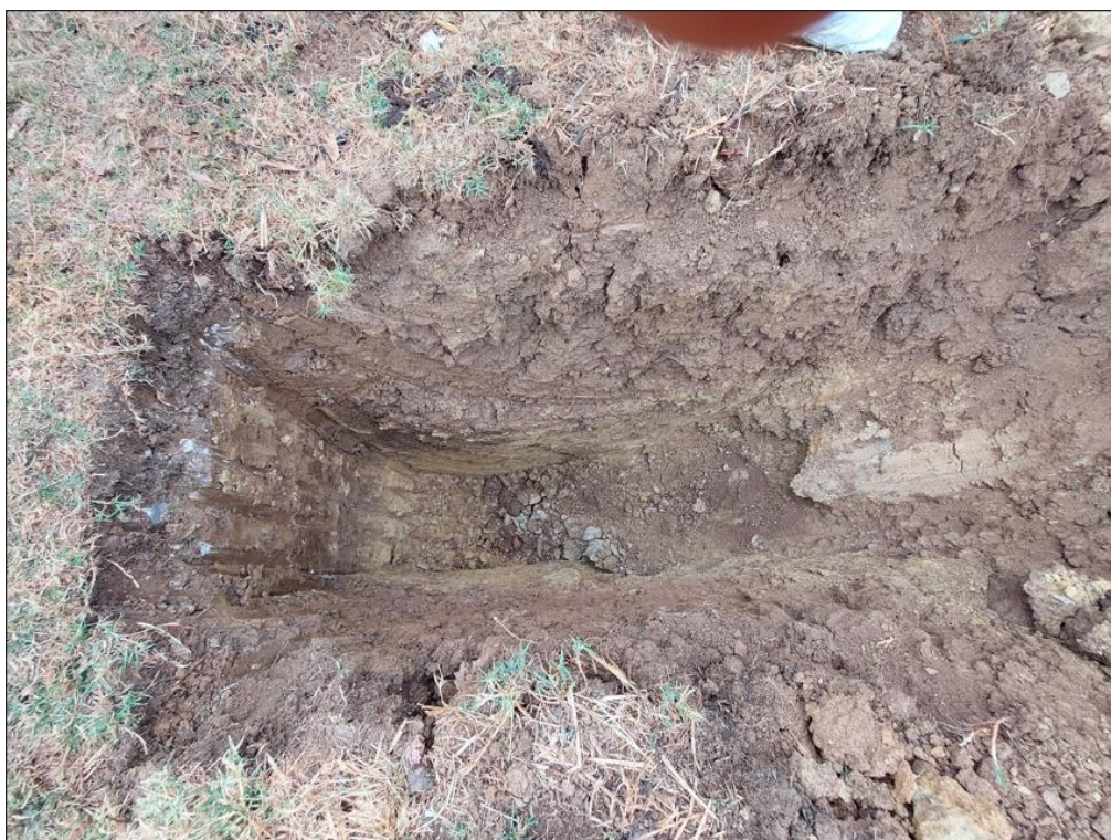
Fotografía 08: Perfil estratigráfico de la calicata N° 3.
