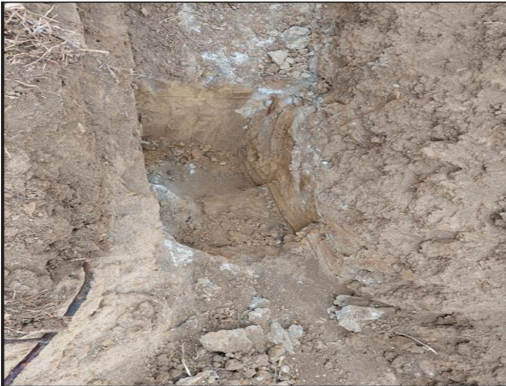
Fotografía 05: Perfil estratigráfico de la calicata N° 2.
