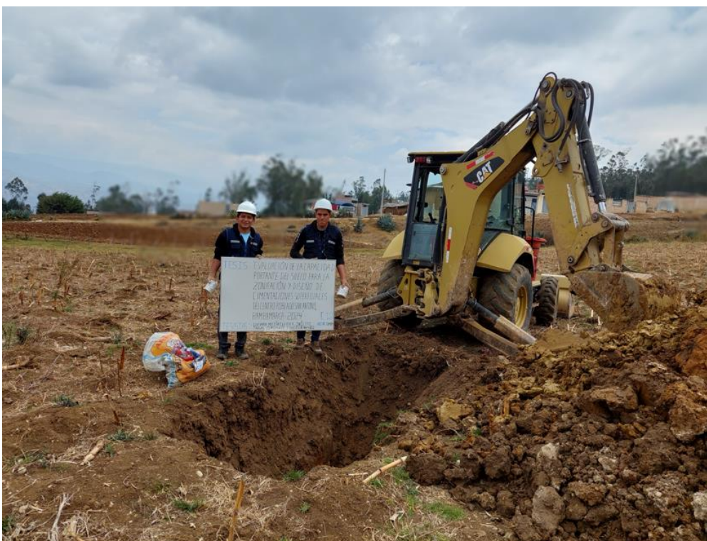
Fotografía 34: Excavación de la calicata N° 12.
