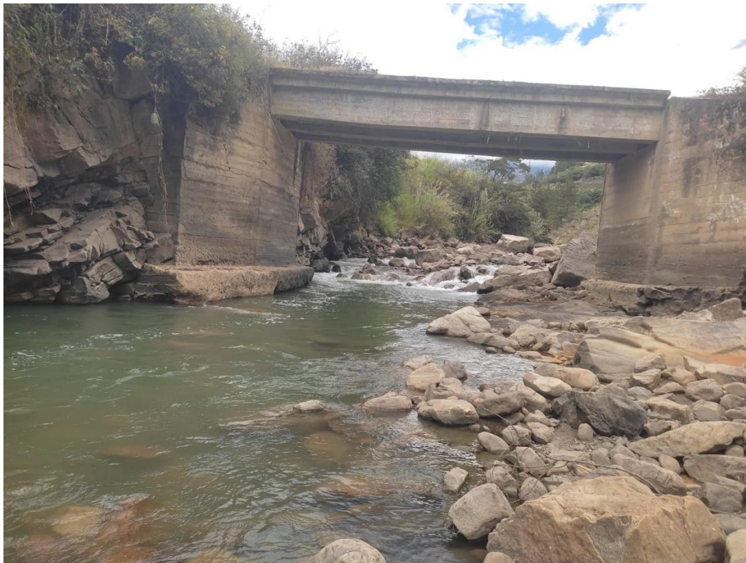
Fotografía 4. Véase la socavación del estribo derecho del puente Chontabamba
