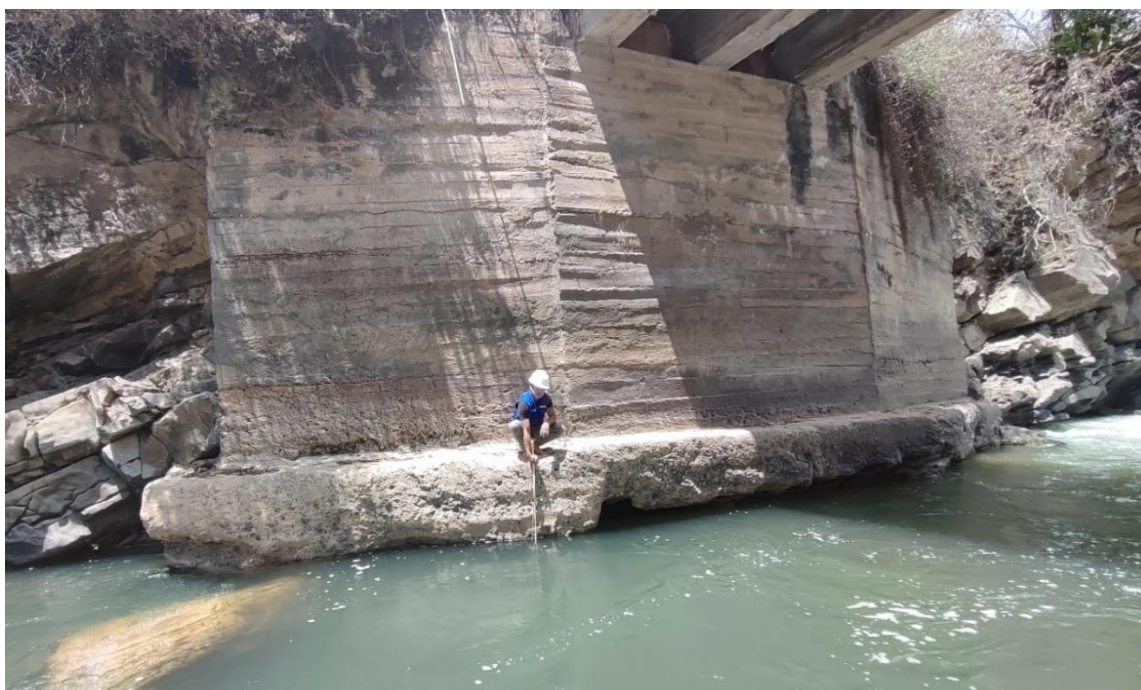
Fotografía 4. Véase la socavación del estribo derecho del puente Chontabamba
