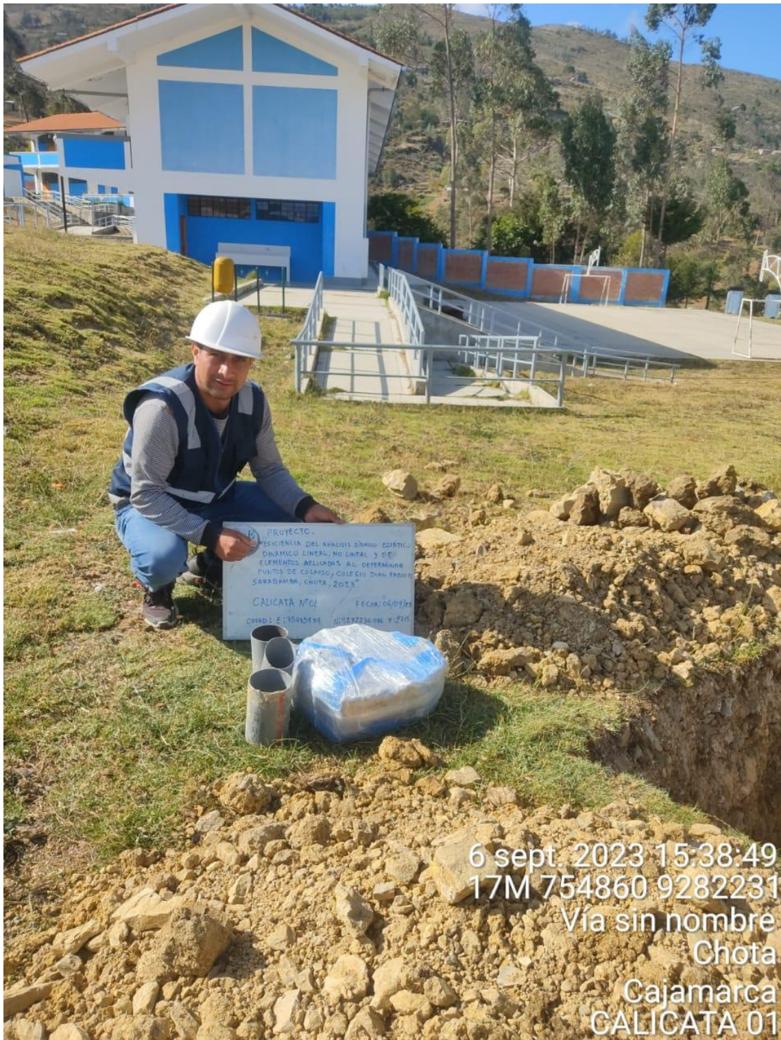
Fotografía 9 Excavación de Calicata para Estudio de mecánica de suelos
