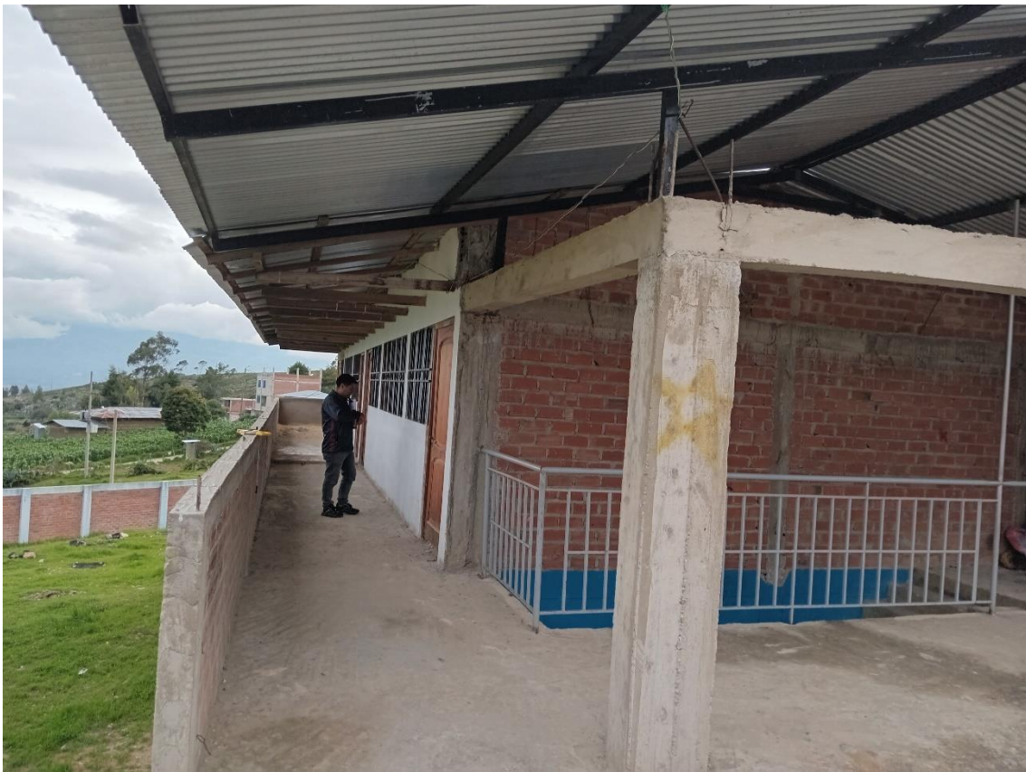
Fotografía 8 Verificación de las dimensiones de los elementos estructurales en el colegio
