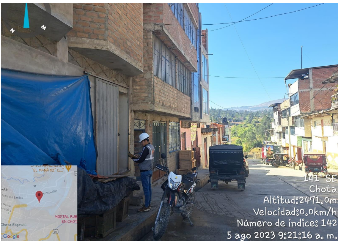
Fotografía 9. Registro de dimensiones de los elementos estructurales de las edificaciones para el análisis de cargas
