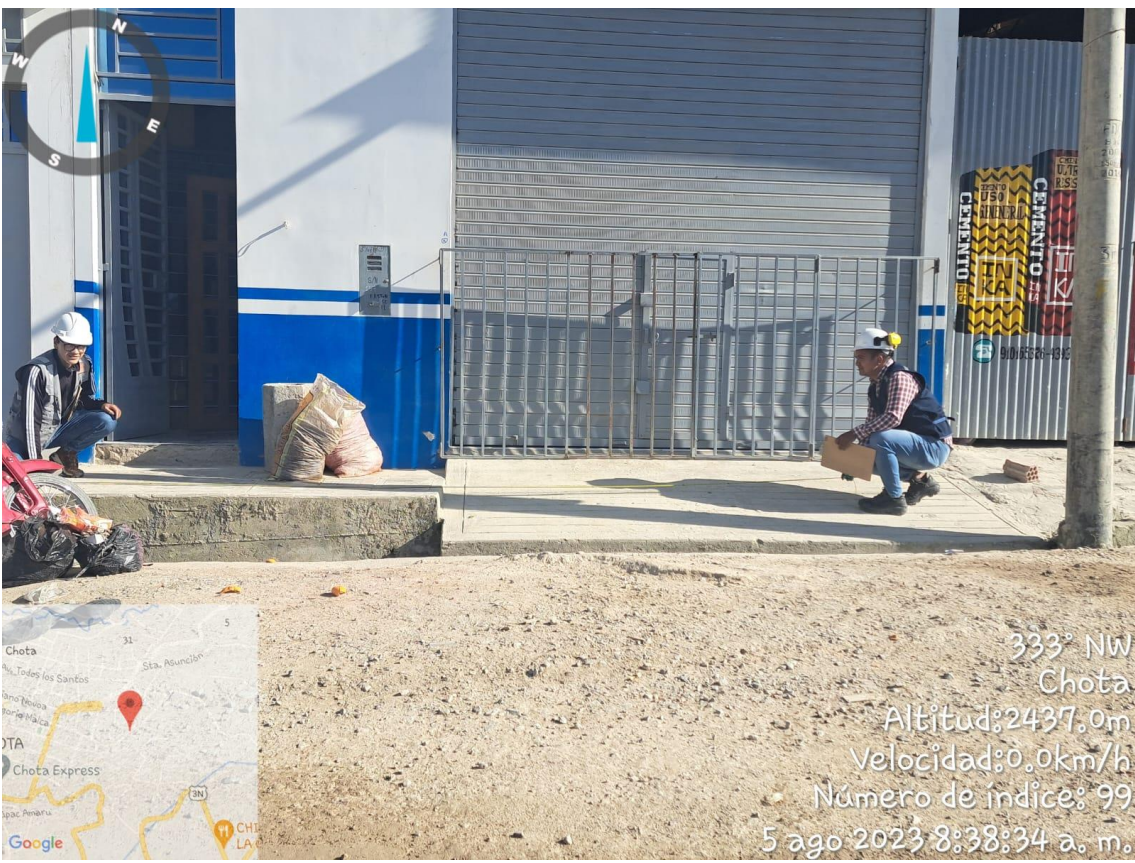
Fotografía 11. Realización del ensayo SPT en la ladera de la Av. Agricultura
