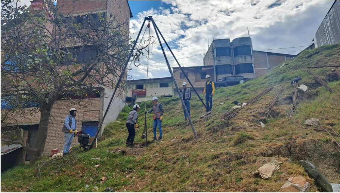
Fotografía 12. Aplicación de la carga en el ensayo de SPT
