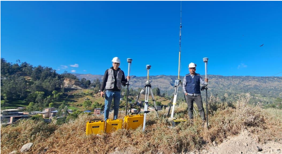
Fotografía 2. Realización del levantamiento topográfico
