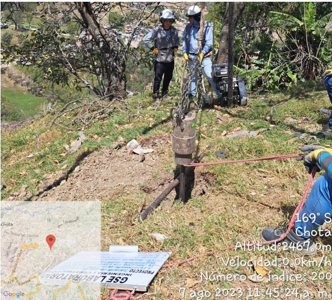
Fotografía 13. Tesistas durante la realización del ensayo SPT con recuperación de muestra
