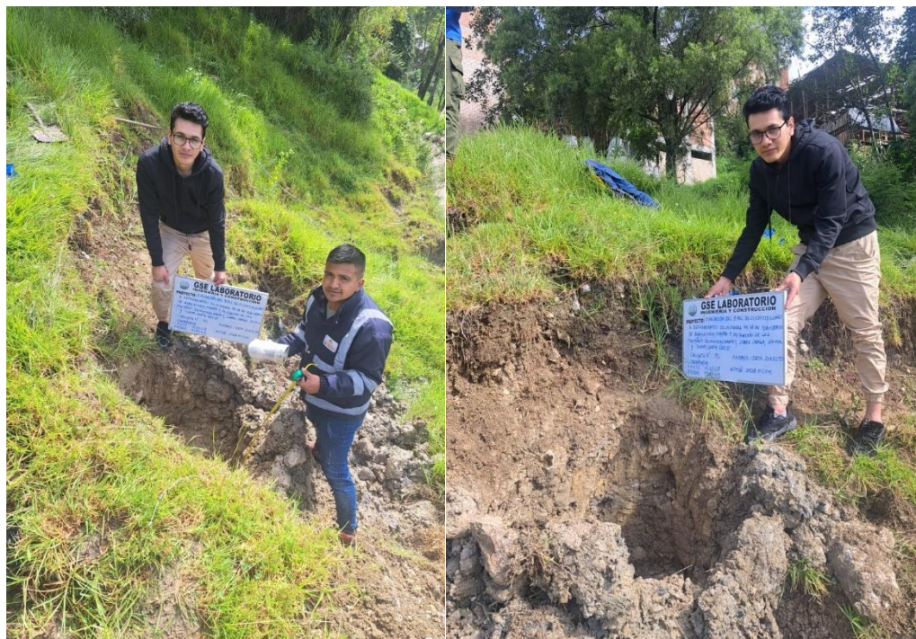
Vista de la Excavación de las Calicatas en el Talud
