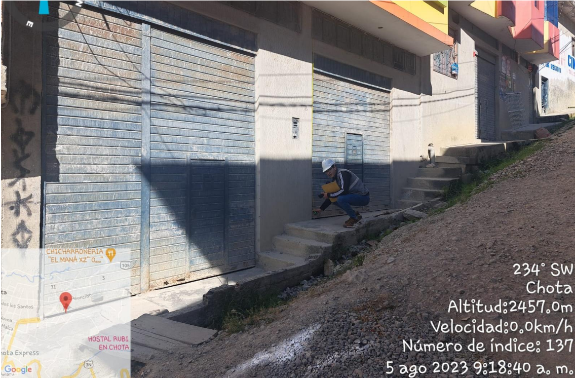
Fotografía 10. Registro de dimensiones externas de la edificación para análisis de cargas
