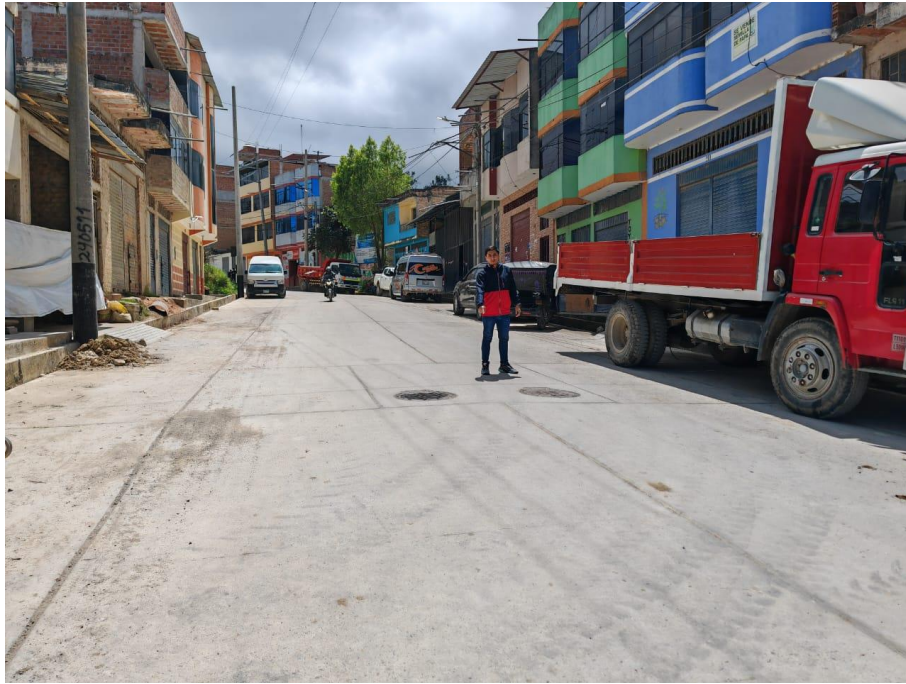
Fotografía N° 11: Válvula reductora de presión N° 1.
