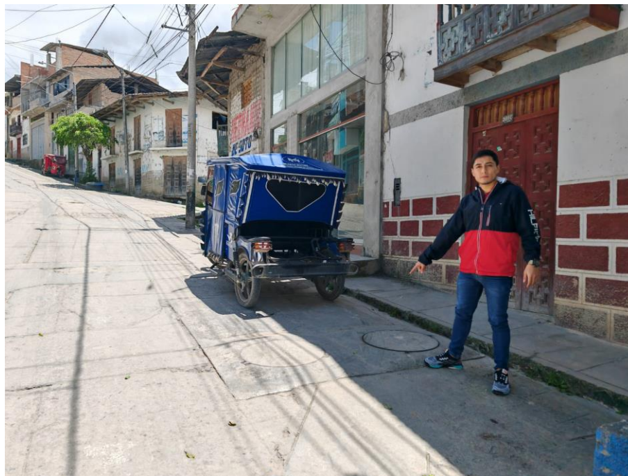
Fotografía N° 16: Válvula reductora de presión N° 6.
