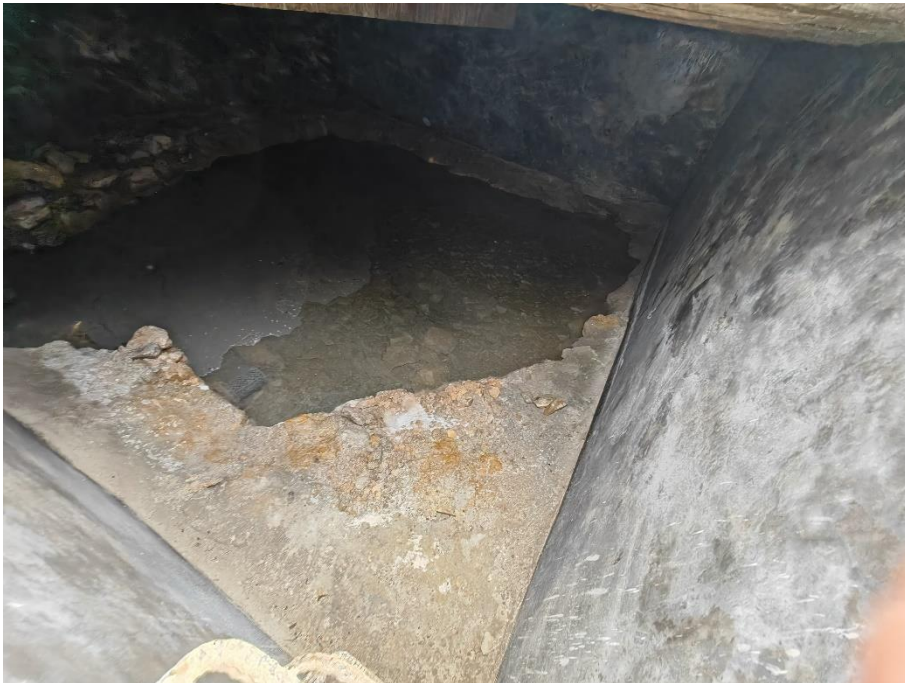
Fotografía N° 02: Interior de la captación el Suro.
