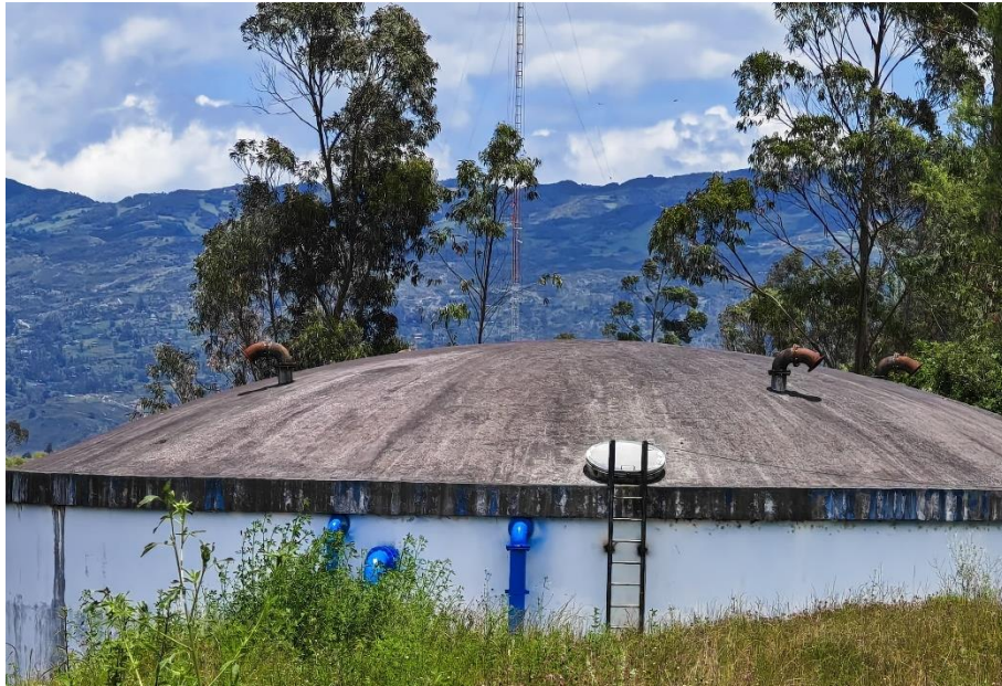
Fotografía N° 07: Reservorio de 1100 m3.
