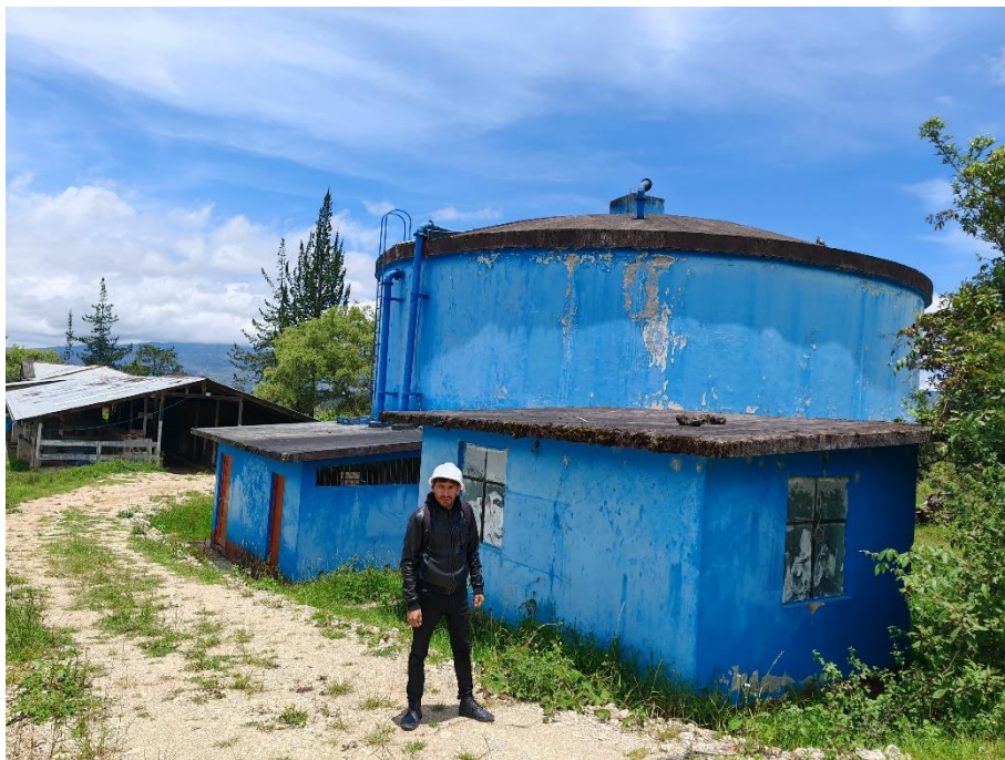
Fotografía N° 08: Reservorio de 900 m3.
