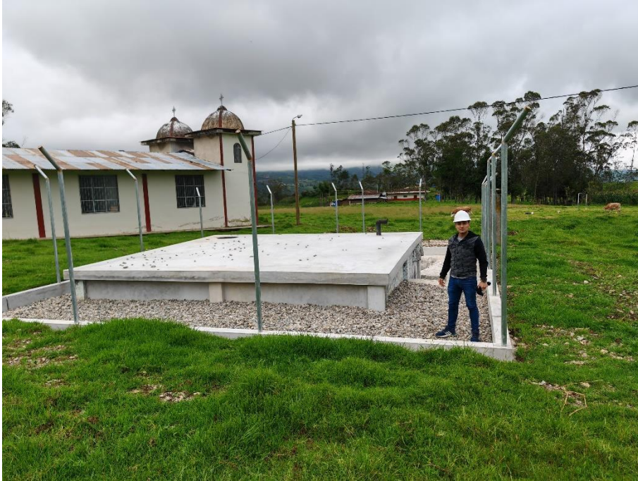
Fotografía N° 01: Captación el Suro.
