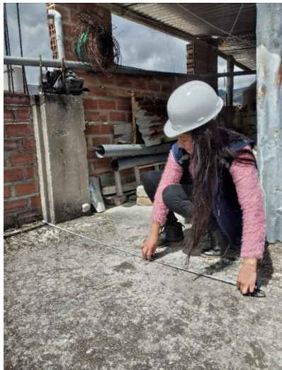
Figura 35 Medición de área y parámetros estructurales de las viviendas
