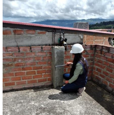
Figura 32 Medición de área y parámetros estructurales de las viviendas
