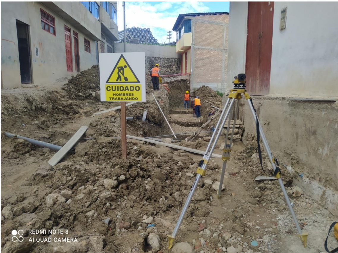
Fotografía 12. Visita de los tesisistas para observar el desarrollo del proceso constructivo: Excavaciones en la obra de pavimentación
