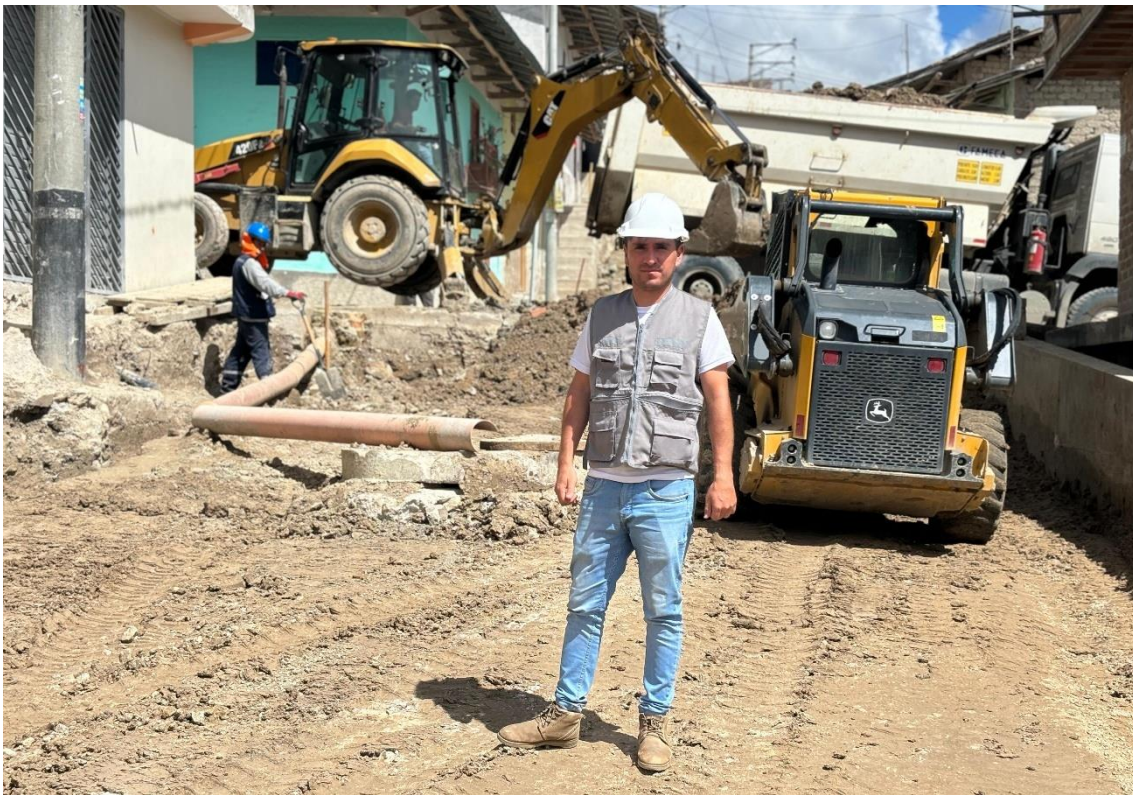
Fotografía 14. Visita de los tesisistas para observar el desarrollo del proceso constructivo:
