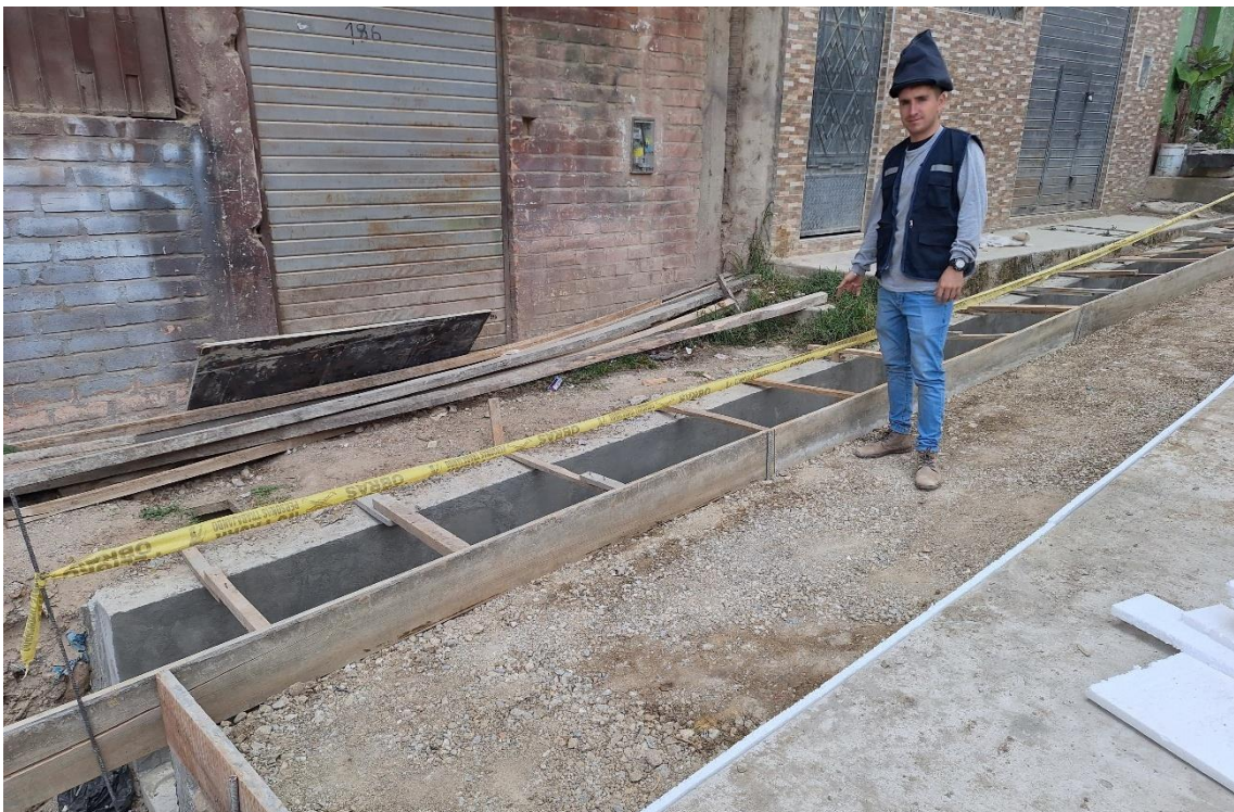
Fotografía 16. Visita de los tesisistas para observar el desarrollo del proceso constructivo: Encofrado de cunetas
