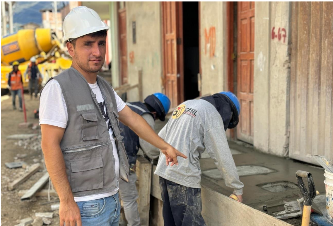
Fotografía 16. Visita de los tesisistas para observar el desarrollo del proceso constructivo: Encofrado de cunetas
