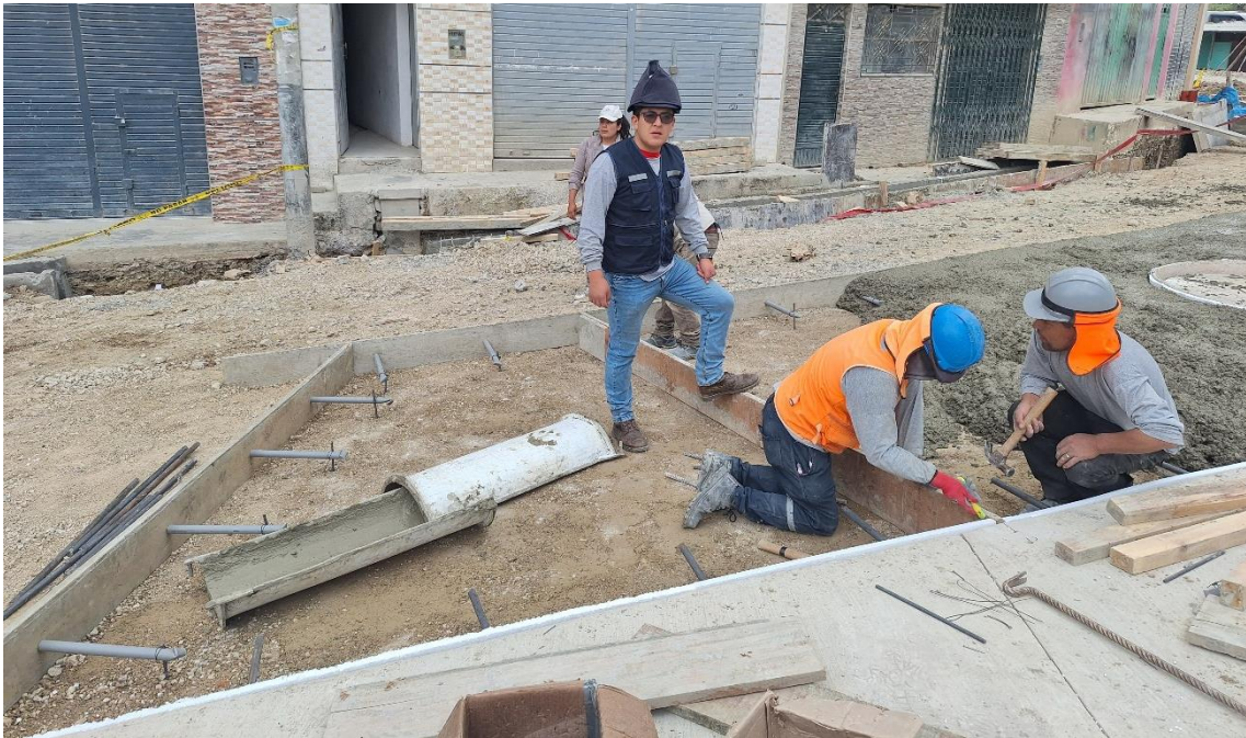
Fotografía 18. Visita de los tesisistas para observar el desarrollo del proceso constructivo: habilitación de materiales para vaciado de losa de concreto
