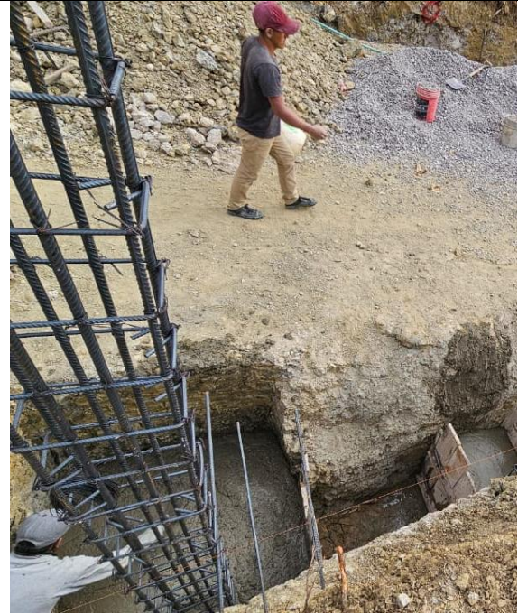
Fotografía 52. Habilitación de acero en cimentación, vivienda 12
