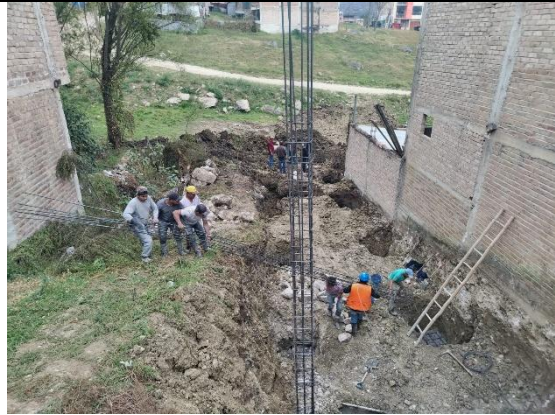
Fotografía 45. Preparación y vaciado de concreto en cimentación, vivienda 9
