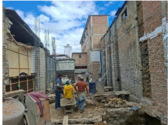
Fotografía 40. Habilitación y colocación de acero, Vivienda 7
