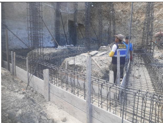
Fotografía 11. Encofrado en la Vivienda 2
