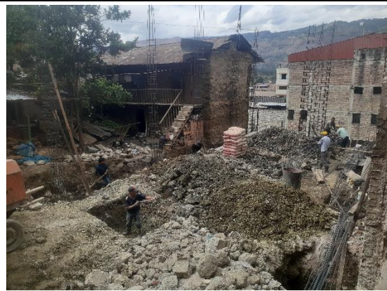
Fotografía 27. Excavación en zapatas de la vivienda 5
