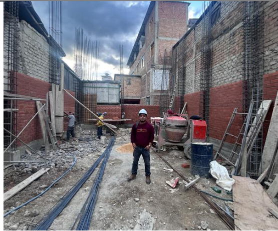
Fotografía 37. Evaluación de la vivienda 7
