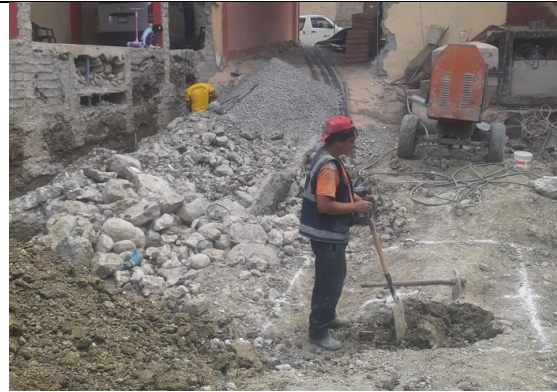
Fotografía 27. Excavación en zapatas de la vivienda 5
