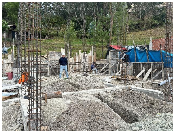
Fotografía 47. Excavación de cimentación, vivienda 10
