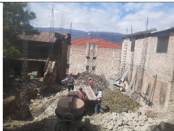
Fotografía 29. Encofrado en la Vivienda 5
