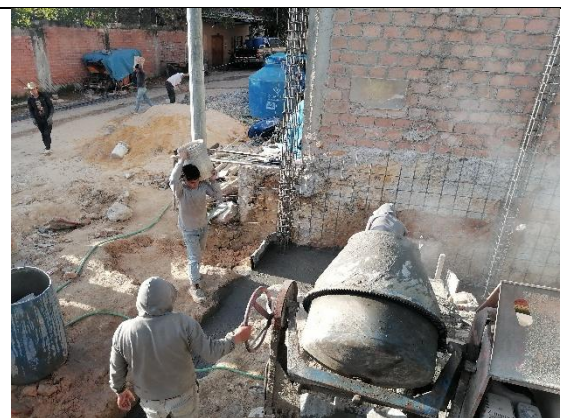
Fotografía 24. Vaciado de concreto de la vivienda 4
