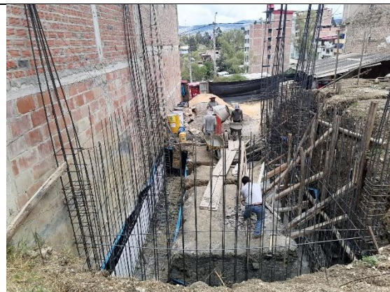
Fotografía 18. Vaciado de concreto de la vivienda 3
