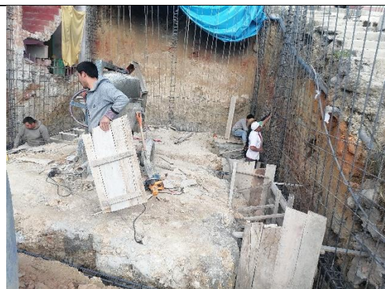
Fotografía 23. Encofrado en la Vivienda 4
