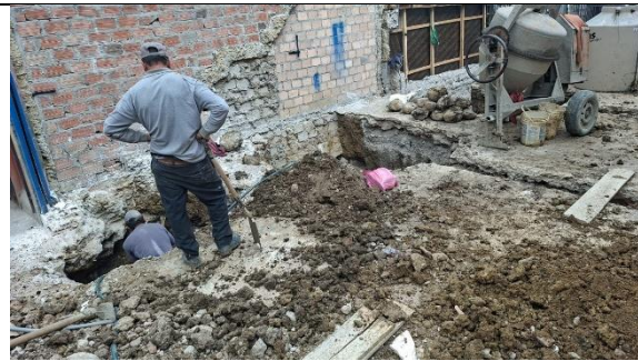
Fotografía 61. Preparación y vaciado de concreto en cimentación, vivienda 14
