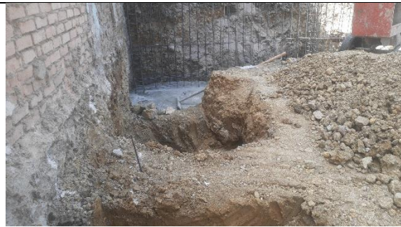
Fotografía 53. Colocación de acero en cimentación, vivienda 12
