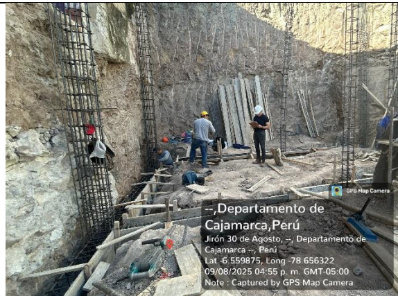
Fotografía 48. Preparación y vaciado de concreto en cimentación, vivienda 10
