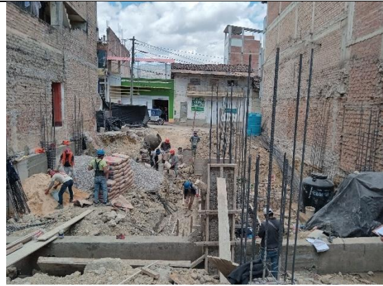
Fotografía 31. Evaluación de la vivienda 6
