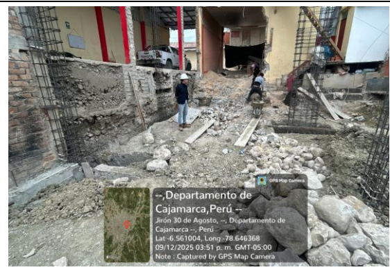
Fotografía 28. Habilitación y colocación de acero, Vivienda 5
