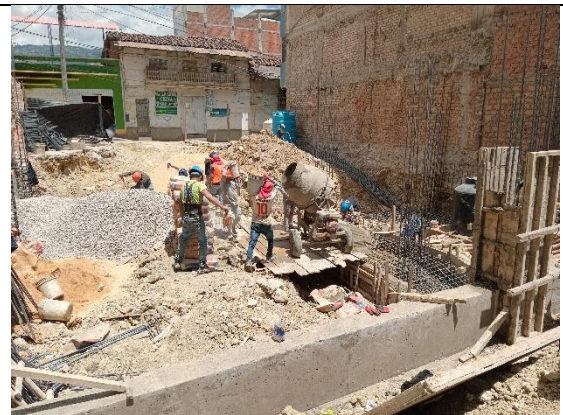
Fotografía 36. Vaciado de concreto de la vivienda 6
