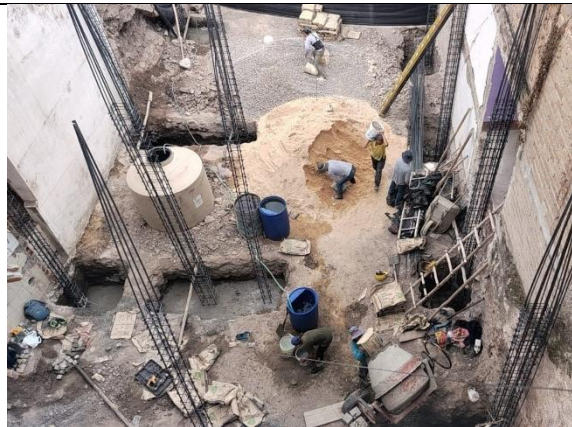
Fotografía 47. Excavación de cimentación, vivienda 10
