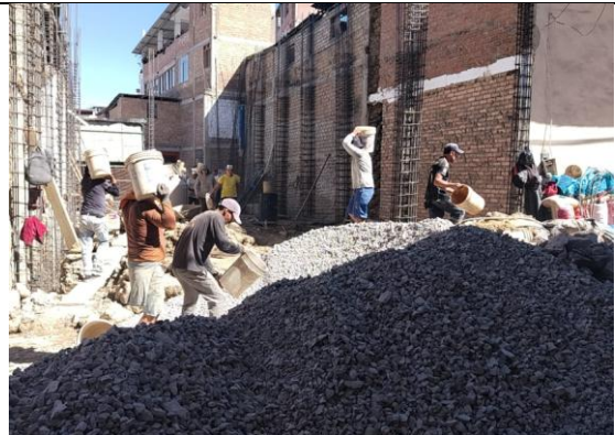
Fotografía 42. Vaciado de concreto de la vivienda 7
