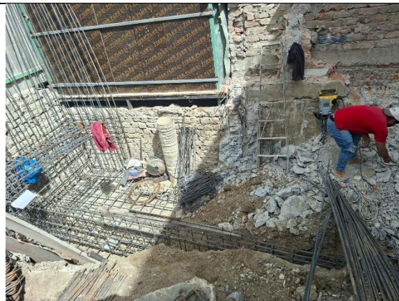
Fotografía 53. Colocación de acero en cimentación, vivienda 12
