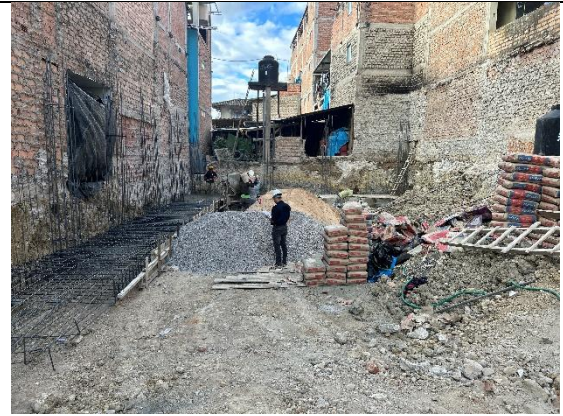
Fotografía 34. Habilitación y colocación de acero, Vivienda 6
