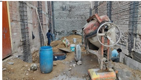
Fotografía 61. Preparación y vaciado de concreto en cimentación, vivienda 14
