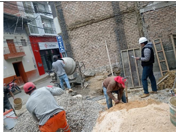
Fotografía 54. Preparación y vaciado de concreto en cimentación, vivienda 12
