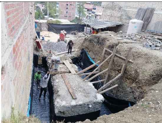
Fotografía 17. Colocación de acero, Vivienda 3
