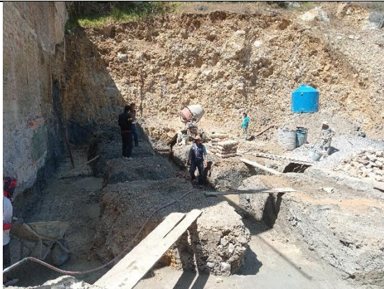
Fotografía 9. Solado en zapatas de la vivienda
