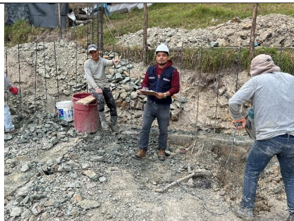
Fotografía 48. Preparación y vaciado de concreto en cimentación, vivienda 10
