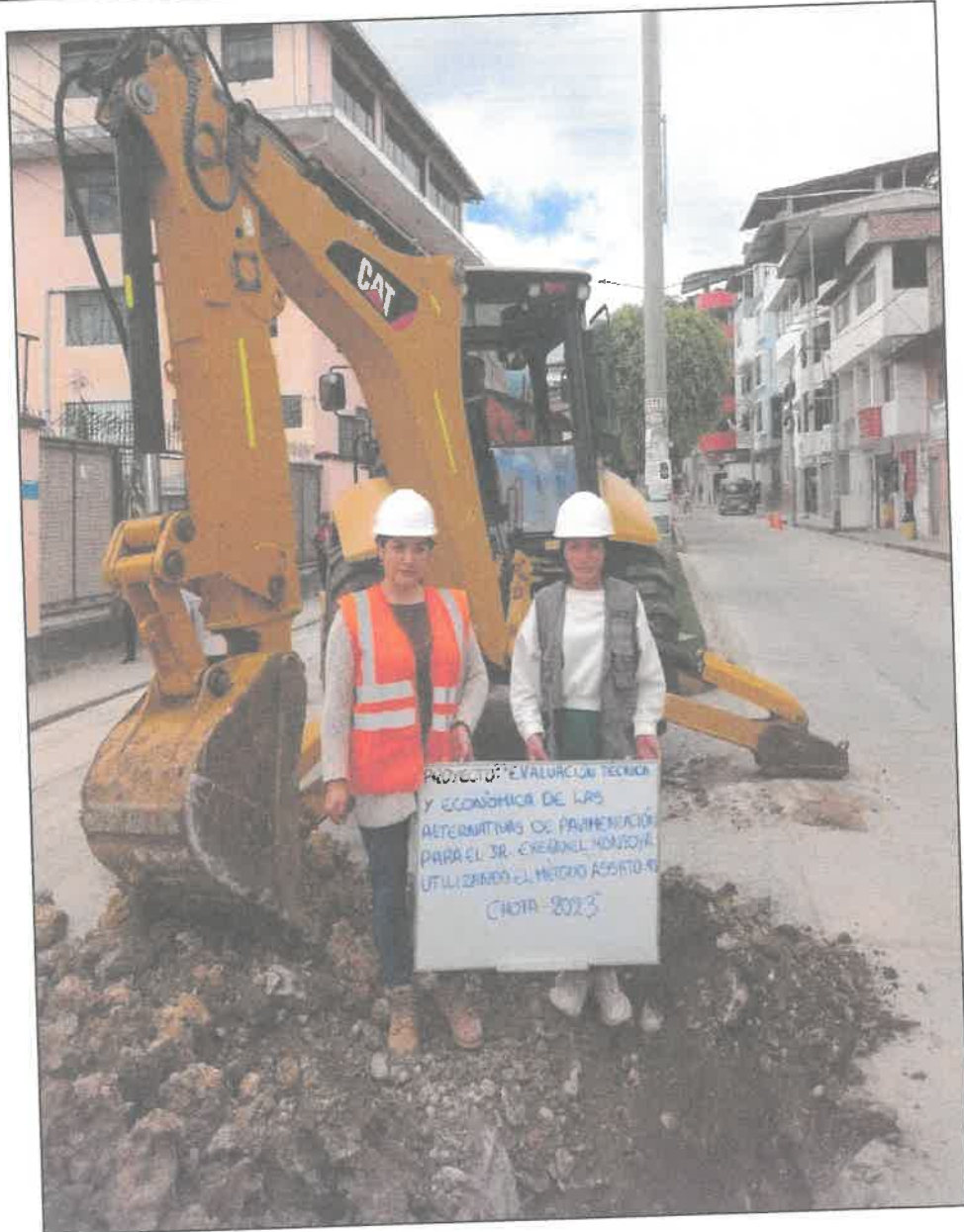
FOTOGRAFIA 01: Muestra la extracción de muestra de la C - 1
