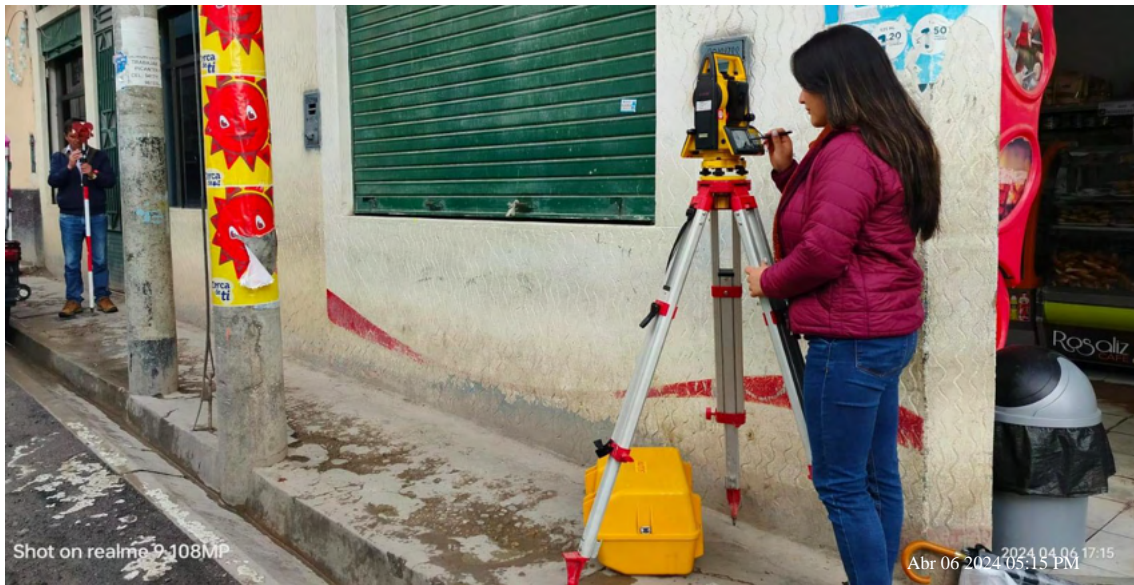
Fotografía 3. Toma de Puntos Topográficos en los Bordes de la Vía, Cunetas Existentes, Postes y Demás Puntos de Interés en el Jr. Exequiel Montoya
