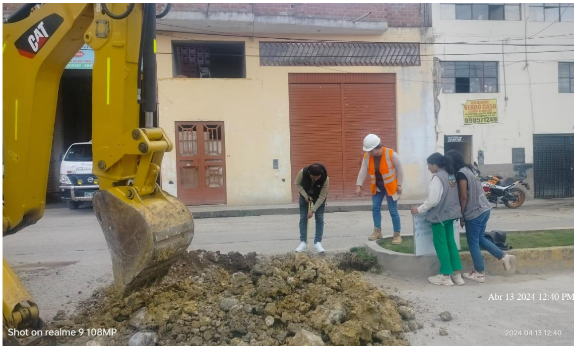
Fotografía 8. Excavación de la Calicata C-2 en el Jr. Exequiel Montoya
