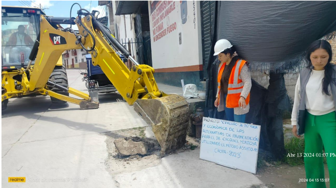
Fotografía 7. Excavación de la Calicata C-1 en el Jr. Exequiel Montoya
