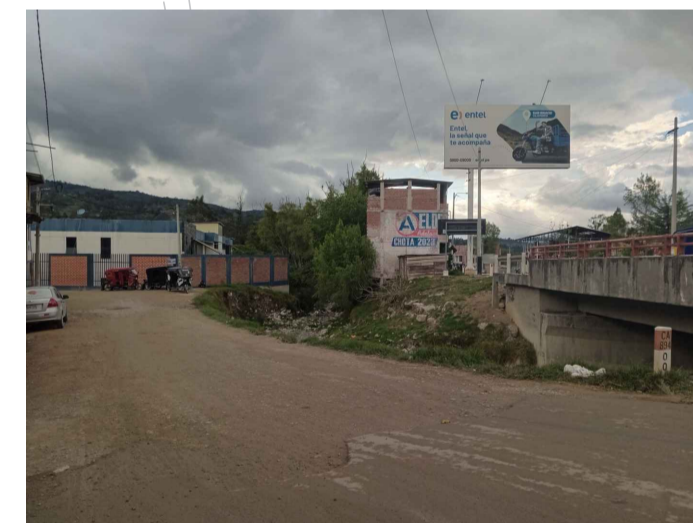
GERENCIA SUB REGIONAL DE CHOTA Y VIVIENDAS CONSTRUIDAS AL BORDE DE RIO
