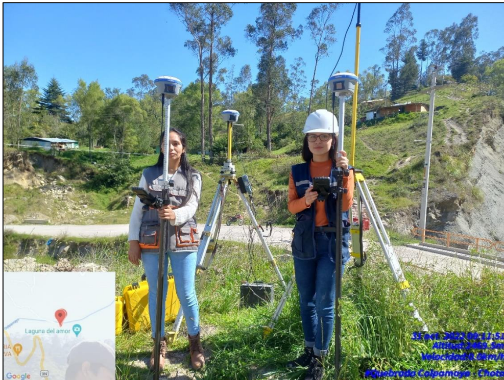
Fotografía 1. Estacionamiento del equipo topográfico (GPS Diferencial) para el levantamiento topográfico.
