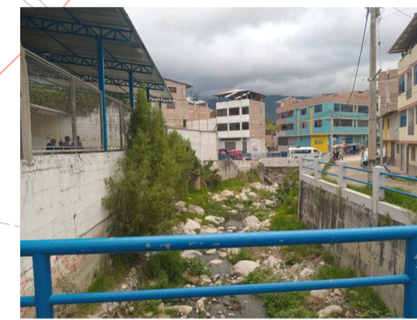
VIVIENDA CONSTRUIDA AL BORDE DE RIO LADO IZQUIERDO EX CAMAL DE CHOTA
