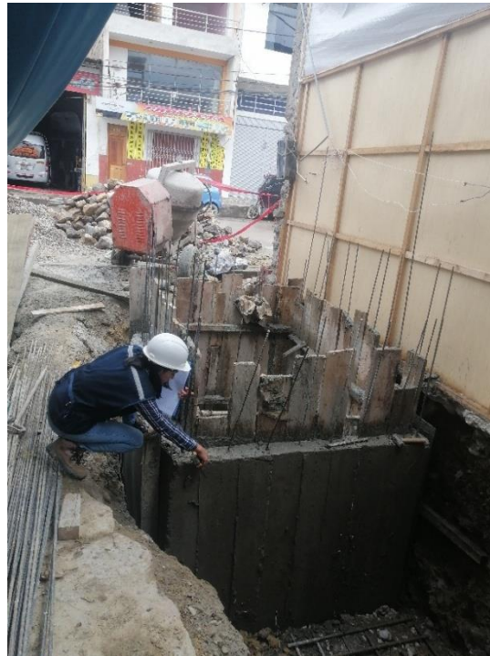
Fotografía 6. Amarrando las barras de acero de refuerzo para cisterna en vivienda N° 2.
