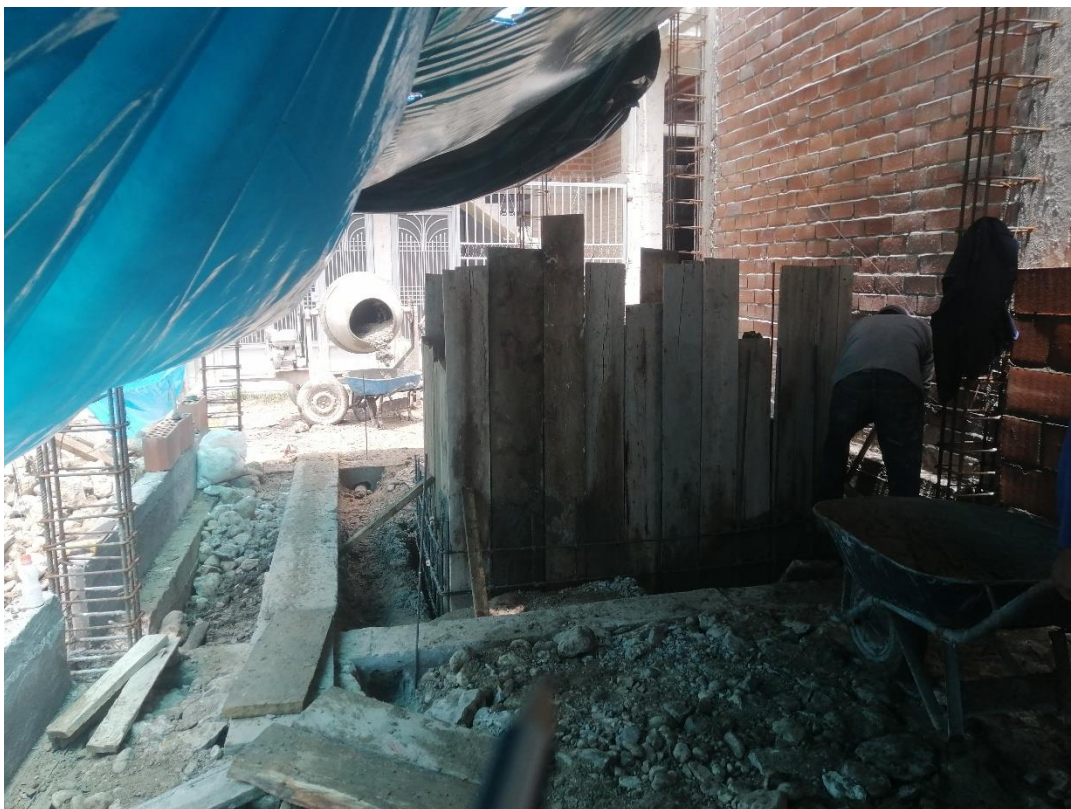
Fotografía 28. Vaciado de concreto para cisterna en vivienda N° 6.
