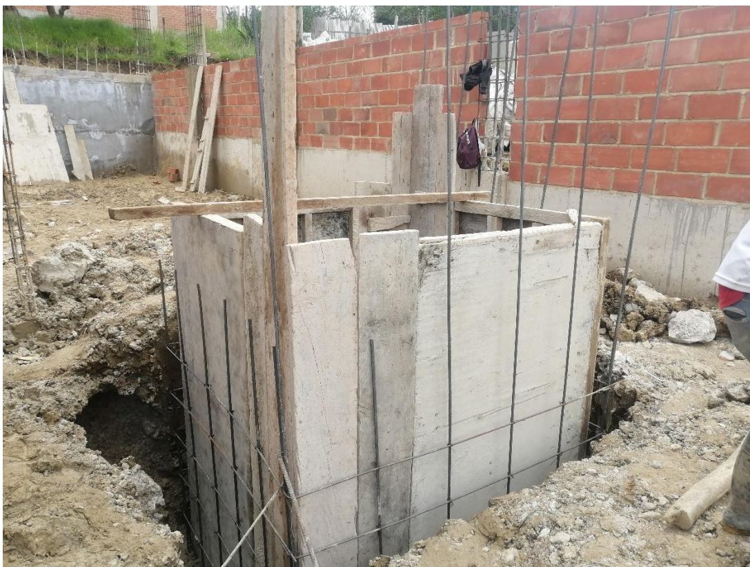
Fotografía 20. Encofrado de cisterna en la vivienda N° 5.
