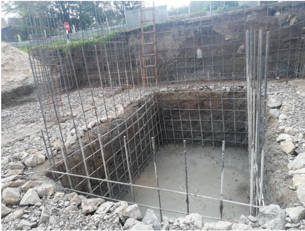
Fotografía 10. Encofrado de cisterna en la vivienda N° 3
