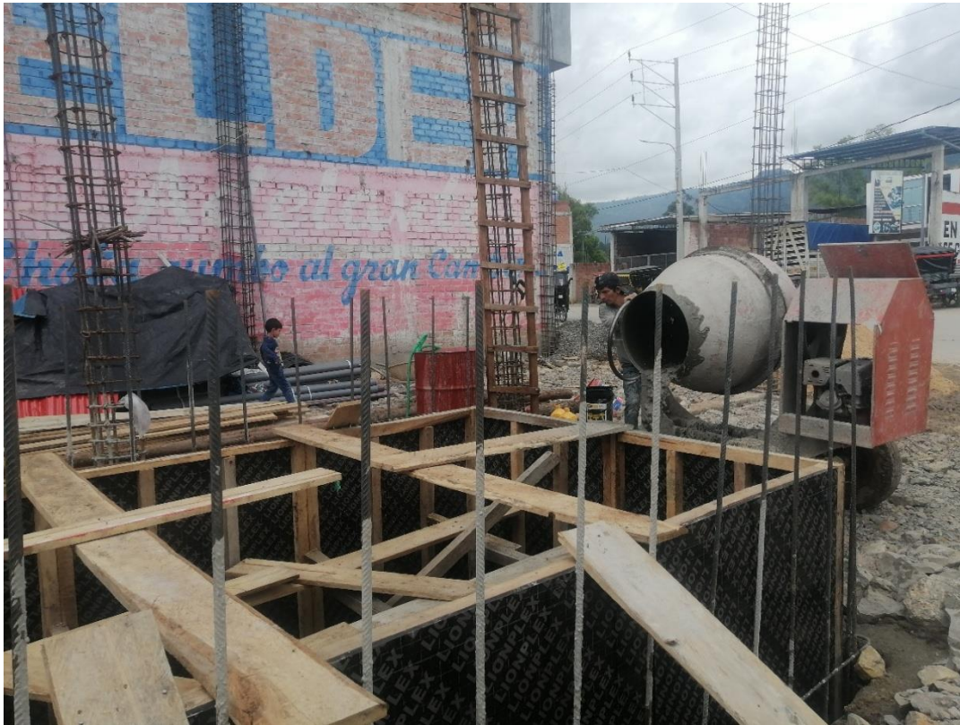
Fotografía 11. Vaciado de concreto para cisterna en vivienda N° 3.
