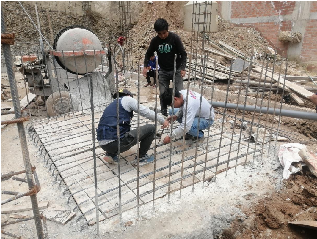
Fotografía 17. Amarado de acero en la tapa de cisterna en la vivienda N° 4
