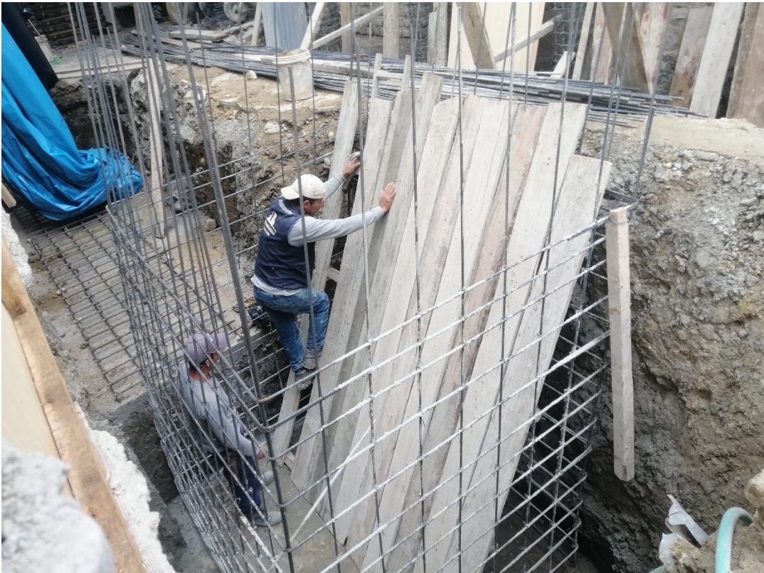
Fotografía 2. Encofrado de cisterna en la vivienda N° 1
