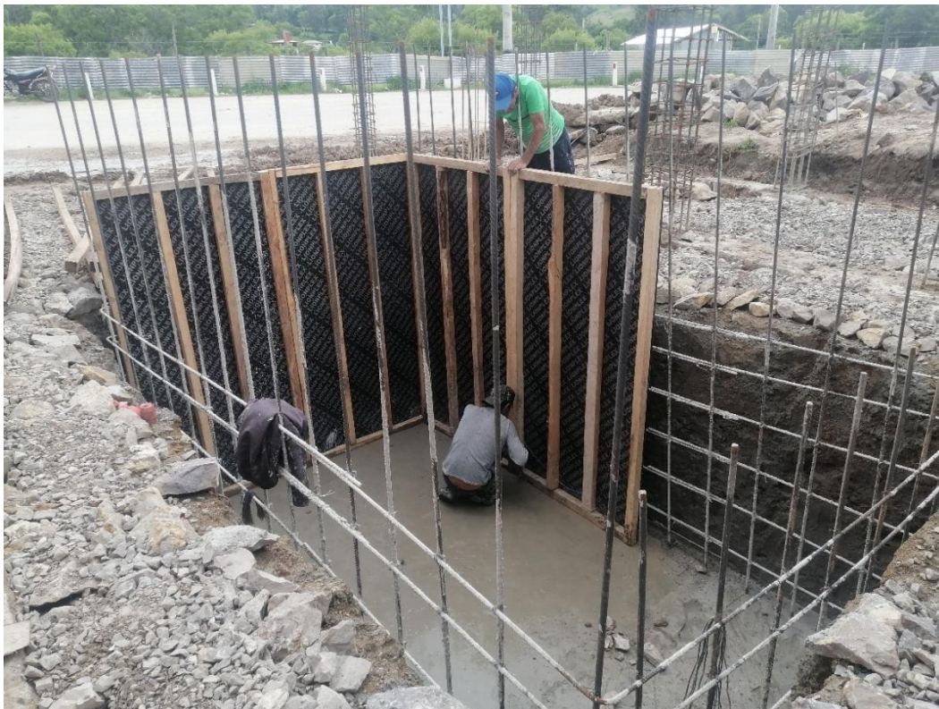
Fotografía 10. Encofrado de cisterna en la vivienda N° 3
