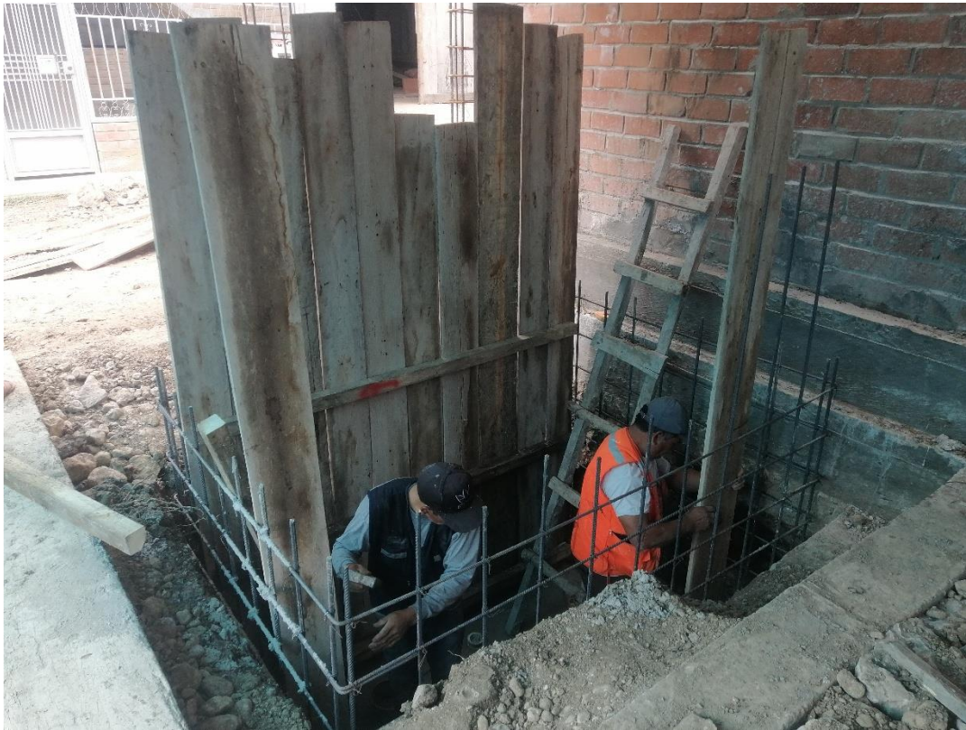
Fotografía 26. Verificación de recubrimiento para cisterna en vivienda N° 6.
