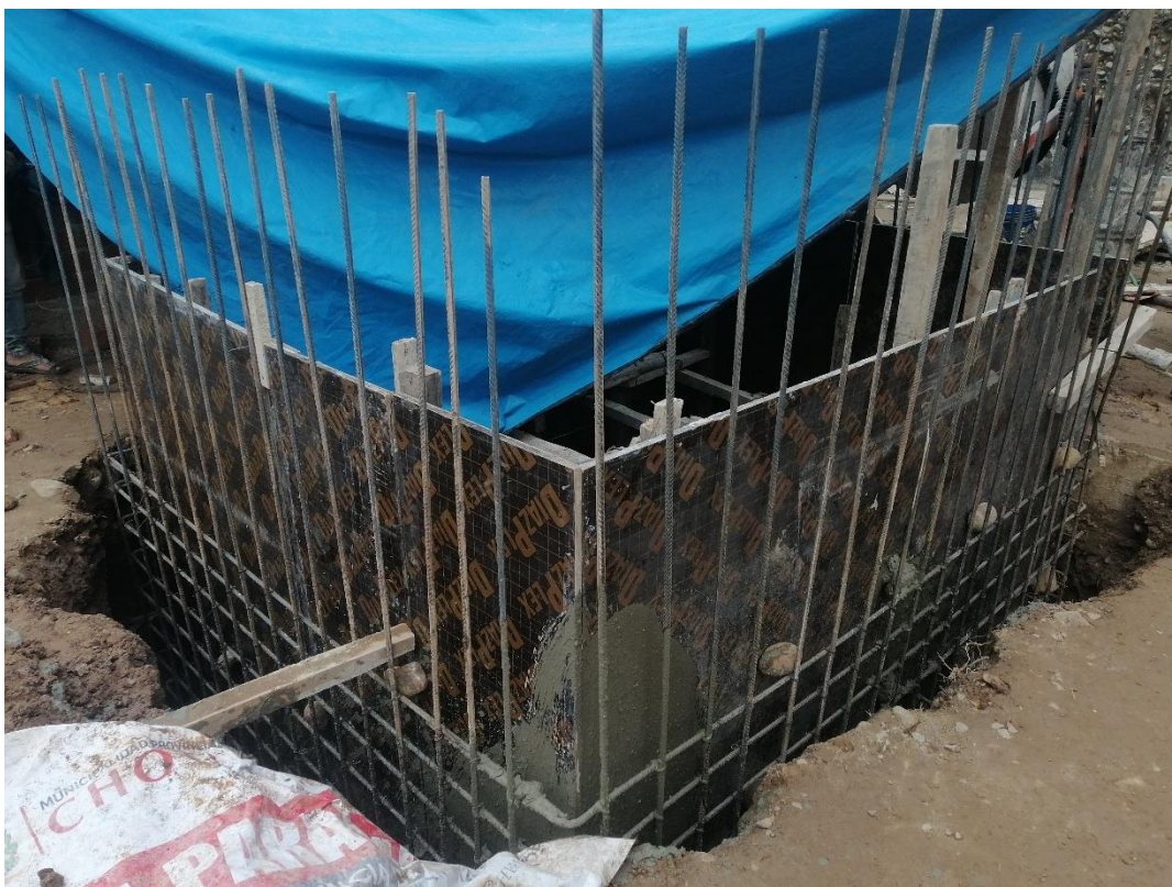
Fotografía 16. Vaciado de concreto para cisterna en vivienda N° 4.
