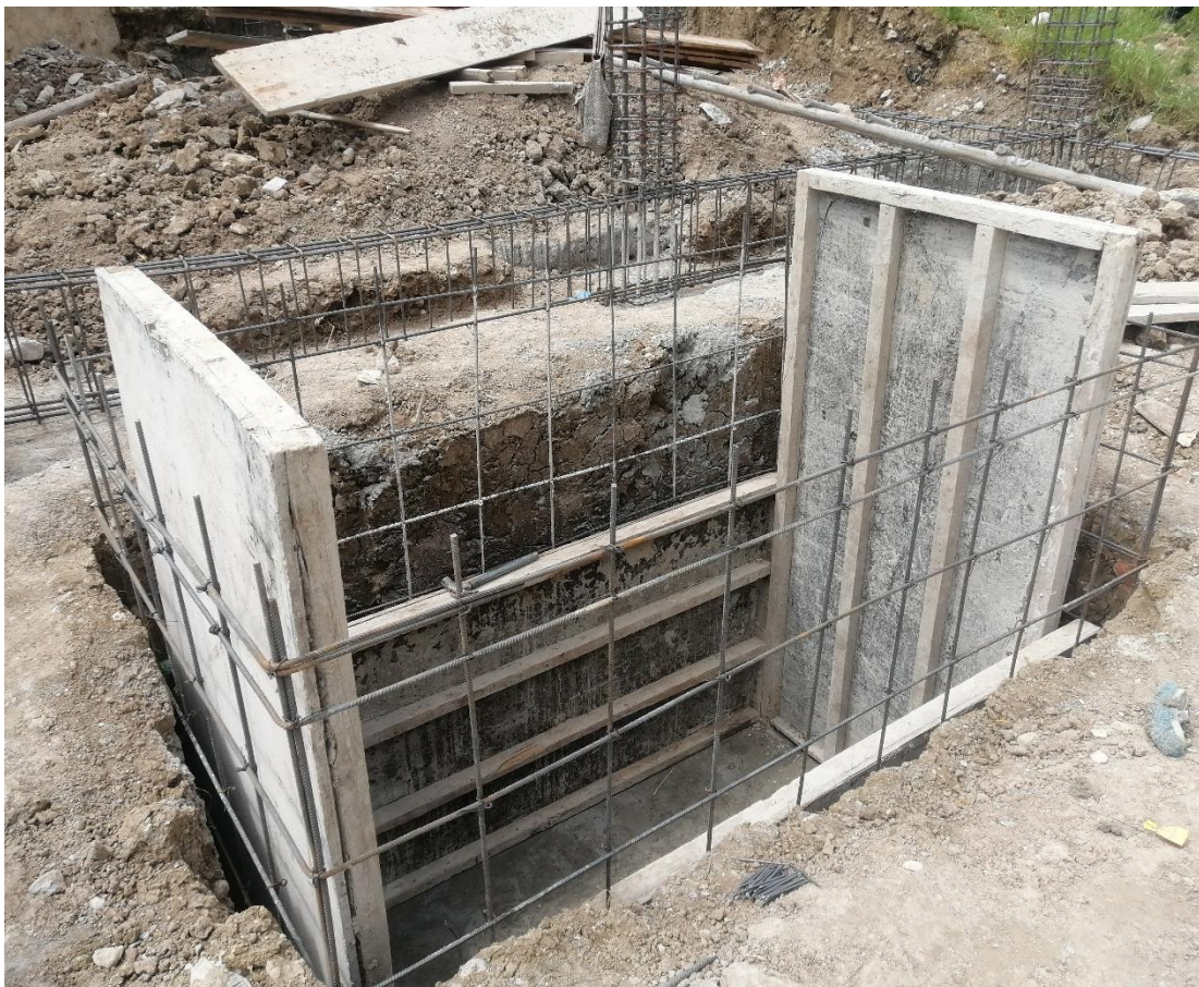
Fotografía 30. Encofrado para cisterna en vivienda N° 7.
