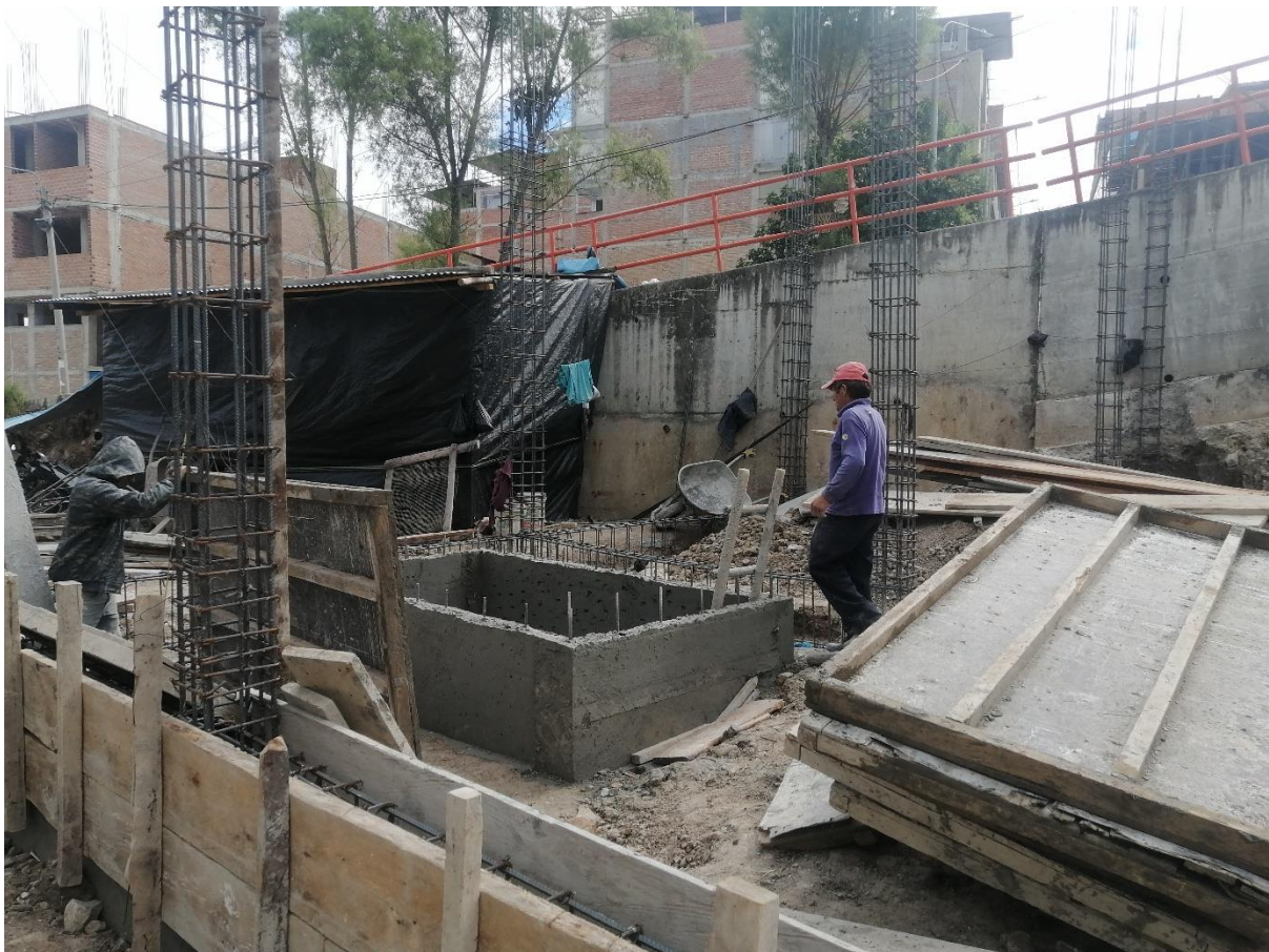
Fotografía 32. Desencofrado para cisterna en vivienda N° 7.
