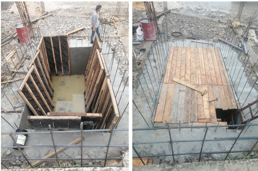
Fotografía 12. Desencofrado de cisterna y encofrado de tapa en la vivienda N° 3
