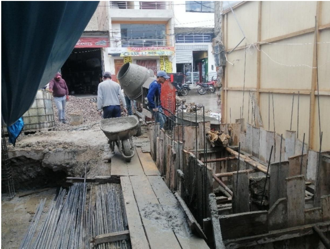
Fotografía 4. Desencofrado de cisterna en la vivienda N° 1
