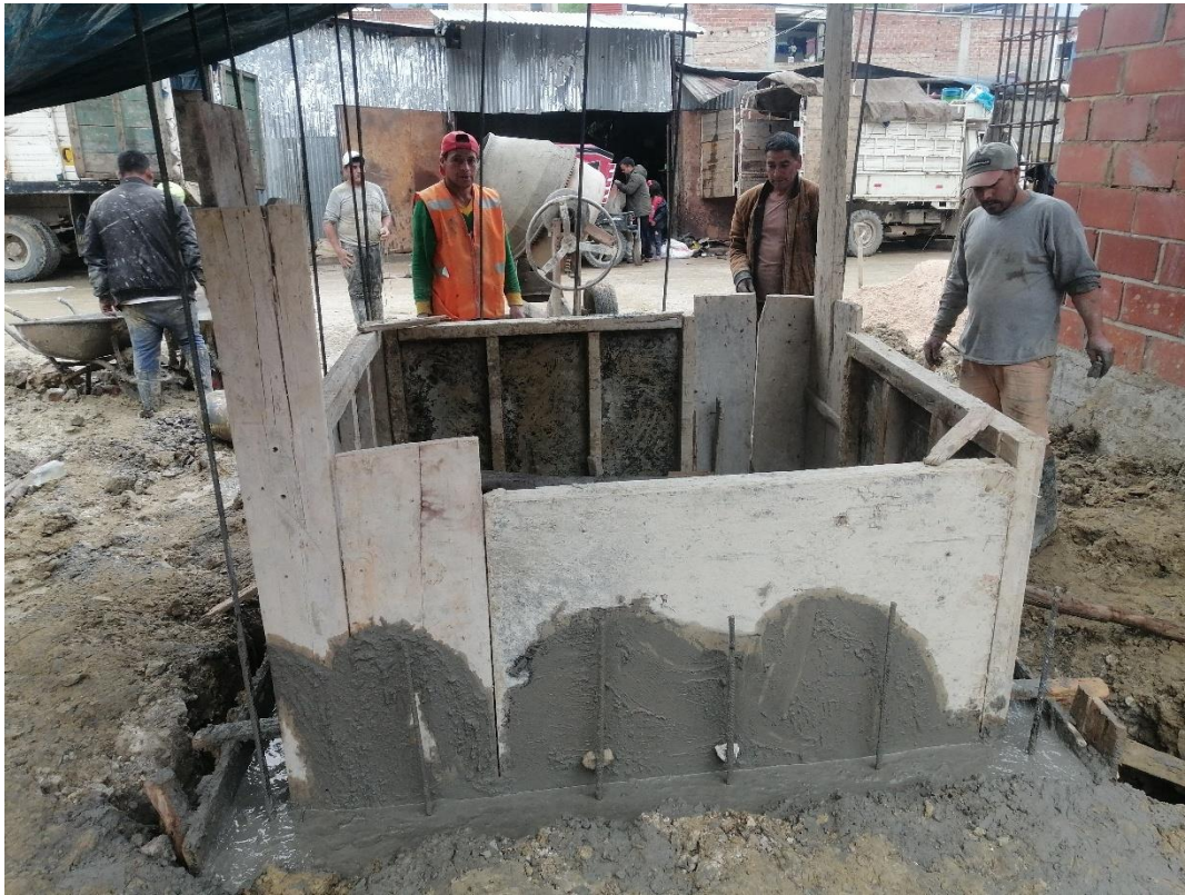
Fotografía 22. Encofrado de tapa de cisterna en la vivienda N° 5.
