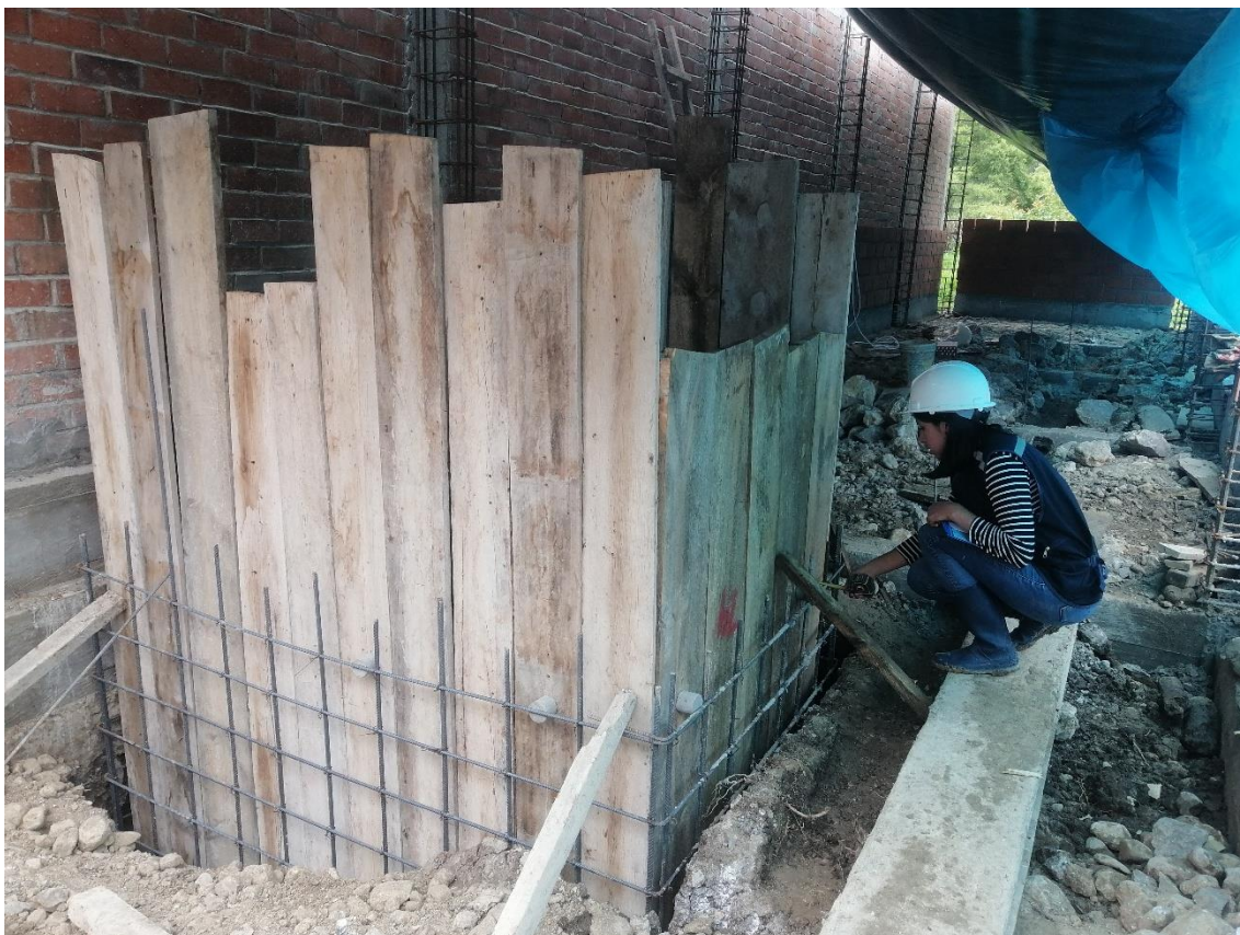
Fotografía 26. Verificación de recubrimiento para cisterna en vivienda N° 6.
