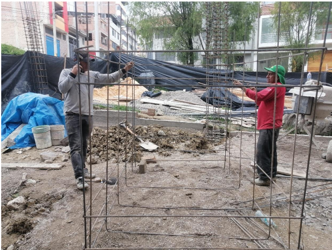
Fotografía 6. Amarrando las barras de acero de refuerzo para cisterna en vivienda N° 2.
