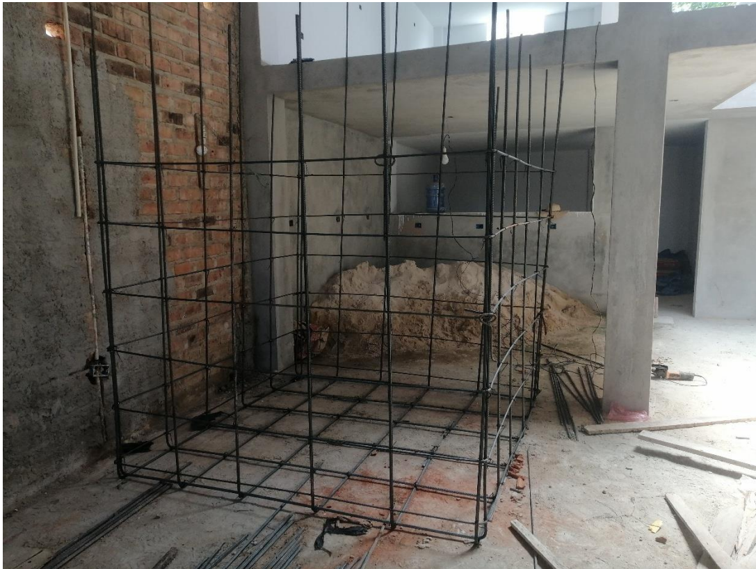
Fotografía 20. Encofrado de cisterna en la vivienda N° 5.
