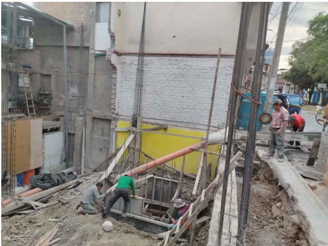
Fotografía 40. Vaciado de concreto para cisterna en vivienda N° 9.
