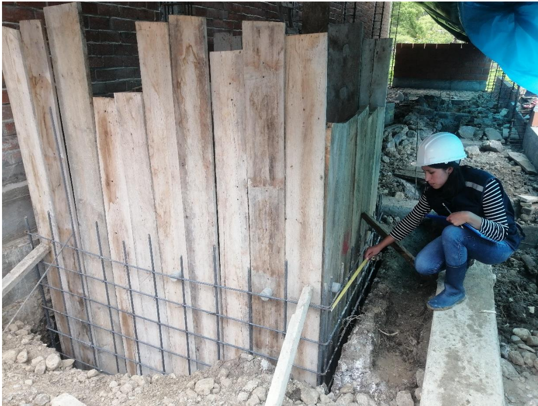
Fotografía 28. Vaciado de concreto para cisterna en vivienda N° 6.
