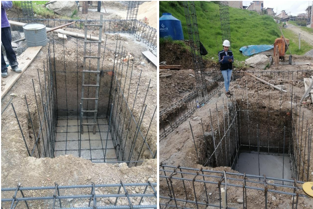
Fotografía 30. Encofrado para cisterna en vivienda N° 7.
