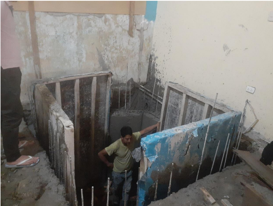
Fotografía 38. Acero de refuerzo para cisterna en vivienda N° 9.
