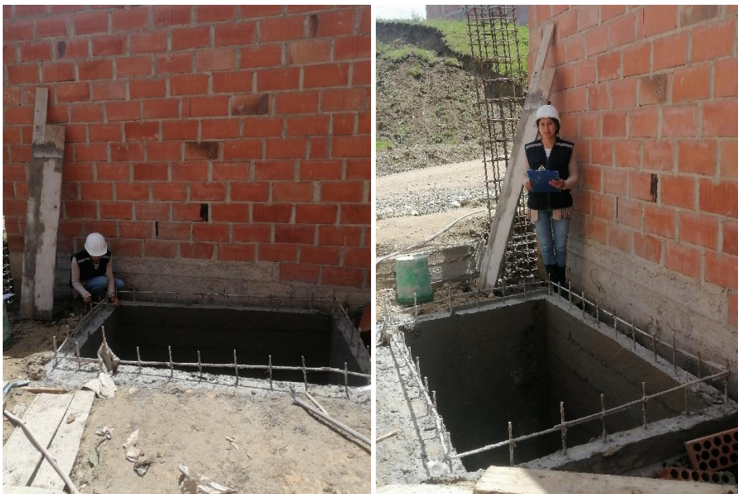
Fotografía 8. Evaluación de carta balance de cisterna y verificación de medidas en vivienda N° 2.
