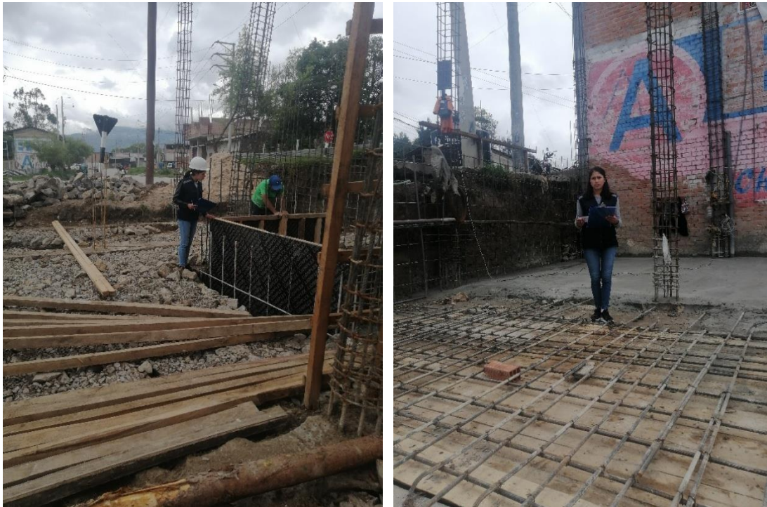
Fotografía 14. Amarrando las barras de acero de refuerzo para cisterna en vivienda N° 4.
