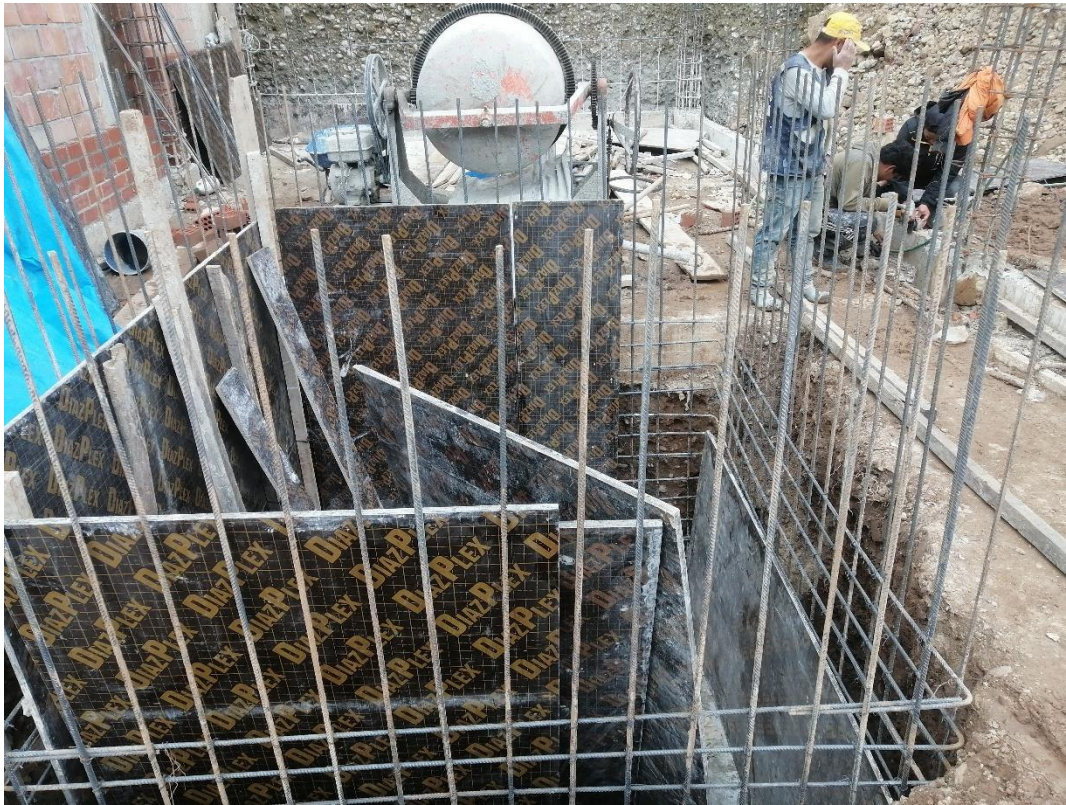
Fotografía 16. Vaciado de concreto para cisterna en vivienda N° 4.
