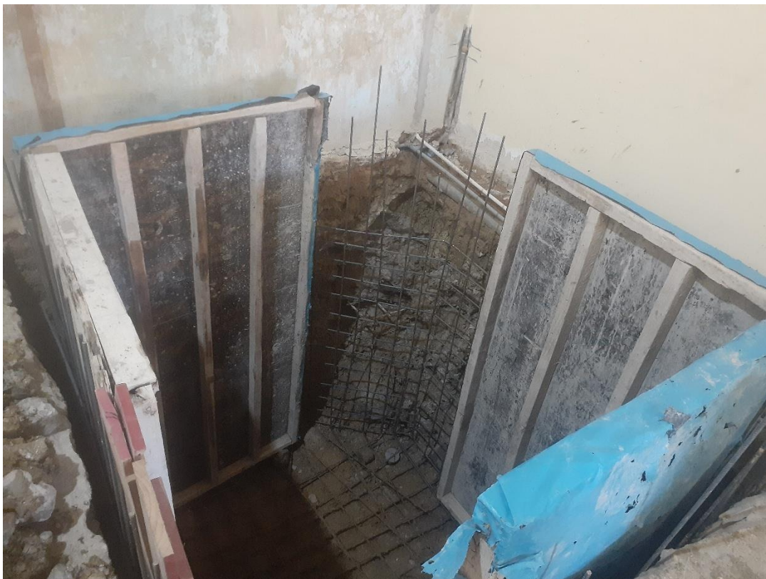
Fotografía 36. Encofrado de cisterna en la vivienda N° 8.
