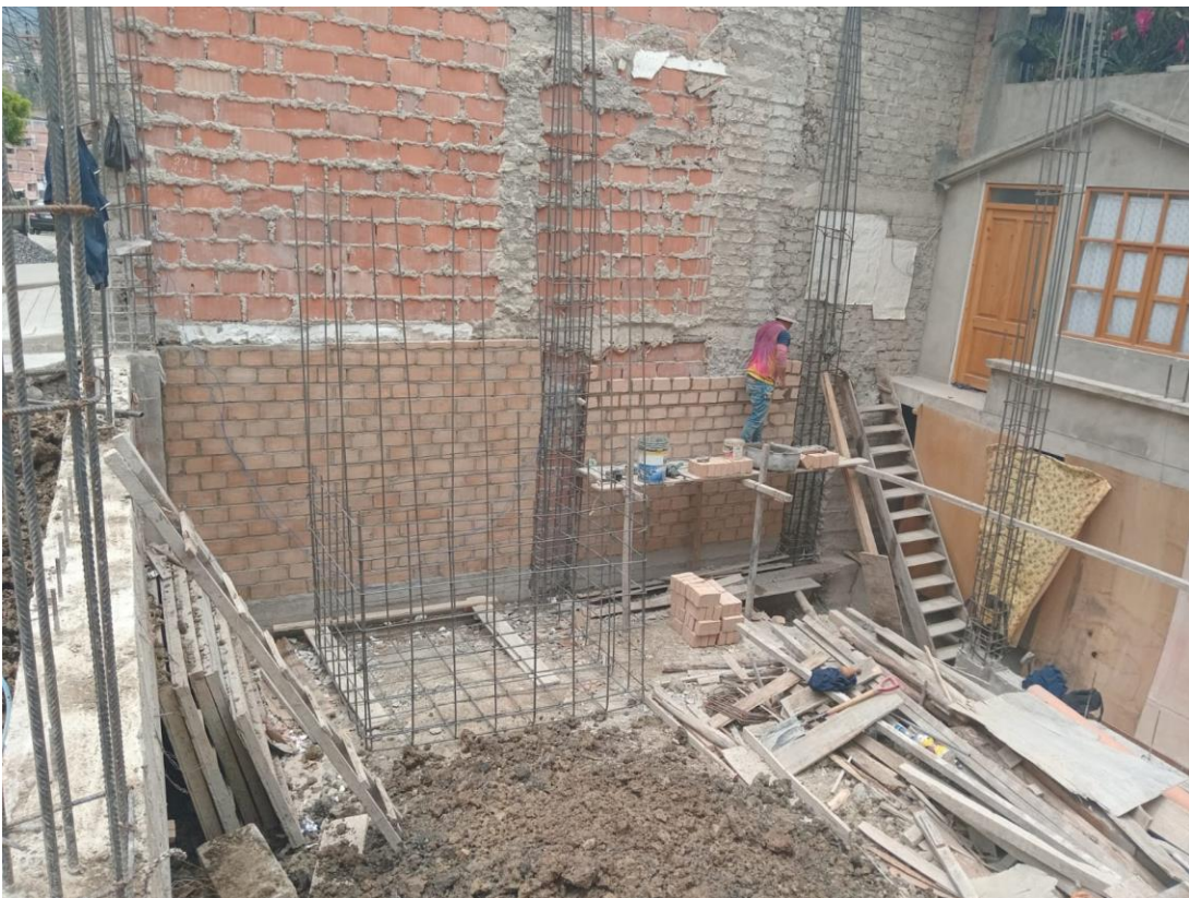
Fotografía 38. Acero de refuerzo para cisterna en vivienda N° 9.
