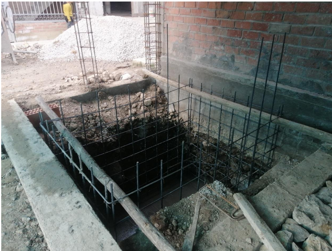
Fotografía 24. Colocación de las barras de acero de refuerzo para cisterna en vivienda N° 6.
