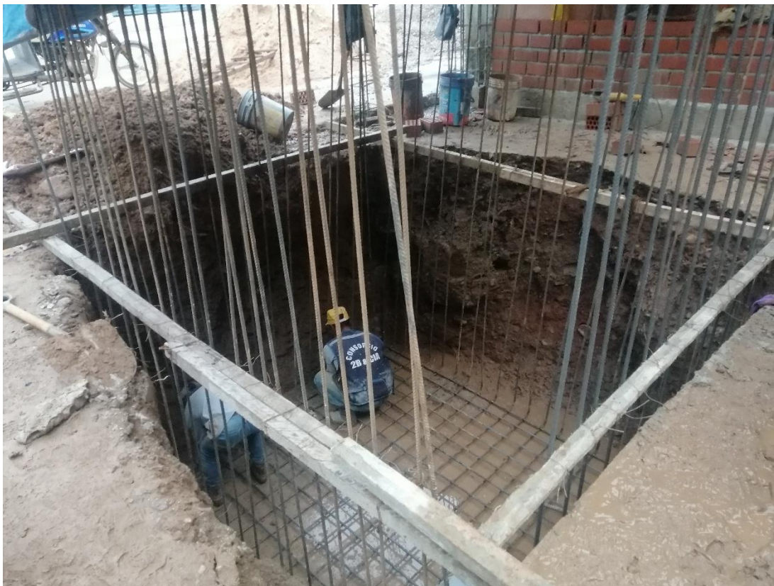
Fotografía 14. Amarrando las barras de acero de refuerzo para cisterna en vivienda N° 4.
