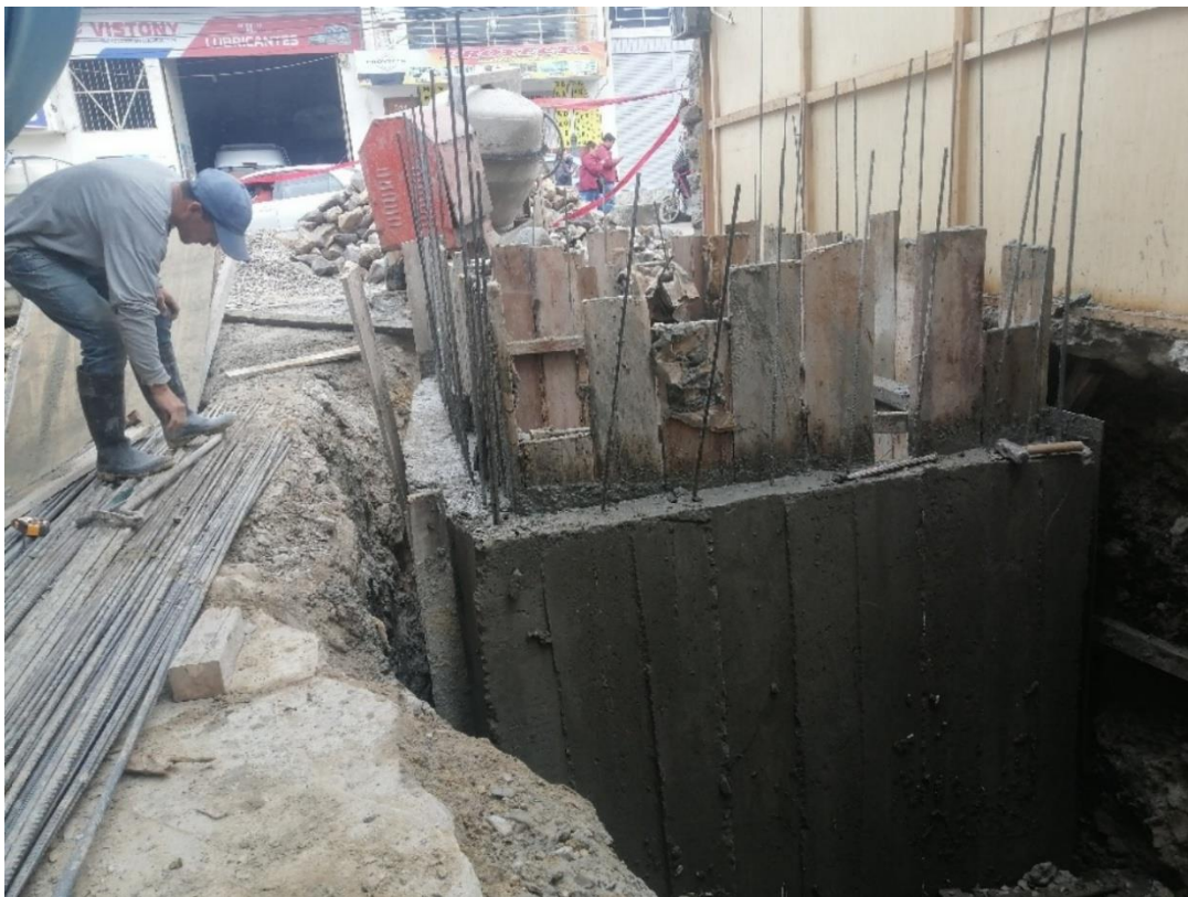
Fotografía 4. Desencofrado de cisterna en la vivienda N° 1
