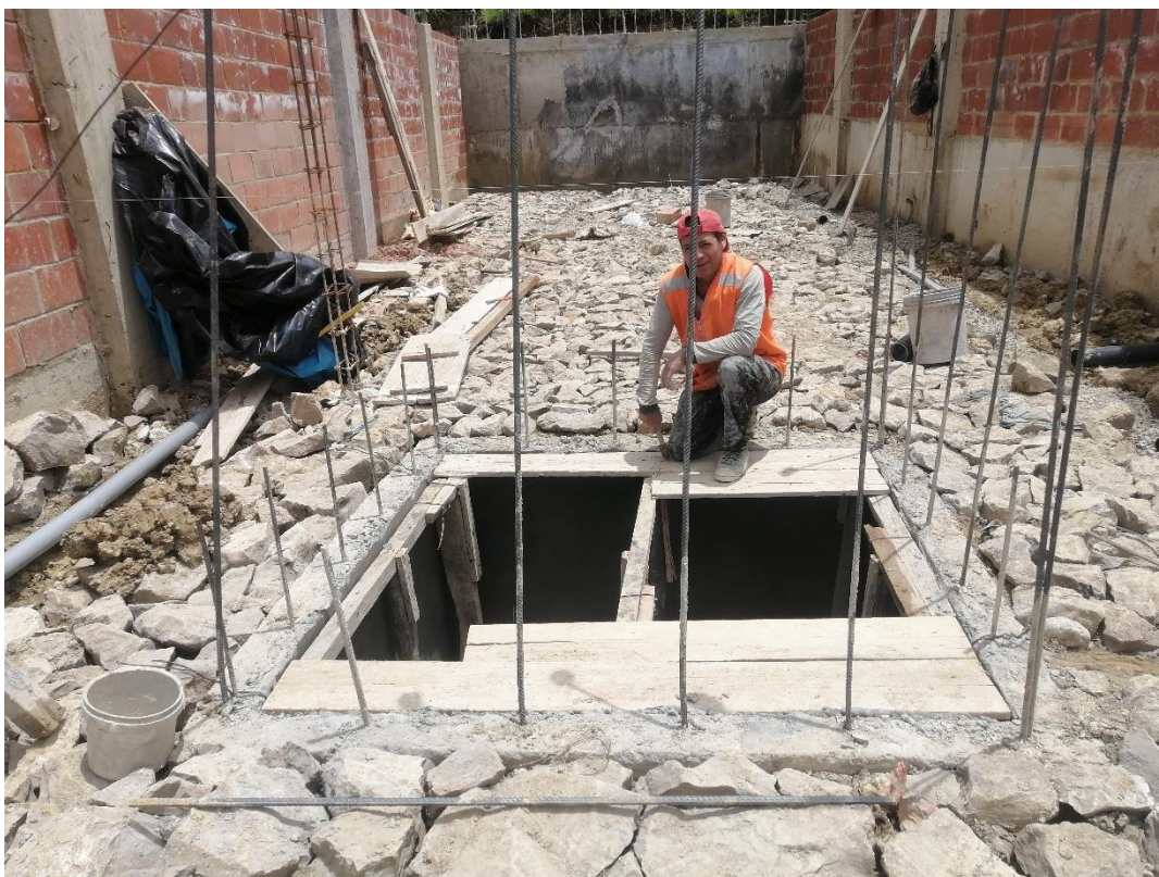
Fotografía 22. Encofrado de tapa de cisterna en la vivienda N° 5.
