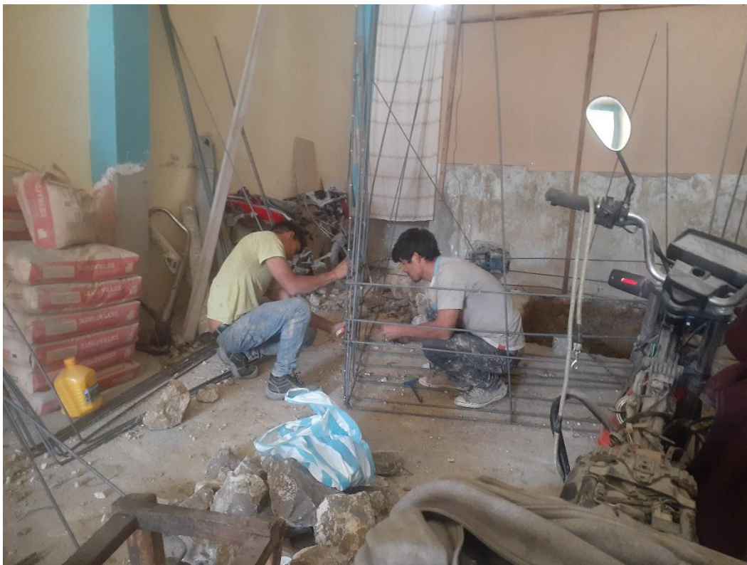
Fotografía 34. Amarrando las barras de acero de refuerzo para cisterna en vivienda N° 8.
