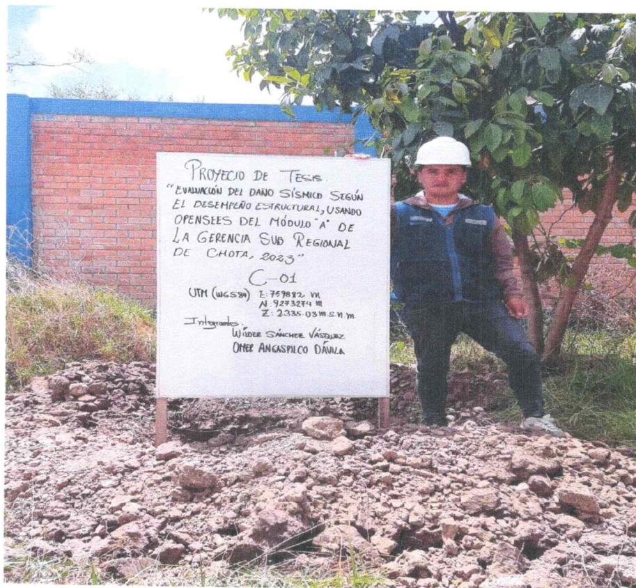
FOTOGRAFIA 4: Excavación de calicata
