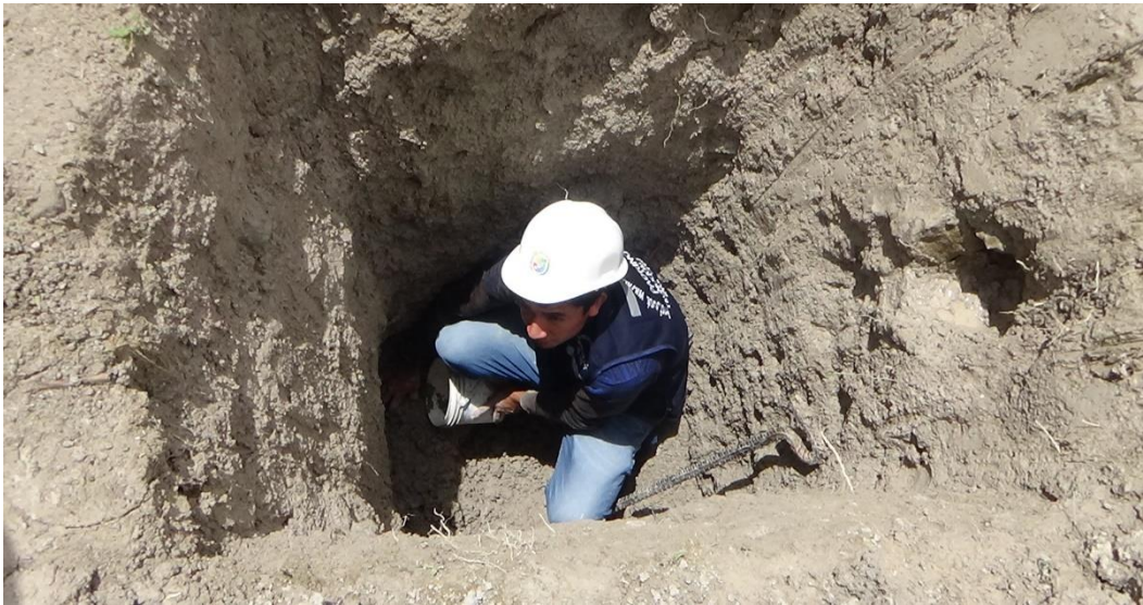
Fotografía 2. Estudio de suelos previo a la aprobación del proyecto de tesis.
