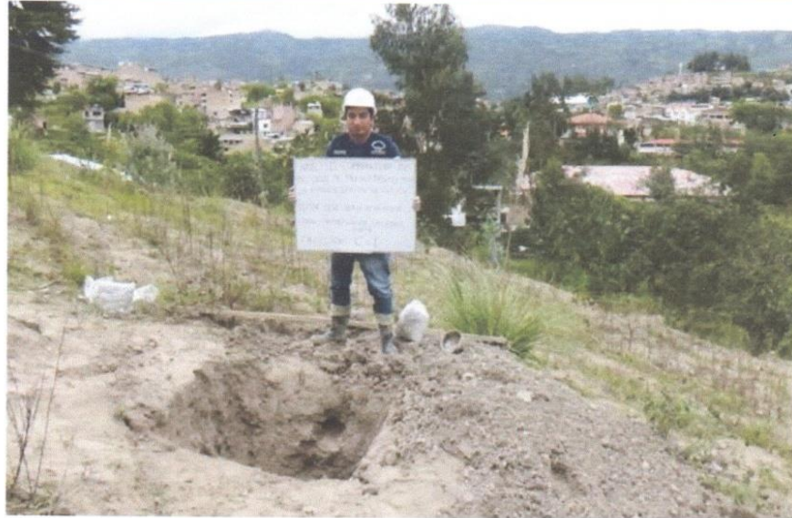
Fotografía N° 01: Vista General - Calicata N° 01
