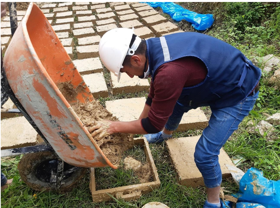
Fotografía 6. Colocación de mezcla en el molde
