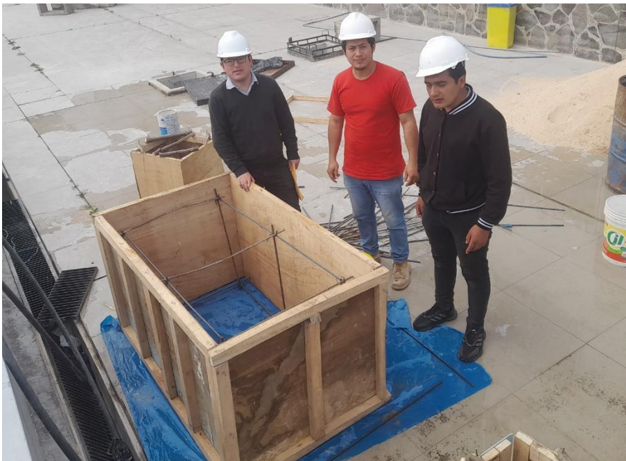
Fotografía 26 Encofrados de madera armados para la elaboración de los modelos: Estructuras a escala
