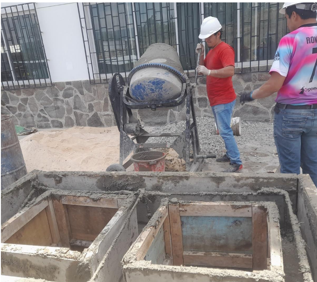
Fotografía 28 Colocación de la mezcla de concreto con caucho granular para la elaboración de modelos a escala
