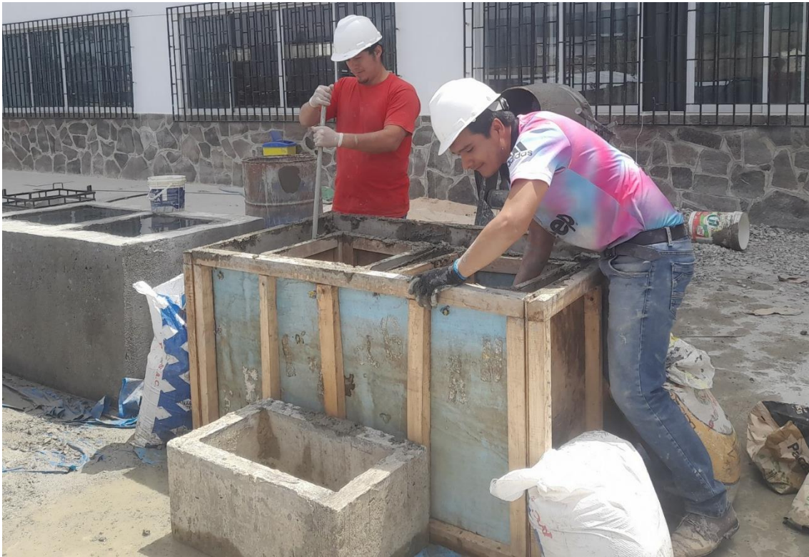
Fotografía 30 Modelos a escala de concreto con caucho granular pasando por proceso de curado
