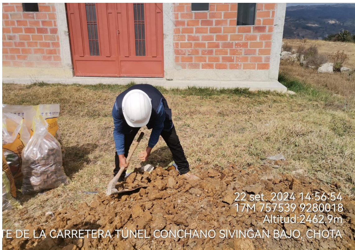
Fotografía 8. Excavación de la calicata 2 (C2) en la carretera Campamento Túnel Conchano – Sivingan Bajo
