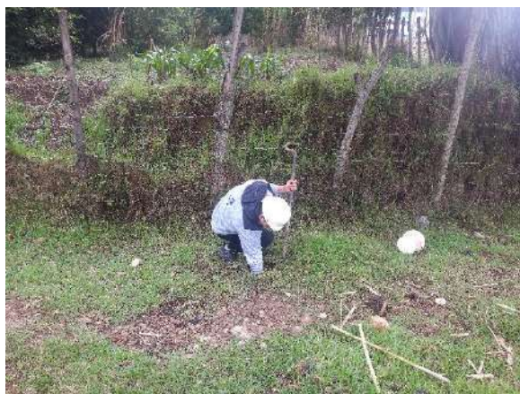
Foto N ° 23. Excavación de hoyo para Método de Porchet.
