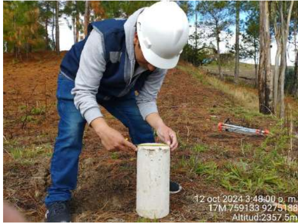
Foto N ° 07. Colocación de BM para levantamiento topográfico.
