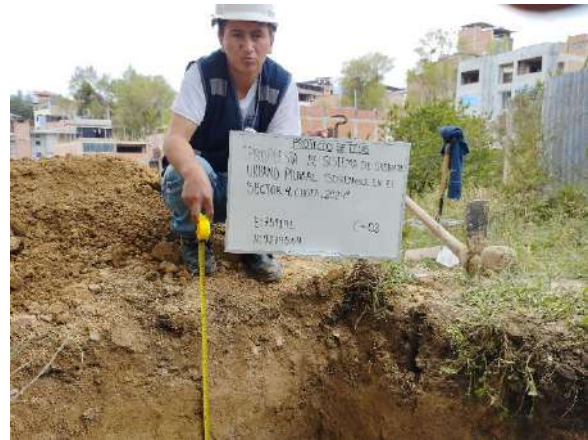
Foto N ° 14. Calicata 02 Sector 4 – Chota.
