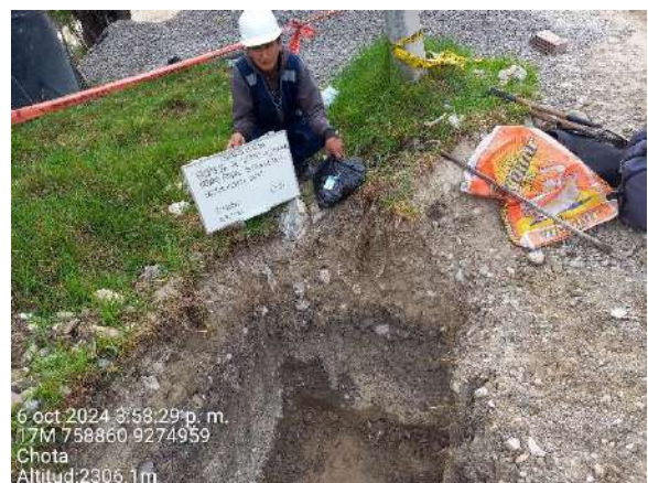
Foto N ° 16. Calicata 04 Sector 4 – Chota.
