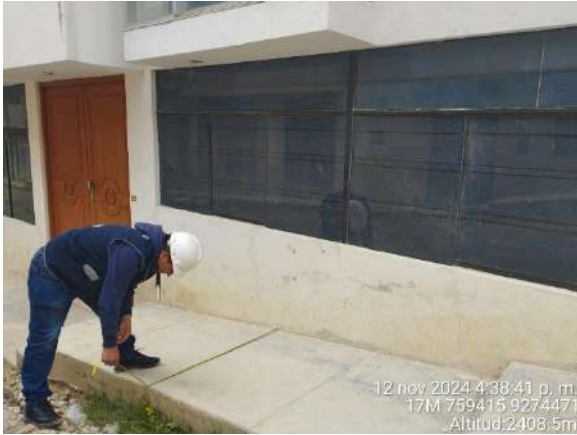
Foto N ° 31. Verificación de vereda en el Sector 4, Chota.
