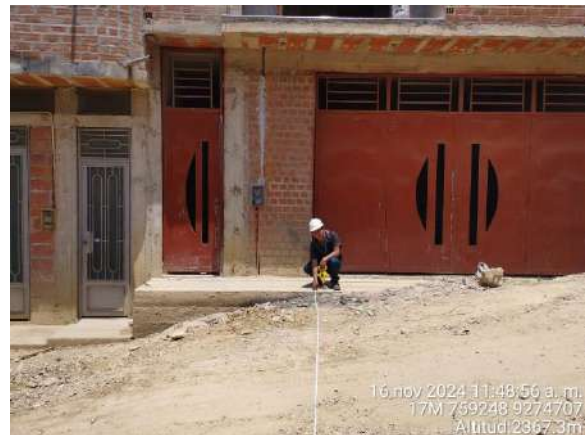
Foto N ° 28. Medición de ancho de calle Psje. Santa Elena en el Sector 4 Chota.
