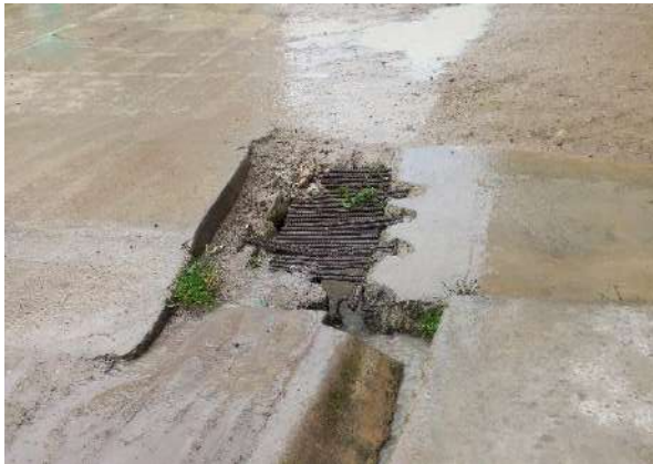
Foto N ° 03. Inspección de rejillas en el Sector 4.
