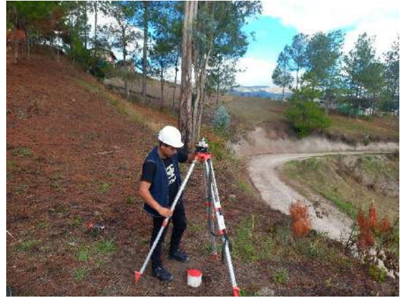
Foto N ° 08. Estacionamiento de equipo para levantamiento topográfico.
