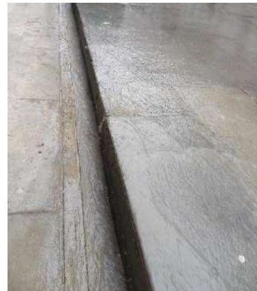
Foto N ° 04. Inspección de cunetas en el Sector 4.
