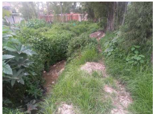
Foto N ° 36. Quebrada San Mateo Propensa Desbordamiento.
