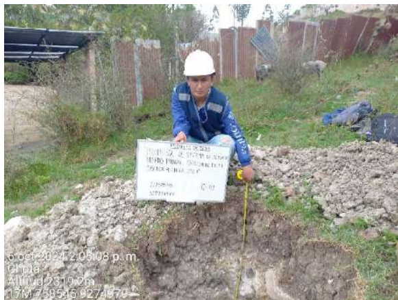
Foto N ° 15. Calicata 03 Sector 4 – Chota.
