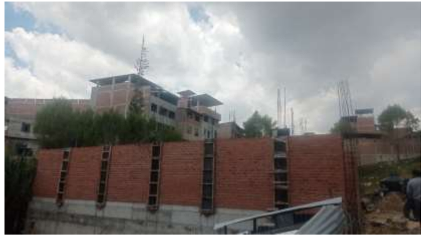
Fotografía 2. Encofrado de columnas de la vivienda N° 1
