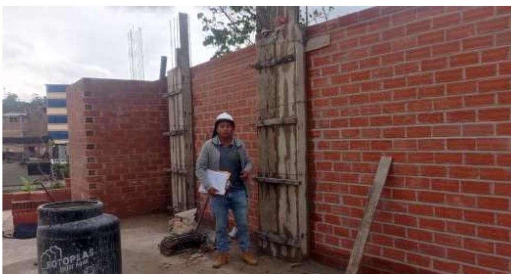
Encofrado de Columnas con Madera
