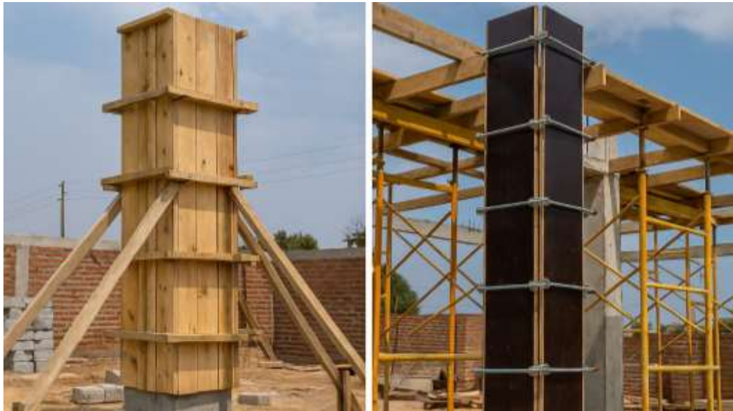
Encofrado de madera
