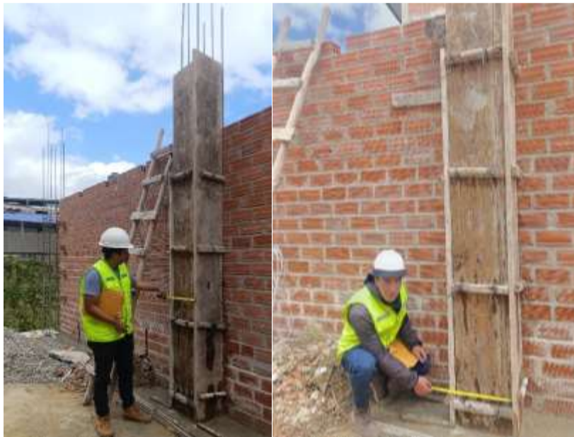
Fotografía 43. Medición del rendimiento en encofrado de columnas de la vivienda N° 11
