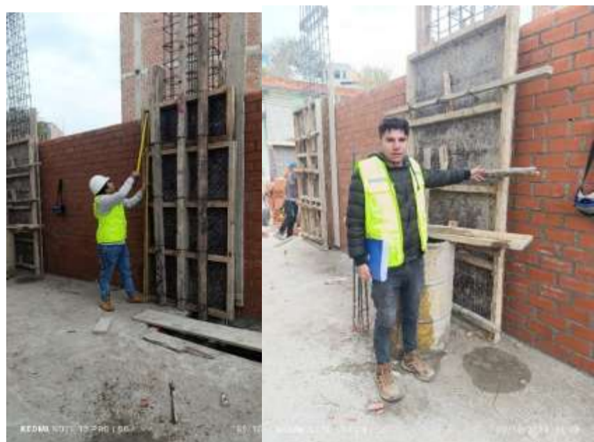
Fotografía 39. Medición del rendimiento en encofrado de columnas de la vivienda N° 10
