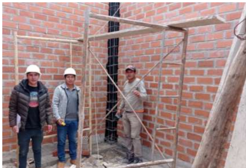
Fotografía 33. Encofrado de columnas de la vivienda N° 9
