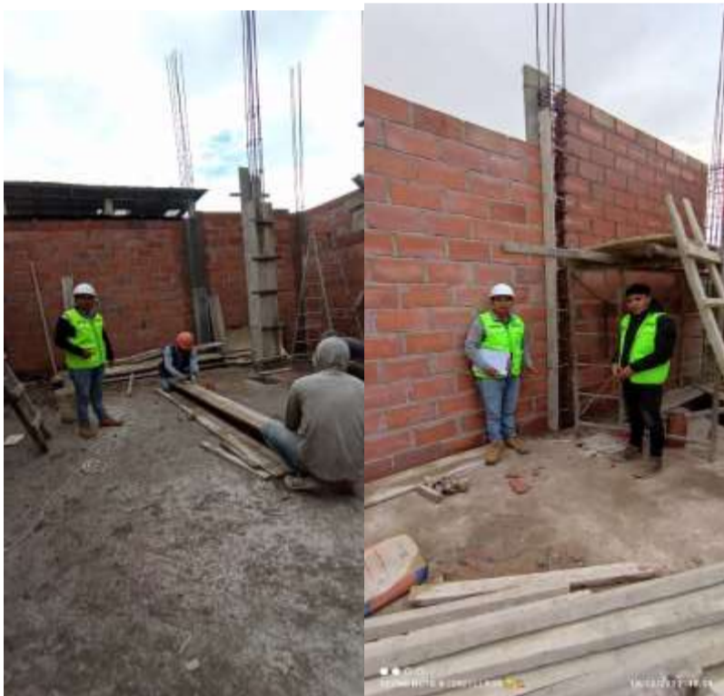
Fotografía 7. Medición del rendimiento en el encofrado de columnas de la vivienda N° 2
