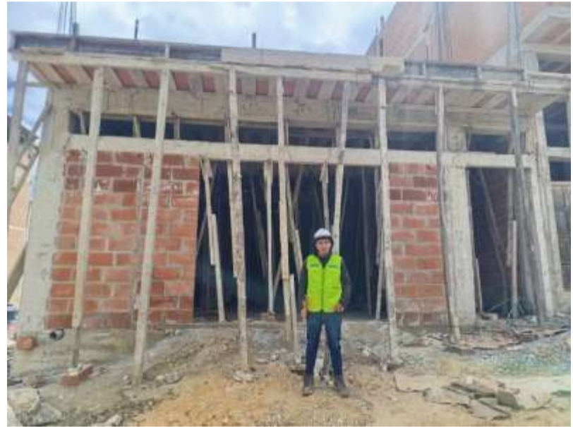
Fotografía 54. Encofrado de columnas de la vivienda N° 14
