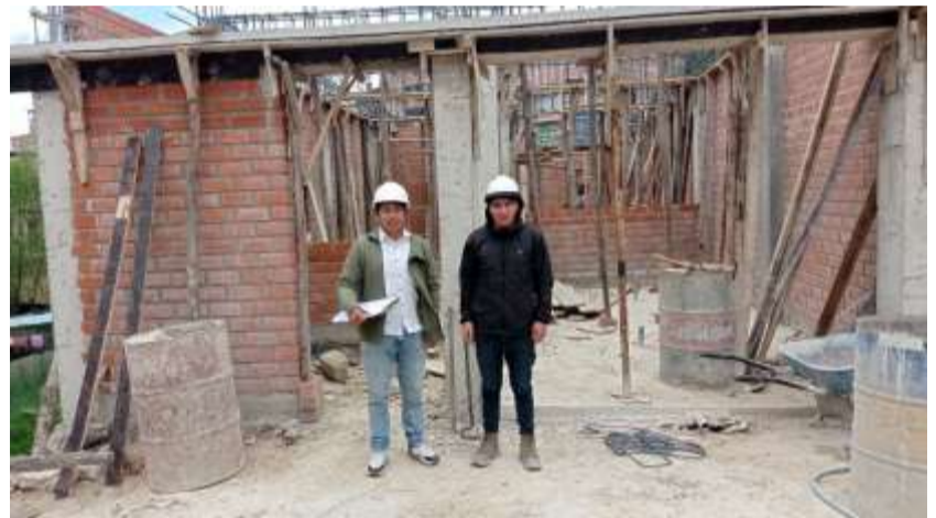
Fotografía 4. Encofrado de vigas de la vivienda N° 1
