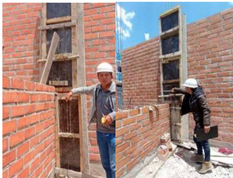
Fotografía 36. Medición del rendimiento en el encofrado de vigas de la vivienda N° 9
