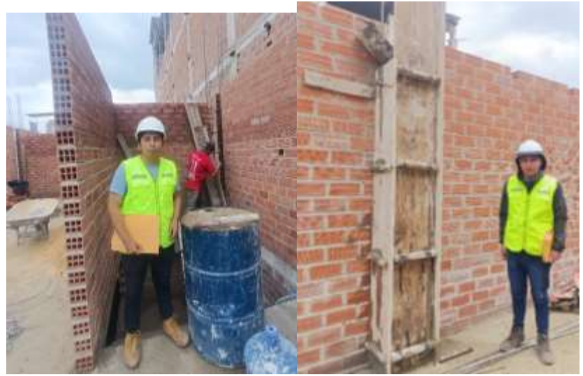
Fotografía 42. Encofrado de columnas de la vivienda N° 11
