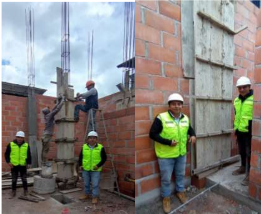
Fotografía 27. Medición del rendimiento en el encofrado de columnas de la vivienda N° 7
