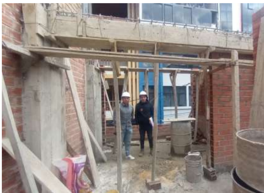
Fotografía 13. Preparación del encofrado de la vivienda N° 4
