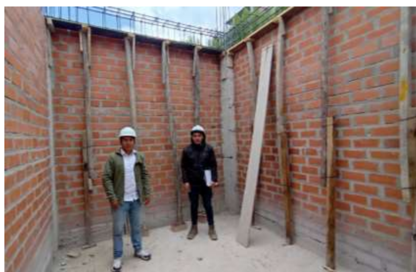
Fotografía 38. Encofrado de columnas de la vivienda N° 10
