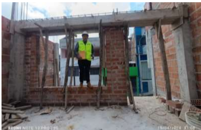
Fotografía 47. Medición del rendimiento en encofrado de columnas de la vivienda N° 12
