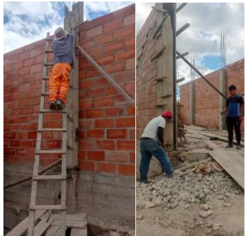
Fotografía 8. Rendimiento de encofrado de vigas de la vivienda N° 2
