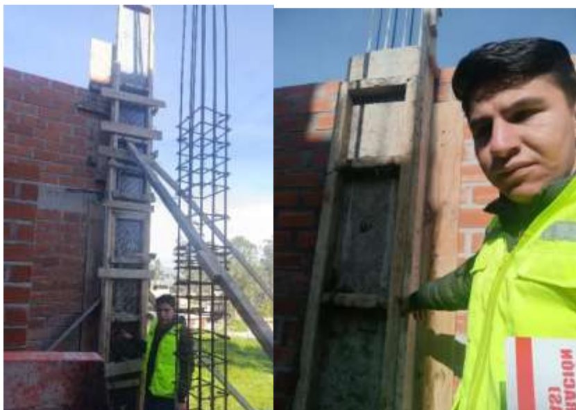
Fotografía 55. Medición del rendimiento en encofrado de columnas de la vivienda N° 14
