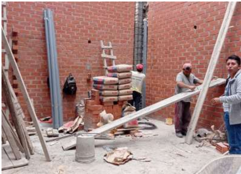
Fotografía 9. Preparación del encofrado de la vivienda N° 3
