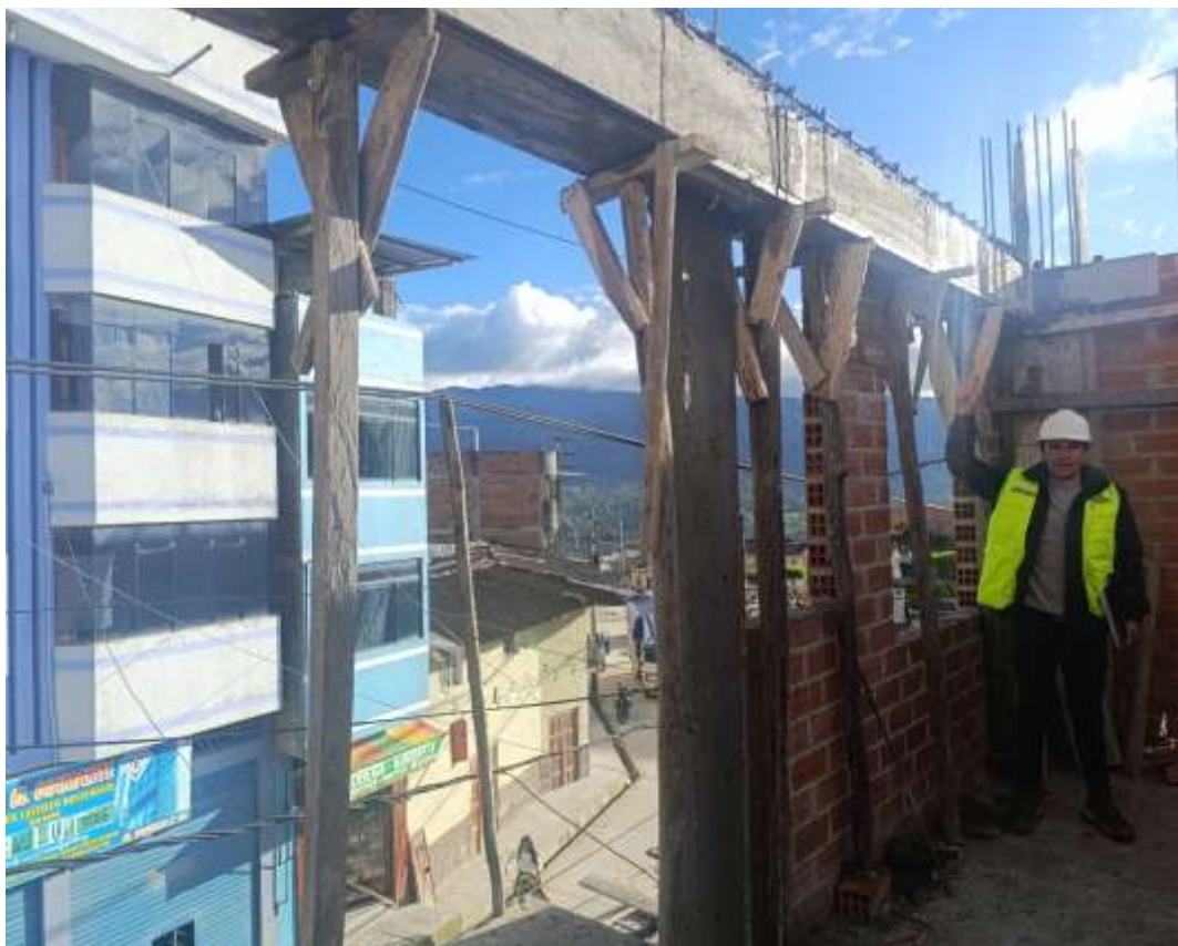
Encofrado de Vigas con Madera Natural
