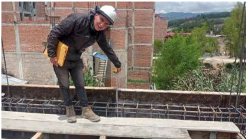
Fotografía 5. Preparación del encofrado de la vivienda N° 2
