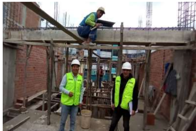
Fotografía 20. Rendimiento de encofrado de vigas de la vivienda N° 5
