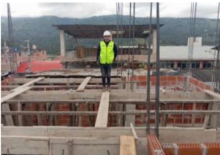
Fotografía 31. Medición del rendimiento en el encofrado de vigas de la vivienda N° 8
