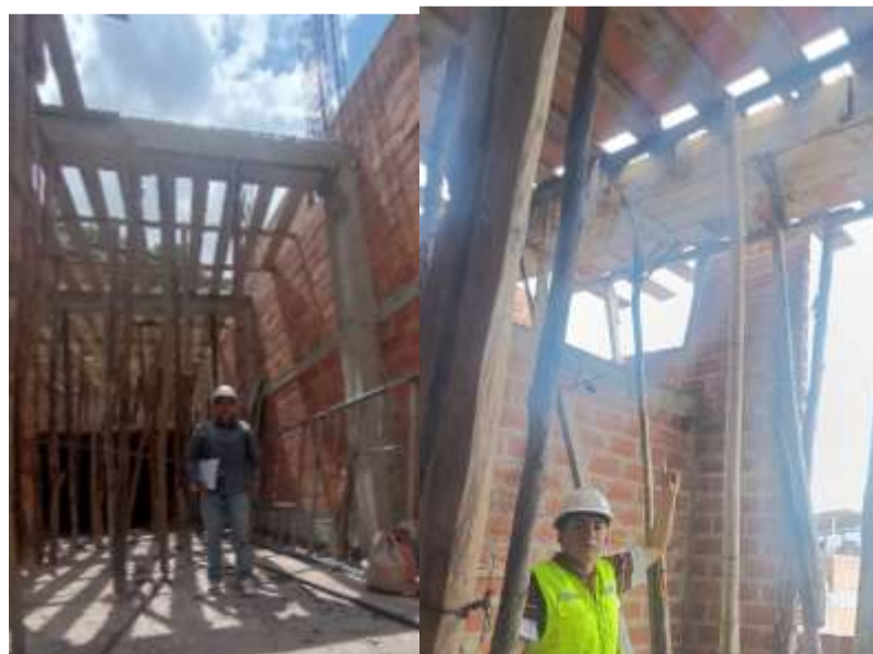
Fotografía 16. Rendimiento de encofrado de vigas de la vivienda N° 4
