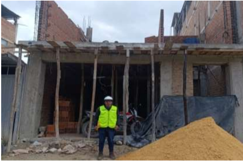
Fotografía 43. Medición del rendimiento en encofrado de columnas de la vivienda N° 11
