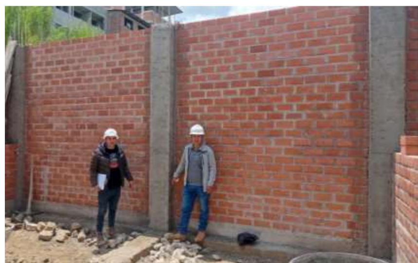
Fotografía 35.. Vista de los acabados de columnas de la vivienda N° 9
