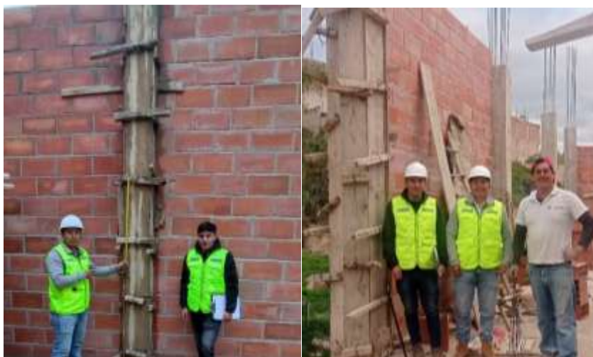
Fotografía 7. Medición del rendimiento en el encofrado de columnas de la vivienda N° 2
