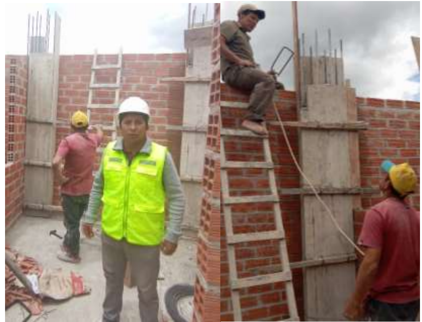
Fotografía 18. Encofrado de columnas de la vivienda N° 5
