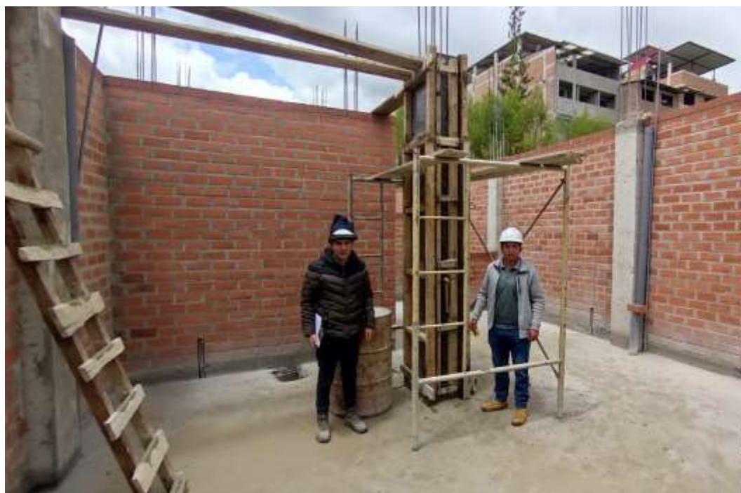
Encofrado de Columnas con Madera Artificial Fenólico
