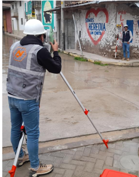
Fotografía 16. Proceso de levantamiento topográfico: toma de puntos en BMS y puntos fijos registrados con esmalte color rojo
