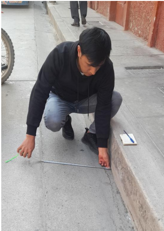
Recolección de medidas del sistema de drenaje pluvial urbano del Jr. Rosendo Mendivel Cuadra 4.
