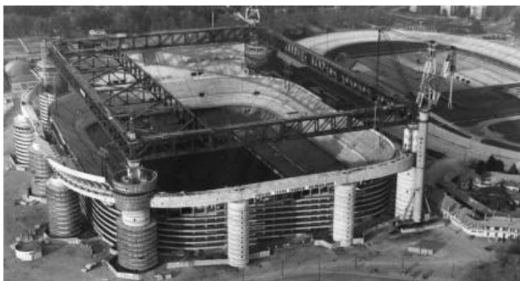
Figura 7 Estructura Adintelada: Construcción de la Cubierta de San Siro
