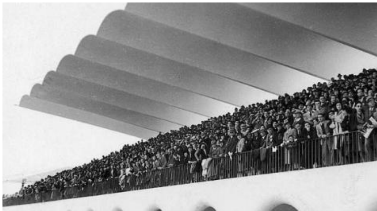
Figura 6 Estructura Volada: Hipódromo de Zarzuela
