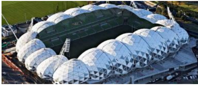
Figura 8 Estructura Abovedada: Aami Park
