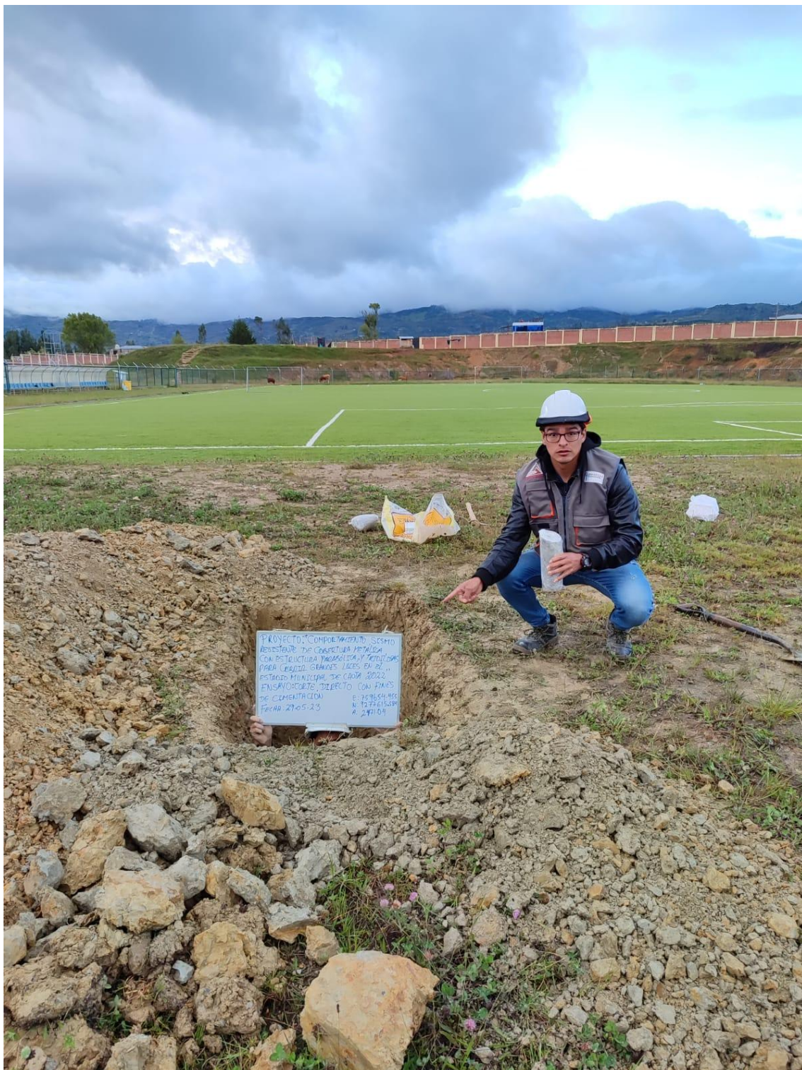
Fotografía 3. Recolección de muestras de suelo inalterado de la calicata en el estadio municipal de Chota
