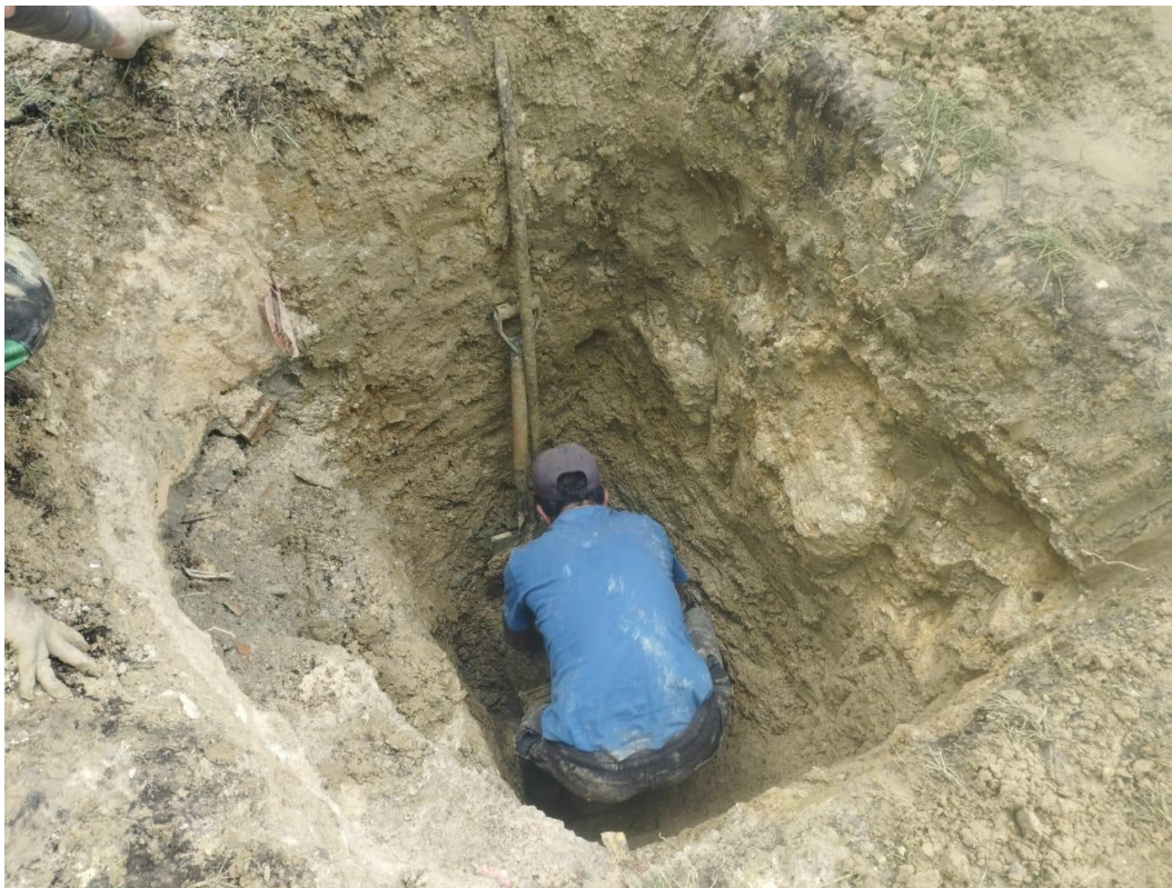
Fotografía 6. Excavación de la calicata 6 en pabellón de EPIFA
