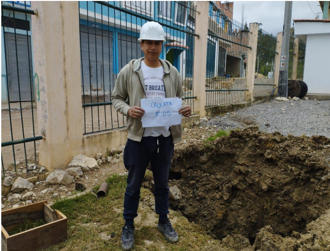
Fotografía 6. Excavación de la calicata 6 en pabellón de EPIFA
