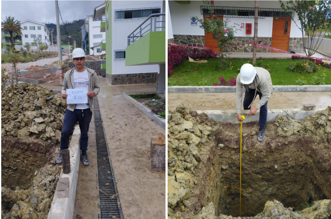
Fotografía 2. Excavación de la calicata 2 en pabellón de civil.
