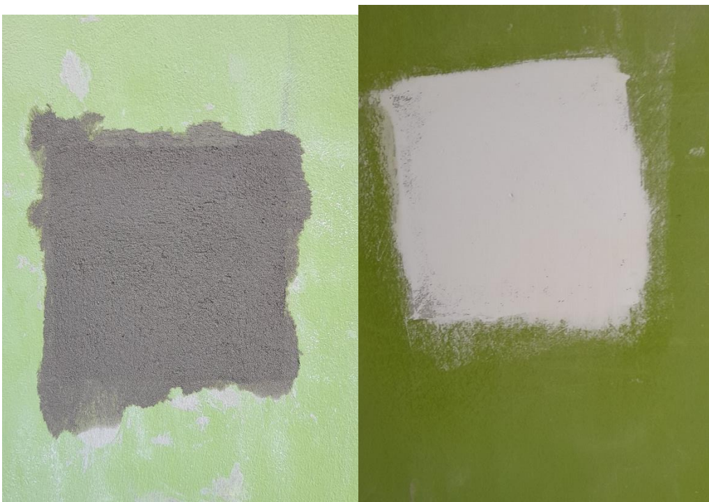
Fotografía 24. Tarrajeo de puntos que fueron afectados para el ensayo de esclerometría
