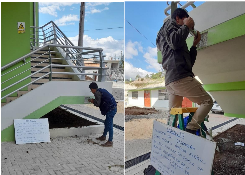
Fotografía 22. Realización de ensayos de esclerometría en escalera
