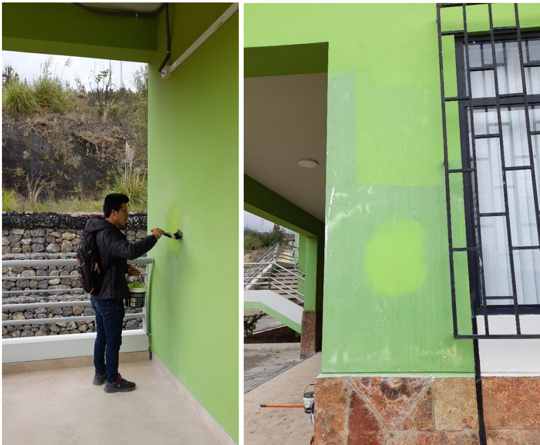
Fotografía 25. Pintado de puntos que fueron afectados para el ensayo de esclerometría
