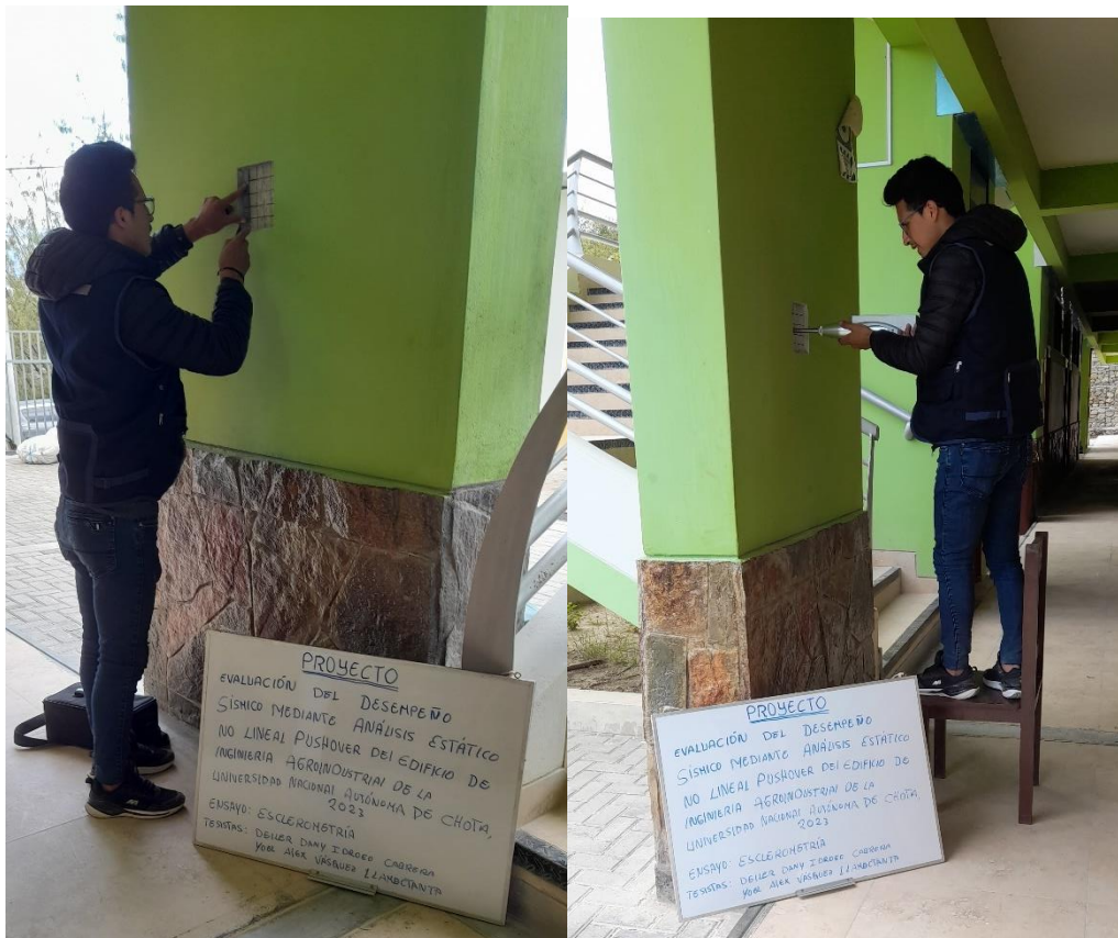
Fotografía 16. Realización de ensayos de esclerometría en columnas
