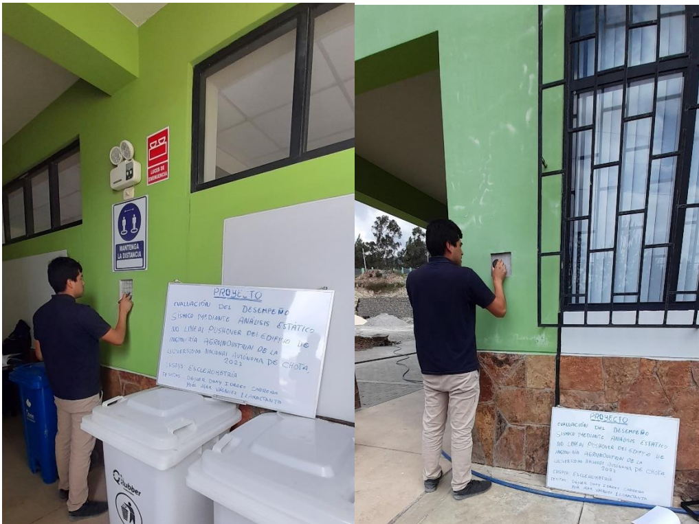
Fotografía 21. Realización de ensayos de esclerometría en columnas
