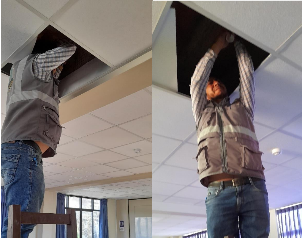
Fotografía 17. Realización de ensayos de esclerometría en losas
