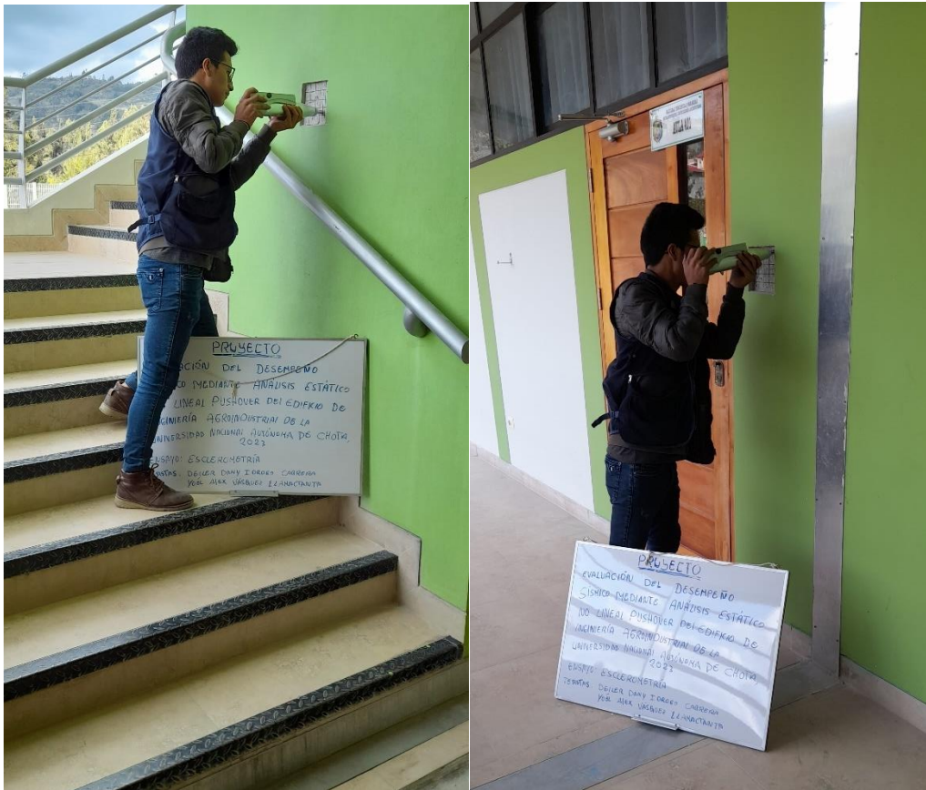
Fotografía 23. Realización de ensayos de esclerometría en escalera
