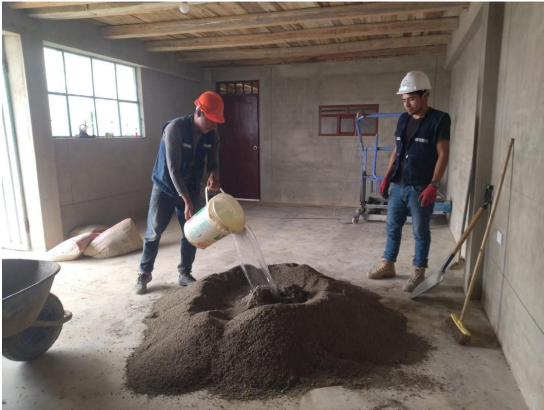
Fotografía 12. Elaboración de los bloques de ladrillos.
