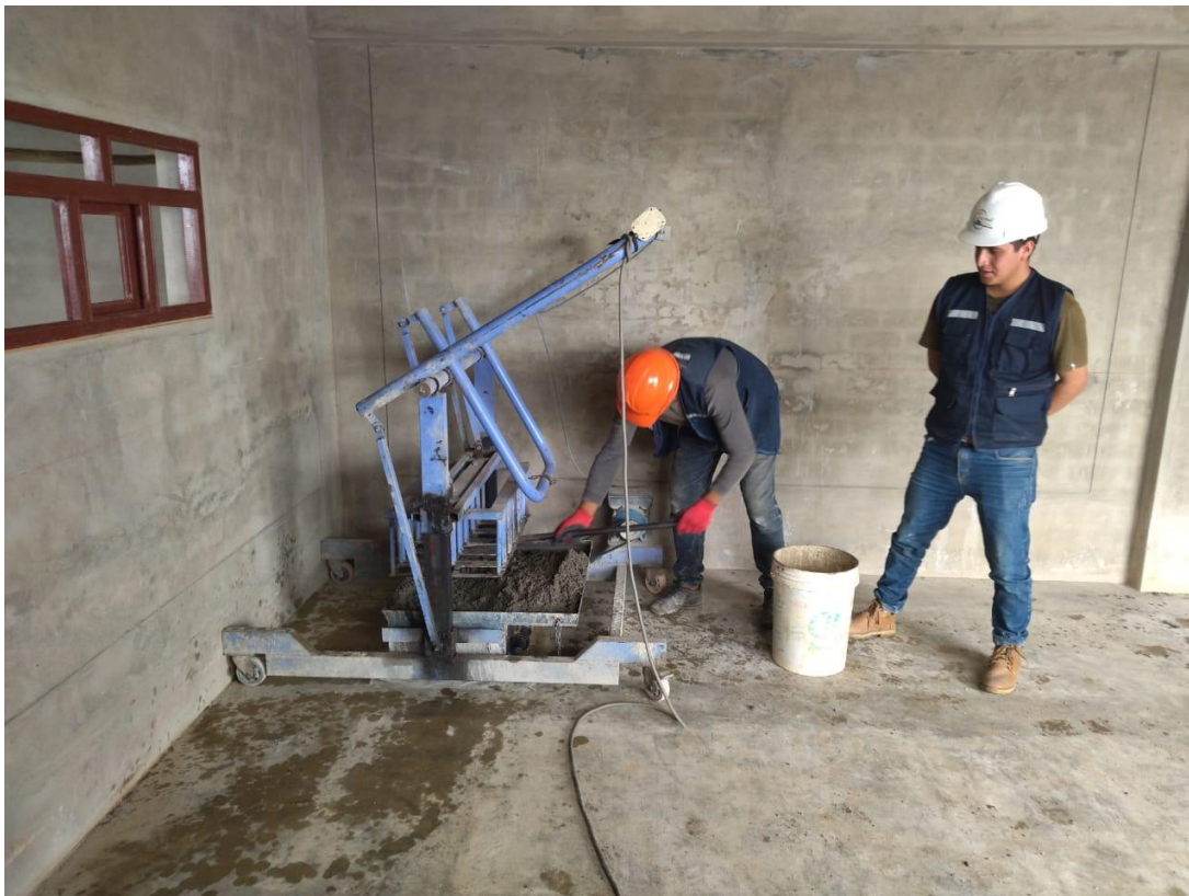
Fotografía 12. Elaboración de los bloques de ladrillos.
