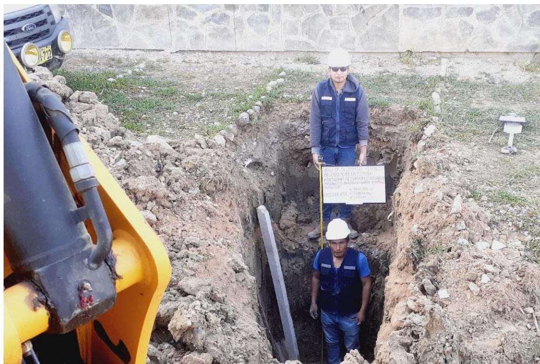
Excavación de Muestras de Suelo de Cimentación
