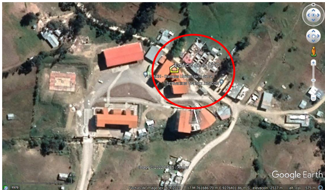
Edificio de Contabilidad
