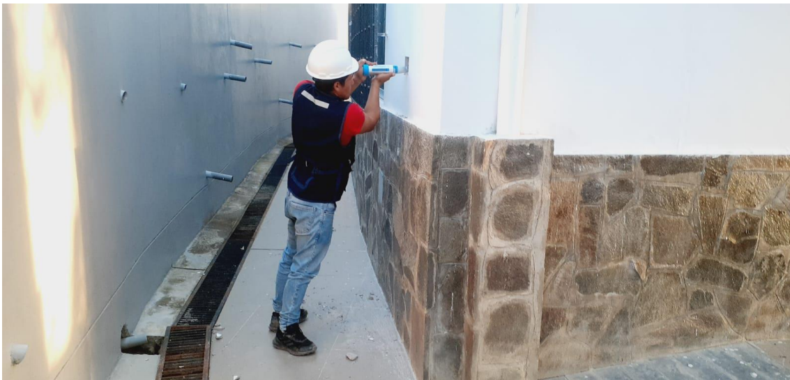
Fotografía 4. Ensayo de esclerometría en la columna del pabellón de contabilidad
