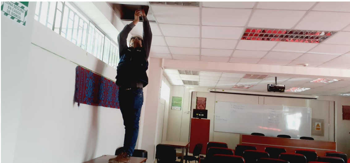
Fotografía 7. Ensayo de esclerometría en la placa del pabellón de contabilidad
