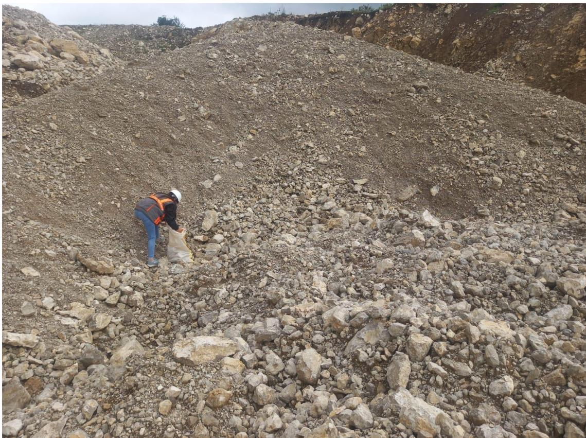
Fotografía 4. Recolección de residuos de concreto en la vivienda demolida
