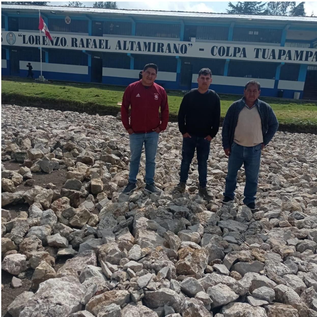
Figura 6 Vista donde se aprecia la base de la infraestructura conformado por afirmado con un espesor de 15 cm para la construcción de la losa deportiva de la I E 10405 Lorenzo Rafael Altamirano.
