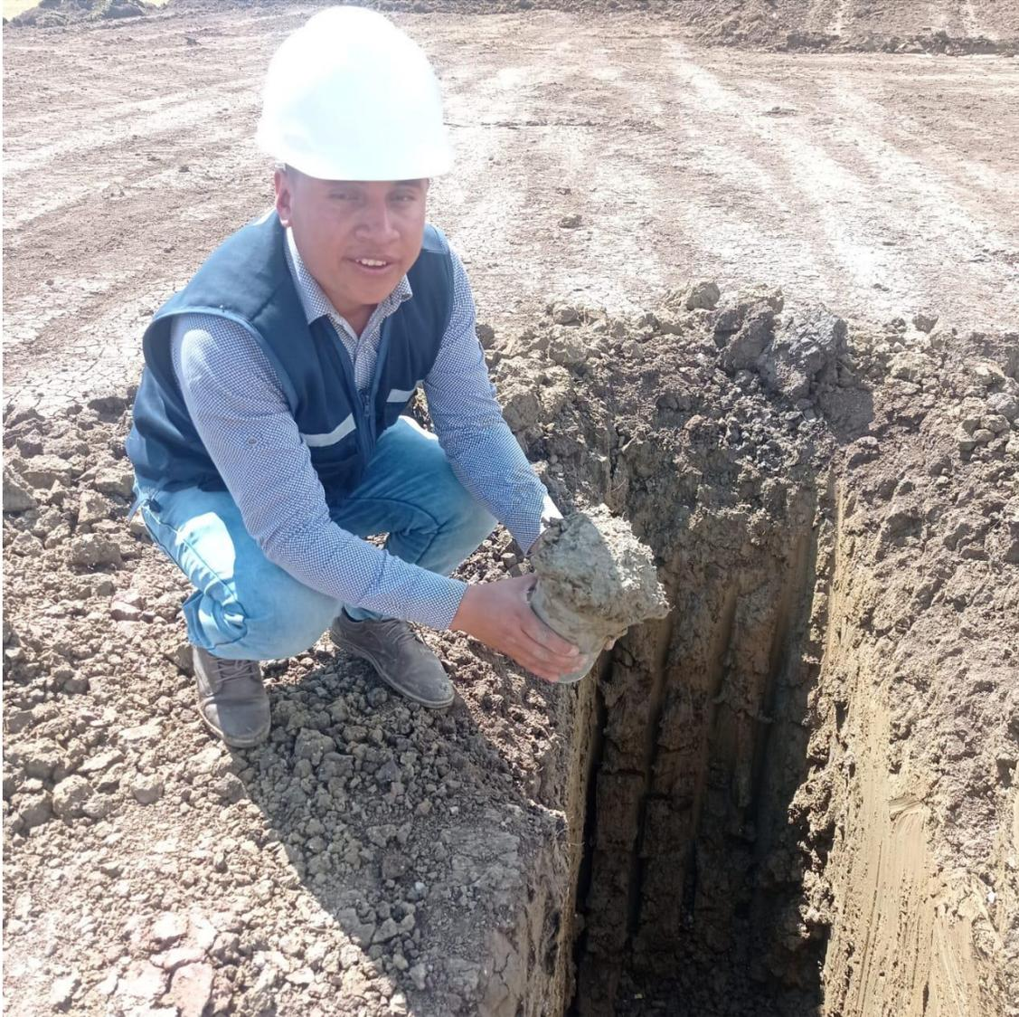
Figura 5 Colocación de la subrasante conformada por piedra mediana con un *espesor de 25* cm para la construcción de la losa deportiva de la I E 10405 Lorenzo Rafael Altamirano.
