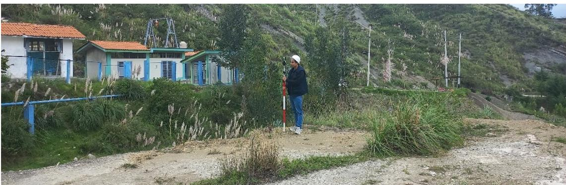
Fotografía 11 Toma de puntos topográficos en el puente que da inicio a la rápida hidráulica por parte de los tesistas durante el levantamiento topográfico
