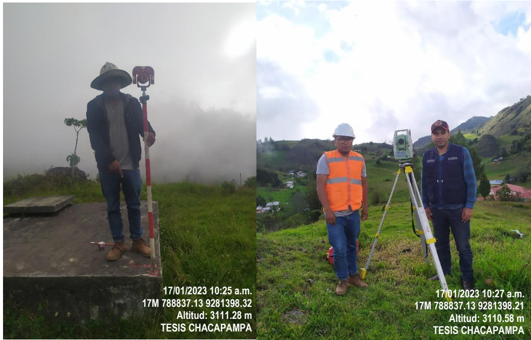
17/01/2023 Levantamiento topográfico en el CC. PP Chacapampa-Chadín
