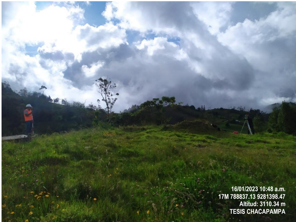
16/01/2023 Levantamiento topográfico en el CC. PP Chacapampa-Chadín
