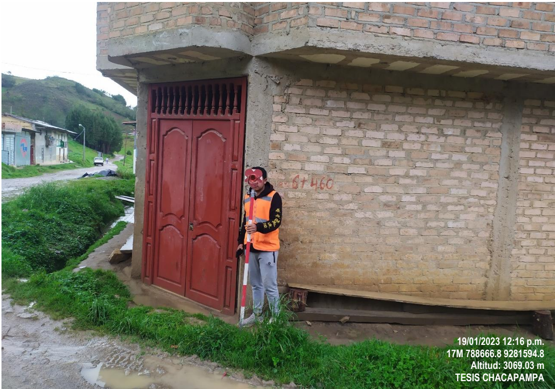
19/01/2023 Levantamiento topográfico para conexiones domiciliarias en el CC. PP Chacapampa-Chadín
