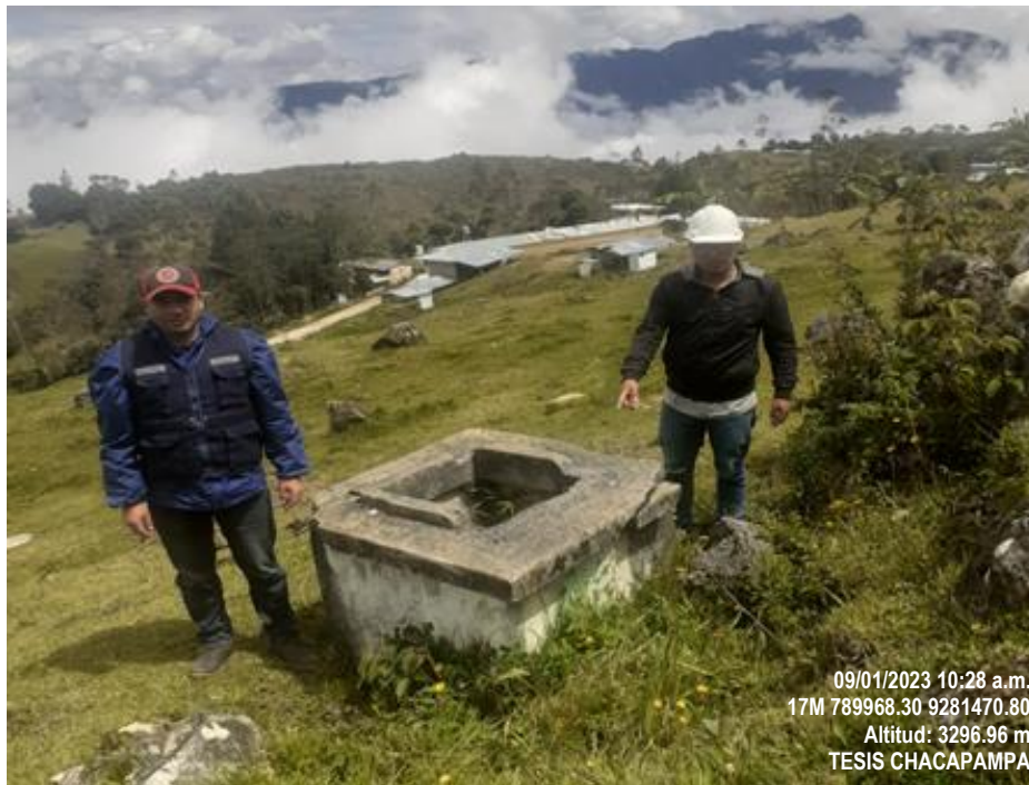
09/01/2023. Tesistas realizando la evaluación de los componentes del sistema de agua potable
