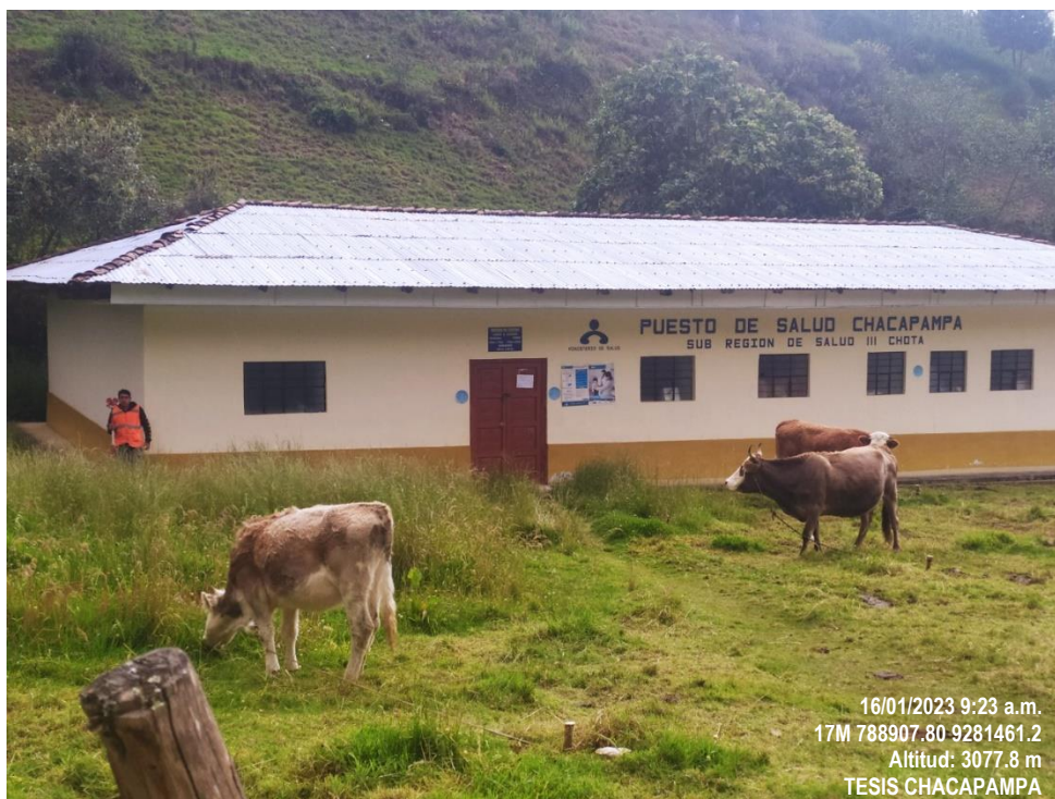
16/01/2023 Levantamiento topográfico para conexiones domiciliarias en el CC. PP Chacapampa-Chadín
