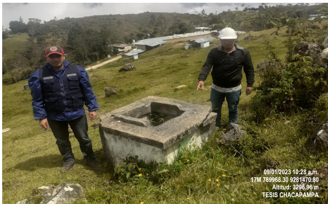
Figura 39 Estado de la Caja de Reunión del Sistema de Abastecimiento de Chacapampa
