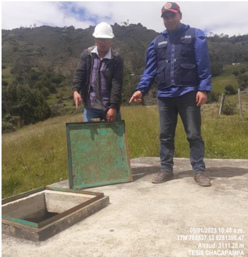
09/01/2023. Tesistas realizando la evaluación del reservorio existente
