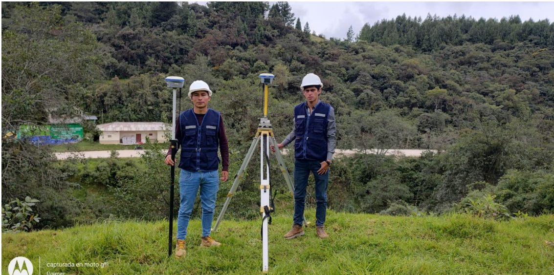
Fotografía 2 Toma de puntos en la carretera La Palma – Chota, talud Llarillaco
