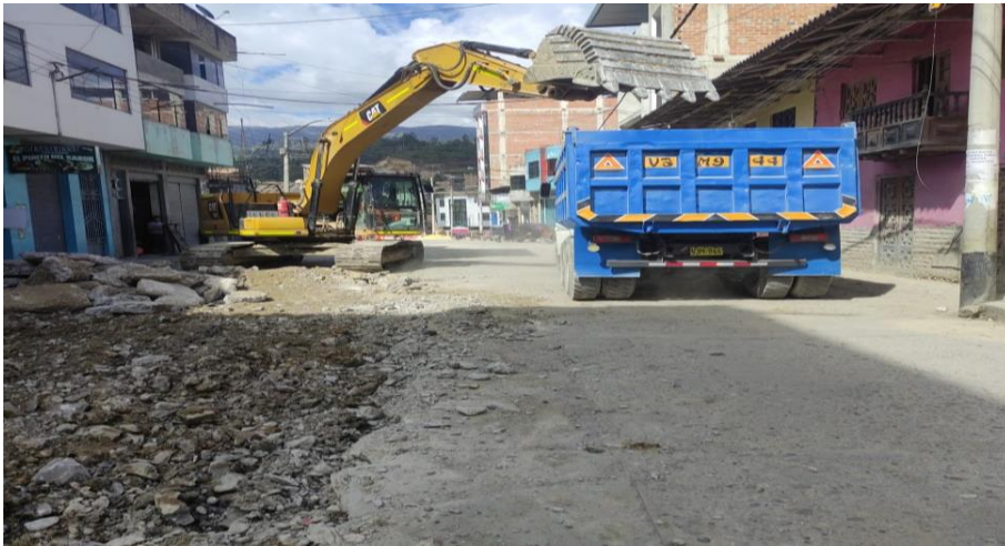
FOTOGRAFÍA N° 01: Demolición de pavimento de concreto de 0.20 m
