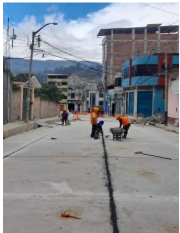
FOTOGRAFÍA N° 33: llenado de juntas en pavimento e=1'' haciendo uso de asfalto liquido
