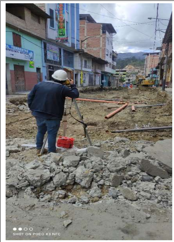
FOTOGRAFÍA N° 3: Trazo, nivel y replanteo durante la ejecución
