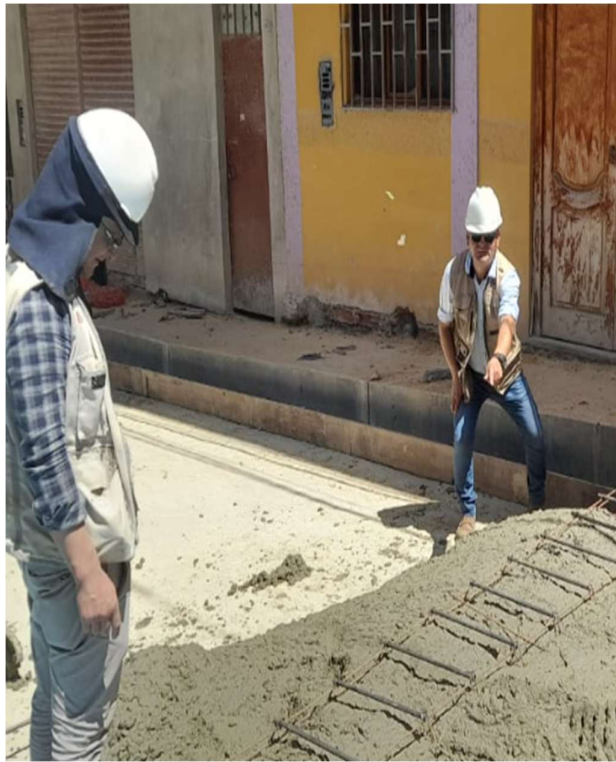
FOTOGRAFÍA N° 16: habilitación de acero liso de 1" para dowels
