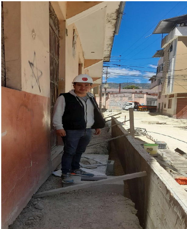
FOTOGRAFÍA N° 12: encofrado de veredas C1, teniendo en cuenta las medidas y pendientes
