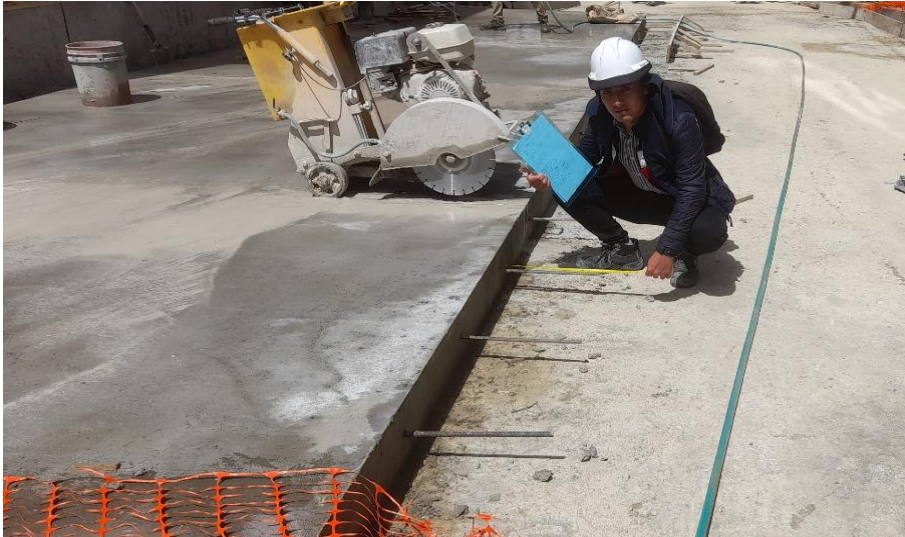
FOTOGRAFÍA N° 16: acero de refuerzo de 1/2" para su uso en juntas longitudinales.
