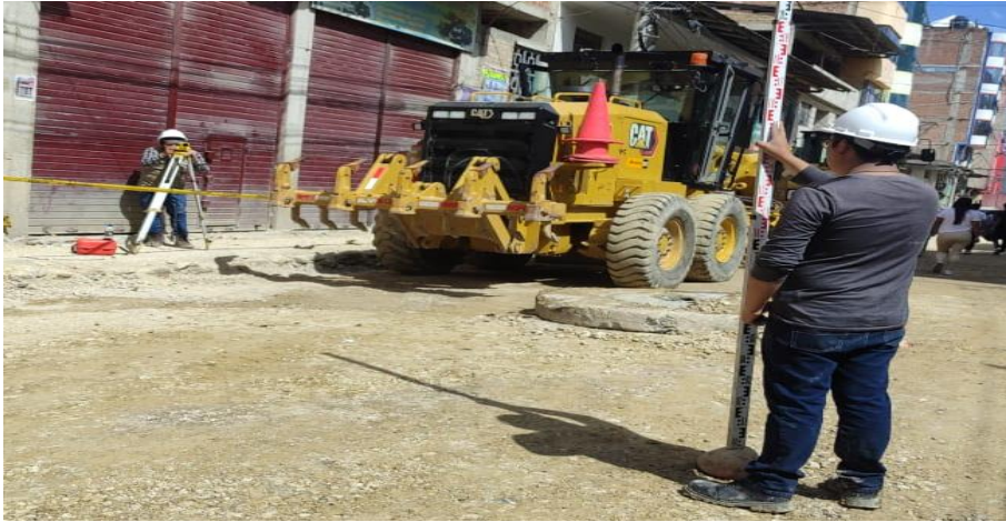
FOTOGRAFÍA N° 13: Nivelación in-situ para determinación de alturas de la pavimentación
