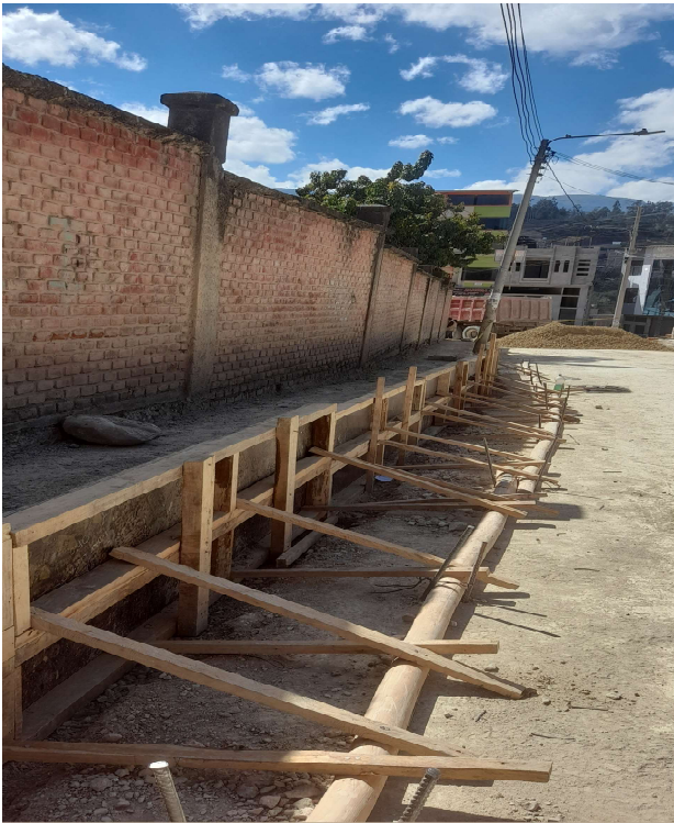
FOTOGRAFÍA N° 16: encofrado de veredas, teniendo en cuenta las medidas y pendientes
