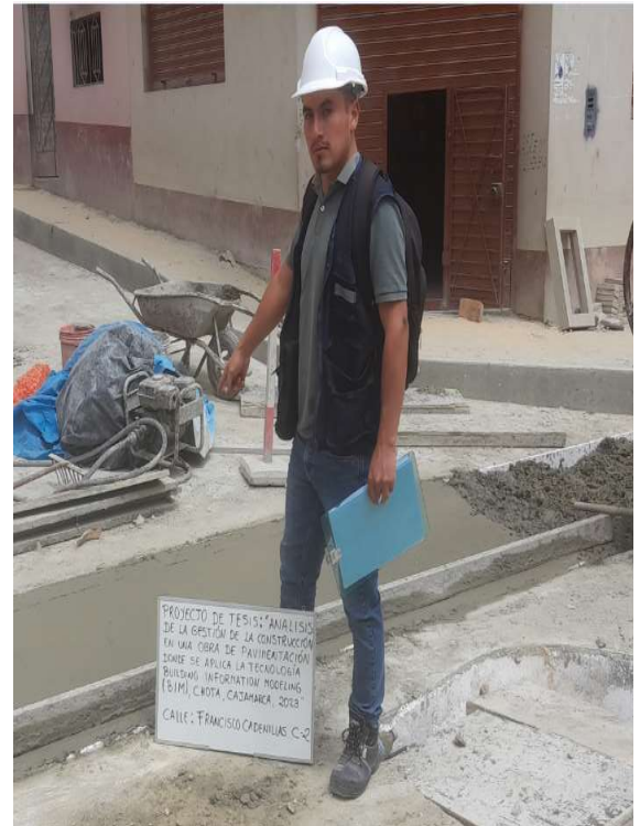
FOTOGRAFÍA N° 23: encofrado y vaciado de concreto 210 kg/cm 2 en badenes.
