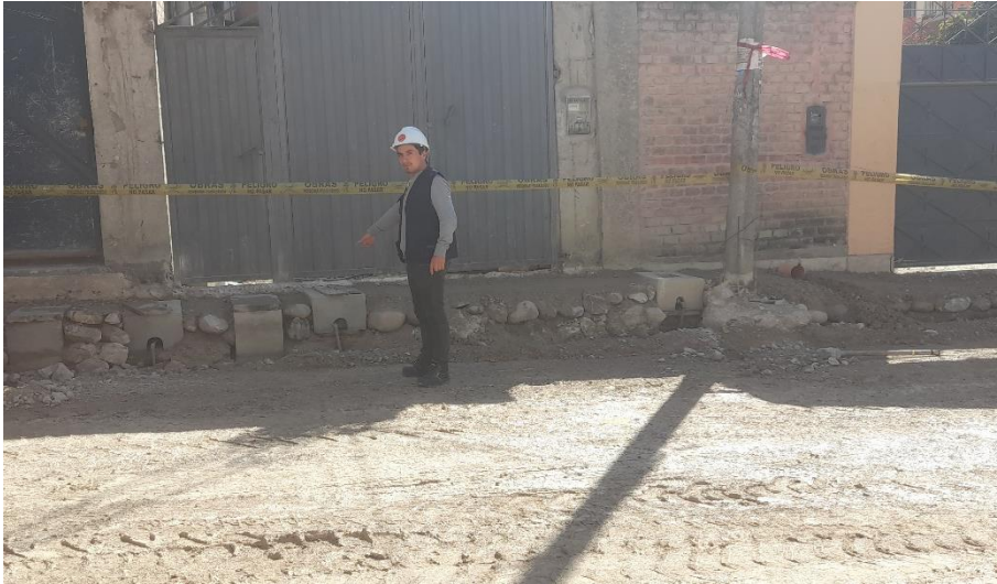
FOTOGRAFÍA N° 10: instalación cajas para desagüe
