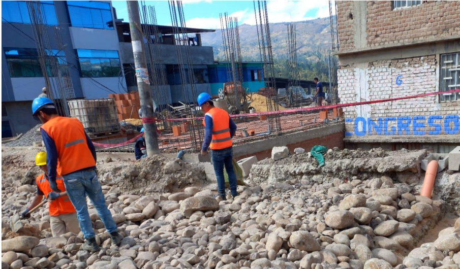
FOTOGRAFÍA N° 04: Instalación de tuberías de desagüe
