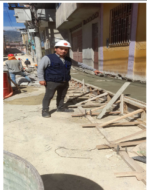
FOTOGRAFÍA N° 19: Acabado de veredas.
