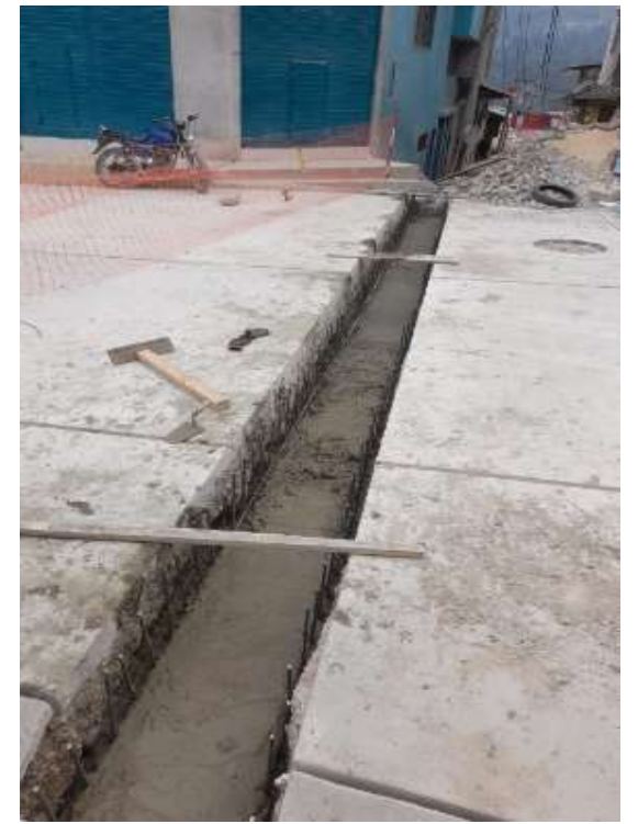
FOTOGRAFÍA N° 31: vaciado de alcantarilla f'c = 210 \text{ kg/cm}^2
