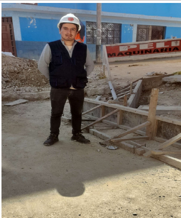
FOTOGRAFÍA N° 14: encofrado de veredas C2, teniendo en cuenta las medidas y pendientes
