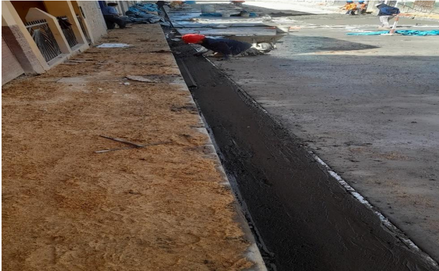
FOTOGRAFÍA N° 25: vaciado de cunetas de concreto f'c = 175 \text{ kg/cm}^2
