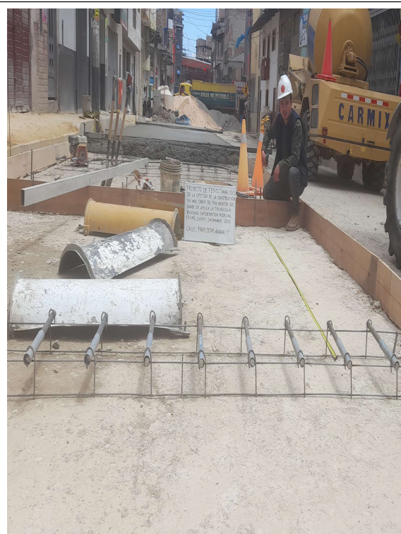
FOTOGRAFÍA N° 25: habilitación de acero liso de 1" para dowels
