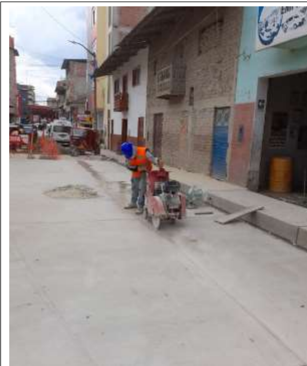
FOTOGRAFÍA N° 32: Acerrando las juntas de contracción e=3\text{mm}
