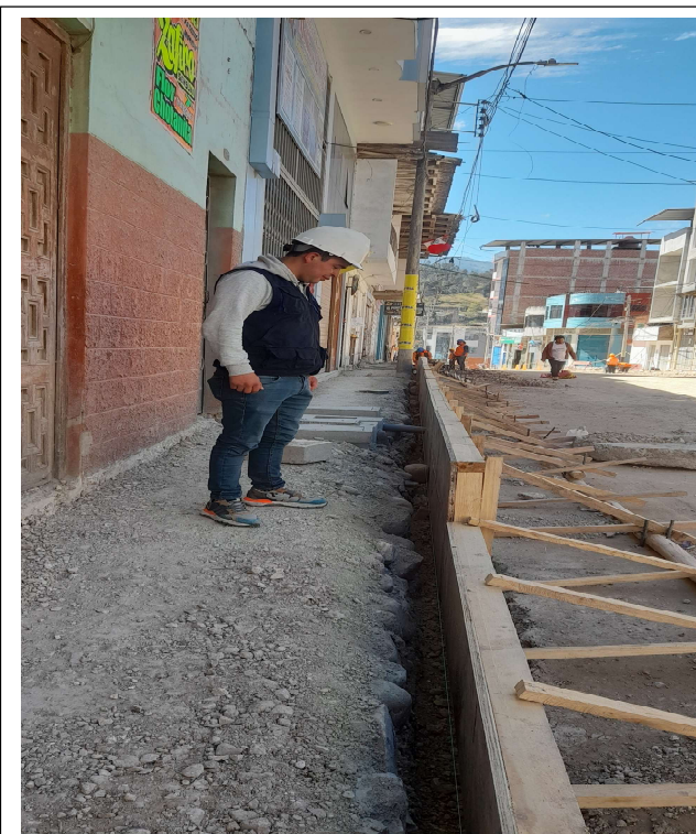
FOTOGRAFÍA N° 14: habilitación de encofrado para veredas, teniendo en cuenta las medidas y pendientes
