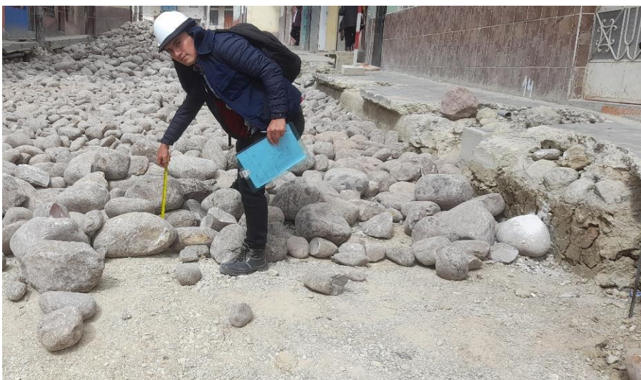
FOTOGRAFÍA N°06: Mejoramiento de subrasante con over e=0.35 m
