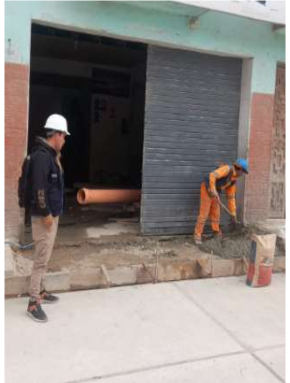
FOTOGRAFÍA N° 29: vaciado de losa de rampas de concreto f'c = 175 \text{ kg/cm}^2
