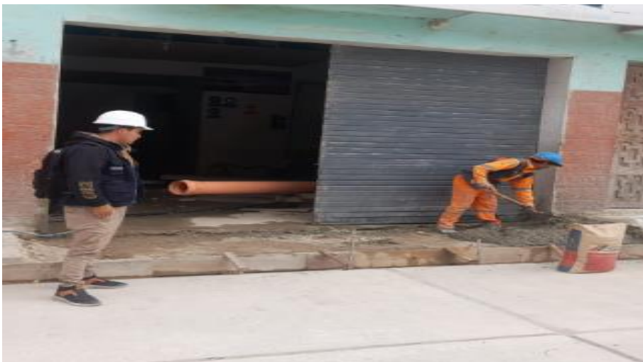
FOTOGRAFÍA N° 24: vaciado de losa de rampas de concreto f'c = 175 \text{ kg/cm}^2
