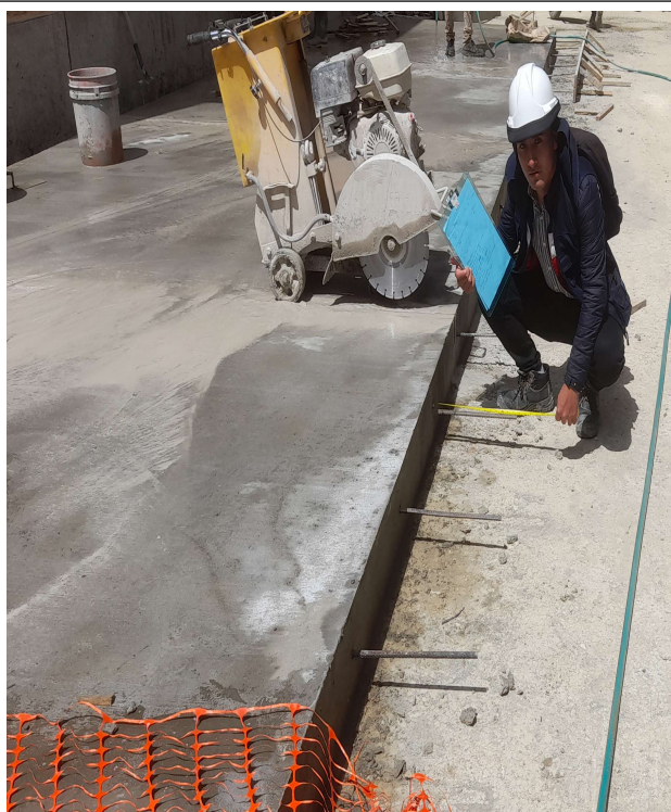
FOTOGRAFÍA N° 26: acero de 1/2" para su uso en juntas longitudinales
