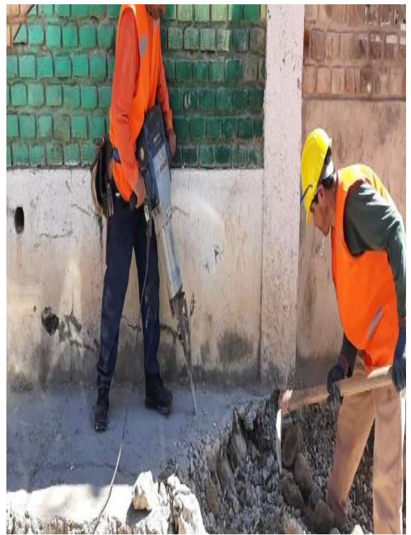
FOTOGRAFÍA N° 5: Demolición de vereda existentes
