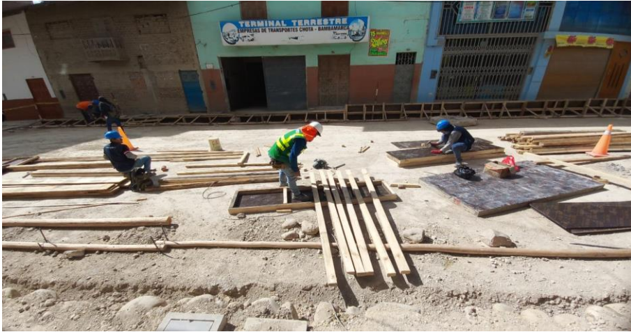
FOTOGRAFÍA N° 16: habilitación de madera para encofrar veredas
