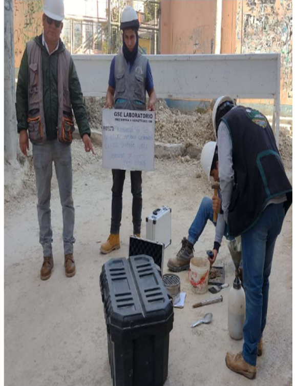
FOTOGRAFÍA N° 13: prueba de Densidad de campo a nivel de base de pavimento
