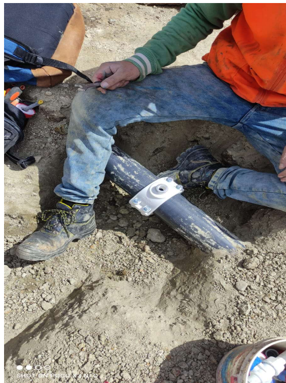
FOTOGRAFÍA N° 5: Instalación de tuberías de agua
