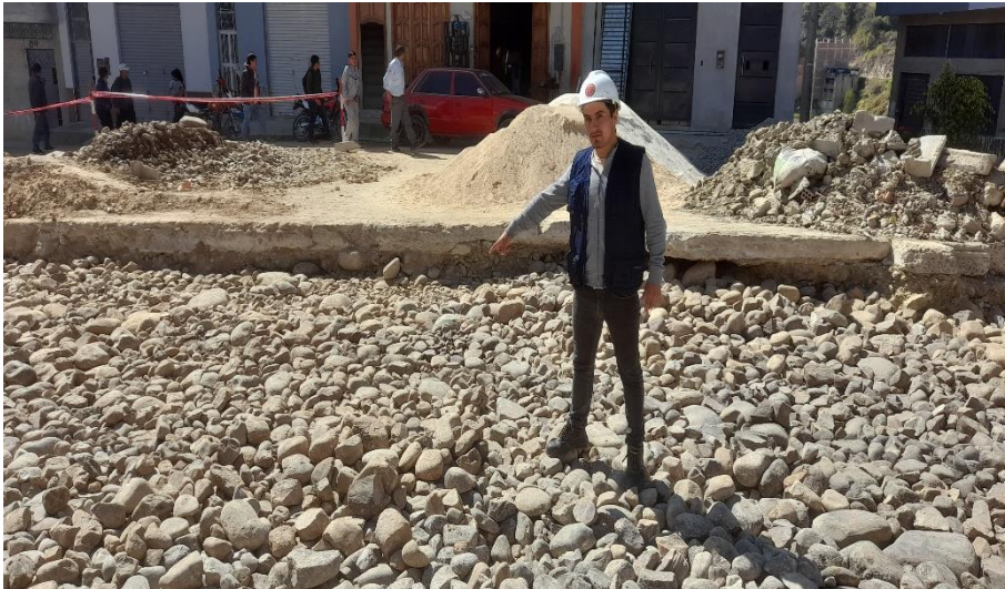
FOTOGRAFÍA N°08: Tendido de over e=0.35 m para mejoramiento de subrasante
