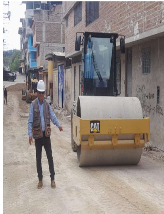
FOTOGRAFÍA N° 11: conformación de la sub base Granular e=0.20 con Equipo Pesado.
