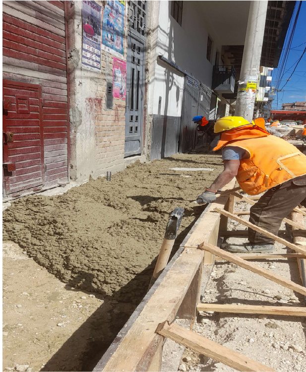
FOTOGRAFÍA N° 20: vaciado de concreto en veredas, concreto f'c = 175 \text{ Kg/cm}^2
