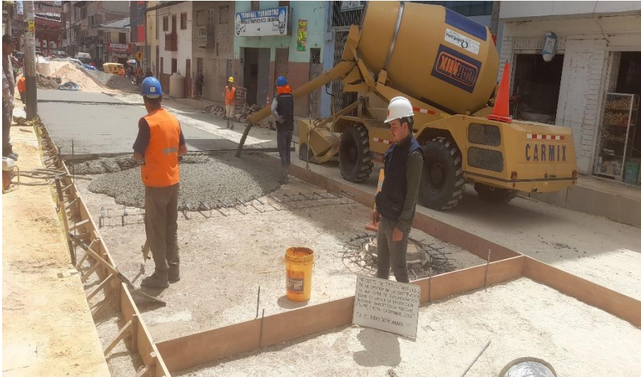
FOTOGRAFÍA N° 22: vaciado de losa de pavimento de concreto f'c = 210 \text{ kg/cm}^2 , haciendo uso de carmix
