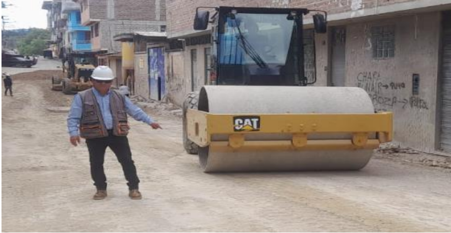
FOTOGRAFÍA N° 10: conformación de la sub base Granular e= 0.20 con Equipo Pesado
