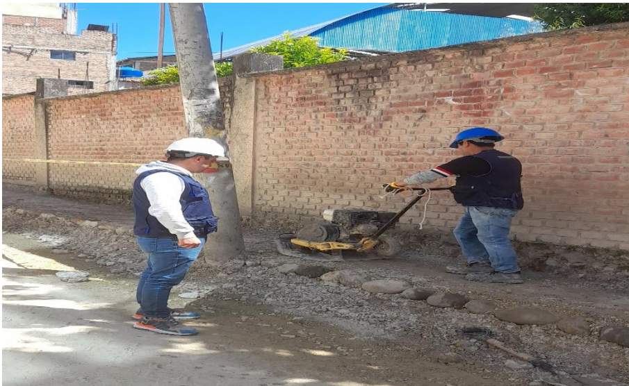
FOTOGRAFÍA N° 14: Nivelación y compactación a nivel de subrasante en veredas
