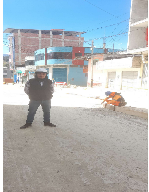
FOTOGRAFÍA N° 21: habilitación de madera para encofrar la losa de pavimento
