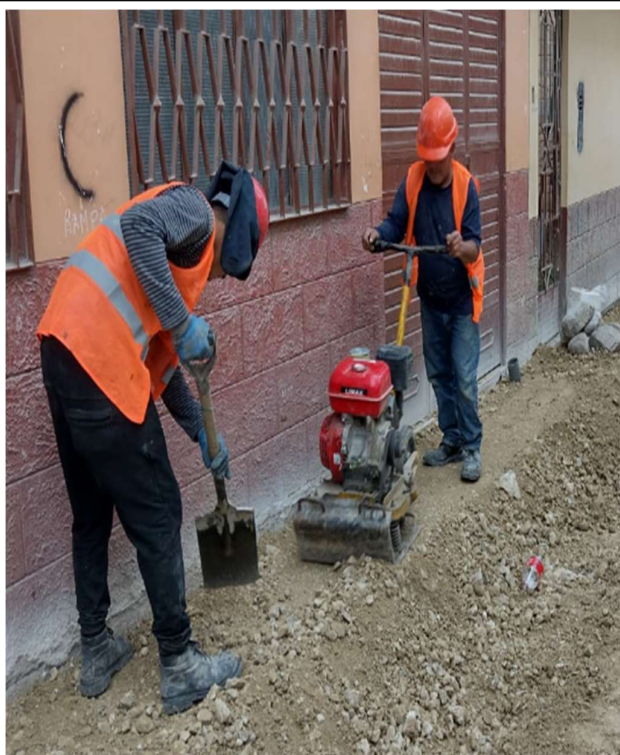
FOTOGRAFÍA N° 4: conformación de base granular en veredas
