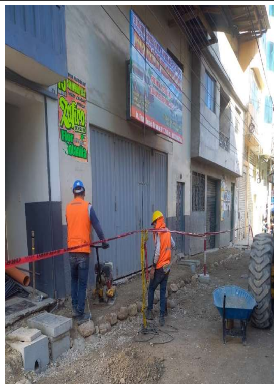
FOTOGRAFÍA N° 13: Compactación y nivelación de base granular e= 0.10 m
