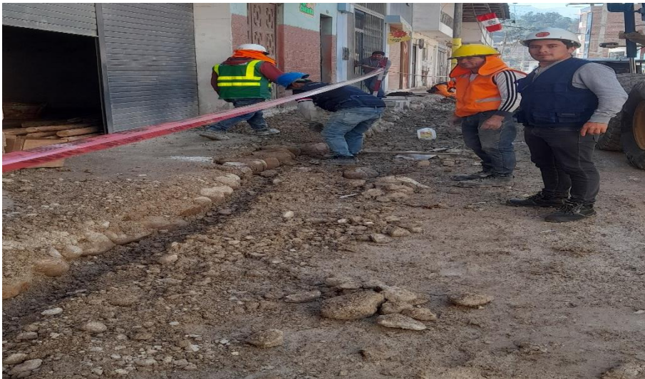
FOTOGRAFÍA N°11: Perfilado de veredas para posterior compactación
