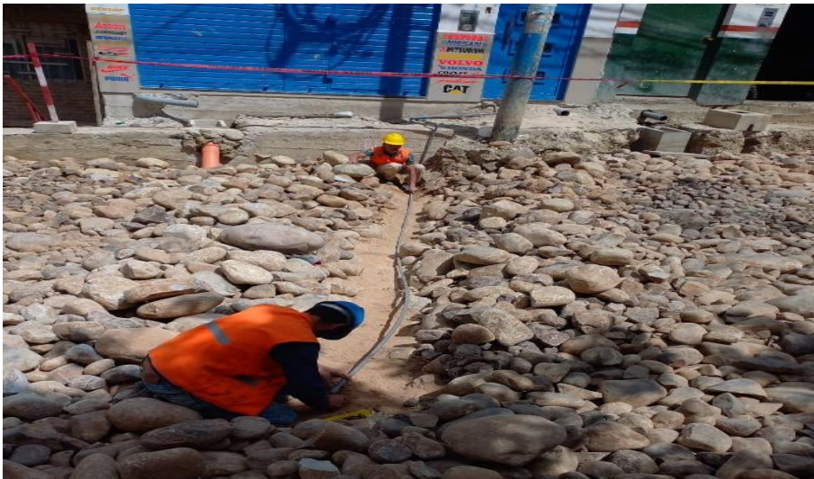
FOTOGRAFÍA N° 05: Suministro e instalación de tuberías de agua
