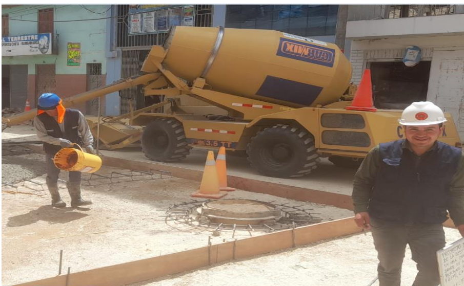
FOTOGRAFÍA N° 21: haciendo uso de antisol en la etapa inicial de fraguado.
