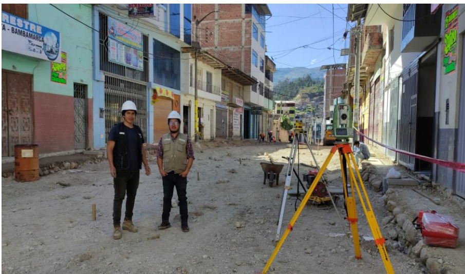
FOTOGRAFÍA N° 03: Trazo, nivel y replanteo durante la ejecución
