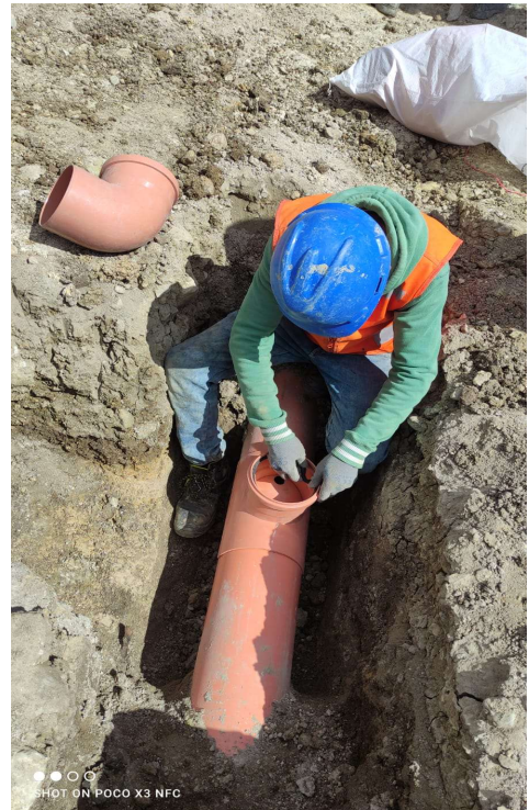
FOTOGRAFÍA N° 7: Instalación de tuberías de desagüe
