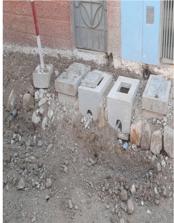
FOTOGRAFÍA N° 9: colocación de cajas de conexiones de agua y desagüe.
