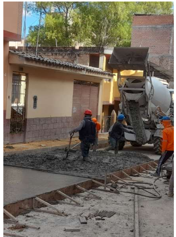
FOTOGRAFÍA N° 21: vaciado de losa de pavimento de concreto f'c = 210 kg/cm 2
