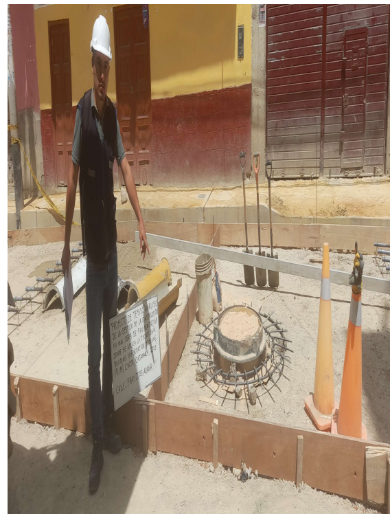
FOTOGRAFÍA N° 27: habilitación de acero para buzones
