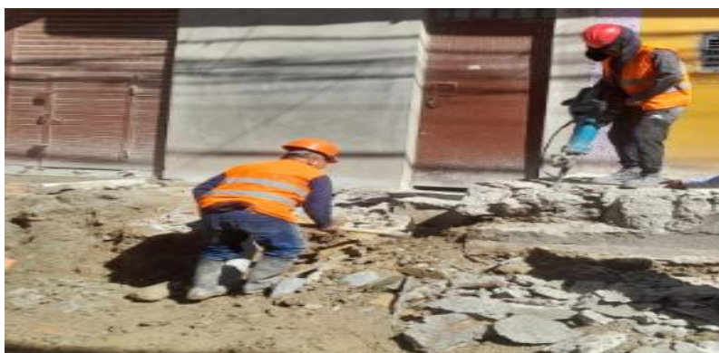
FOTOGRAFÍA N° 02: Demolición de vereda existentes
