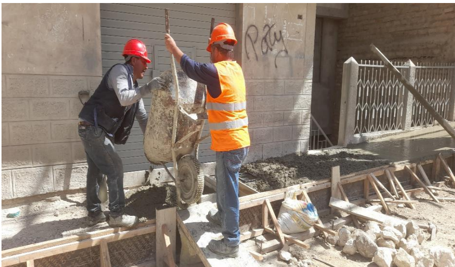
FOTOGRAFÍA N° 12: vaciado de concreto en veredas, concreto f'c= 175 \text{ Kg/cm}^2
