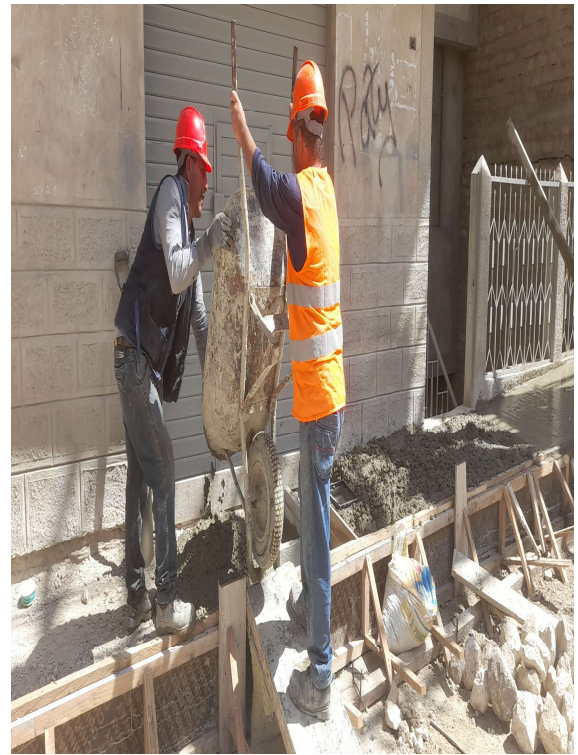
FOTOGRAFÍA N° 17: vaciado de concreto en veredas, concreto f'c= 175 \text{ Kg/cm}^2
