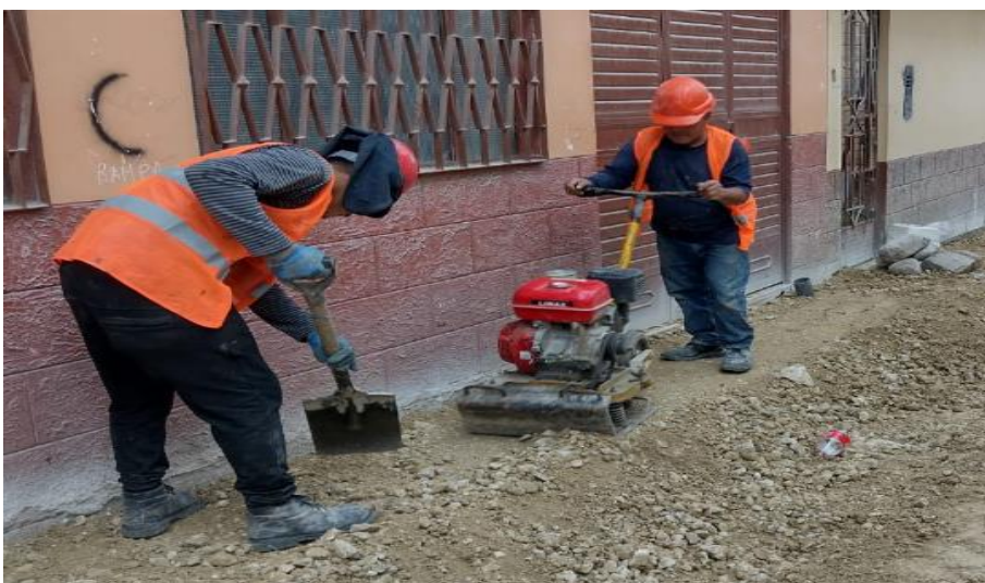
FOTOGRAFÍA N° 09: Compactación y nivelación de base granular e= 0.10 m
