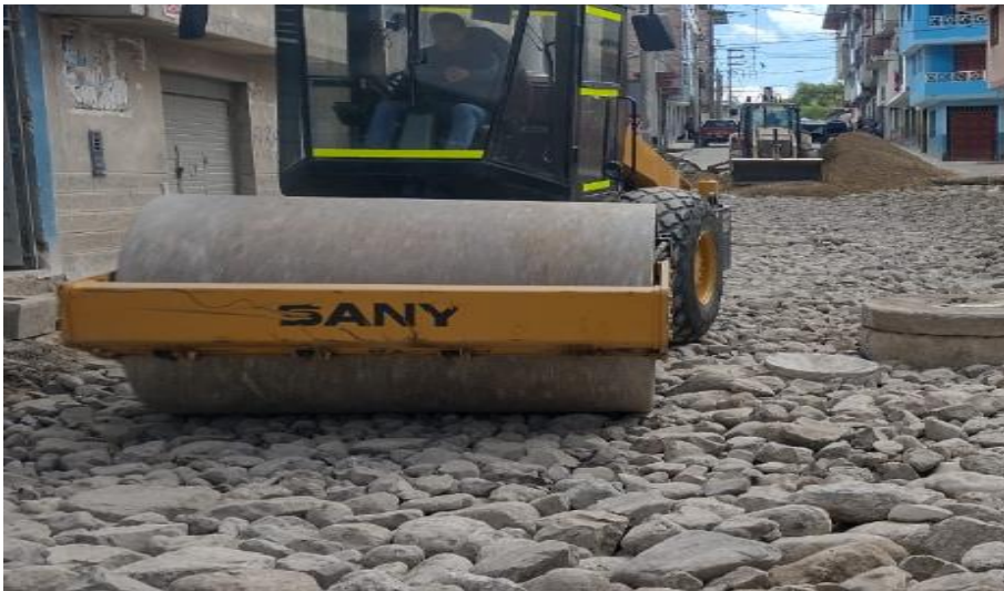
FOTOGRAFÍA N° 08: Compactación del afirmado haciendo uso de rodillo
