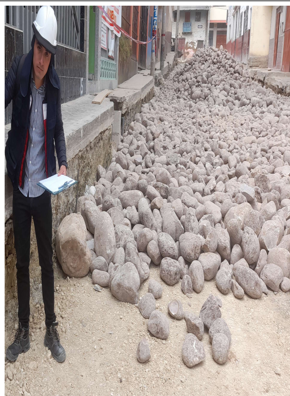
FOTOGRAFÍA N° 7: mejoramiento con material de préstamo over ( E= 0.35 )
