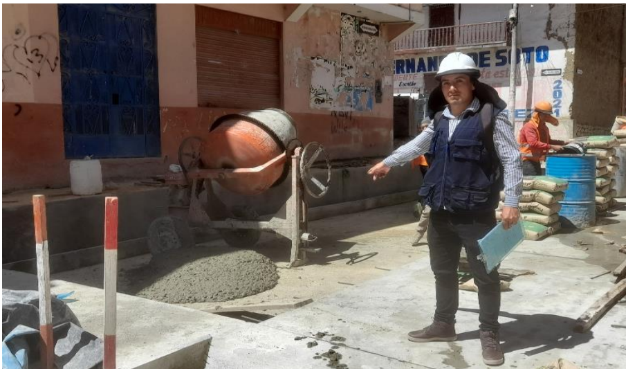
FOTOGRAFÍA N° 17: vaciado de losa de pavimento de concreto f'c = 210 \text{ kg/cm}^2 , cuadra 1
