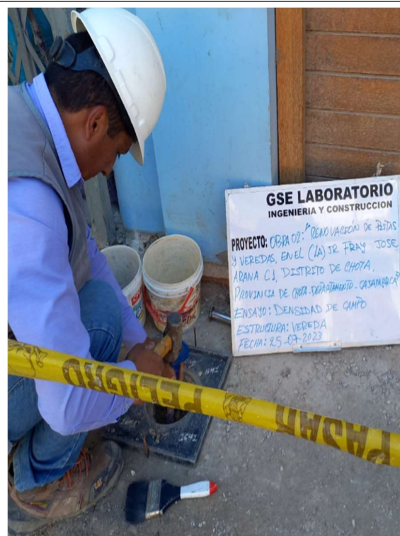
FOTOGRAFÍA N° 15: realiza ensayo de densidad de campo en veredas
