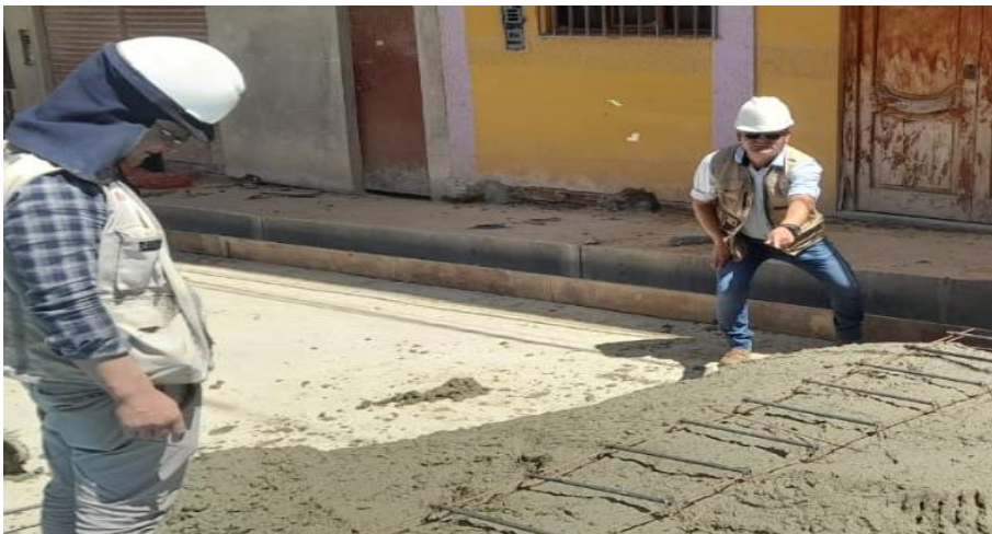
FOTOGRAFÍA N° 14: habilitación de acero liso de 1" para dowels
