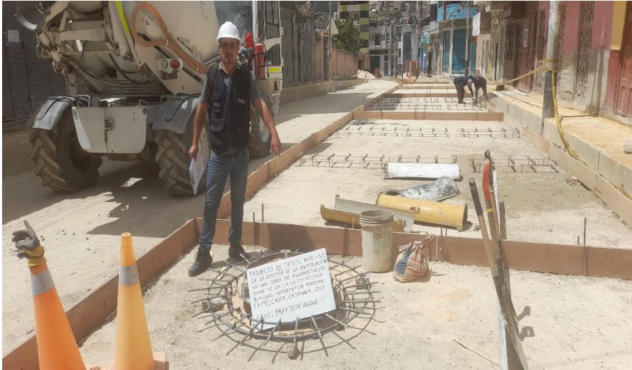
FOTOGRAFÍA N° 19: habilitación de acero para buzones
