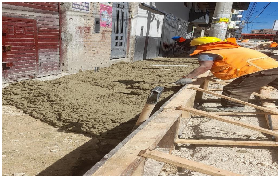
FOTOGRAFÍA N° 18: vaciado de concreto en veredas, concreto f'c= 175 \text{ Kg/cm}^2
