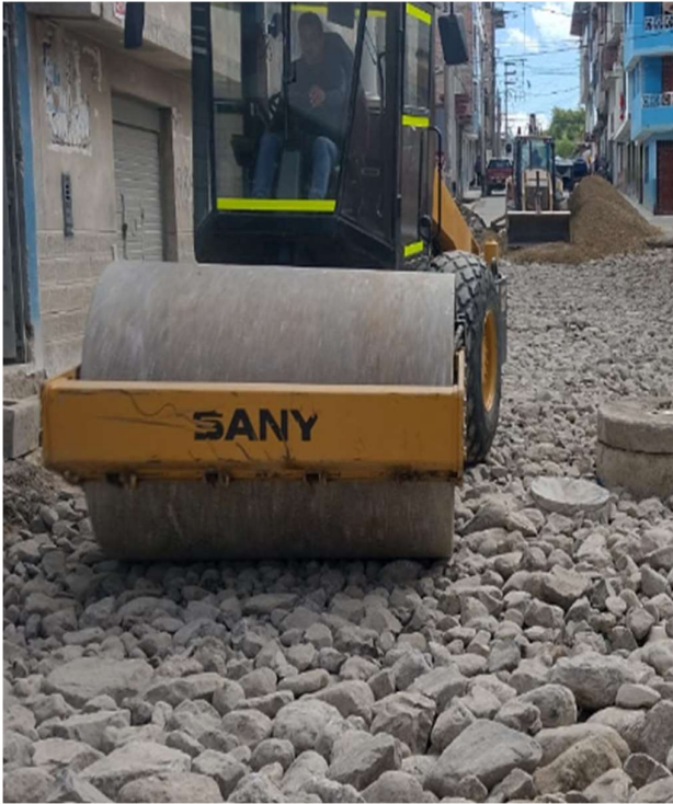
FOTOGRAFÍA N° 8: compactación de over con rodillo liso vibratorio
