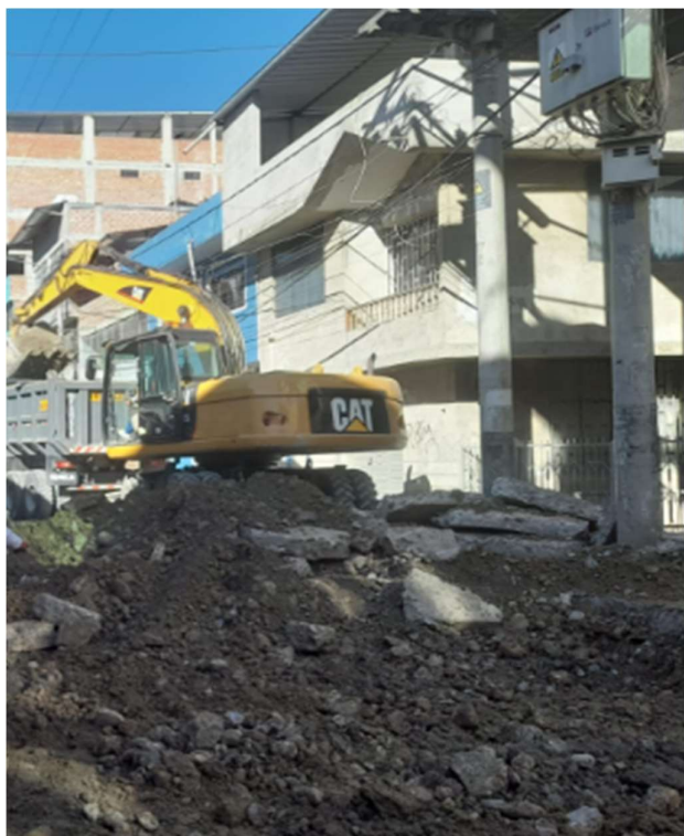
FOTOGRAFÍA N° 1: Demolición de pavimento de concreto de 0.20 m
