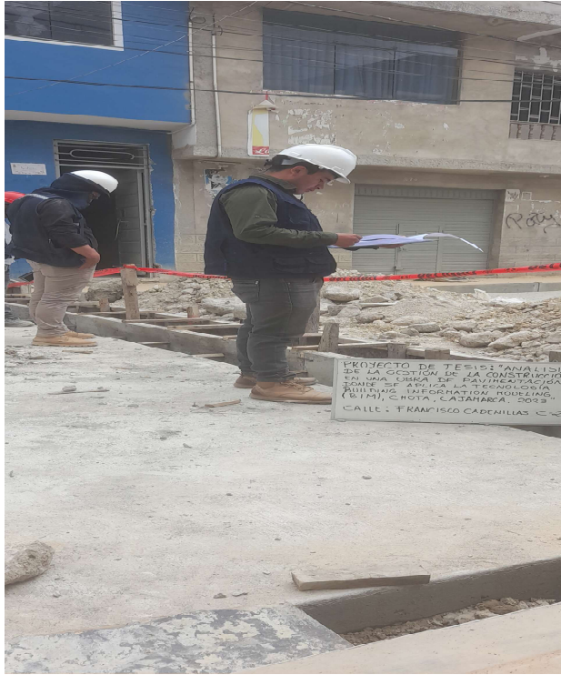
FOTOGRAFÍA N° 24: encofrado de alcantarilla
