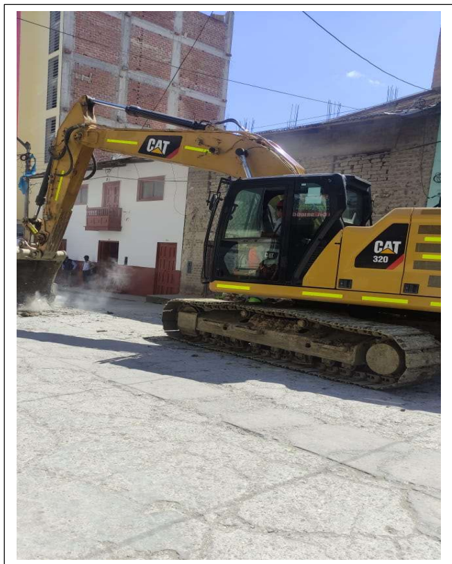
FOTOGRAFÍA N° 2: Demolición de pavimento de concreto de 0.20 m
