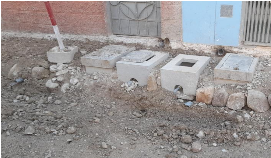
FOTOGRAFÍA N° 05: colocación de cajas de conexiones de agua y desagüe
