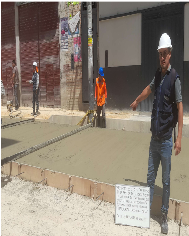
FOTOGRAFÍA N° 28: vaciado de losa de pavimento de concreto f'c = 210 \text{ kg/cm}^2
