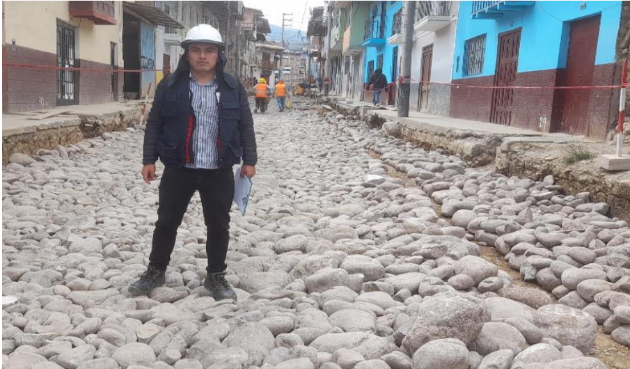
FOTOGRAFÍA N°07: Tendido de over e=0.35 m para mejoramiento de subrasante
