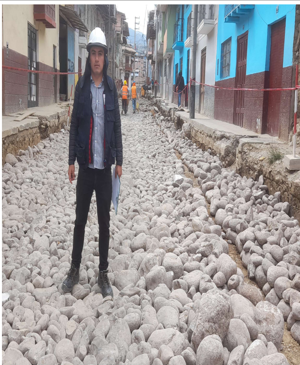
FOTOGRAFÍA N° 10: colocación y expansión de over ( E=0.35 )
