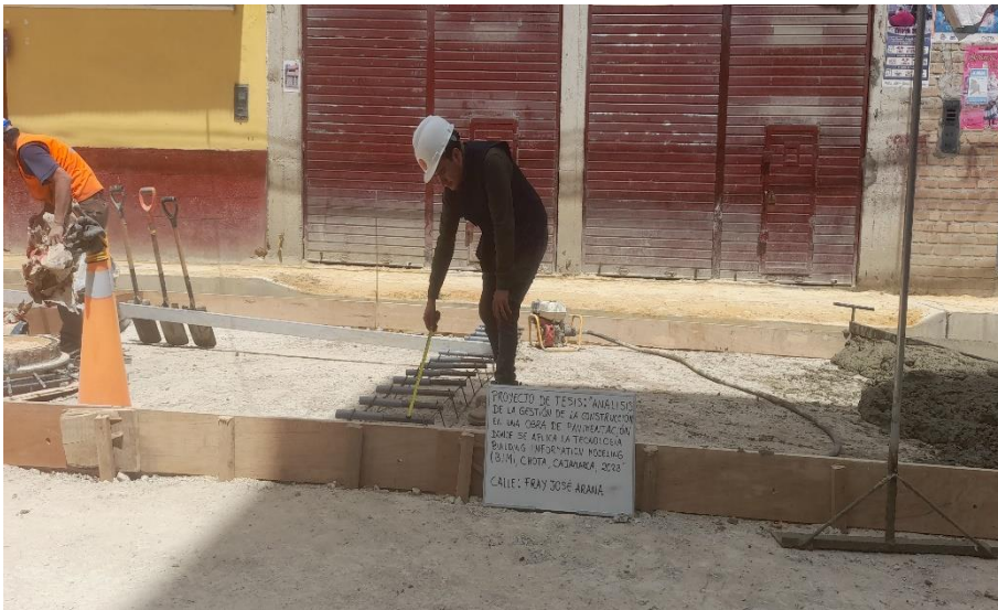
FOTOGRAFÍA N° 20: Habilitación de acero liso de 1” para dowels
