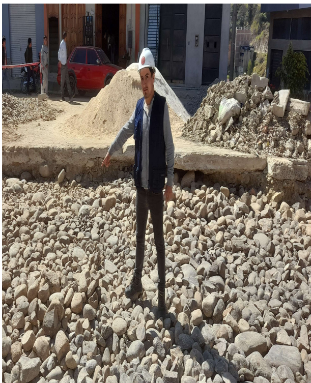
FOTOGRAFÍA N° 10: Mejoramiento de subrasante con over e=0.35 m
