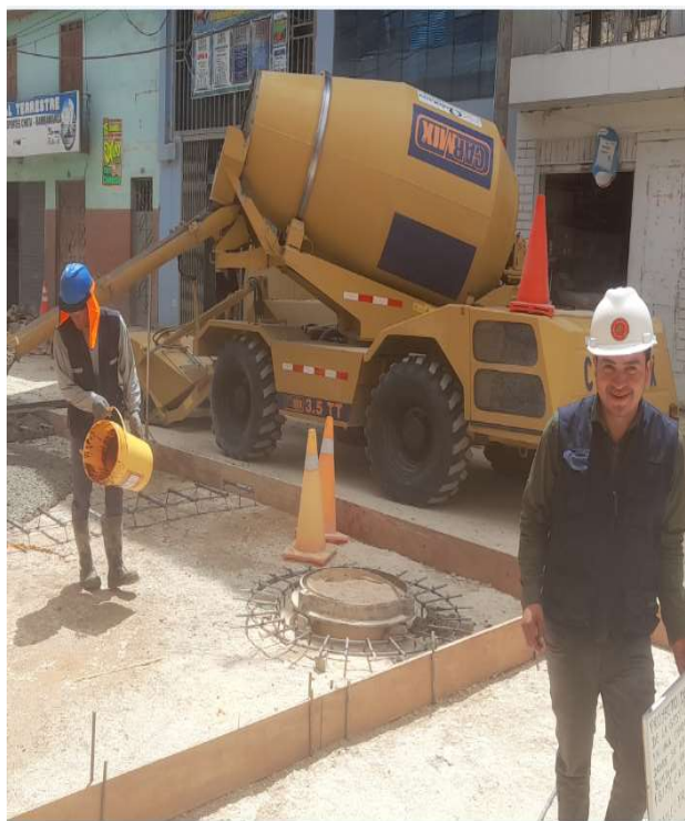
FOTOGRAFÍA N° 24: haciendo uso de antisol en la etapa inicial de fraguado.
