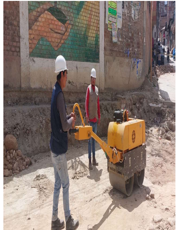
FOTOGRAFÍA N° 9: Perfilado y compactación de subrasante
