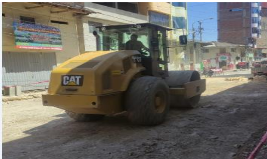
FOTOGRAFÍA N° 15: conformación de la sub base Granular e= 0.20 con Equipo Pesado.
