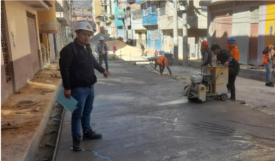
FOTOGRAFÍA N° 19: Acerrando las juntas de contracción e= 3\text{mm}
