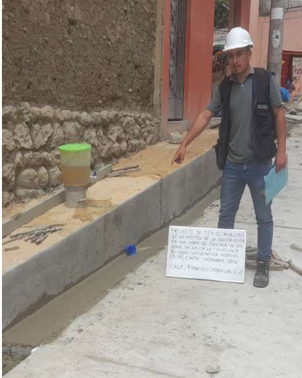
FOTOGRAFÍA N° 20: vaciado de concreto 175 kg/cm 2 en cunetas.
