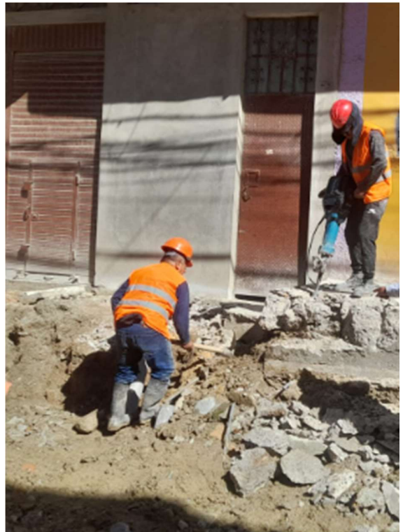
FOTOGRAFÍA N° 2: Demolición de vereda existentes
