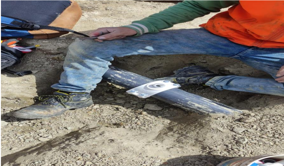
FOTOGRAFÍA N° 04: Instalación de tuberías de agua
