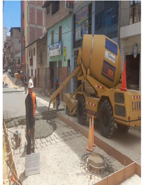
FOTOGRAFÍA N° 23: vaciado de losa de pavimento de concreto f'c = 210 \text{ kg/cm}^2 .
