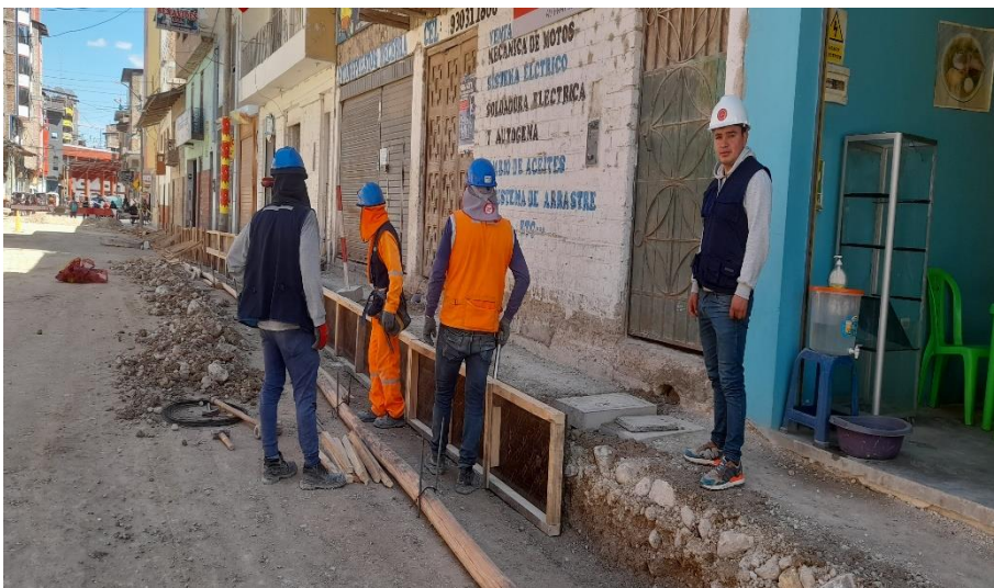
FOTOGRAFÍA N° 17: Encofrado de veredas, teniendo en cuenta las medidas y pendientes
