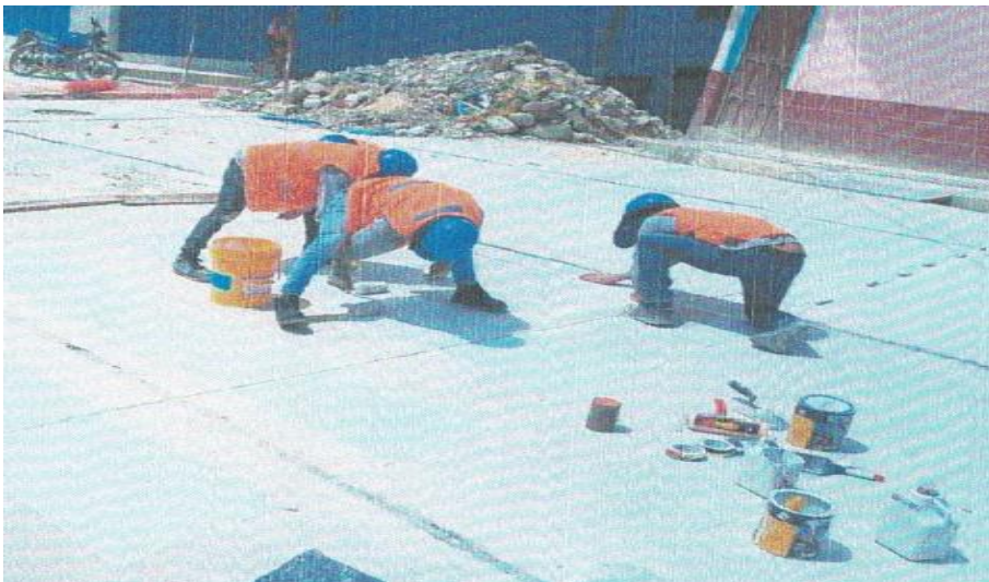
FOTOGRAFÍA N° 29: pintado de señalización
