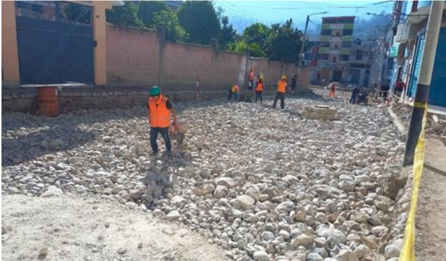
FOTOGRAFÍA N°07: Mejoramiento de subrasante con over e=0.35 m
