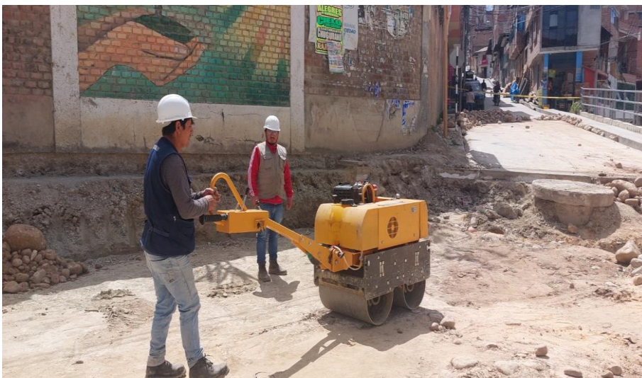
FOTOGRAFÍA N° 1: Perfilado y compactación de subrasante
