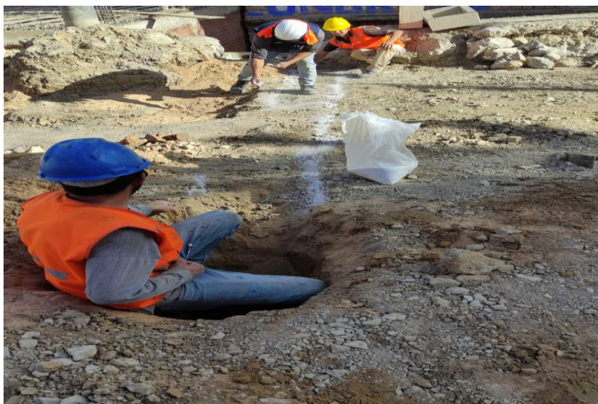
FOTOGRAFÍA N° 03: excavación para cambio de tubería de conexiones domiciliarias de agua y desagüe
