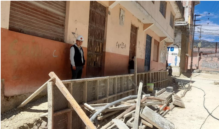
FOTOGRAFÍA N° 11: Encofrado de veredas, teniendo en cuenta las medidas y pendientes
