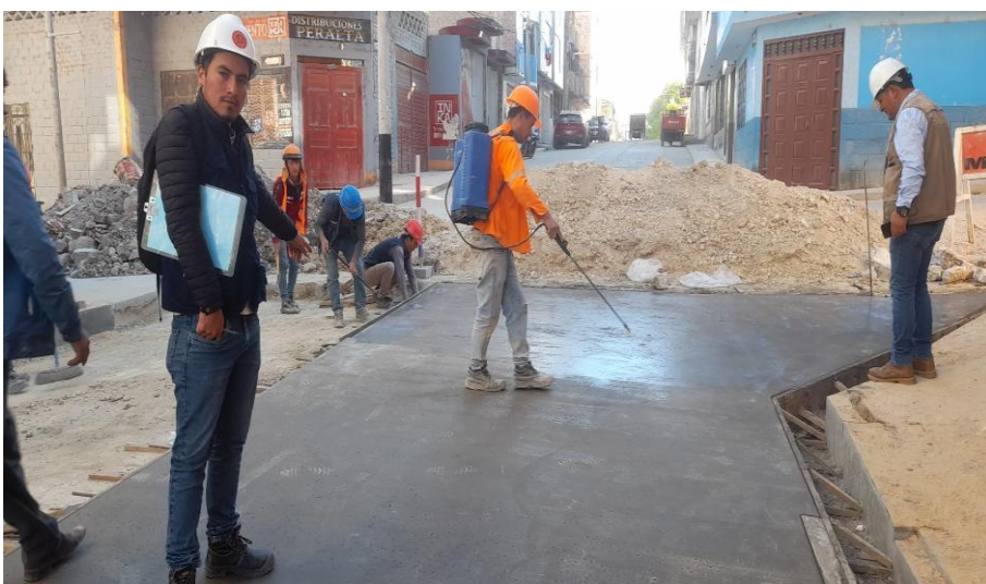
FOTOGRAFÍA N° 18: Curado de pavimento con aditivo
