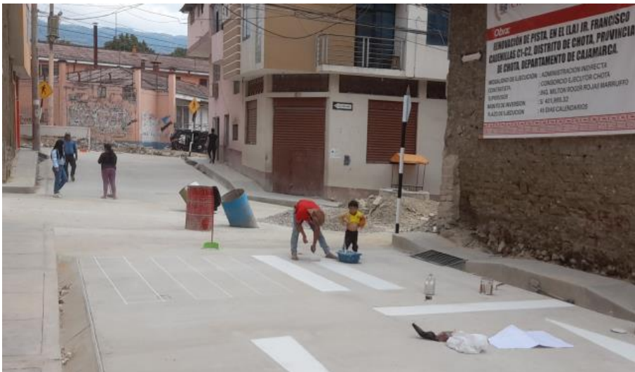
FOTOGRAFÍA N° 23: pintado de señalización
