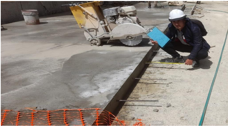
FOTOGRAFÍA N° 23: acero de 1/2" para su uso en juntas longitudinales
