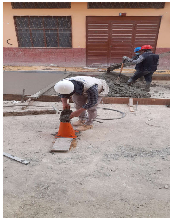
FOTOGRAFÍA N° 19: el Slump del concreto el cual dio 3.5" que está dentro del rango indicado en el Expediente Técnico.
