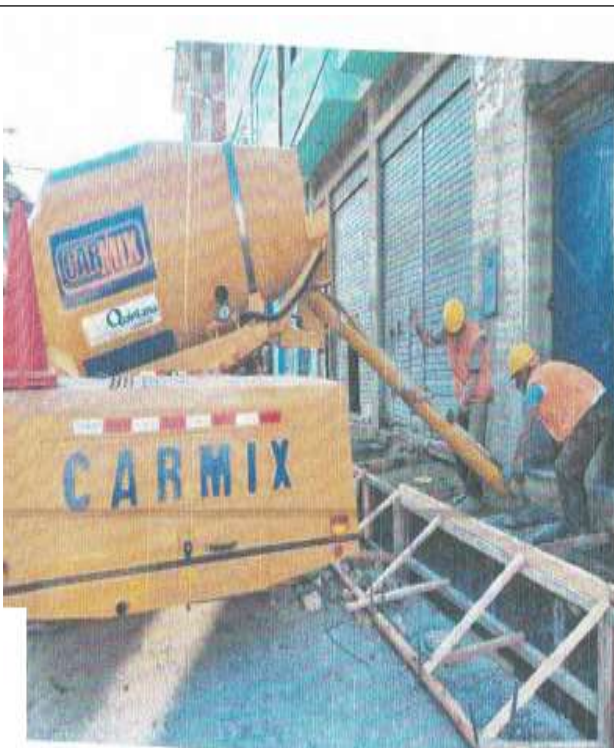
FOTOGRAFÍA N° 18: vaciado de concreto en veredas con Carmix, concreto f'c= 175 \text{ Kg/cm}^2
