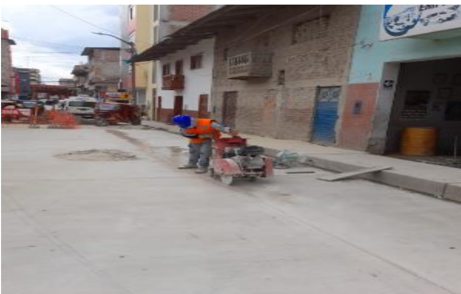
FOTOGRAFÍA N° 27: Acerrando las juntas de contracción e = 3 \text{ mm}
