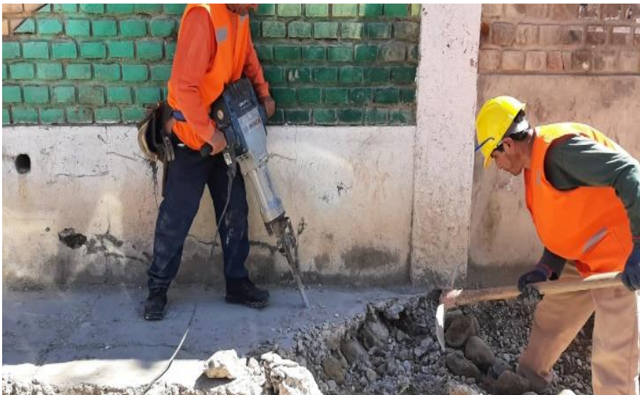
FOTOGRAFÍA N° 02: Demolición de vereda de concreto
