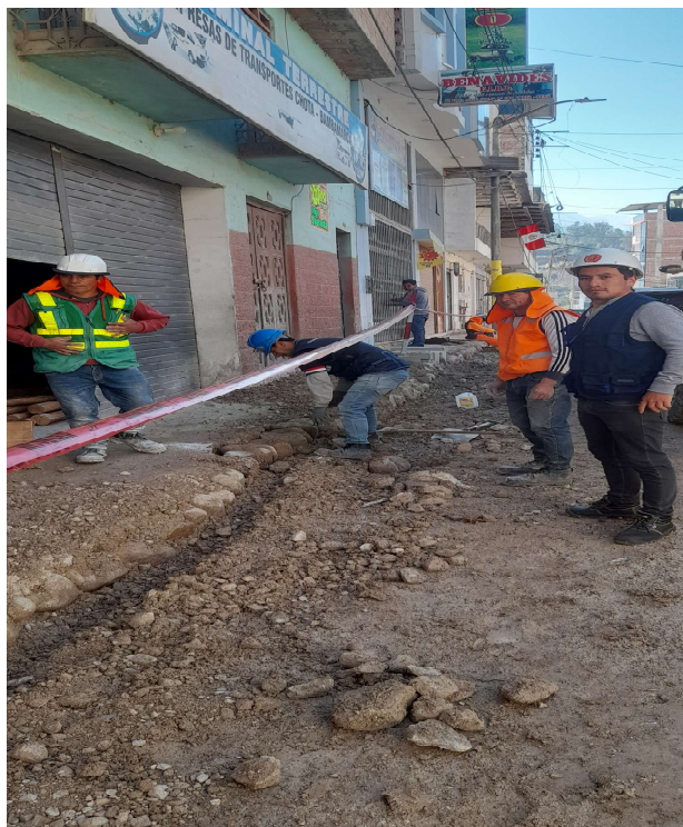
FOTOGRAFÍA N° 6: colocación de relleno con afirmado en veredas
