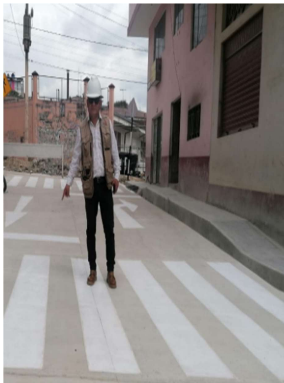
FOTOGRAFÍA N° 26: pintado de señalización
