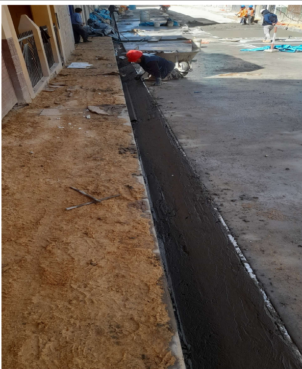
FOTOGRAFÍA N° 30: vaciado de cunetas de concreto f'c = 175 \text{ kg/cm}^2
