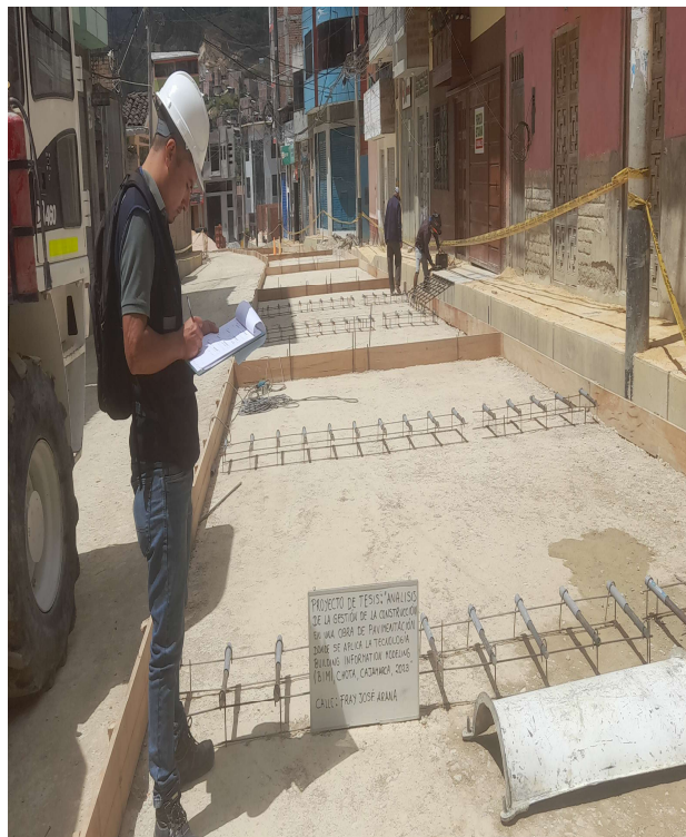
FOTOGRAFÍA N° 22: habilitación de acero liso de 1" para dowels
