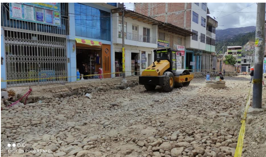
FOTOGRAFÍA N° 09: Compactación del afirmado haciendo uso de rodillo
