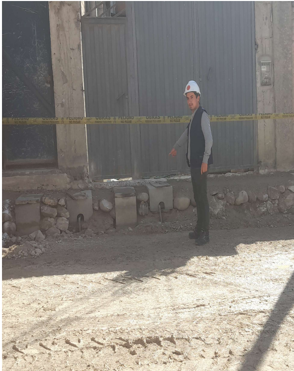
FOTOGRAFÍA N° 8: instalaciones de cajas de registro y las conexiones domiciliarias de agua.
