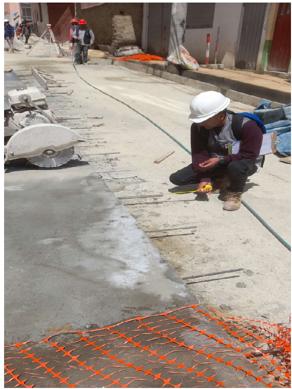
FOTOGRAFÍA N° 17: acero de refuerzo de 1/2" para su uso en juntas longitudinales.
