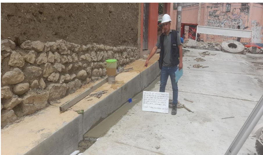
FOTOGRAFÍA N° 21: vaciado de concreto 175 \text{ kg/cm}^2 en cunetas.
