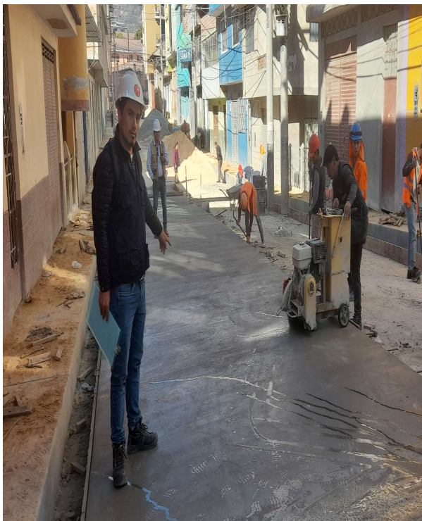
FOTOGRAFÍA N° 22: Acerrando las juntas de contracción e = 3 mm
