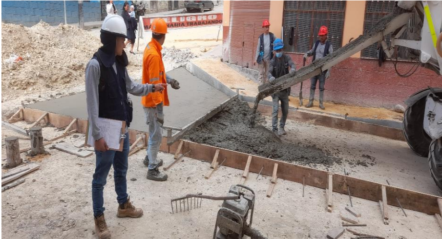
FOTOGRAFÍA N° 13: vaciado de losa de pavimento de concreto f'c = 210 \text{ kg/cm}^2 , cuadra 2
