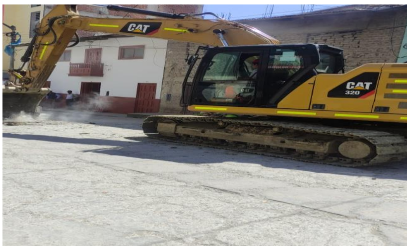
FOTOGRAFÍA N° 01: Demolición de pavimento de concreto de 0.20 m
