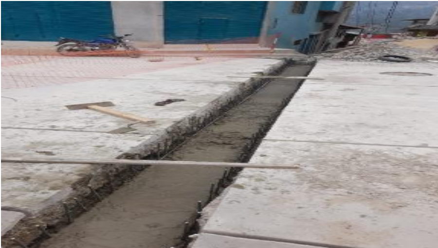
FOTOGRAFÍA N° 26: vaciado de alcantarilla f'c = 210 \text{ kg/cm}^2
