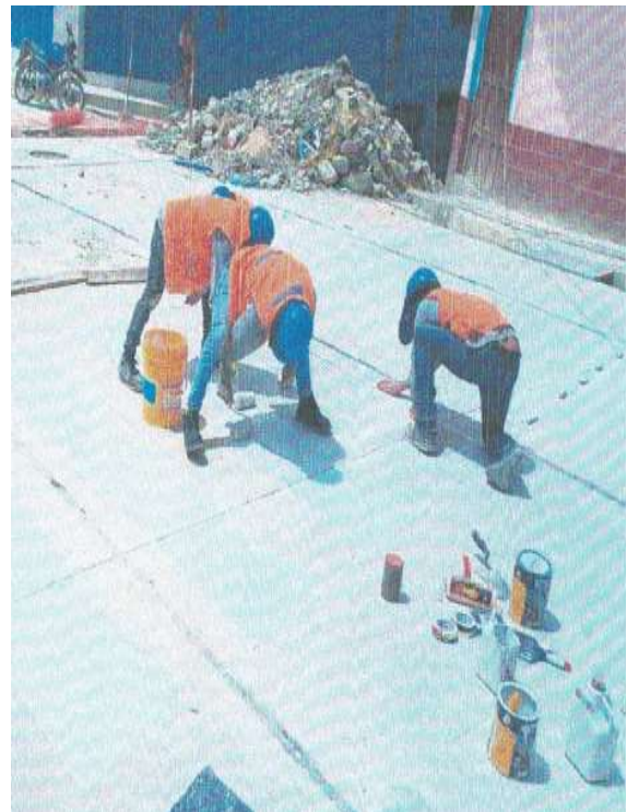
FOTOGRAFÍA N° 35: pintado de señalización
