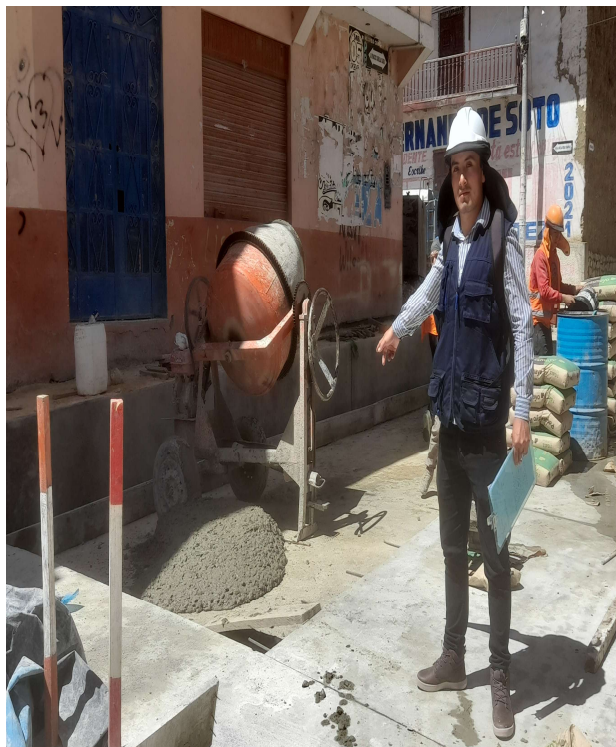
FOTOGRAFÍA N° 18: vaciado de losa de pavimento de concreto f'c = 210 \text{ kg/cm}^2
