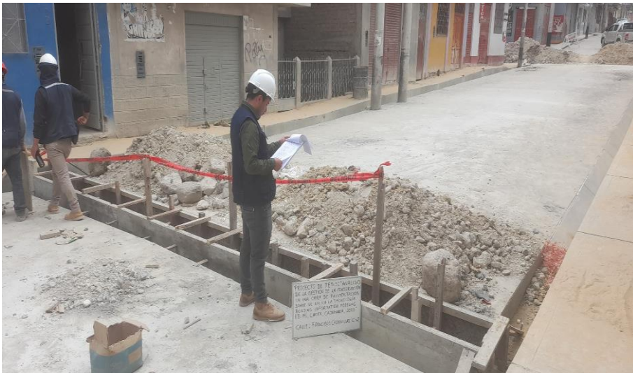
FOTOGRAFÍA N° 20: encofrado de alcantarilla
