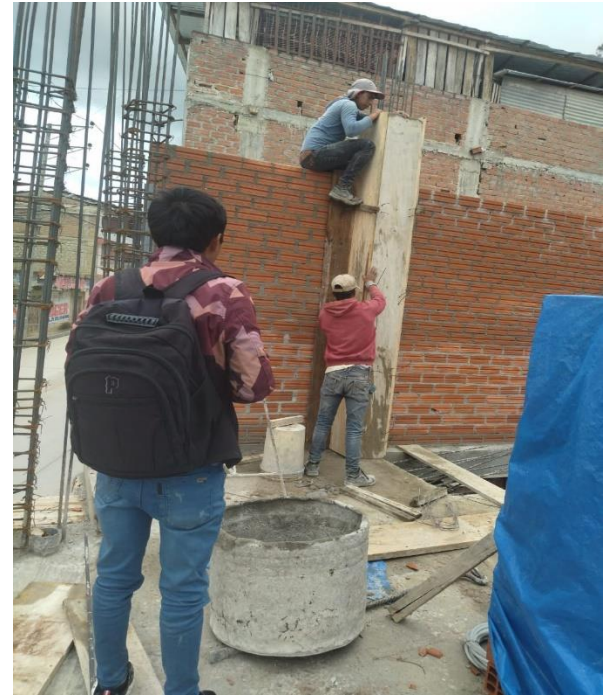
Fotografía 20. Encofrado en columnas V-04
