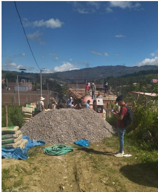
Fotografía 27. Registrando la productividad de concreto en vigas V-06
