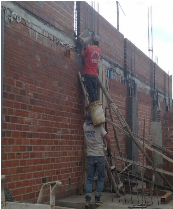
Fotografía 23. Concreto en columnas V-05
