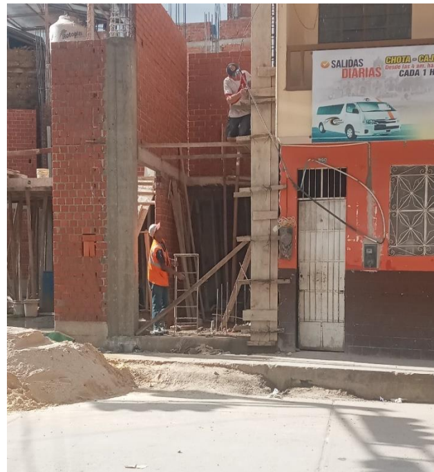
Fotografía 34. Encofrado en columnas V-07
