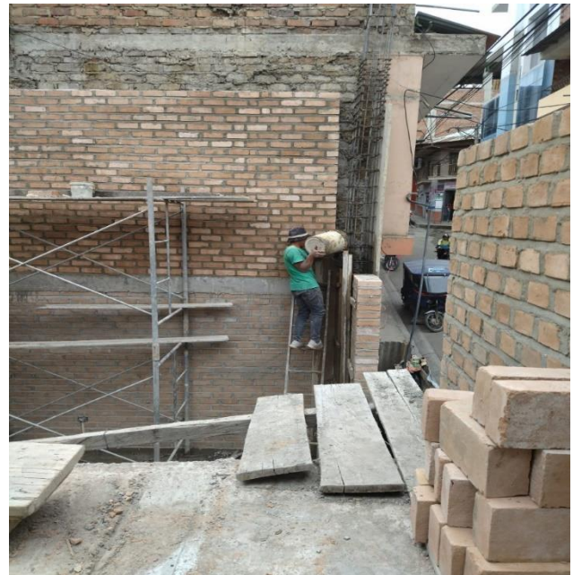
Fotografía 8. Concreto en columnas V-02
