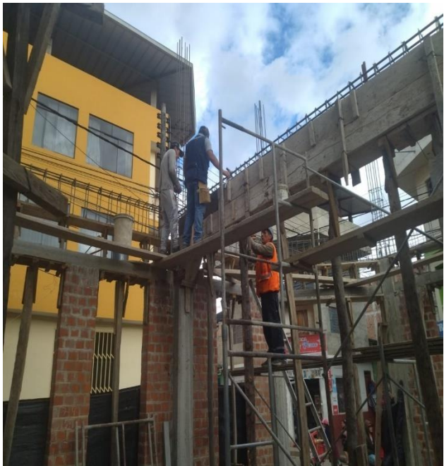
Fotografía 3. Encofrado en vigas V-01
