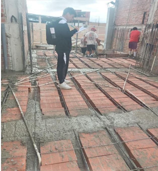
Fotografía 12. Registrando la productividad de concreto en vigas V-03
