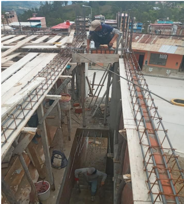
Fotografía 19. Encofrado en vigas V-04
