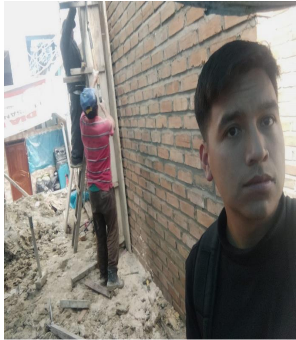
Fotografía 10. Encofrado en columnas V-02
