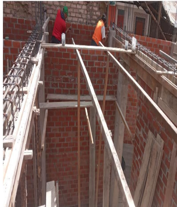
Fotografía 40. Encofrado de vigas V-09
