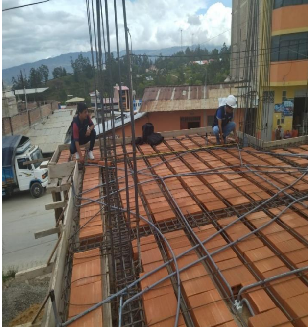
Fotografía 17. Registro del metrado para el rendimiento de Concreto en vigas V-04
