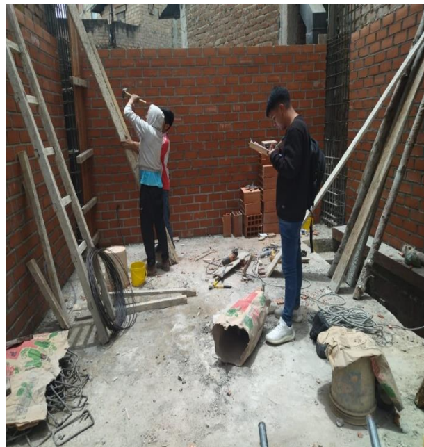
Fotografía 16. Registrando la productividad en encofrado de columnas V-03
