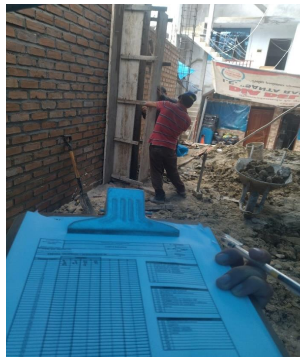
Fotografía 12. Productividad en encofrado de columnas V-02
