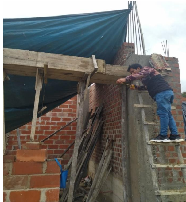
Fotografía 30. Registrando el metrado para el rendimiento de encofrado en vigas V-06
