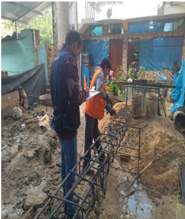
Fotografía 11. Registrando la productividad en acero de columnas V-02
