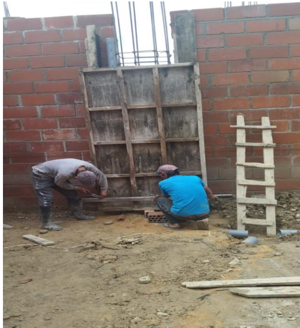
Fotografía 25. Encofrado de columnas V-05
