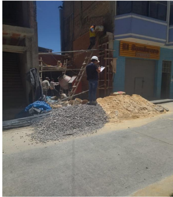
Fotografía 14. Registrando la productividad de concreto en columnas V-03
