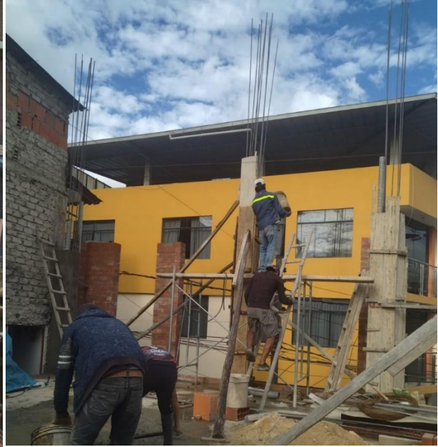
Fotografía 2. Concreto en columnas V-01
