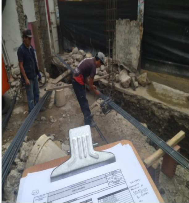
Fotografía 5. Acero en columnas V-01
