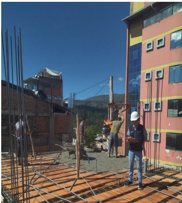
Fotografía 31. Registrando la productividad de concreto en vigas V-07
