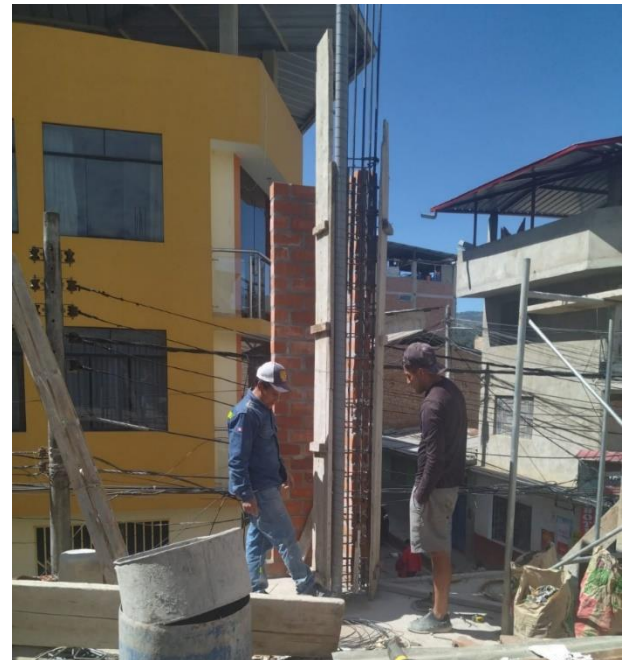
Fotografía 4. Encofrado en columnas V-01
