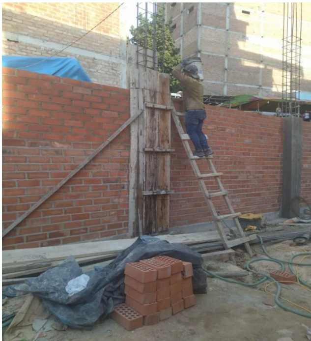
Fotografía 37. Concreto en columnas V-08
