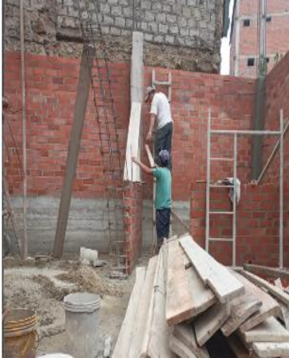
Fotografía 41. Encofrado de columnas V-09
