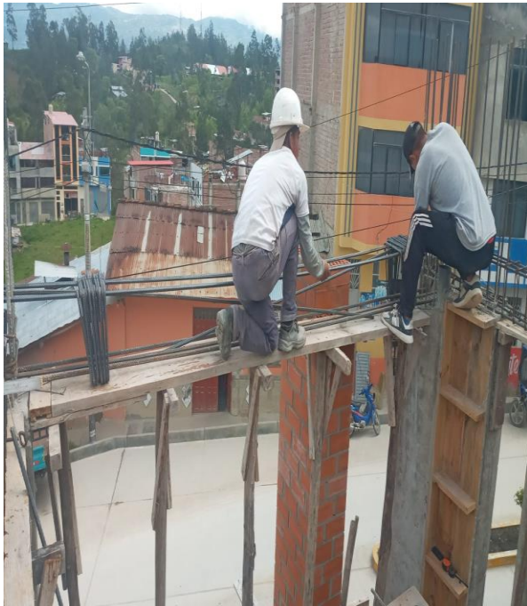
Fotografía 21. Acero en vigas V-04
