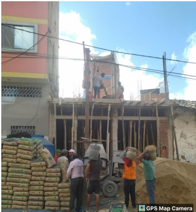
Fotografía 39. Concreto en vigas V-09
