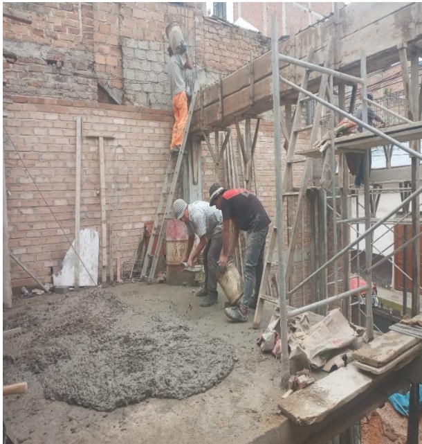
Fotografía 7. Concreto en vigas V-02
