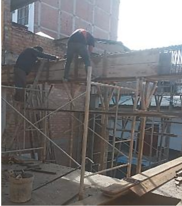
Fotografía 9. Encofrado en vigas V-02
