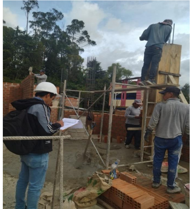
Fotografía 18. Registro de la productividad de concreto en columnas V-04
