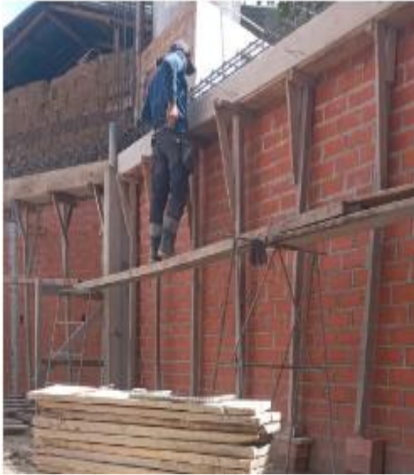
Fotografía 33. Encofrado en vigas V-07
