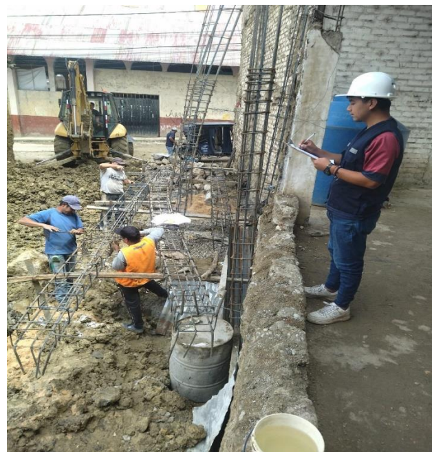
Fotografía 36. Registro de la productividad de habilitación de acero en columnas V-07
