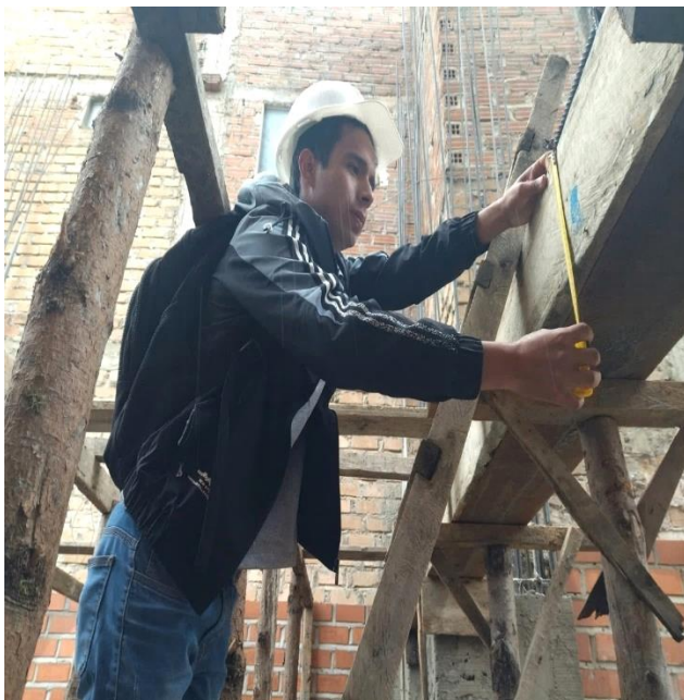
Fotografía 15. Registro del rendimiento en encofrado de vigas V-03
