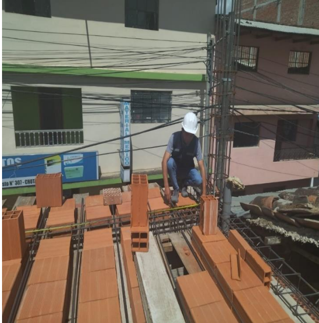
Fotografía 1. Concreto en vigas V-01
