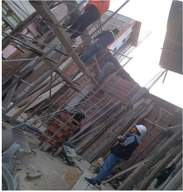
Fotografía 6. Acero en vigas V-01
