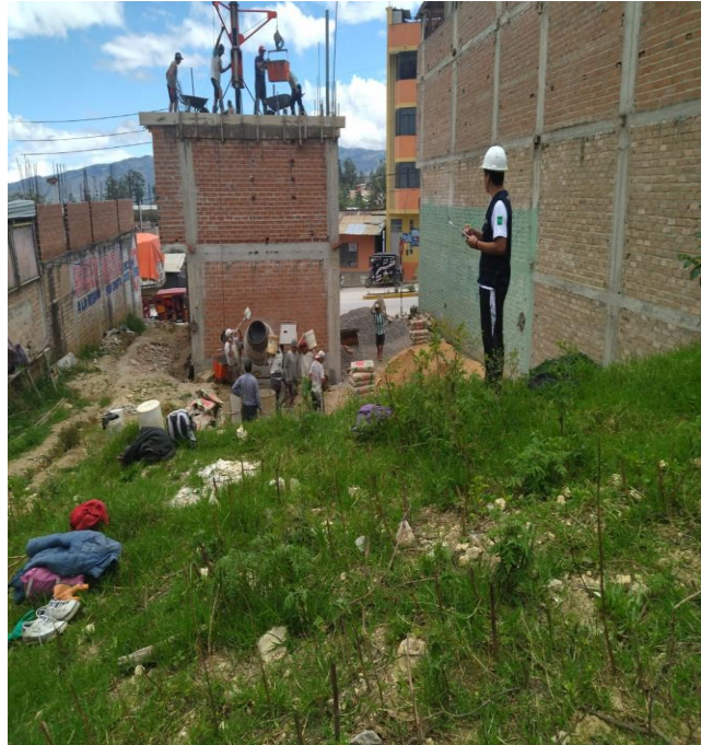
Fotografía 22. Productividad en concreto de vigas V-04
