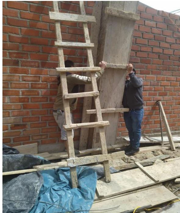
Fotografía 38. Encofrado de columnas V-08
