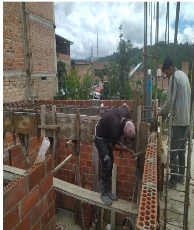
Fotografía 24. Encofrado en vigas V-05
